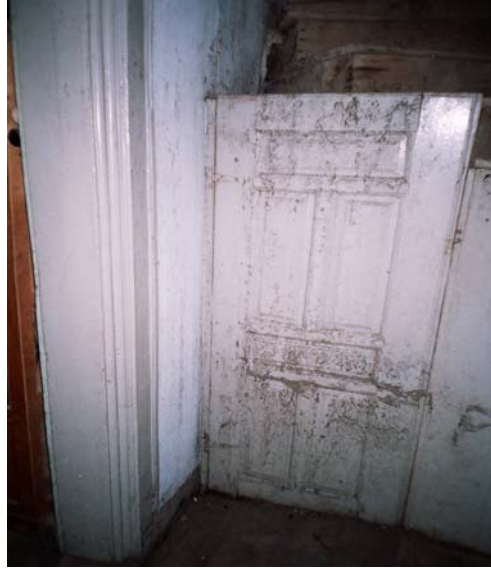
Resim B.18. Merdiven altı dolap kapısı
