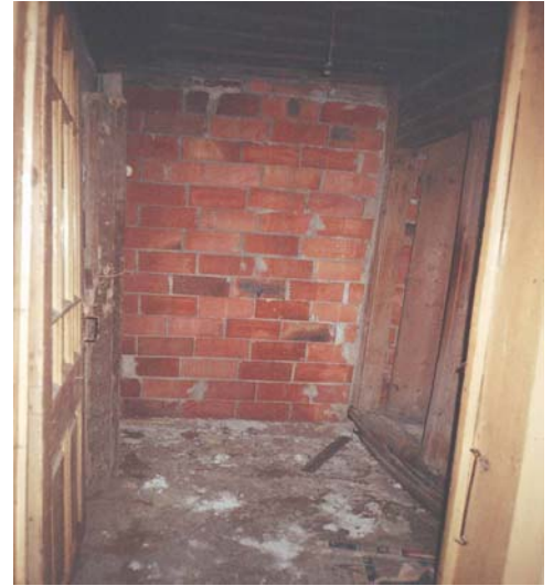
Resim B.6. W.c.Holüne Örülmüş Tuğla Duvar
