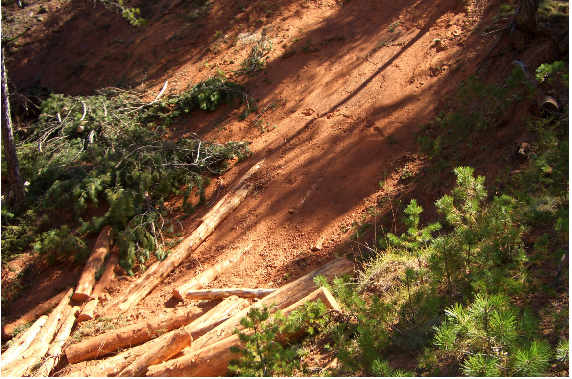
Şekil 4.1 Kontrolsüz kaydırma ve atma şeklinde uygulanan bölmeden çıkarma çalışmaları sırasında yamaçta orman toprağında oluşan zarar (Fotoğraf: K.Menemencioğlu, 2004).
