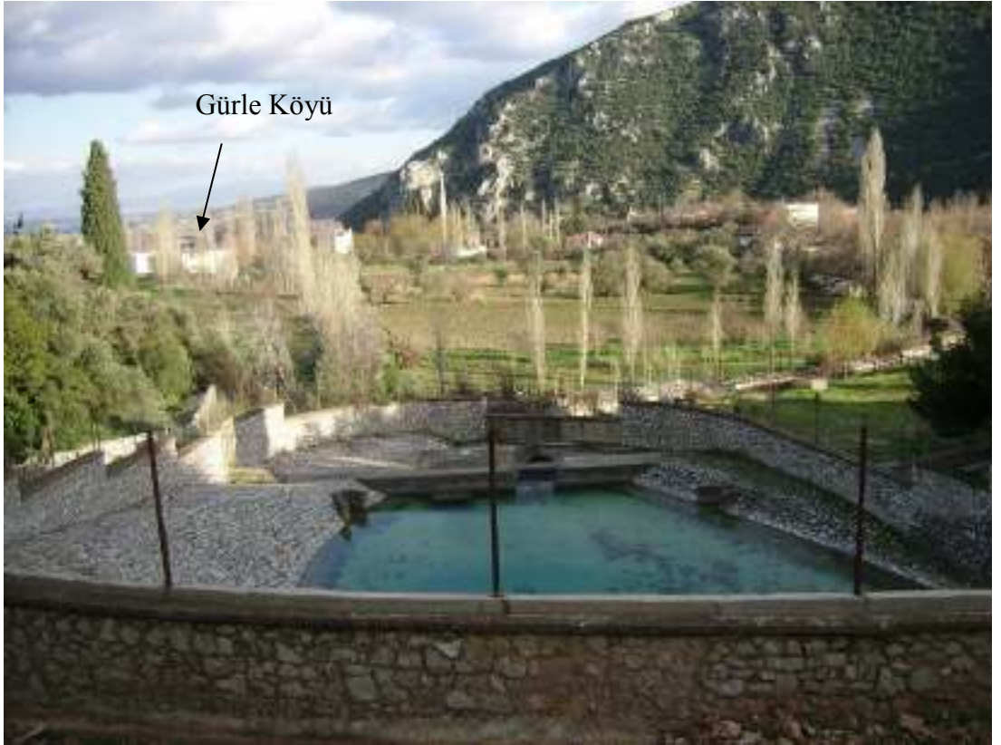
Şekil 26: Gürle Kaynağındaki suyun toplandığı kaptaj alanının görünümü
