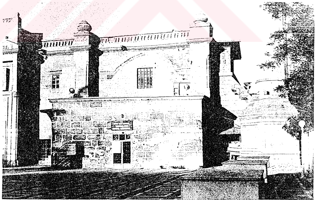
b. Batı cephe, güney bölüm
