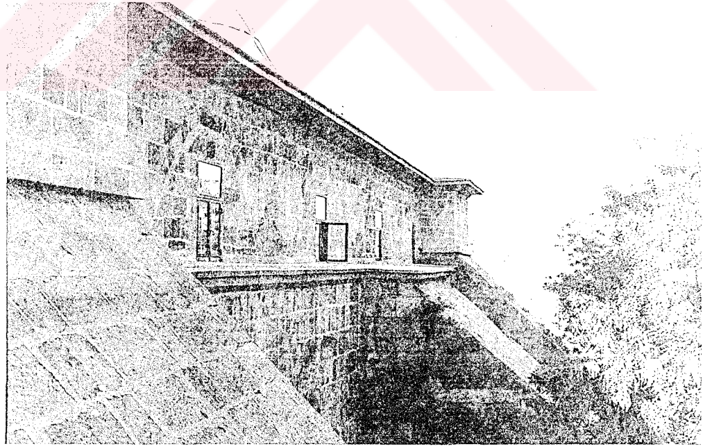
b. Güney cephe, doğu bölüm
