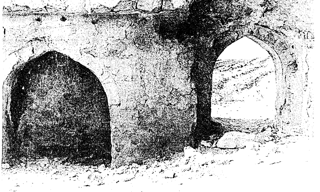
Lev.33 a. İçten,batı bölüm,kuzey duvar,ayrıntı
