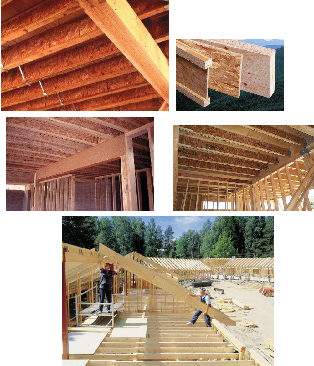
řekil 2.23 : LVL' nin yapılarda tařıma amalı eřitli kullanımları ( www.cfr.ncsu.edu ).
