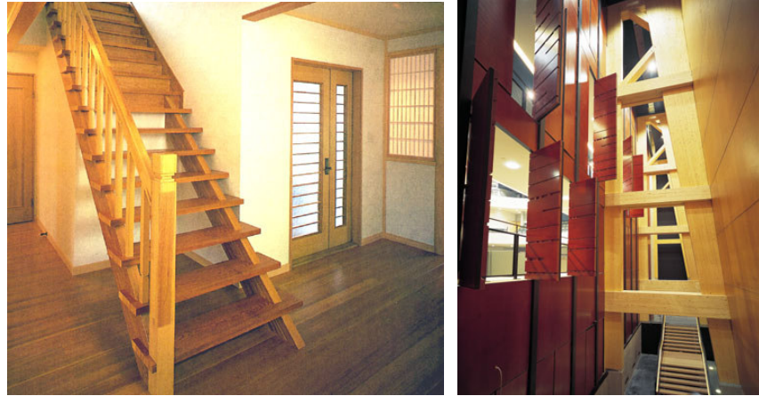
Şekil 2.22 : LVL' nin merdiven ve pencerede kullanımı (www.raute.fi).
