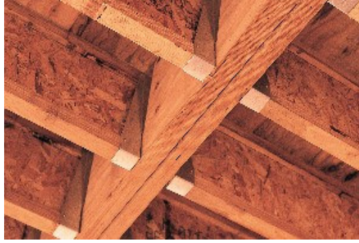
Şekil 2.27 : LVL' nin I-kirişlerinde çerçeve olarak kullanımı (www. northerninitiatives.com).
