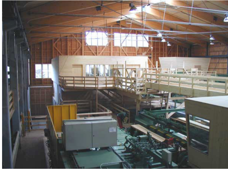
Şekil 2.28 : LVL' nin bir fabrikada çatıda kullanımı (www.cfr.ncsu.edu).
