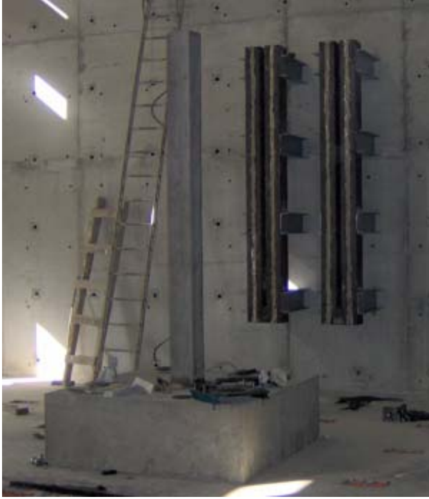
Şekil 3.20. RD Veren düşey mesnet kızağının montajı
