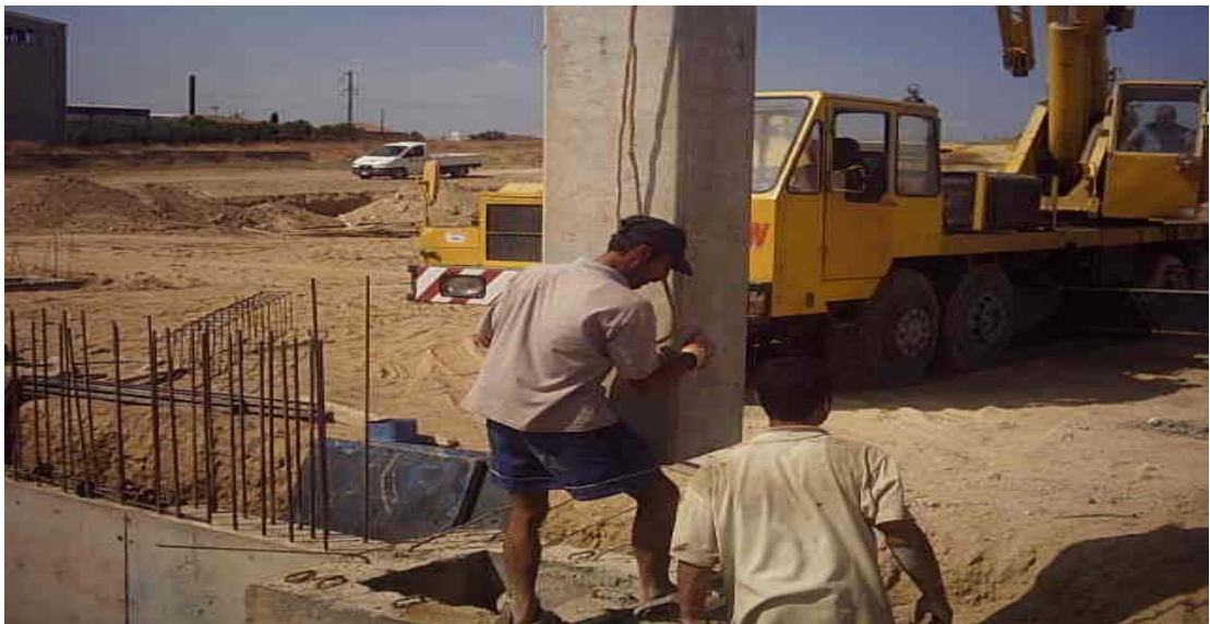
Şekil EK.9 Kolonun sokete indirilmesi
