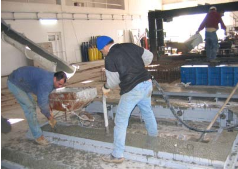
Şekil 4.20 PBA perde betonu dökümü
