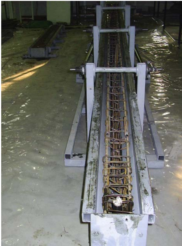
Şekil 4.16 Makas donatısının kalıba yerleştirilmiş durumu
