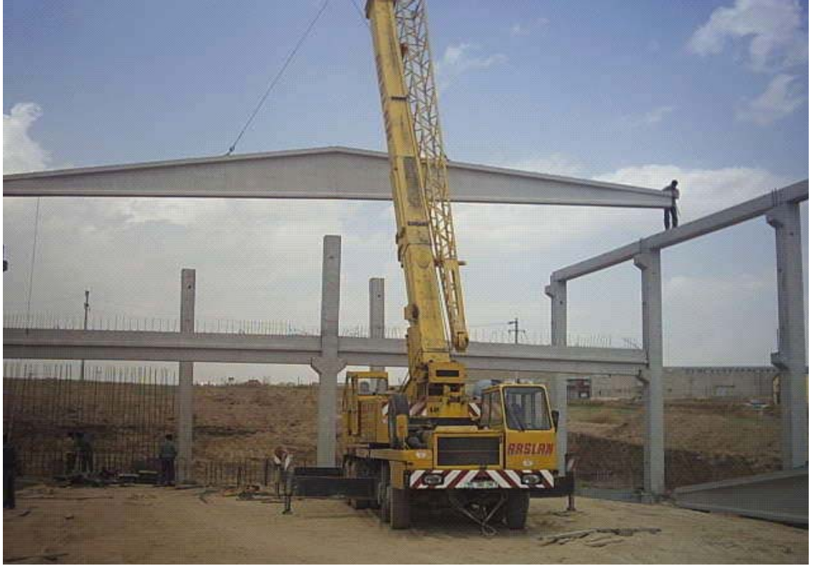
Şekil EK.11 Makas montajı-1
