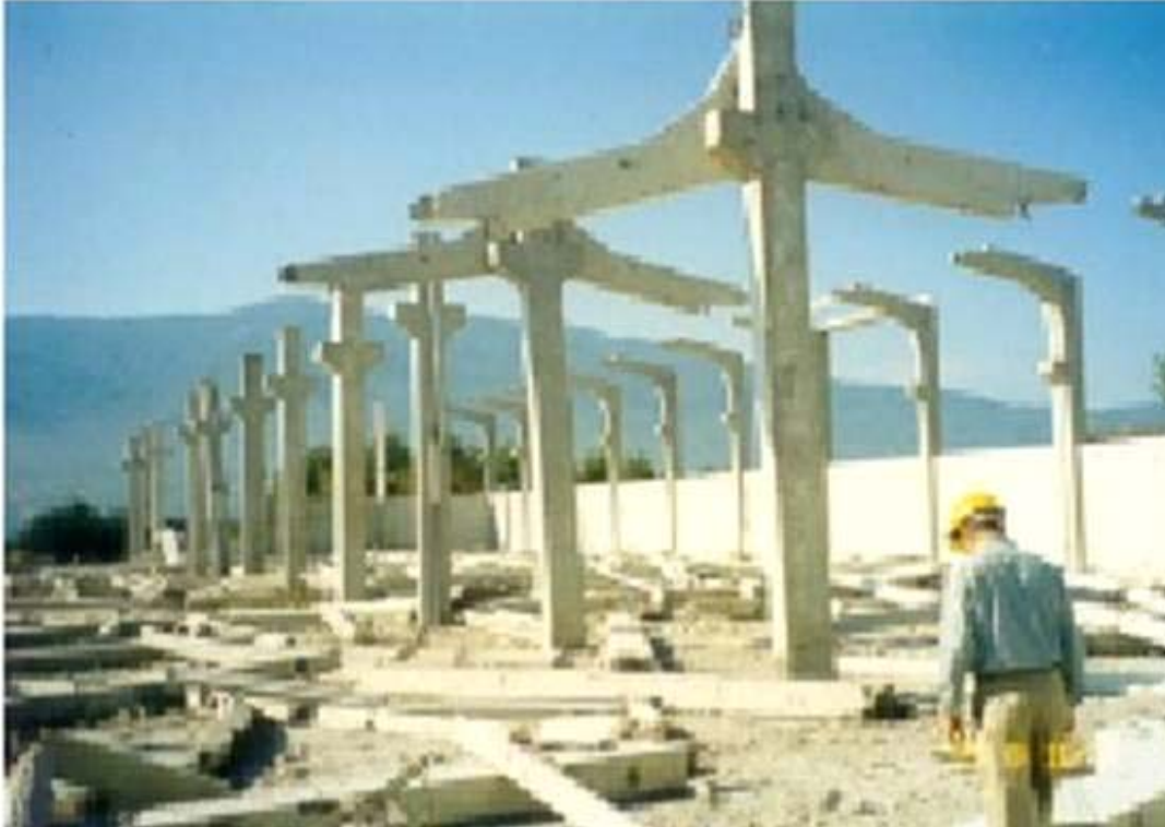
Şekil 2.5 1999 Marmara depreminde PBA kolonlar ayakta ama makaslar düşmüş
