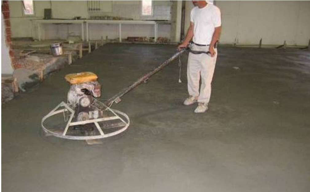
Şekil 3.12 Betonun titreşimli master ile perdahlanması
