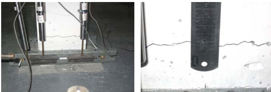
Şekil 2.11 Deney sonunda kolon alt bölgesinde oluşan çatlaklar
