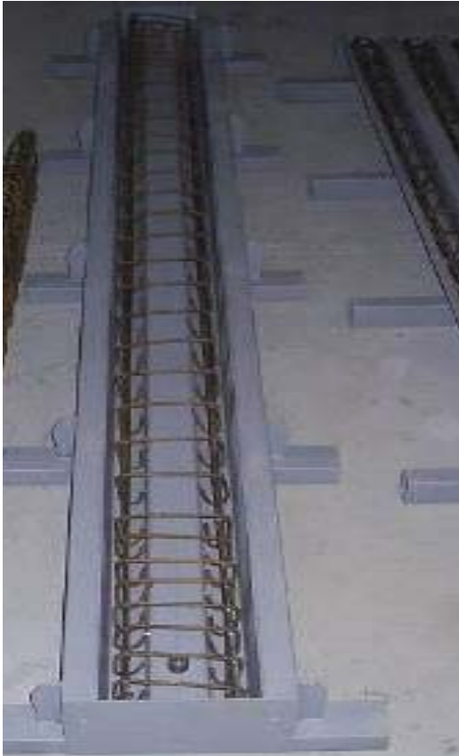
Şekil 4.14 Oluk donatısı ve kalıbı
