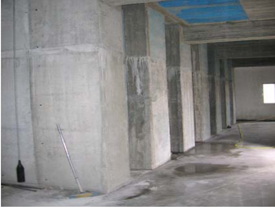
Şekil 3.17 Reaksiyon Duvarı arka cephe görünüşü
