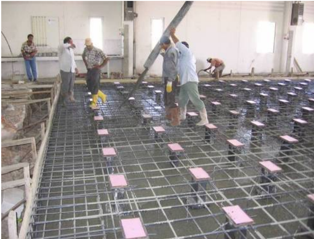
Şekil 3.10 Beton pompası ile betonun dökümü
