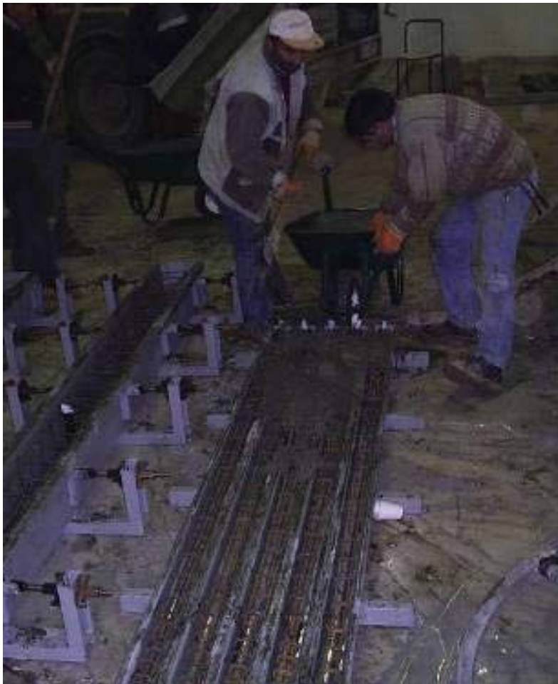
Şekil 4.21 Aşıkların beton dökümü
