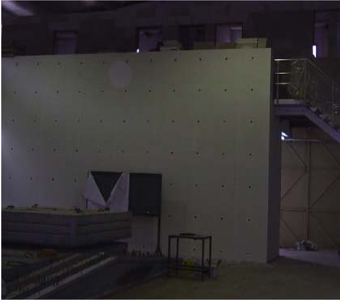
Şekil 3.19 RD'nın dolgu macunu yapılmış durumu
