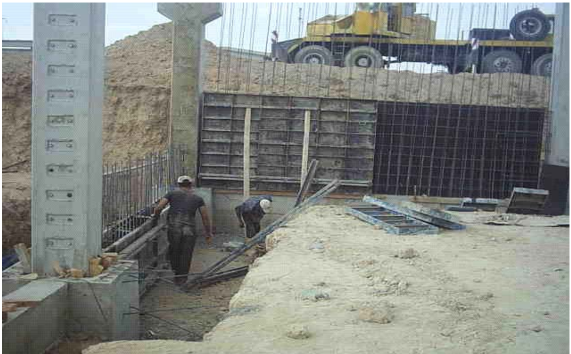
Şekil EK.16 Perde duvar imalatı
