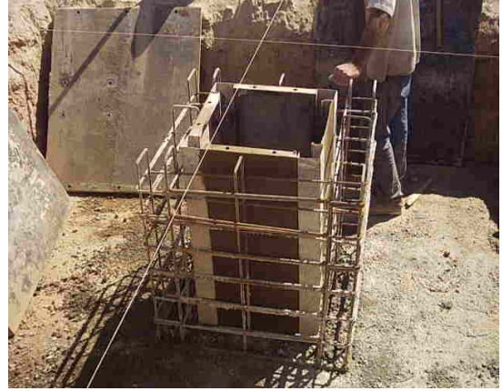
Şekil EK.2 Soket iç kalıp işleri
