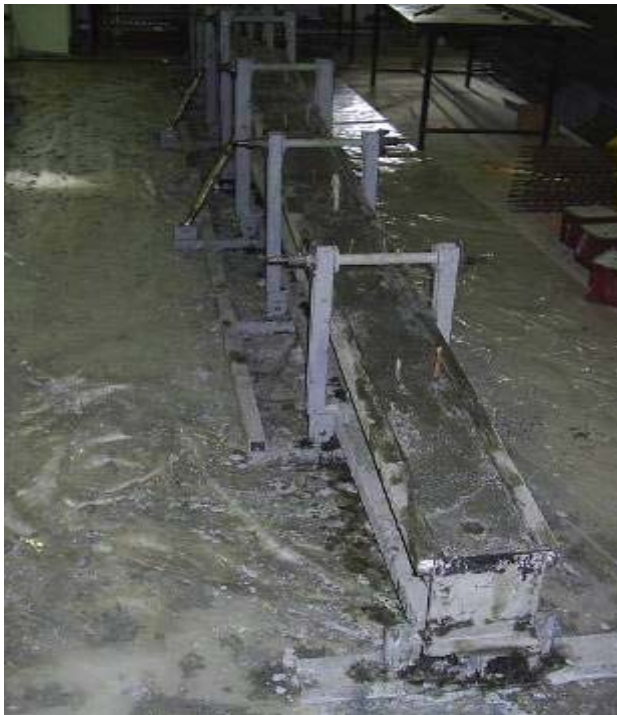
Şekil 4.23 Makas- beton dökümünden sonra
