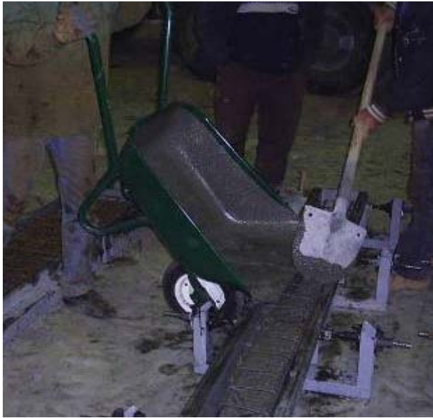
Şekil 4.22 Kolon beton dökümü
