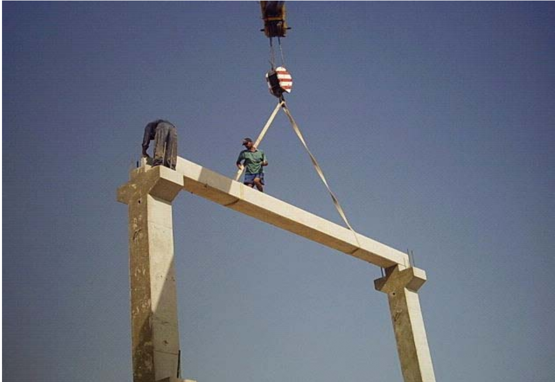
Şekil EK.10 Oluk montajı
