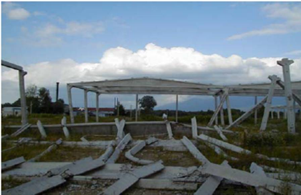
Şekil 2.8 1999 Marmara depreminde tümüyle göçmüş PBA sanayi yapısı
