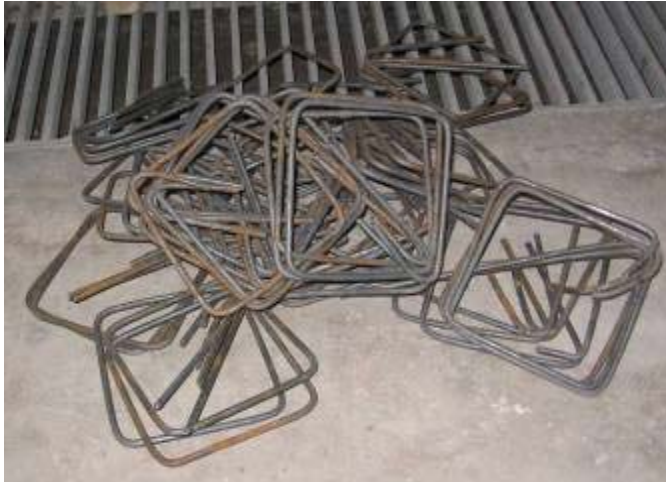
Şekil 4.11 PBA kolon etriyeleri
