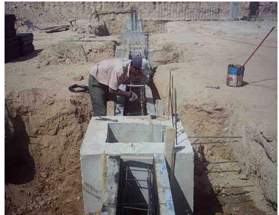
Şekil EK.4 Bağ kirişi kalıp ve donatı
