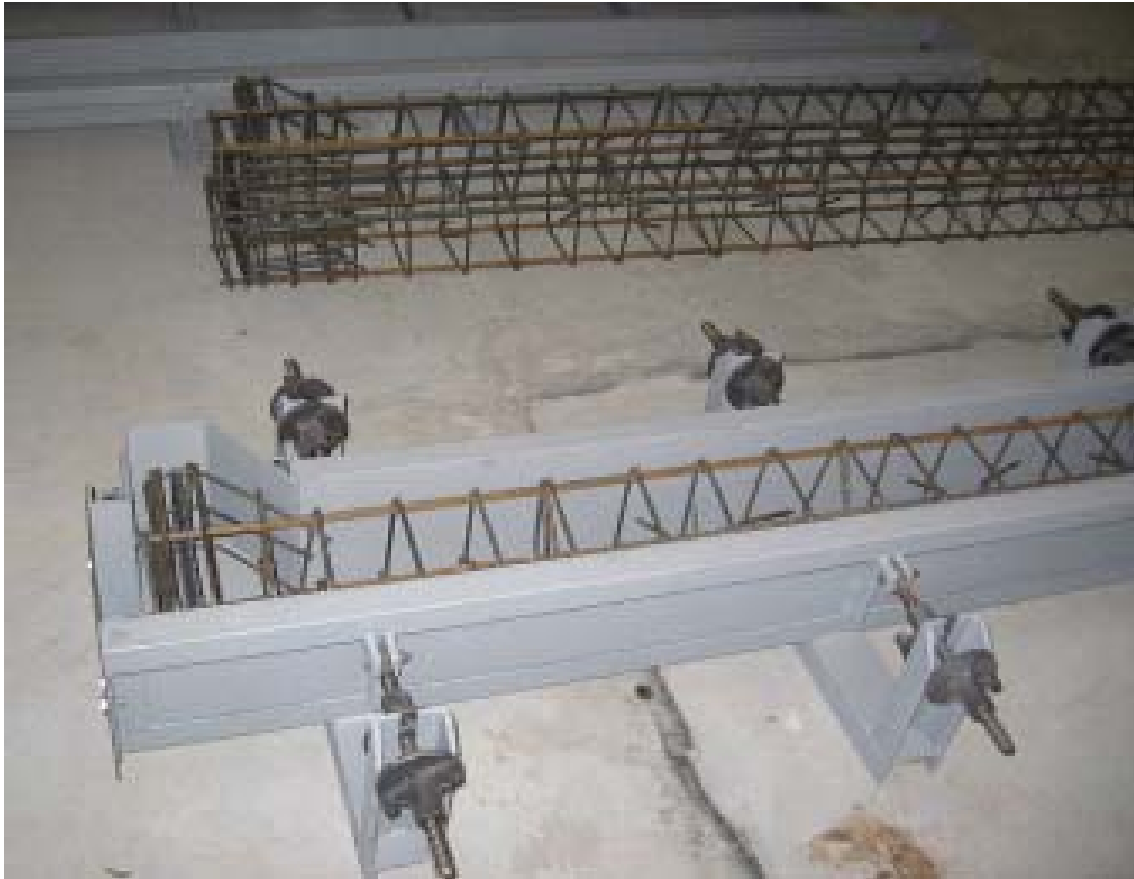
Şekil 4.12 PBA kolon donatılarının çelik kalıba yerleştirilmesi
