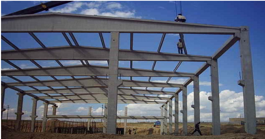
Şekil EK.14 Aşık montajı-2
