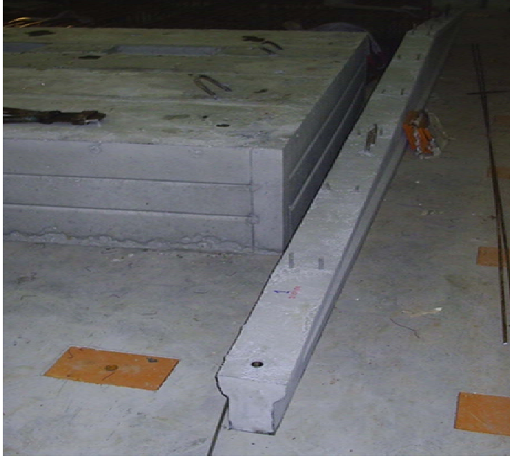
Şekil 4.26 Tamamlanmış makas ve temel
