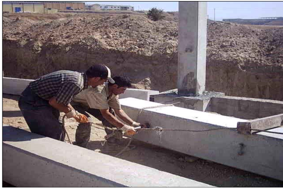
Şekil EK.7 PBA kolonun vince bağlanması
