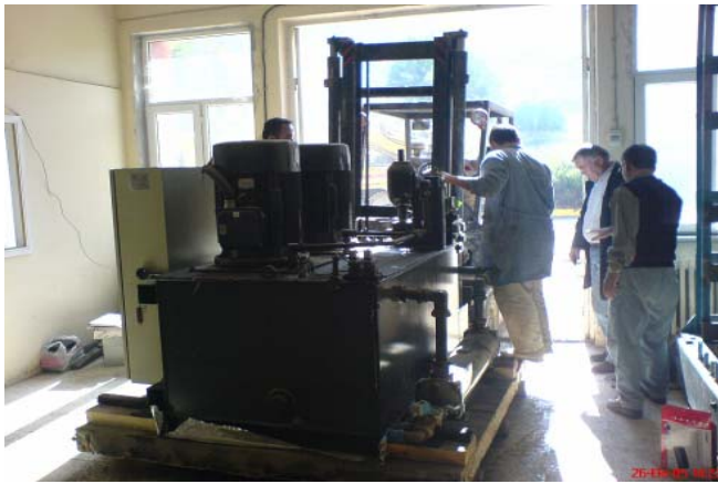
Şekil 3.27 Hidrolik Güç Ünitesinin eski laboratuardan çıkarılması
