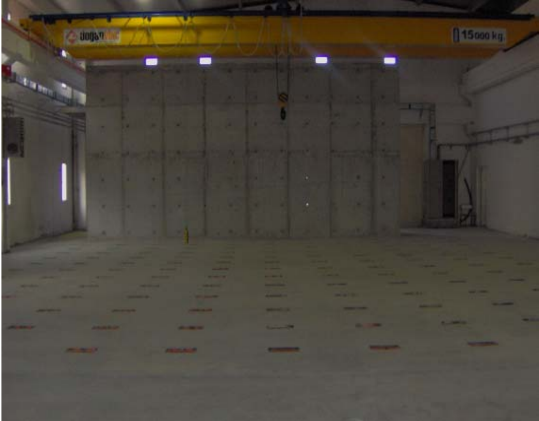
Şekil 3.18 Betonarme yapım işleri tamamlanmış KD-RD sistemi
