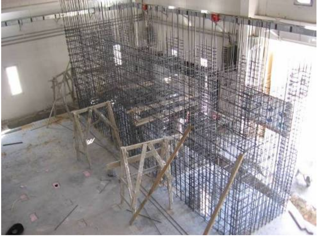
Şekil 3.13 Reaksiyon duvarı donatı demirlerinin bağlanması
