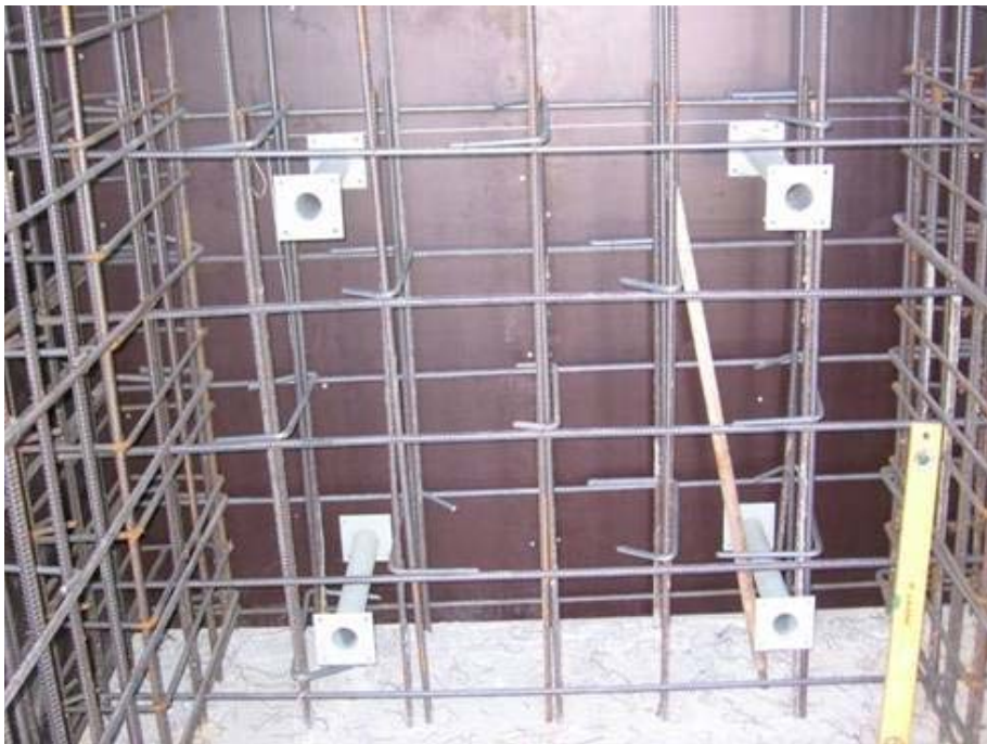
Şekil 3.15 Reaksiyon duvarı ankraj kılıflarının yerleştirilmesi
