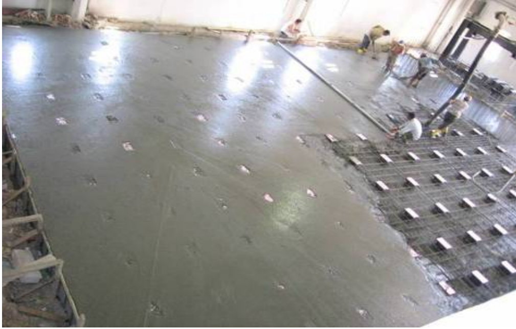
Şekil 3.11 Beton yüzeyinin alüminyum kutu profil ile düzeltilmesi
