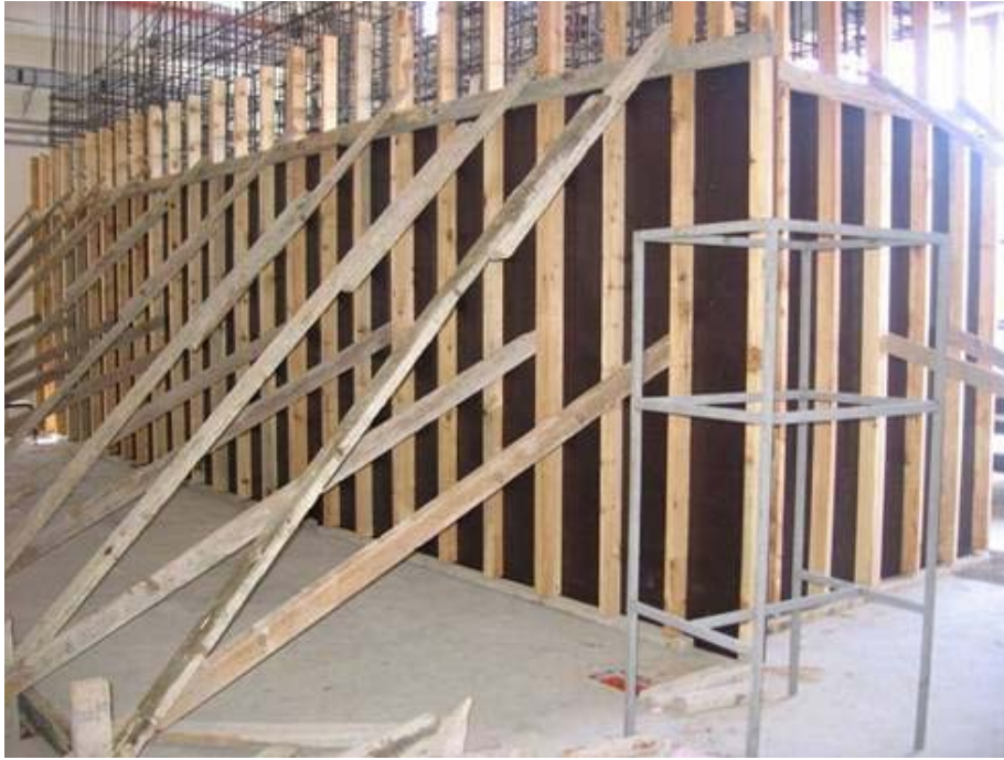
Şekil 3.14 Reaksiyon duvarı kalıbı
