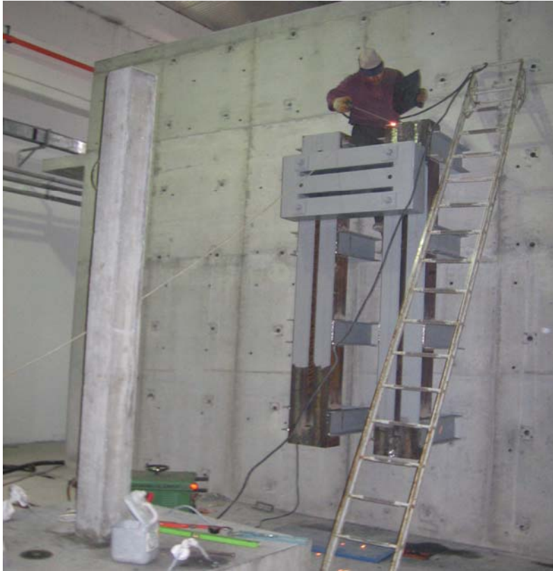
Şekil 3.23. Veren düşey ve yatay mesnet kızağının montajı
