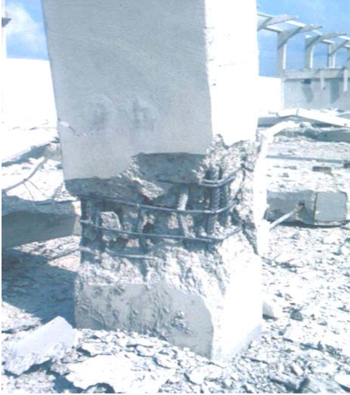
Şekil 2.1 PBA kolonda mafsallaşma
