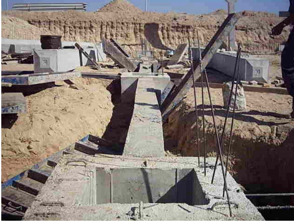
Şekil EK.5 Tamamlanmış bağ kirişleri
