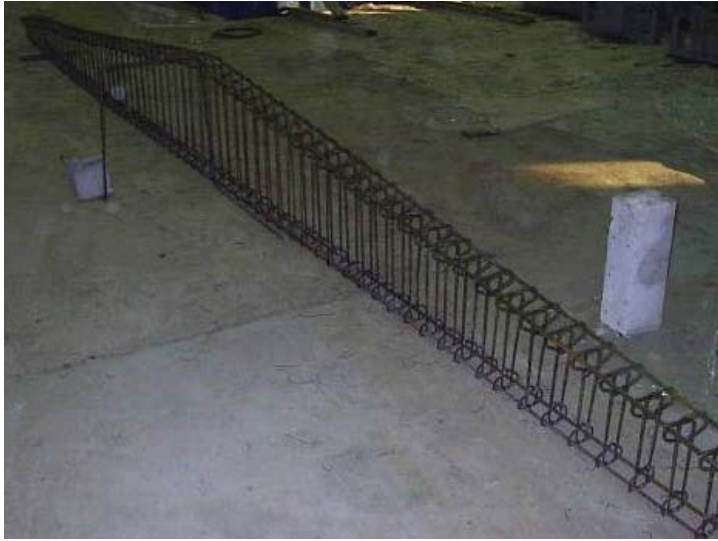
Şekil 4.15 Makas donatısı
