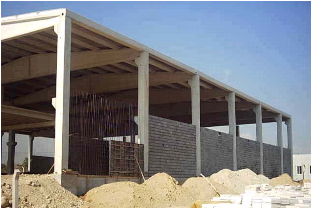
Şekil EK.17 Duvar imalatı
