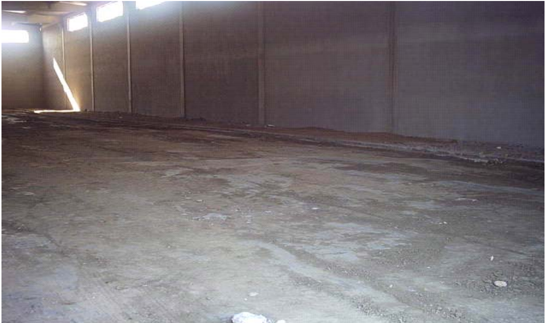
Şekil EK.19 Zemin üstü betonu hazırlıkları
