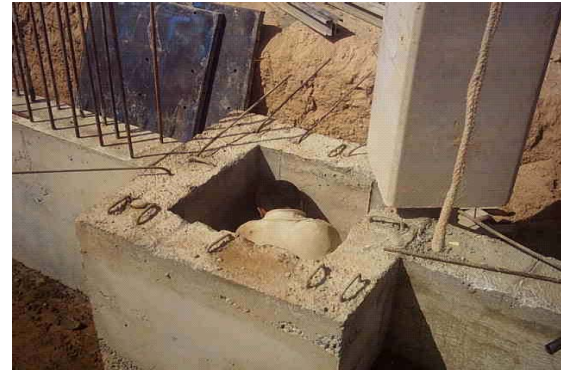
Şekil EK.8 Soket içinin hazırlanması
