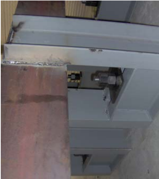
Şekil 3.21. RD Veren düşey mesnet kızağının montajı 2
