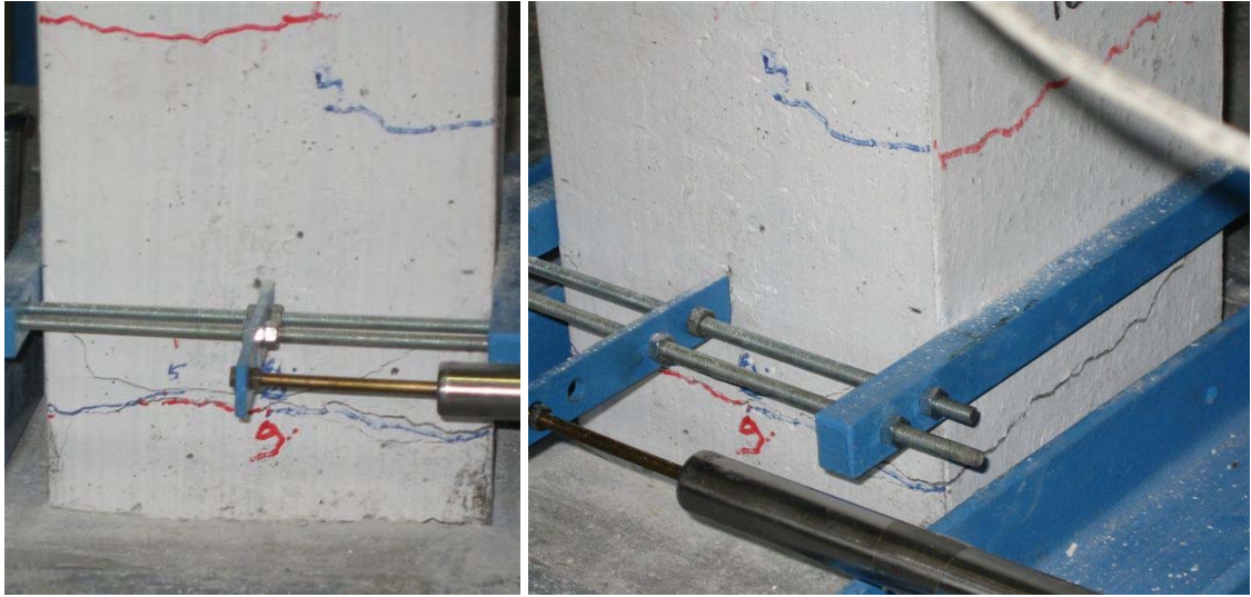
Şekil 4.78 Kolon alt bölgesinde oluşan hasarlar
