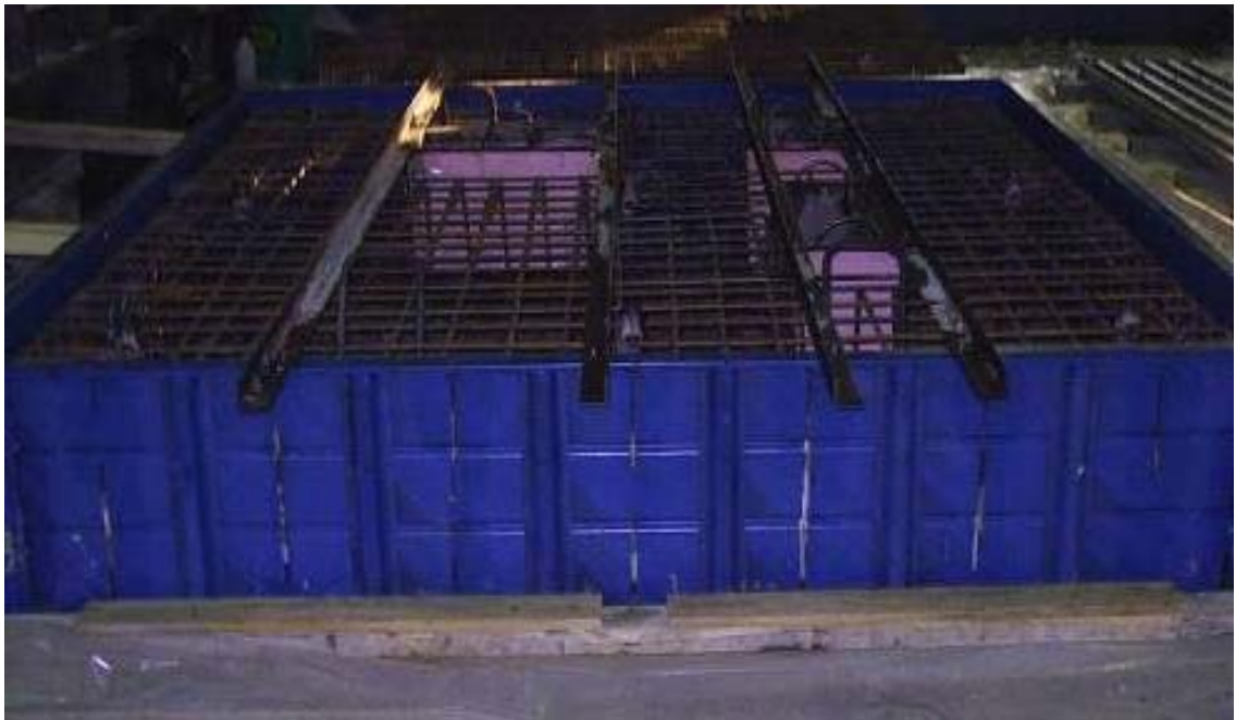
Şekil 4.18 Temel donatısının kalıba yerleştirilmiş durumu
