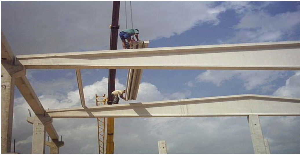
Şekil EK.13 Aşık montajı-1
