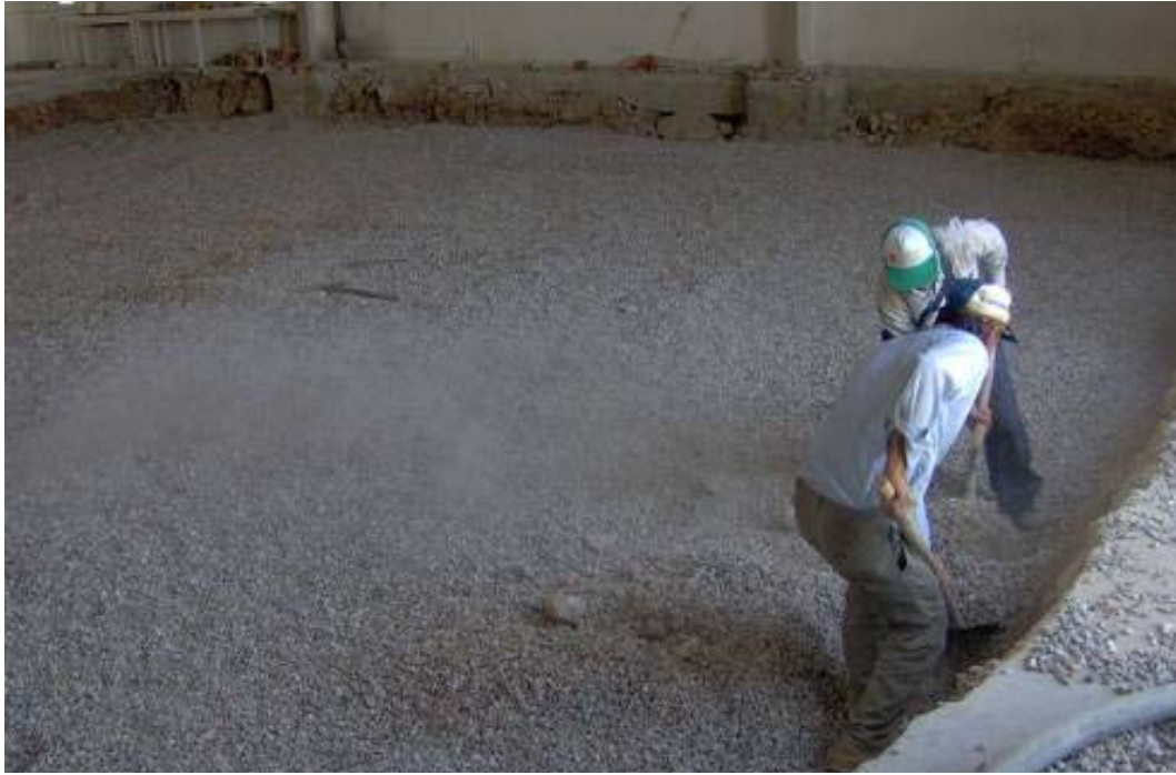
Şekil 3.8 Kazı sonrası mıcıır serilmesi
