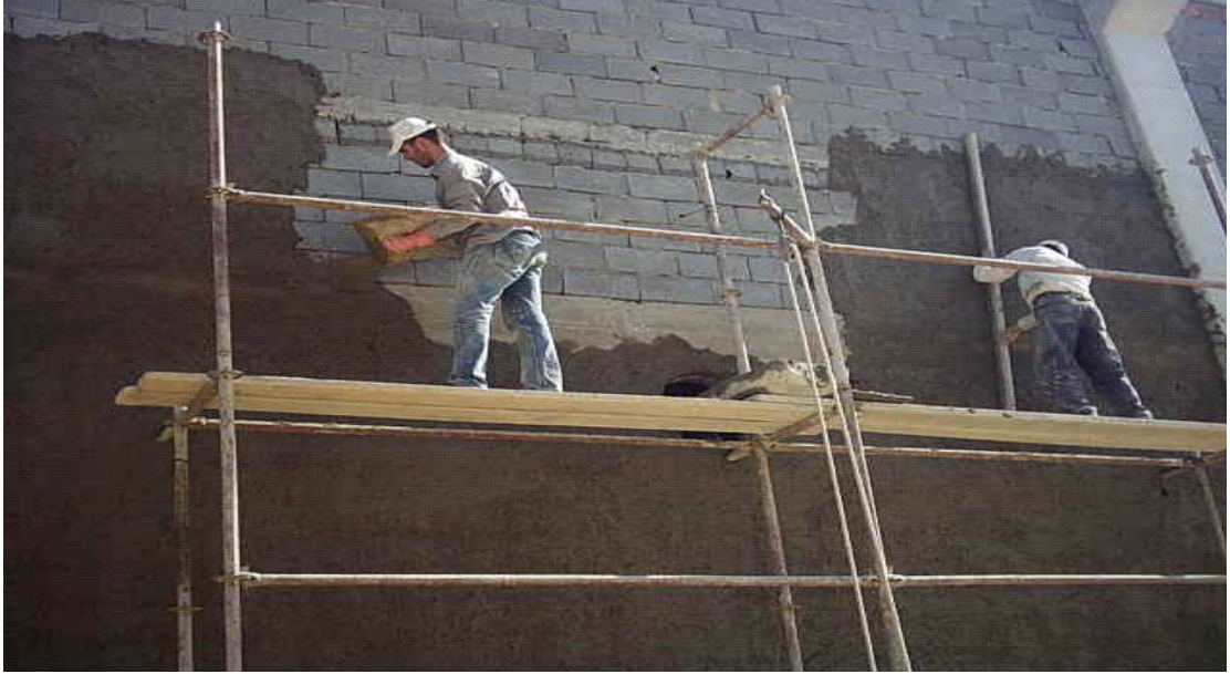
Şekil EK.18 Sıva çalışması
