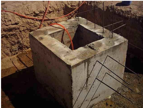
Şekil EK.3 Soket ve bağ kirişi filizleri
