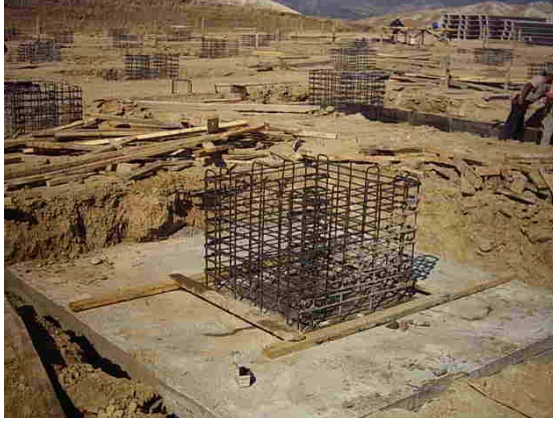
Şekil EK.1 Soket donatısı ve kalıp işleri
