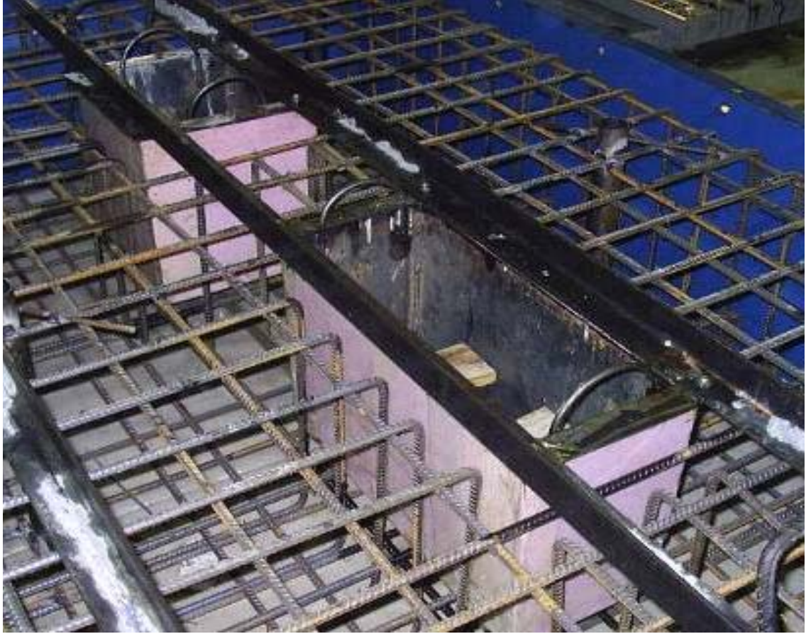
Şekil 4.19 Temellerde perde ve kolon soket kalıplarının yerleştirilmesi
