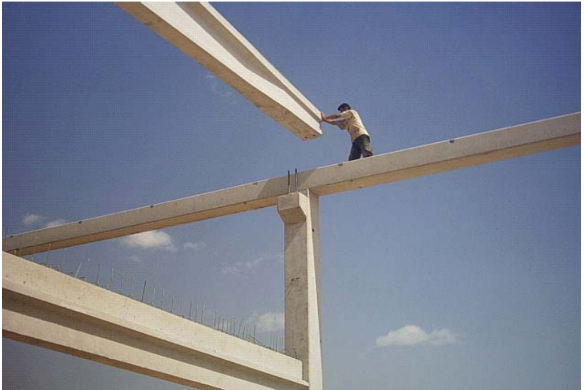
Şekil EK.12 Makas montajı-2
