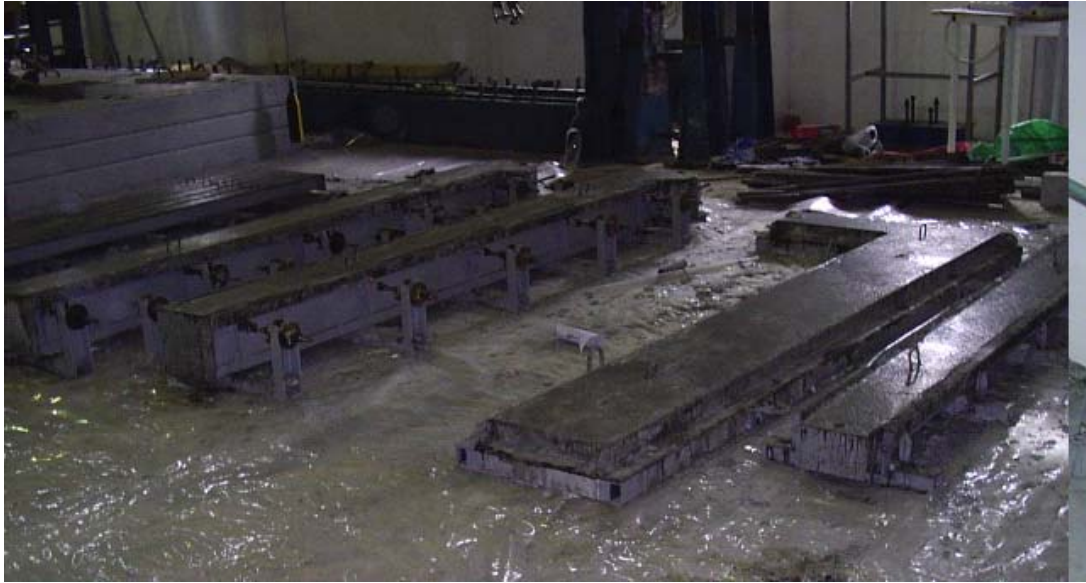
Şekil 4.24 Beton dökümünden hemen sonra elamanlar
