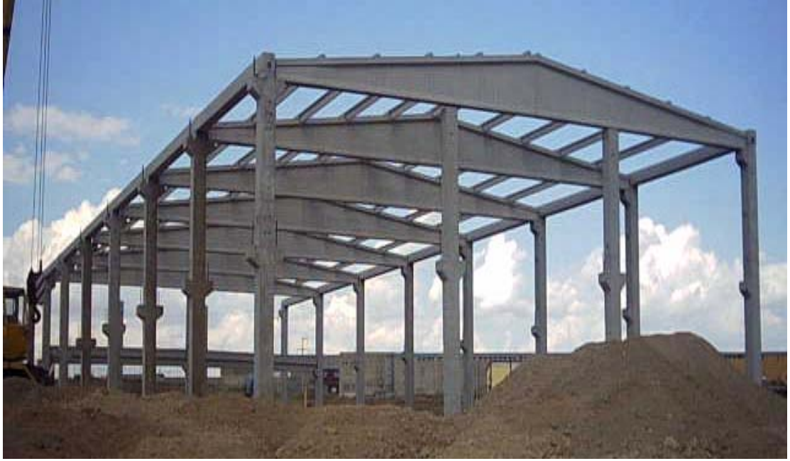
Şekil EK.15 BA iskeleti tamamlanmış SY
