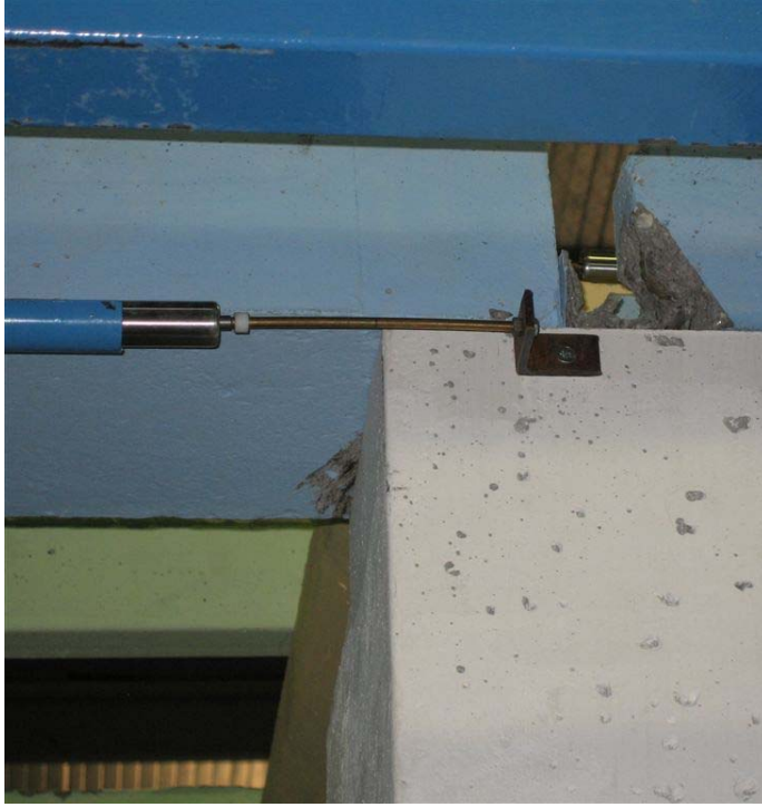
Şekil 4.74 O1-S4 birleşim bölgesinde oluşan hasar
