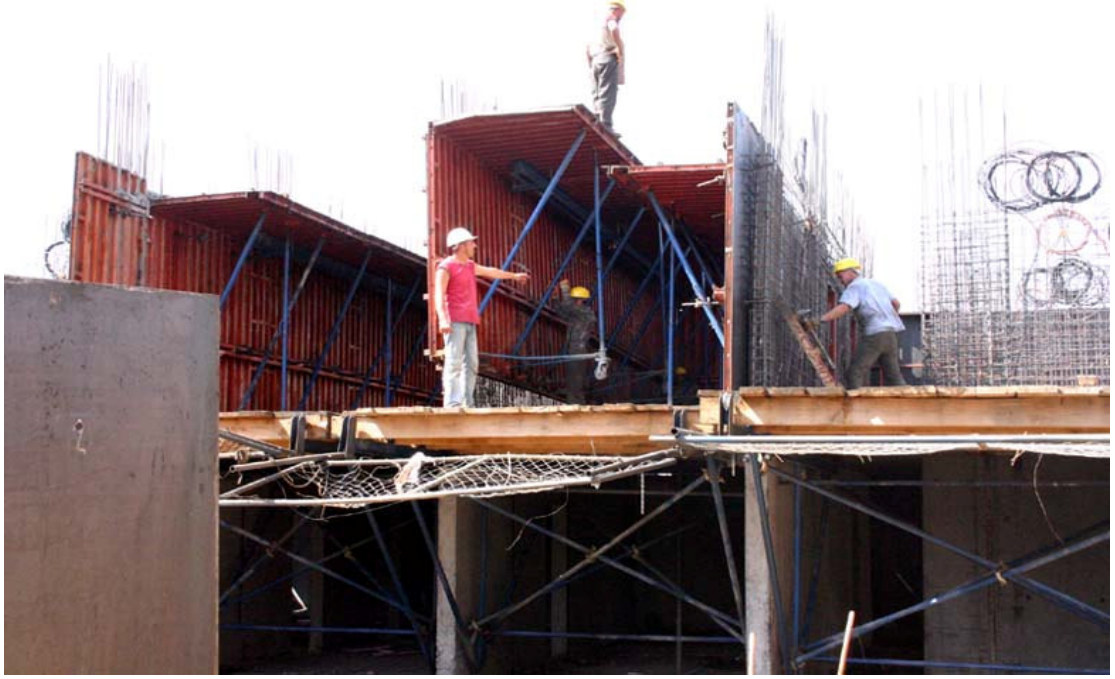
Resim 2.1. Klasik Tünel Kalıp Sistemin Görünümü.
