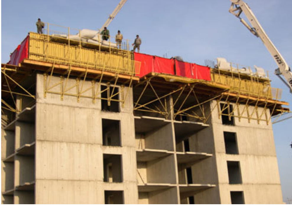
Resim 2.2. Klasik Tünel Kalıp Sistem Uygulanan Bir Yapı Görünümü.
