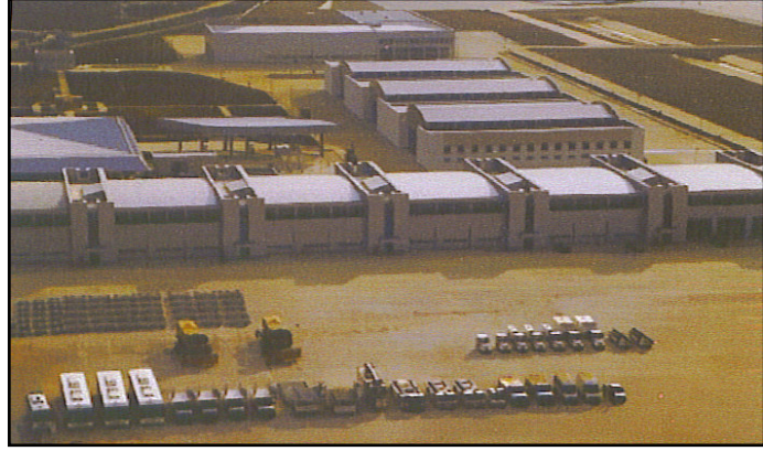
Foto 25. Sabiha Gökçen Havaalanı apron ve yan hizmetler binaları
