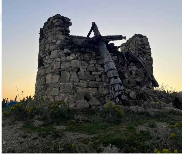
Şekil 4.113. Hayrullah Dalyan isimli kişiye ait olduğu bilinen yel değirmenin çürümüş ahşap mekanizması, 10.11.2024 tarihinde Sıdika Çakıl tarafından yerinde çekimi.
