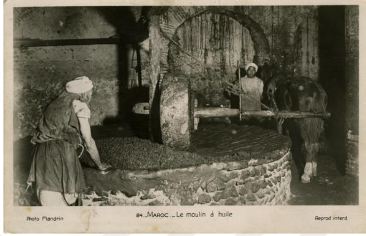
Şekil 3.8. Fas'ta at gücü kullanılarak çalışan yağ sıkılan değirmen (Mills Archive Trust, t.y.)
