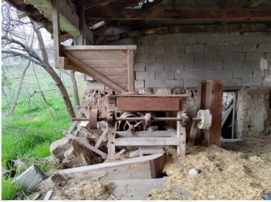
Şekil 4.69. Değirmenin iç mekânındaki makine aksamına görünüm, 21.02.24 tarihinde Sıdika Çakıl tarafından yerinde çekimi.
