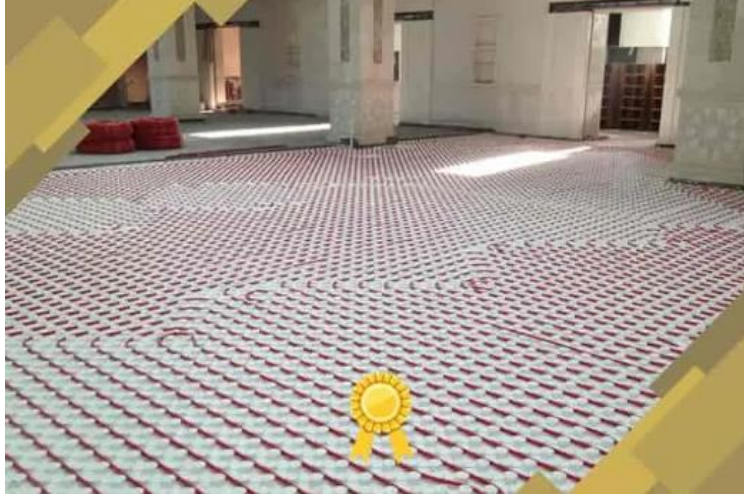
Şekil 3.3. Camilerde Yerden Isıtma Sistemi
