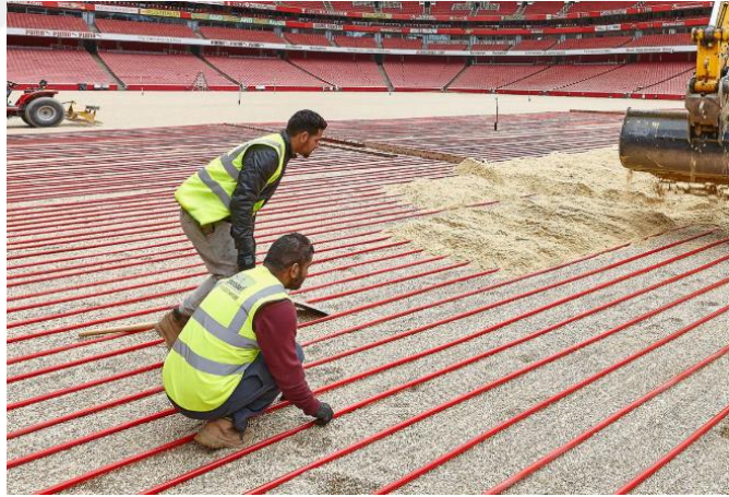
Şekil 3.4. Futbol Sahalarında Yerden Isıtma Sistemi
