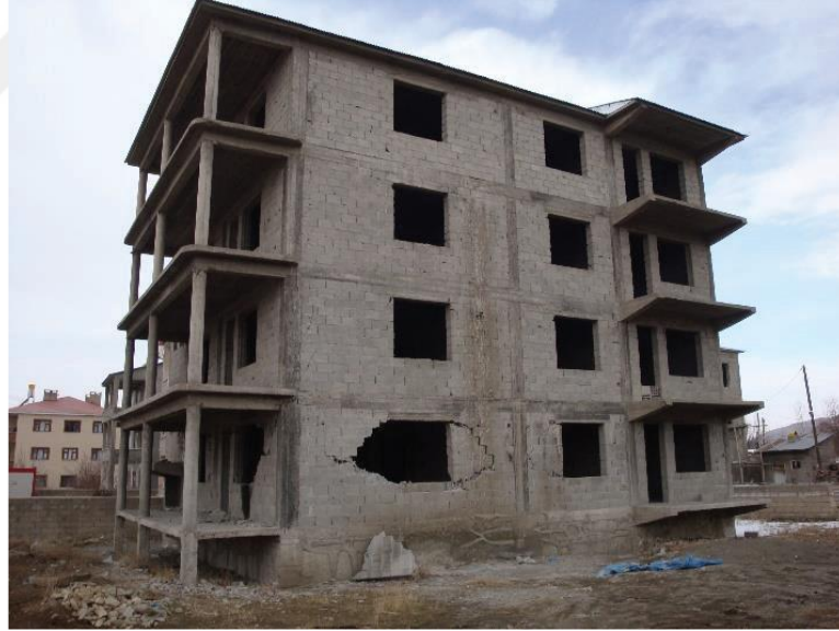
Şekil 3.6. Kuşatılmış yığma yapı örneği (Smyrou, 2016)
