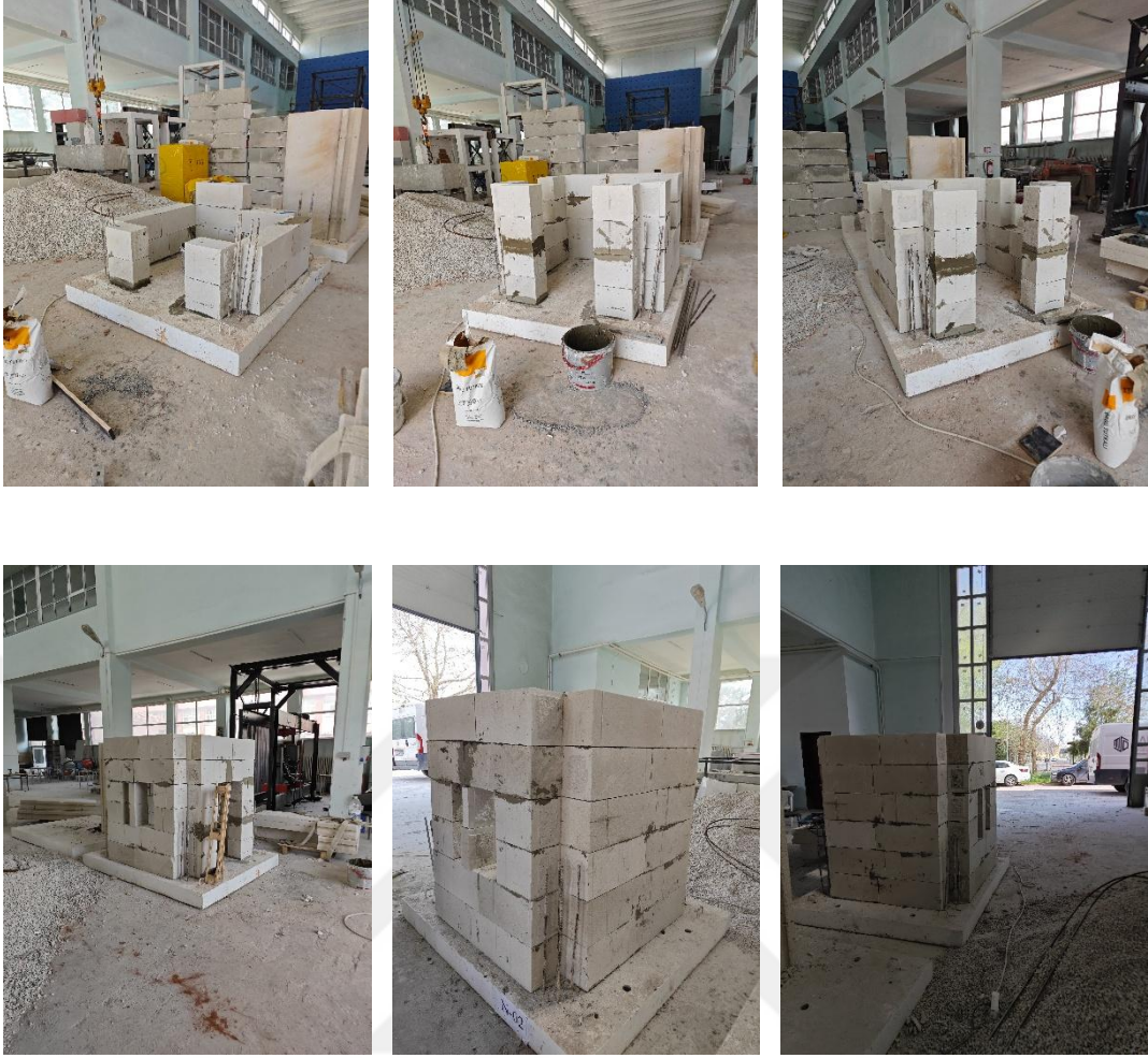
Şekil 6.13. Kuşatılmış yığma yapıda duvar örülmesi
