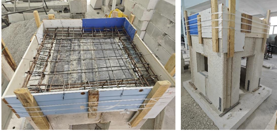
Şekil 6.20. Donatılı panel sistemli yapı numunesinin kalıp ve donatılarının hazırlanması
