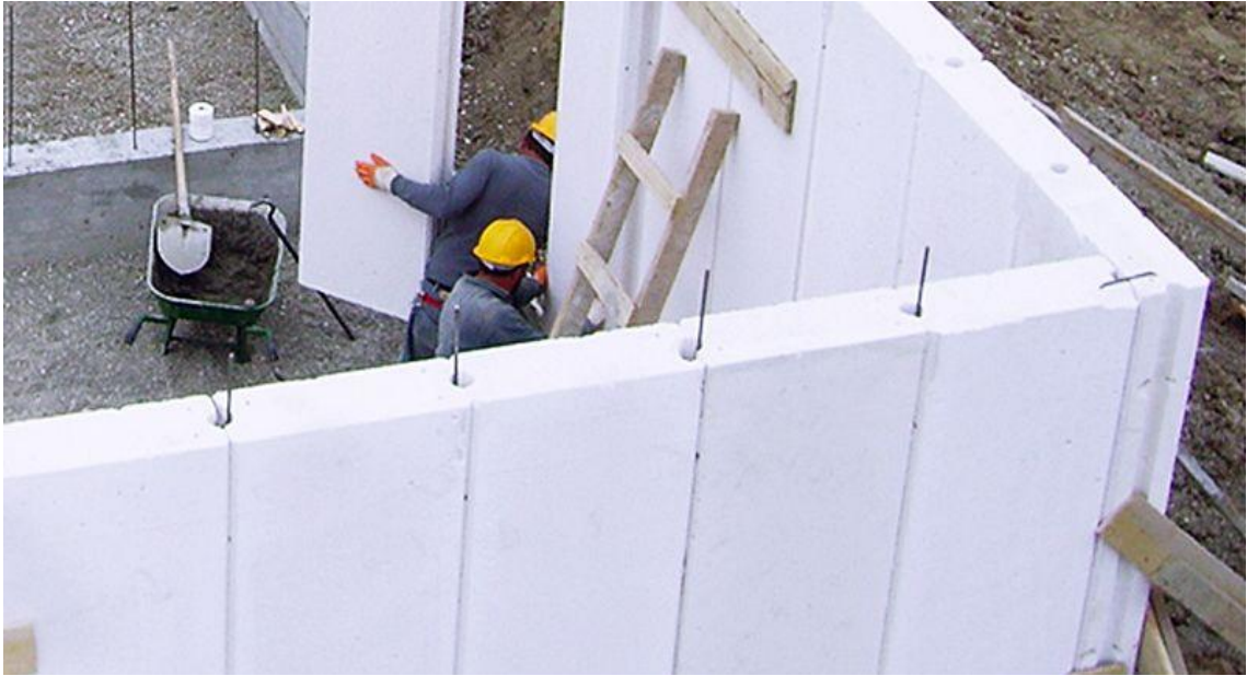
Şekil 3.7. Donatılı panel sistemli yığma yapılar (Türkoğlu A. , 2022)
