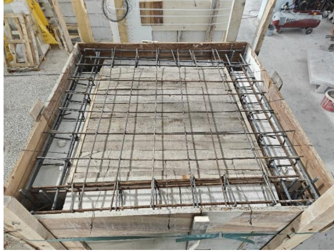
Şekil 6.16. Kuşatılmış yığma yapı döşeme donatılarının yerleştirilmesi
