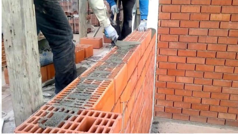
Şekil 3.8. Yığma tuğla duvarı (Erçolak, 2021)
