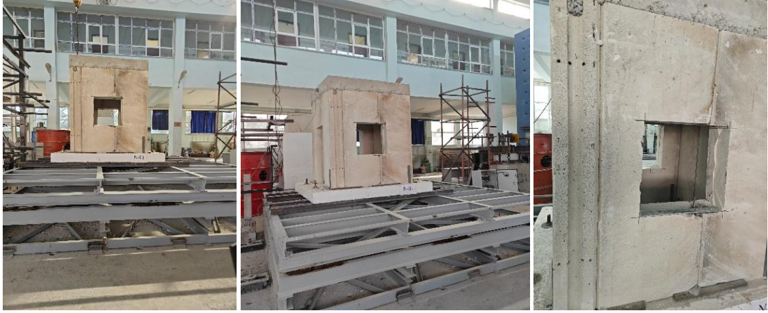
Şekil 7.2. N-01 Donatılı Panel Sistemli yığma yapı numunesinin deney sonrasındaki görünümü
