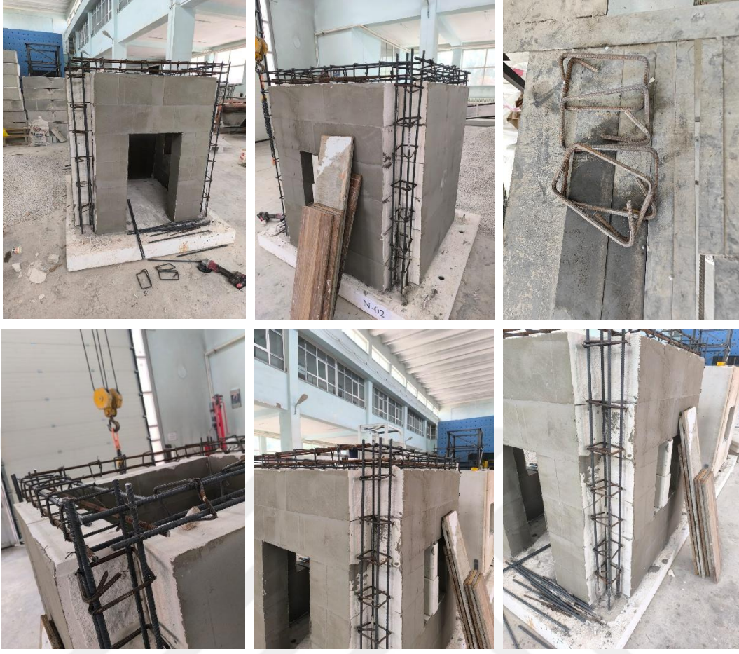
Şekil 6.14. Kuşatılmış yığma yapı düşey ve yatay hatıl donatılarının yerleştirilmesi
