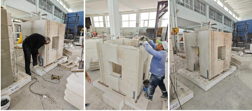
Şekil 6.19. Donatılı panel sistemli yığma yapı numunesinin hazırlanması
