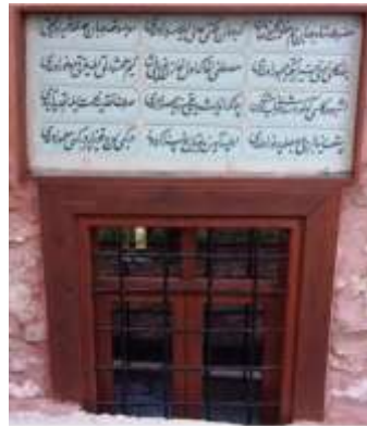
Şekil 4. 85. (Üç Kozlar) Yediler Türbesi güney duvarındaki onarım kitabesi (Gök arşivi, 2022)
