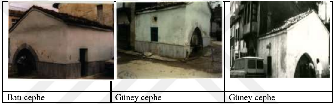
Şekil 4. 50. Ebu İshak Kazeruni Türbesi, batı ve güney cephesi (BKVKKA, 1997)
