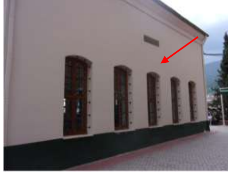
Şekil 4. 145. Üftade Hazretleri Türbesinin batı cephesinde yer alan hacet penceresi (Gök arşivi, 2022)
