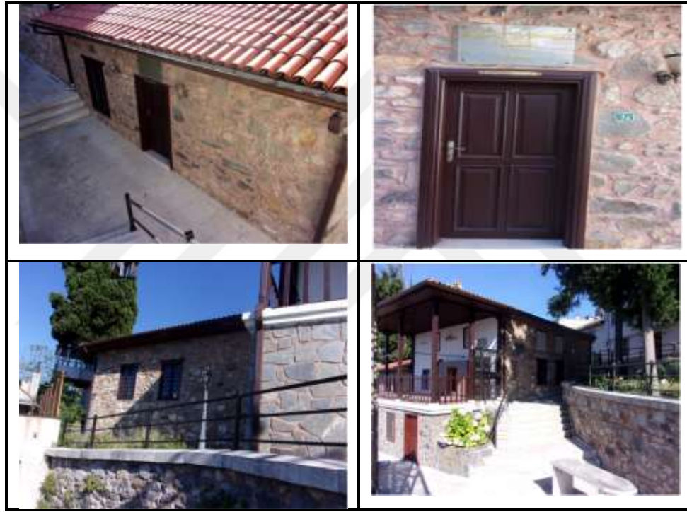
Şekil 4. 11. Hüsamettin Bursavî Türbesi dış cephe ve giriş kapısı (Gök arşivi, 2022)
