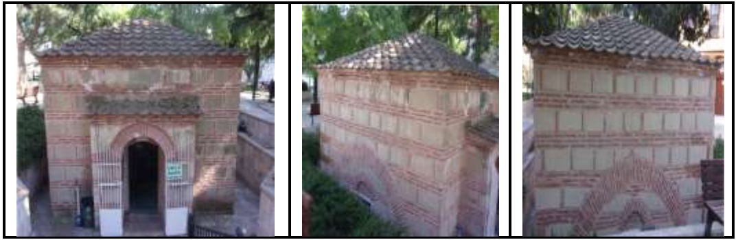
Şekil 4. 23. Okçu Baba Türbesi taç kapısı, doğu ve kuzey cephesi (Gök arşivi 2022)
