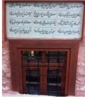
Şekil 4. 146. (Üç Kozlar) Yediler Türbesi güney duvarındaki hacet penceresi (Gök arşivi, 2022)
