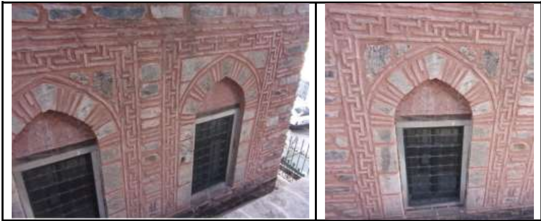
Şekil 4. 40. Abdüllâtif Kudsî Türbesi tuğla malzeme ile zencerek motifi (Gök arşivi 2022)
