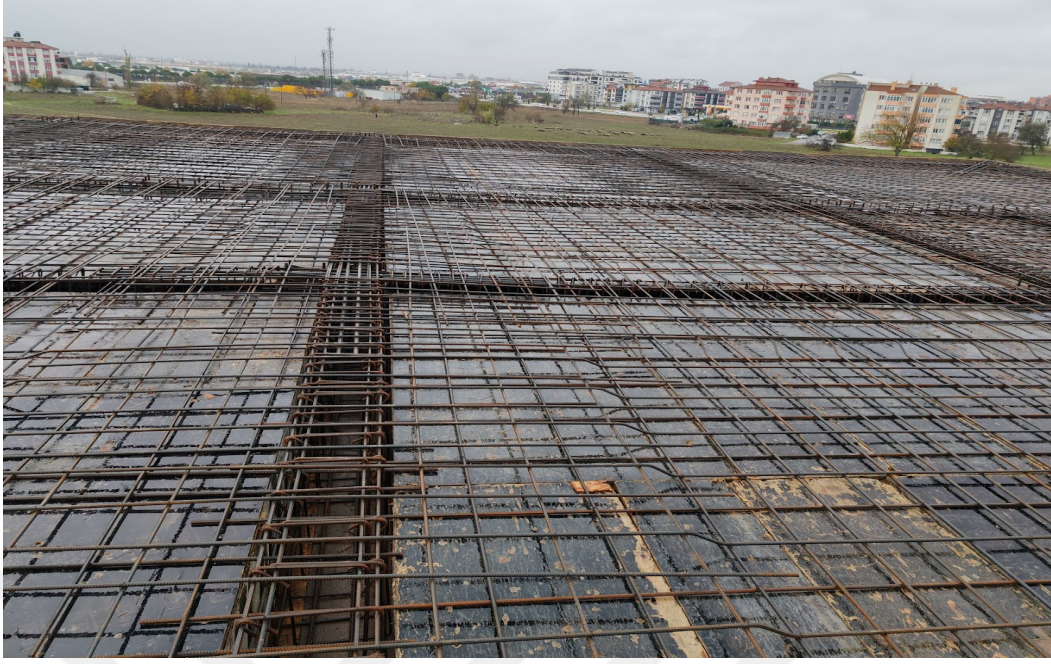
Şekil 1.24. Yerinde dökme beton kiriş (Saha kontrollerinden alıntılanan fotoğraf)
