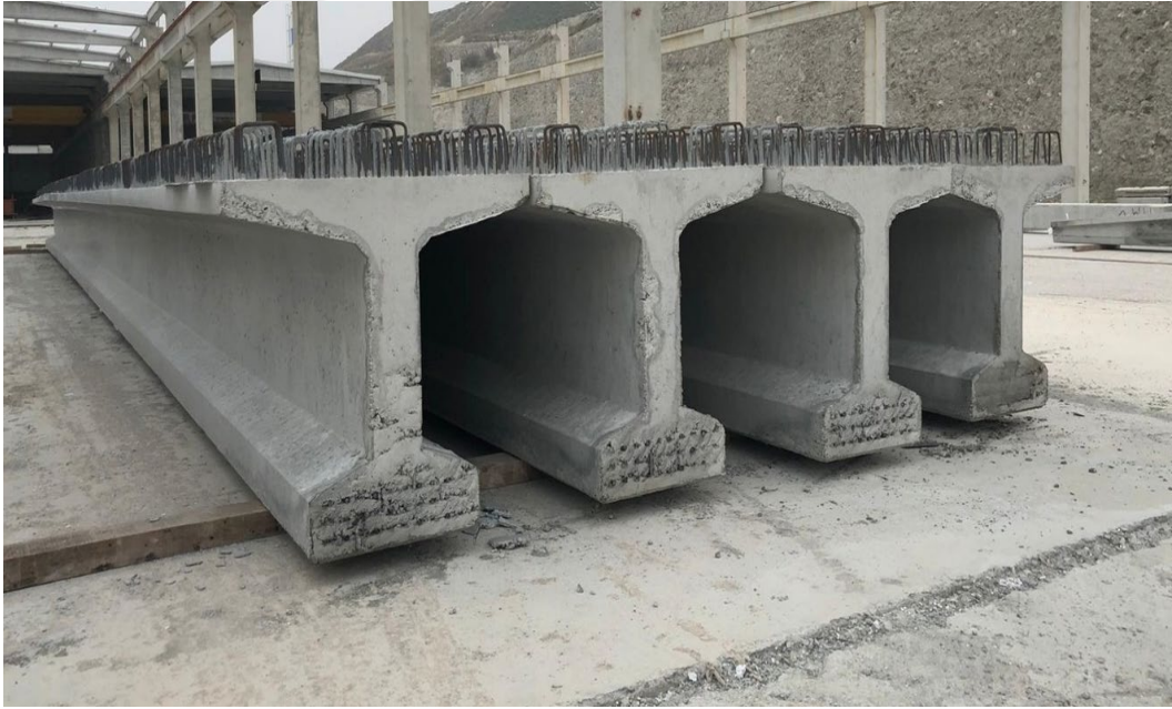
Şekil 1.25. Öngermeli beton kiriş (Anonim 18)
