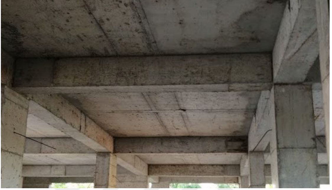
Şekil 1.12. Betonarme kiriş (Saha kontrollerinden alıntılanan fotoğraf)
