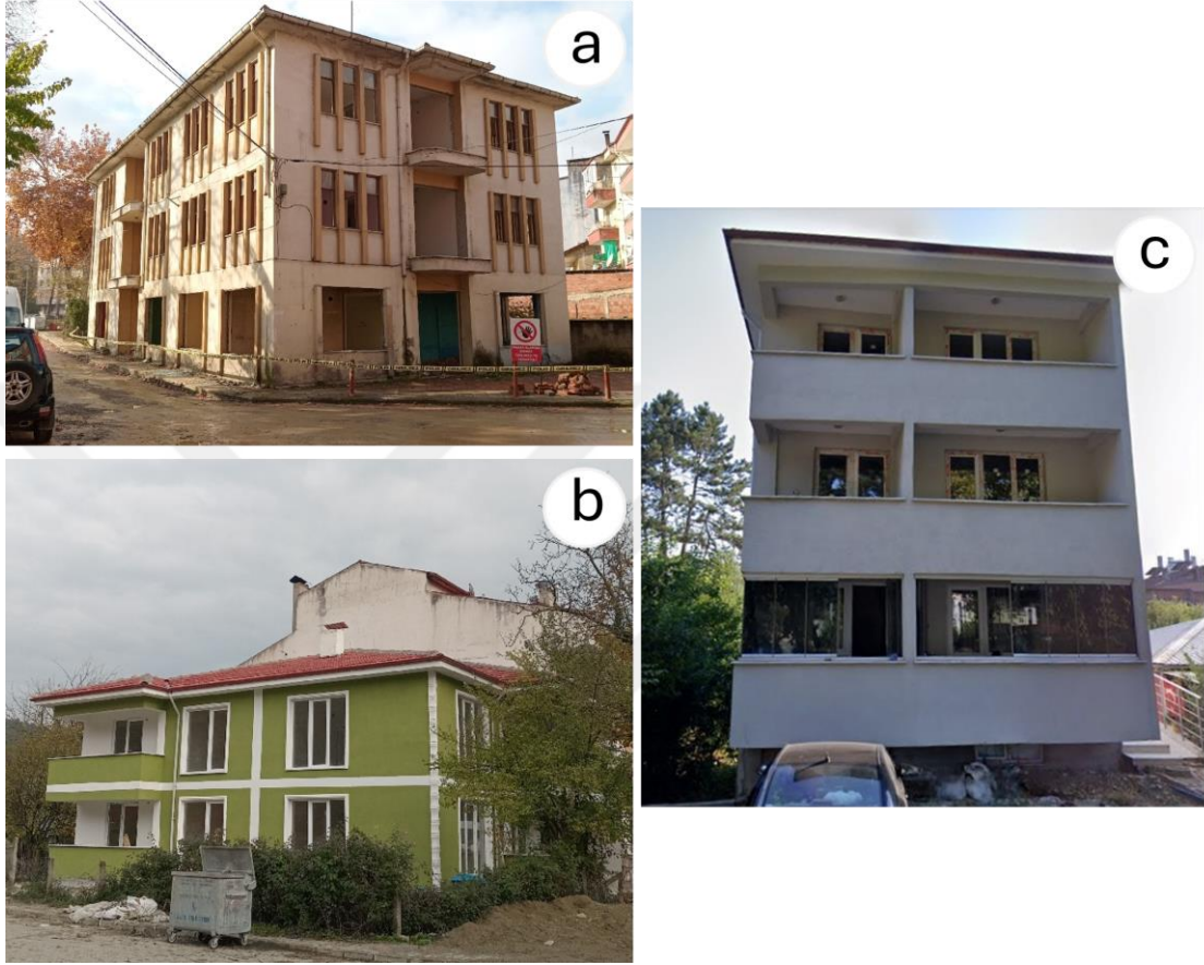
Fotoğraf 11. Bina statüsüne göre örnek yapılar a) terk edilmiş bina b) inşaat halinde bina c) boş bina
