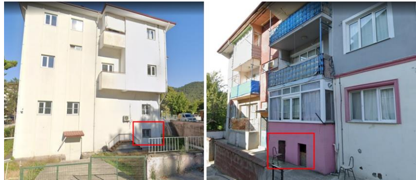
Fotoğraf 6. Bodrum varlığı olan yapılara örnekler.
