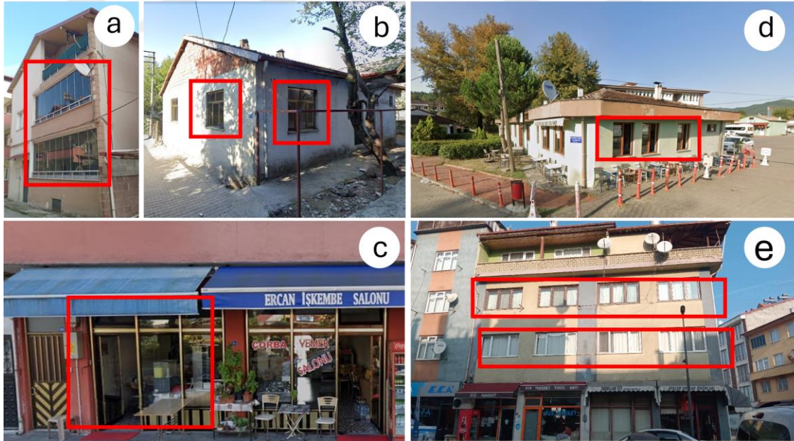
Fotoğraf 15. Pencere malzemesine göre örnek yapılar a) pimapen b) demir c) alüminyum d) ahşap e) karışık pencere sistemi (1. kat pimapen, 2. Kat ahşap )
