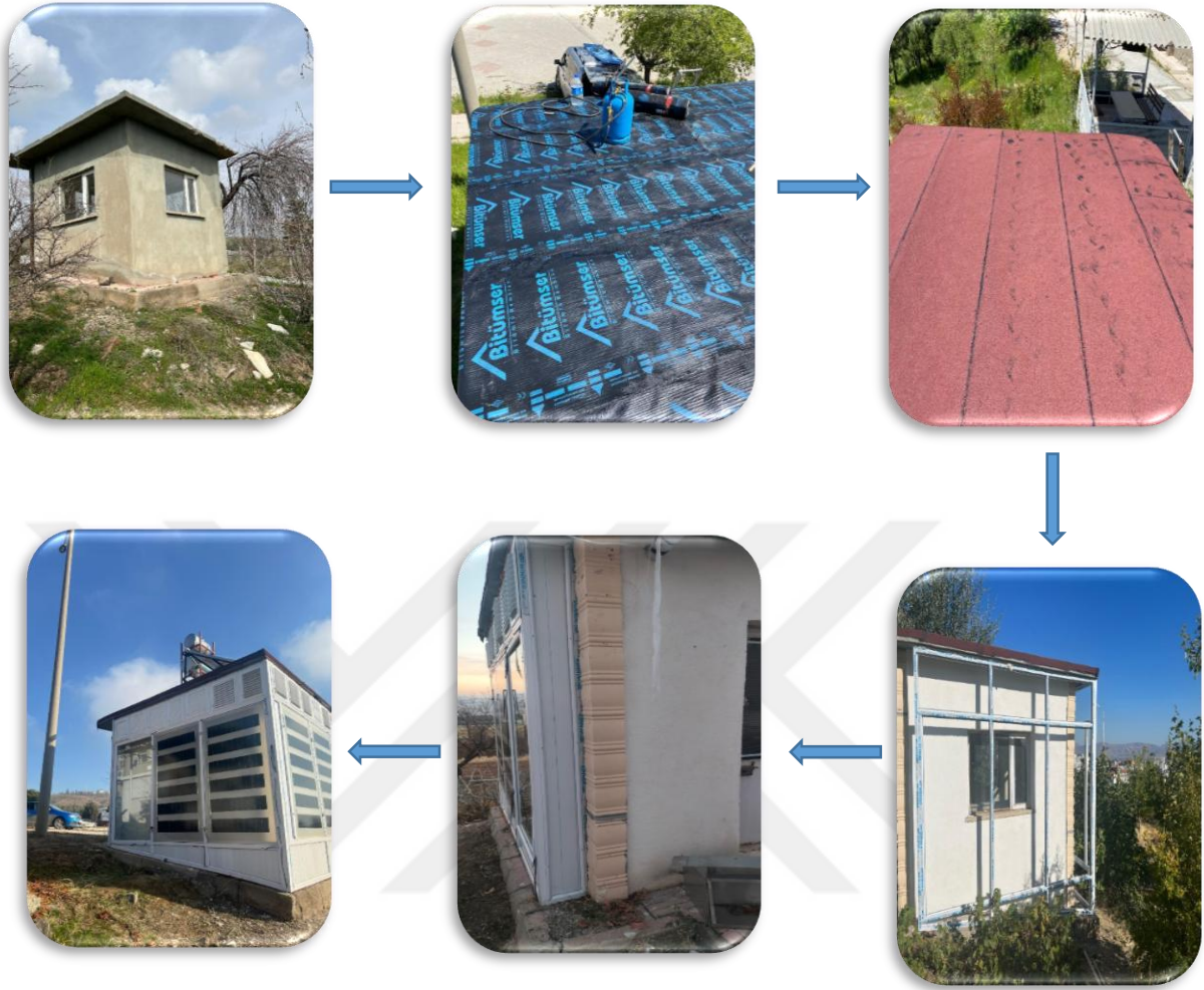
Şekil 3.4. PVC profillerden oluşturulan faade kaplama sistemi ve PV panellerle bütnleřik grnm.
