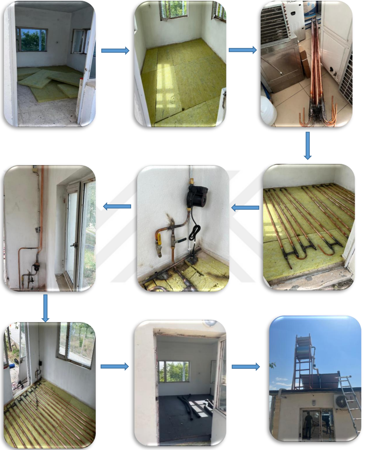
Şekil 3.3. Yerden ısıtma ve FDM destekli ısı depolama sisteminin uygulama aşamaları
