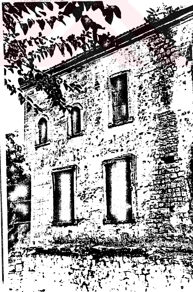
RESİM.V.II.9.23-CEPHEDE, DERZ BOŞALMALARI, TAŞ DÜŞMELERİ (E.T.K.V.K.K.)
