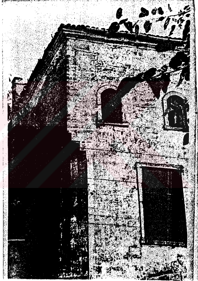
RESİM.V.II.7.13- BASIK DAİRESEL KEMERLİ, PENCERELER VE KÖŞE PAHI.
