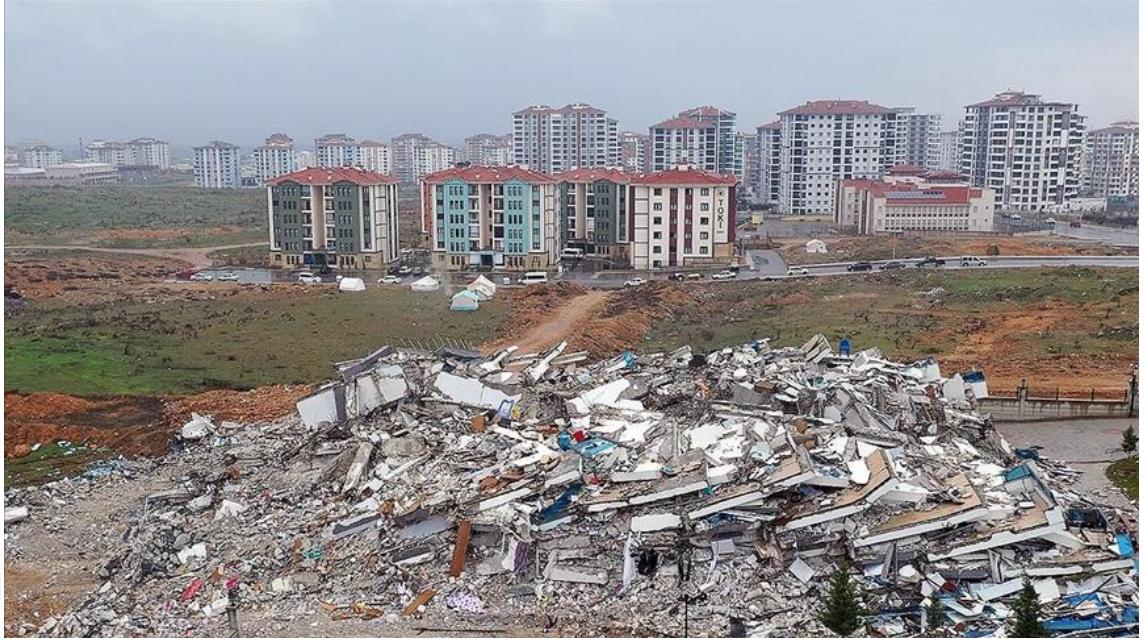
Şekil 1.1 6 Şubat depreminde yıkılan karkas yapı sistemi ve yıkılmayan tünel kalıp sistemi ile yapılmış yapılar
