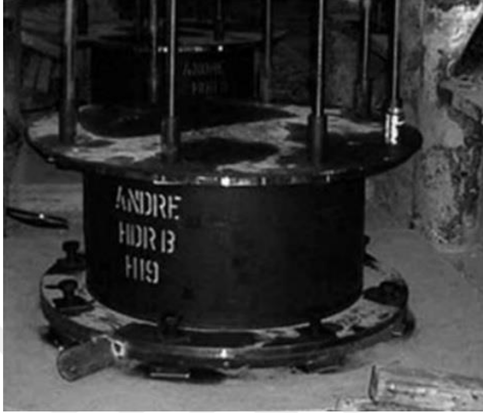
Şekil 3.10 Yüksek sönümlü kauçuk izolatör (Güner,2012)
