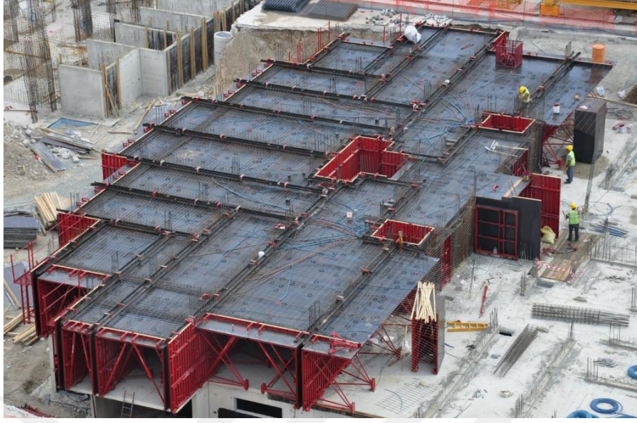
Şekil 3.2 Tünel kalıp döşeme donatısının imalatı
