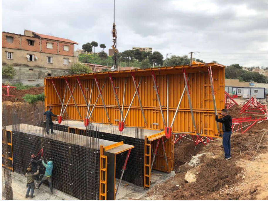
Şekil 3.1 Tünel kalıp perde donatısının imalatı
