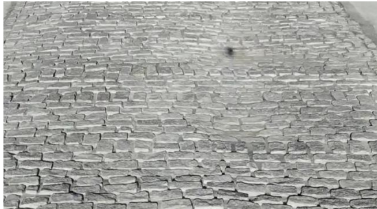
Şekil 2.11 Arnavut kaldırım taşlı zemin [33]
