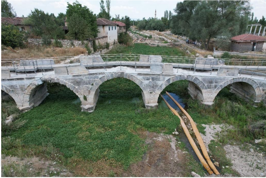
Görsel 3.9: Köprüler ve Barajlar Orijinal Fotoğrafı
