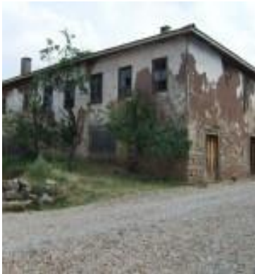
Resim 26: Eski okul binası
