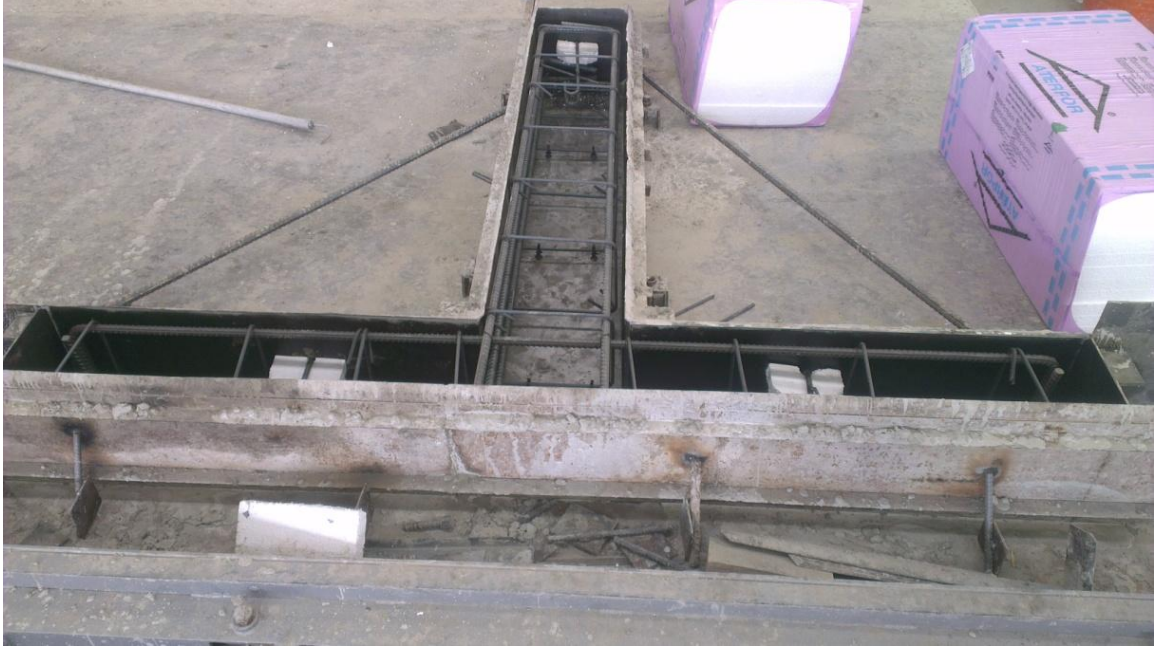
Şekil 3.3.5 Eleman kalıbı beton dökümüne hazır son hali
