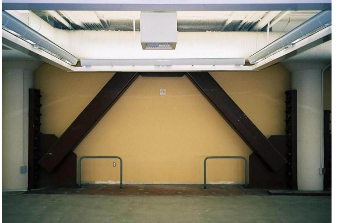
Şekil 1.4. Çelik mantolama uygulanması
