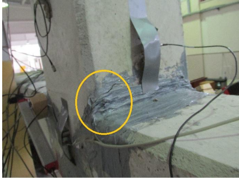
Şekil 5.6.4. CFRP ile beton ayrılması
