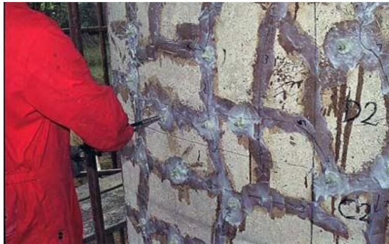
Şekil 1.2. Çatlaklara epoksi enjeksiyonu uygulanması
