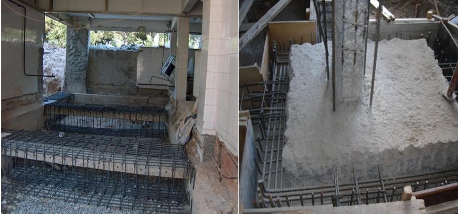
Şekil 1.3. Betonarme mantolamanın temele uygulanması
