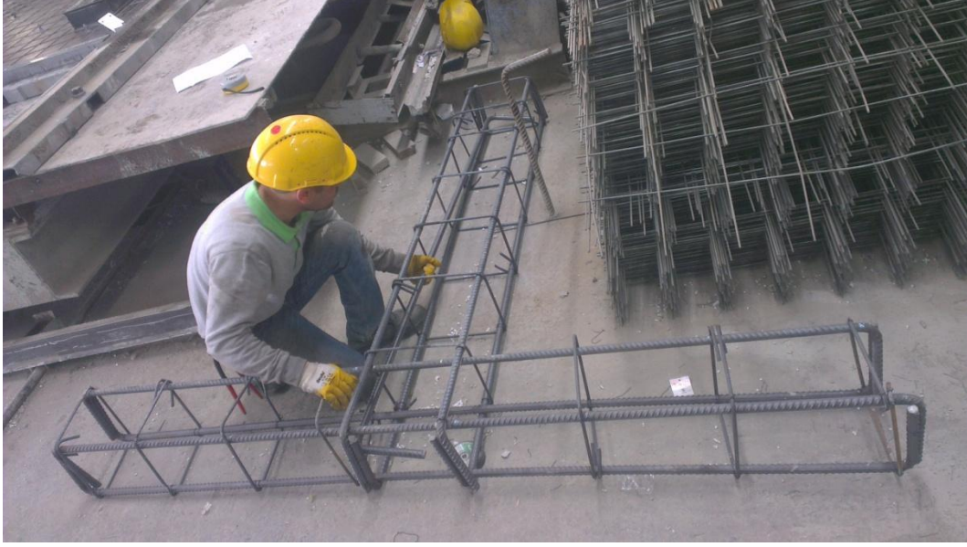
Şekil 3.3.4 İmalatı tamamlanmış eleman iskeleti
