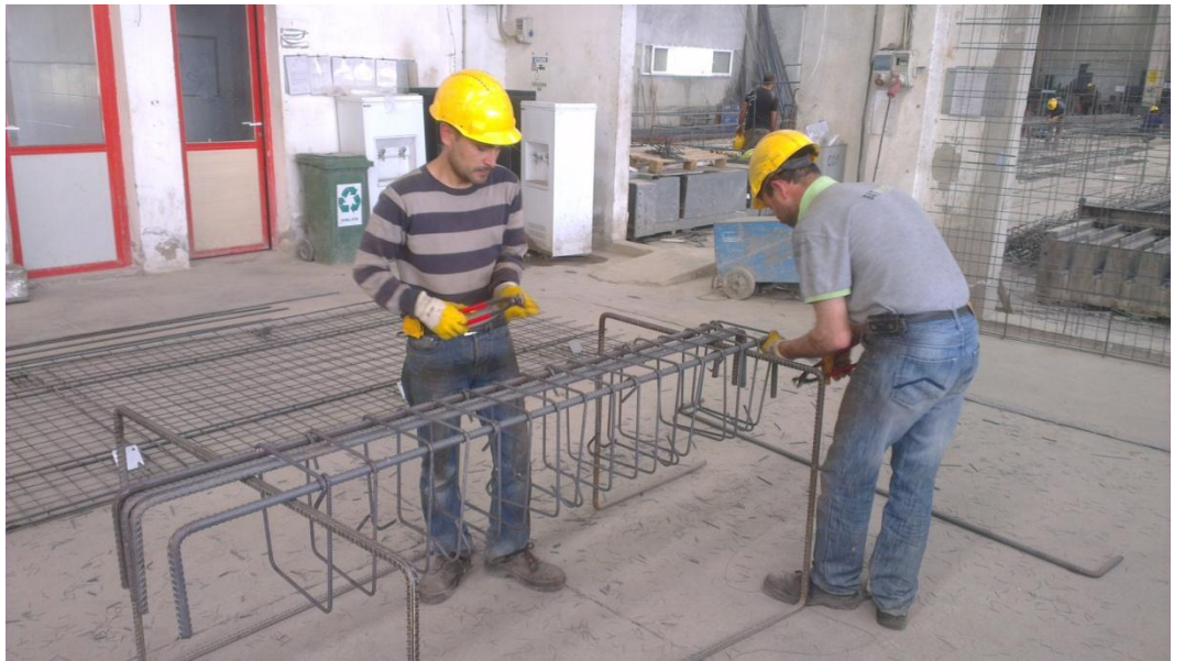
Şekil 3.3.3 Montaj donatılarının etriyelerle bağlanması
