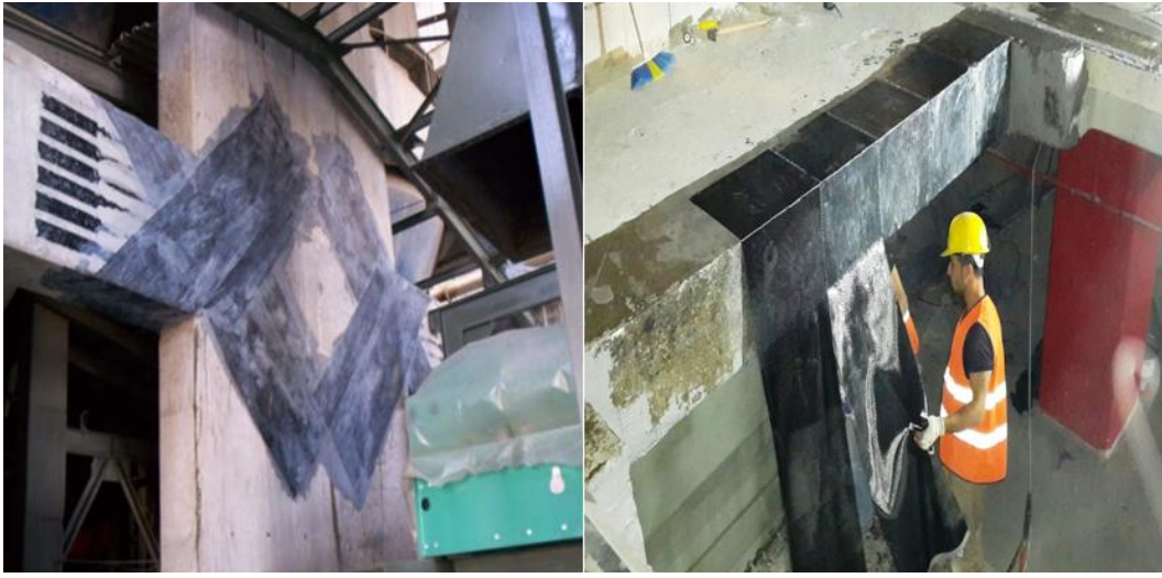
Şekil 1.5. Kolon-kiriş birleşim bölgelerine CFRP uygulanması
