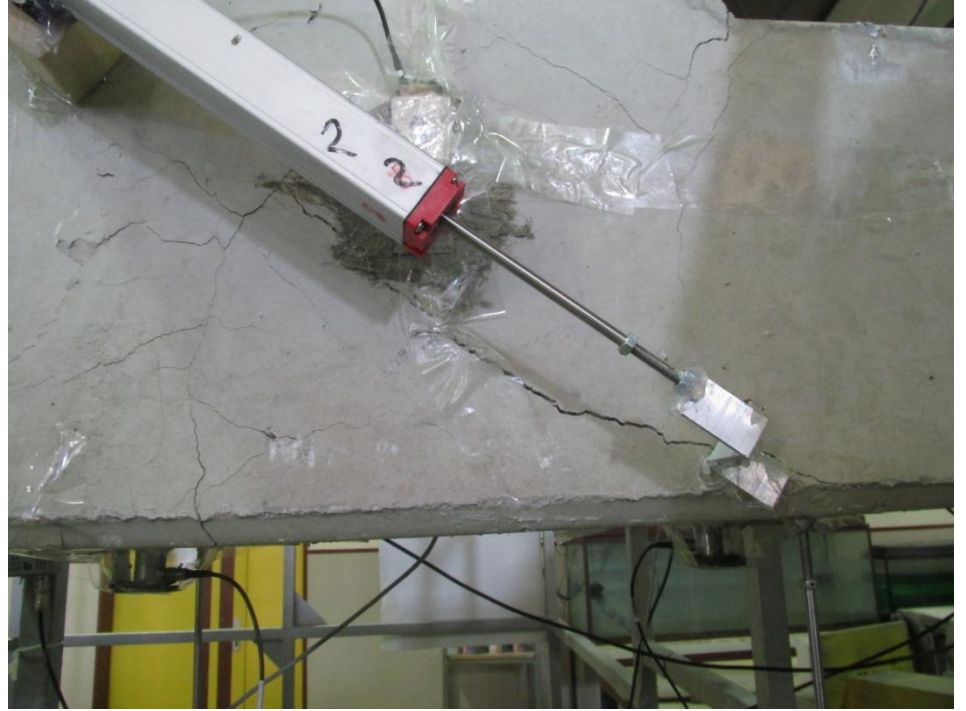
Şekil 5.3.4. Deney sonrası gözlemlenen çatlak ve deformasyonlar
