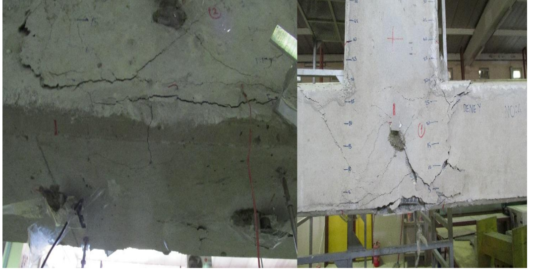
Şekil 5.7.5. Deney sonrası ön ve arka yüzde eleman altında oluşan çatlaklar
