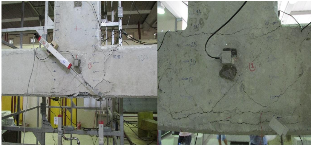
Şekil 5.7.4. Deney sonrası ön ve arka yüzde düğüm noktasında oluşan çatlaklar
