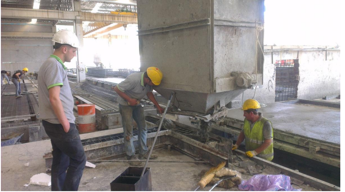
Şekil 3.3.6 Eleman beton dökümü ve kalıp vibratör kullanılması
