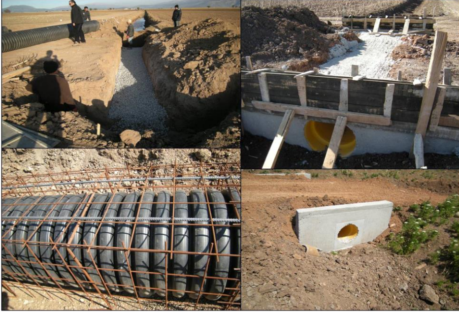
Şekil 4.8. Aydın Merkez-Yenipazar ovası su iletim sistemi inşa ve kurulum çalışmaları
