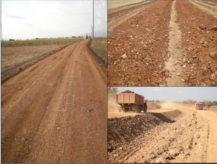
Şekil 4.4. Aydın Merkez–Yenipazar ovası tarla içi yol yapım çalışmaları
