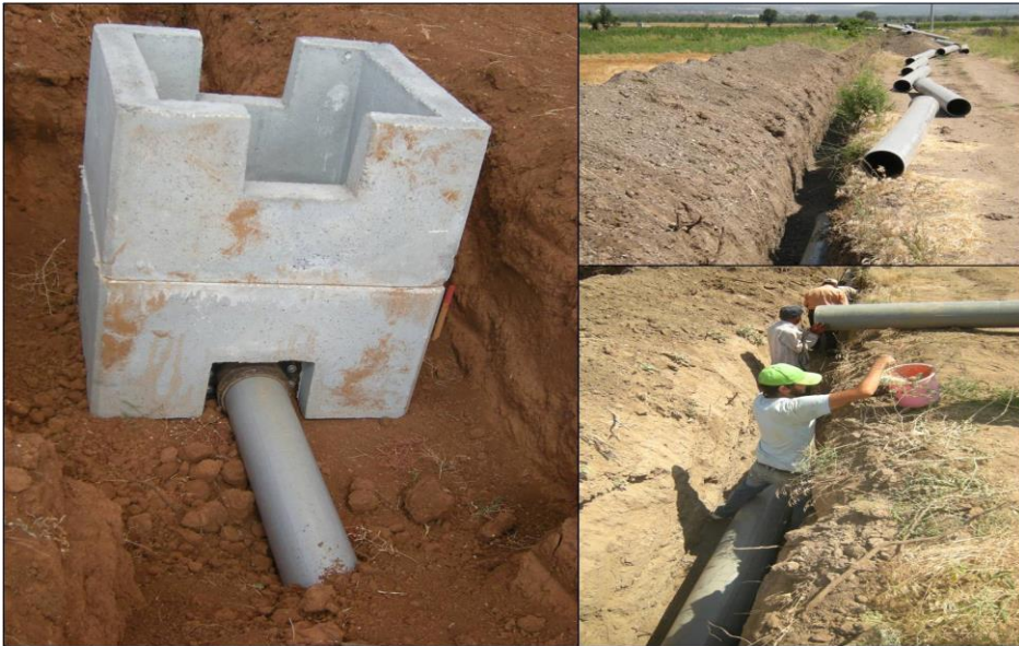
Şekil 4.9. Aydın Merkez-Yenipazar ovası su iletim sistemi inşa ve kurulum çalışmaları(devam)
