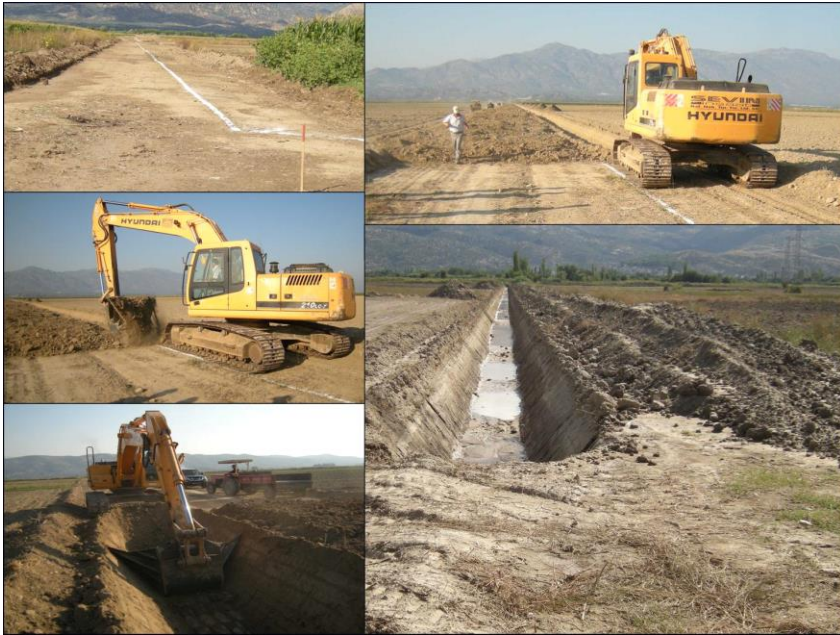
Şekil 4.12. Aydın Merkez – Yenipazar ovası yüzey drenaj kanalı yapım çalışmaları
