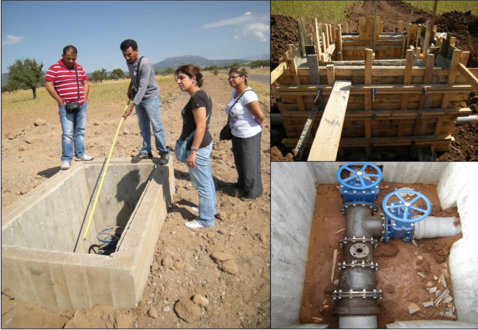
Şekil 4.10. Aydın Merkez–Yenipazar ovası su dağıtım sistemi inşa ve kurulum çalışmaları
