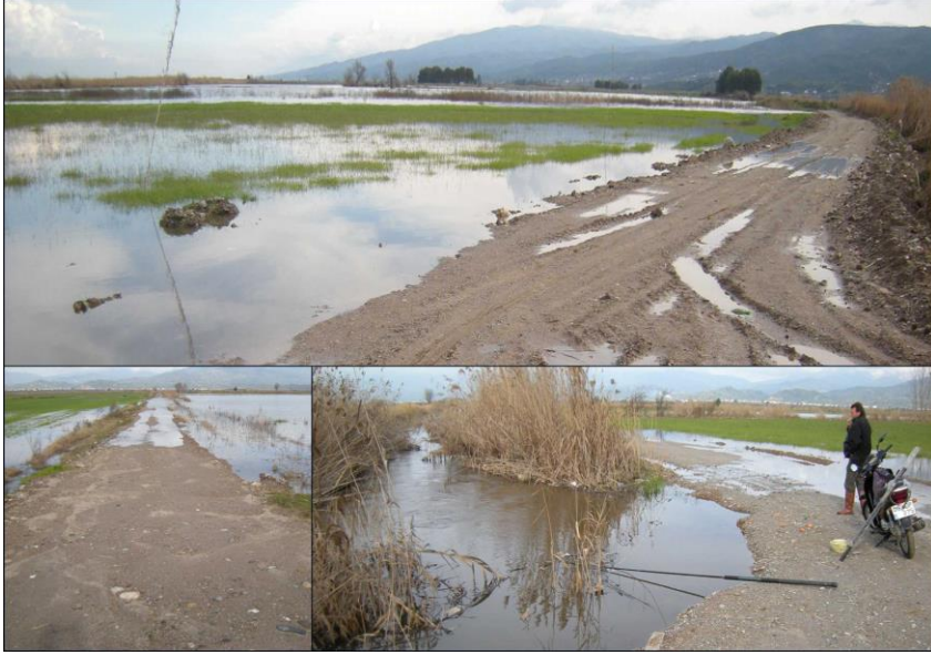
Şekil 4.11. Aydın Merkez–Yenipazar ovası yüzey drenaj kanalı yapımı öncesi bir görünüm
