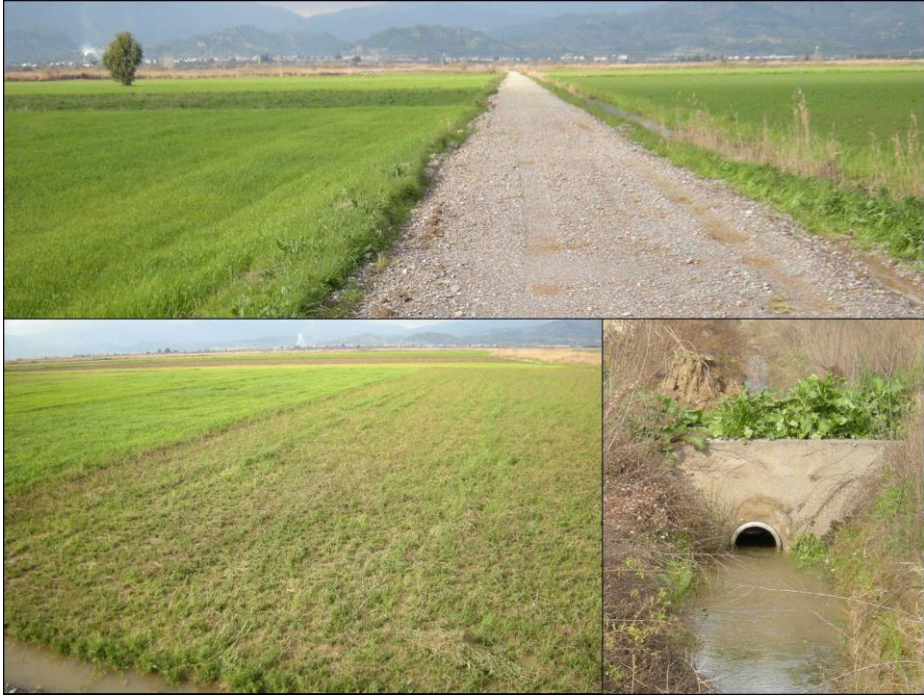
Şekil 4.13. Aydın Merkez–Yenipazar ovası yüzey drenaj kanalı yapımı sonrası bir görünüm
