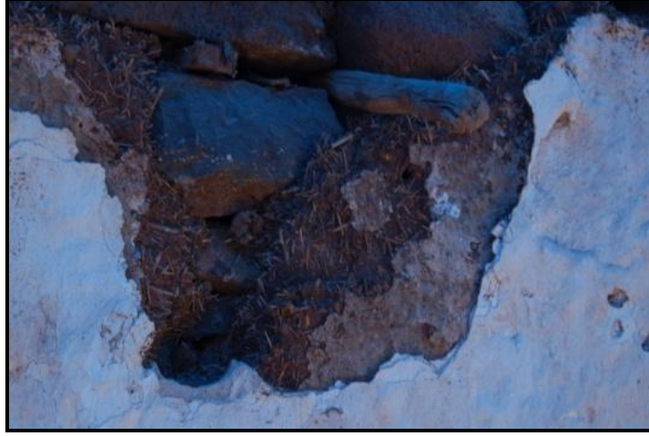
Şekil.3.41 Toprak sıva üzerine kireç uygulaması (Diyarbakır, 2012)
