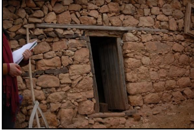
Şekil.3.50 Ahşap hatıl kullanım türü (Diyarbakır-Silvan, 2012)
