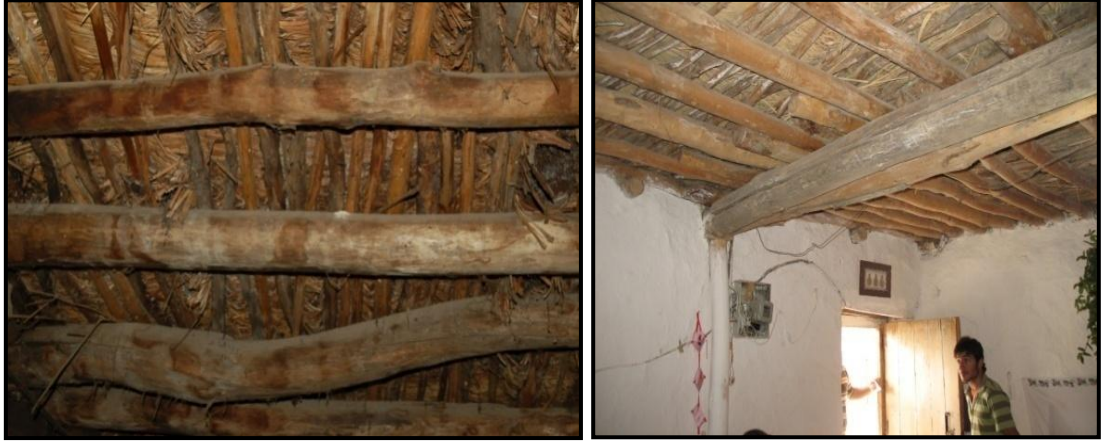
řekil.3.66 Ahřap kiriřleme ve zerine hasır kullanımı (Diyarbakır, 2012)
