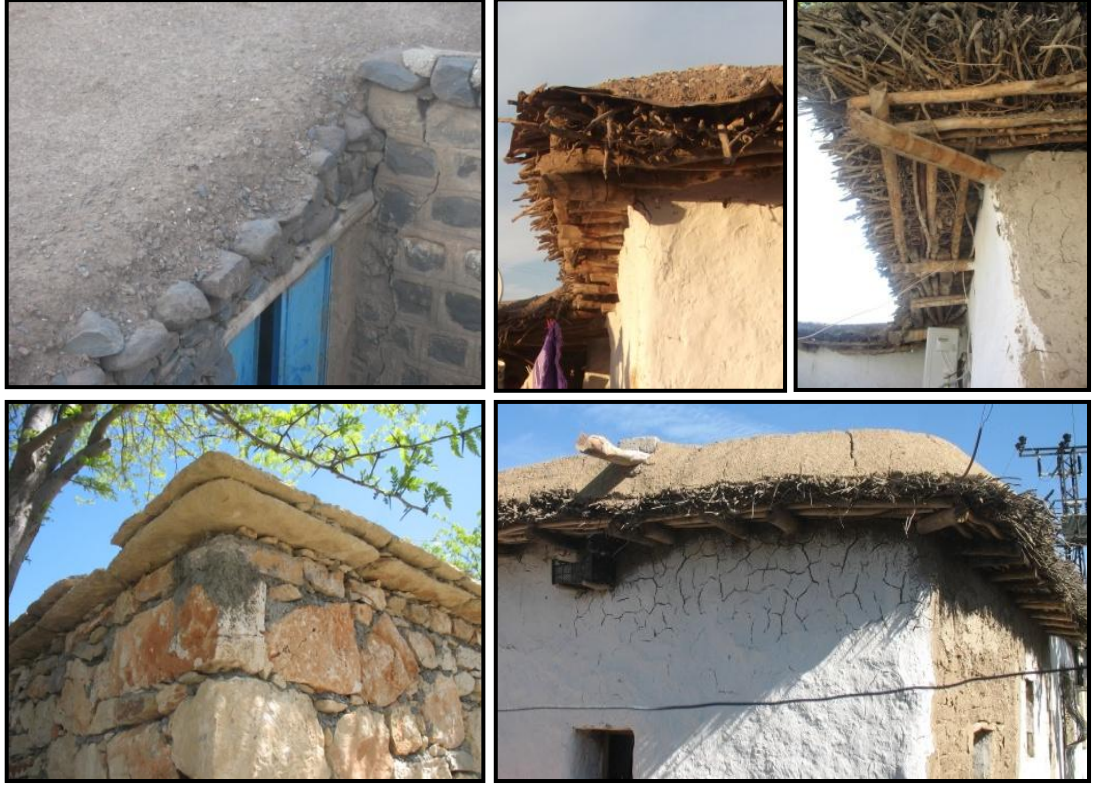
Şekil.3.95 Yörede kullanılan saçak türleri (Diyarbakır, 2012)
