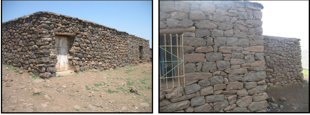
Şekil.3.62 Harç kullanılmadan örülen moloz duvar türleri (Diyarbakır-Merkez, 2012)
