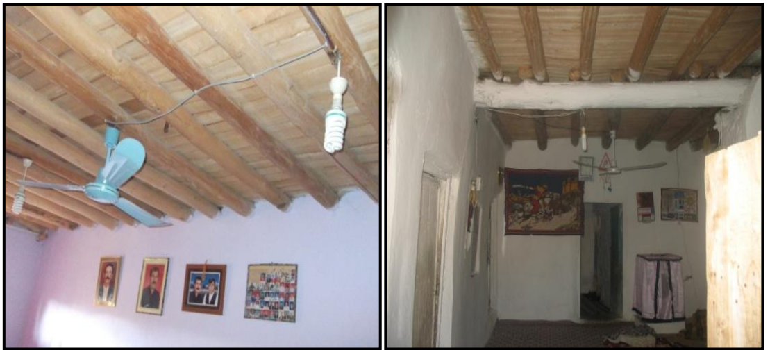
řekil.3.67 Ahřap kiriřleme ve zerine kaplama tahtası kullanımı (Diyarbakır, 2012)
