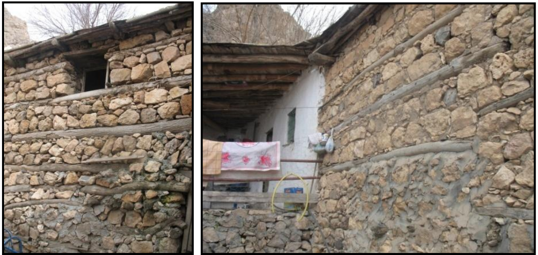
Şekil.3.47 Duvarlarda ahşap hatıl kullanım örnekleri (Diyarbakır-Silvan, 2012)
