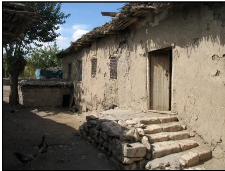
Şekil.3.42 Kerpiç yapılarda toprak sıva kullanımı (Diyarbakır-Silvan, 2012)
