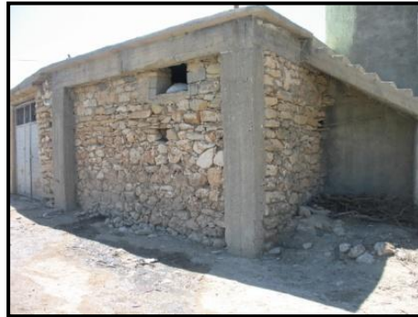
Şekil.3.118 İskelet sistem kullanım türü (Diyarbakır, 2012)
