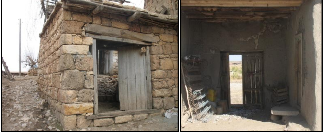
Şekil.3.88 Avlu kapı türleri (Diyarbakır, 2012)
