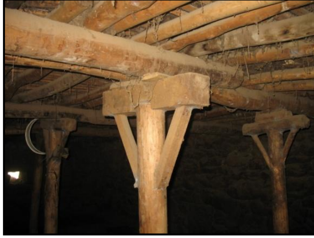
Şekil.3.71 Ahşap kiriş birleşimlerinde kullanılan başlık (Diyarbakır, 2012)
