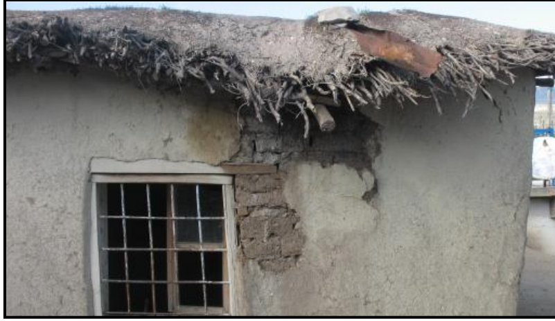
Şekil.3.65 Kerpiç bloklarla örülen duvar (Diyarbakır-Silvan, 2012)
