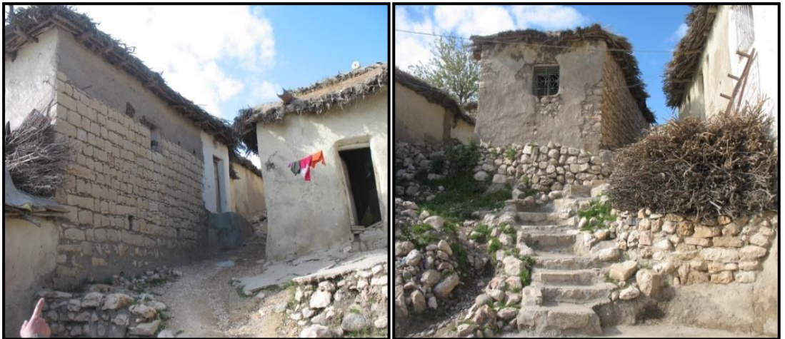
Şekil.3.32 Eğimli topoğrafik alanda yapılaşma düzeni Susuz köyü (Diyarbakır-Silvan, 2012)
