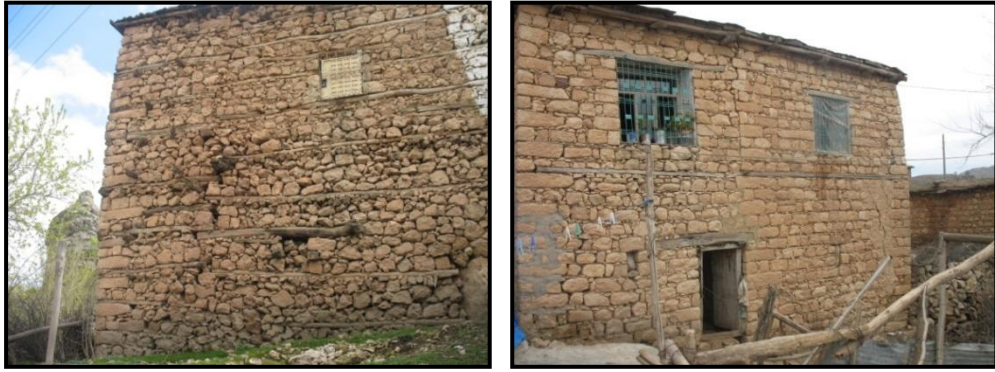
Şekil.3.39 Duvar örgüsünde ahşap hatıl kullanım örnekleri (Diyarbakır-Silvan, 2012)
