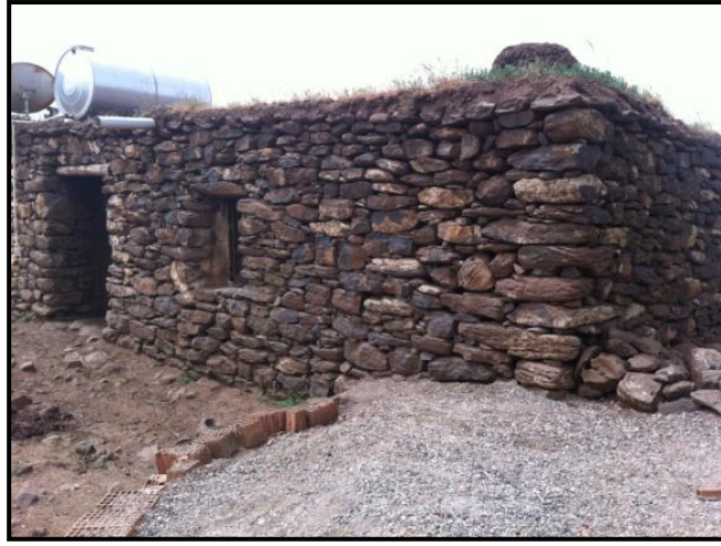
Şekil.3.38 Taş duvar örgüsü - kuru örgü (Diyarbakır, 2012)
