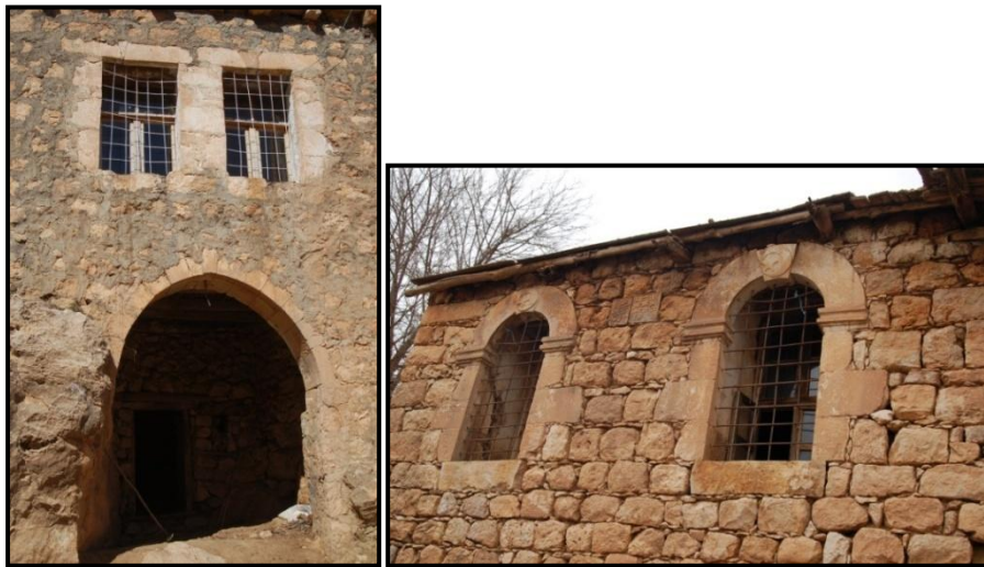
Şekil.3.40 Kapı ve pencerede kemer kullanım örneği (Diyarbakır-Silvan, 2012)
