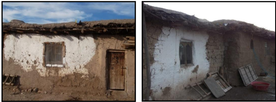
Şekil.3.46 Üst örtü türü - toprak dam (Diyarbakır-Silvan, 2012)
