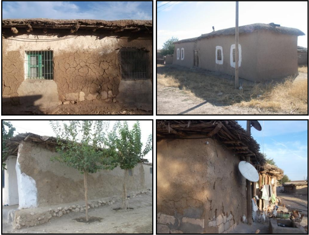
Şekil.3.119 Kerpiç yığma sistem (Diyarbakır, 2012)
