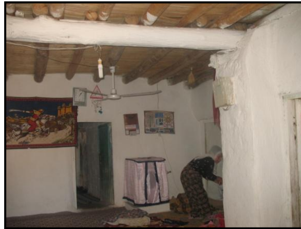
Şekil.3.49 Konut birimlerinde ahşap kirişleme yapım türü (Diyarbakır-Silvan, 2012)
