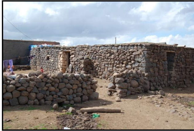
Şekil.3.17 Taş kullanım çeşitliliği, Hacıkoç köyü (Diyarbakır, 2012)
