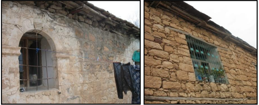
Şekil.3.81 Pencere konumu duvarın iç tarafında (Diyarbakır, 2012)
