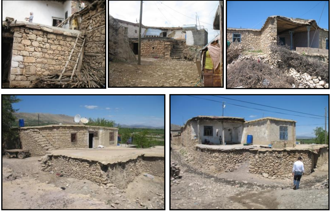
Şekil.3.87 Ahır mekânlarının üstünün teras olarak kullanım örnekleri (Diyarbakır - Silvan, 2012)
