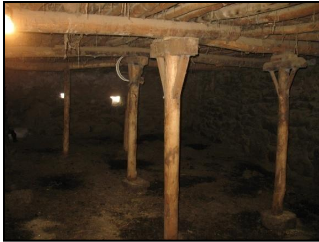
Şekil.3.72 Ahşap kiriş birleşimlerinde kullanılan düşey taşıyıcı (Diyarbakır, 2012)
