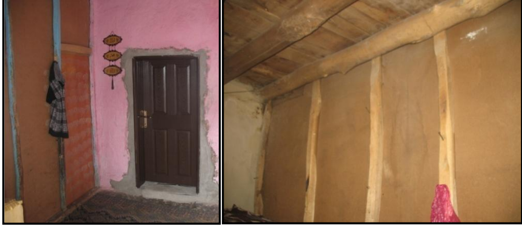
Şekil.3.52 Bölücü duvar olarak ahşabın kullanım türü (Diyarbakır-Silvan, 2012)
