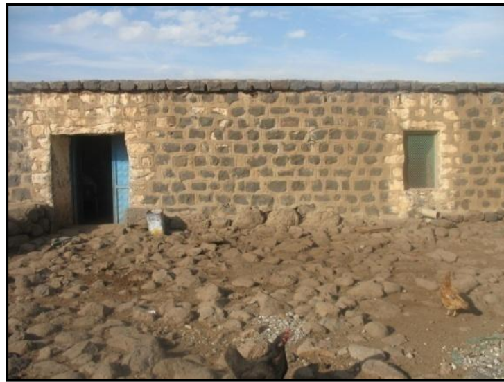
Şekil.3.53 Zemin üzerine inşa edilen yapı (Diyarbakır - Merkez, 2012)
