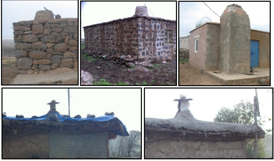
Şekil.3.102 Ocak bacaları kullanım türleri (Diyarbakır, 2012)
