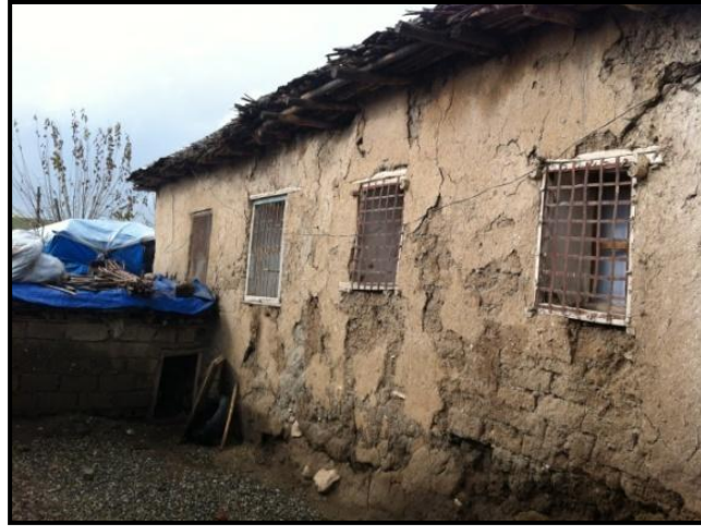
Şekil.3.44 Pencerede ahşap hatıl kullanımı (Diyarbakır-Silvan, 2012)
