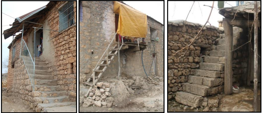
Şekil.3.97. Evlerin üst kat girişlerinde kullanılan merdiven türleri (Diyarbakır - Silvan, 2012)
