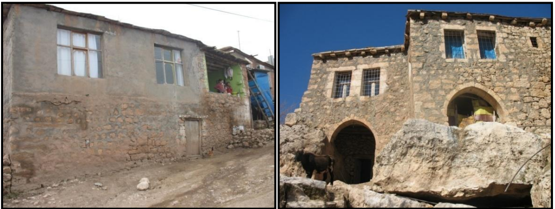
Şekil.3.23 Zemin katta ahır girişi, Boyunlu köyü (Diyarbakır-Silvan, 2012)
