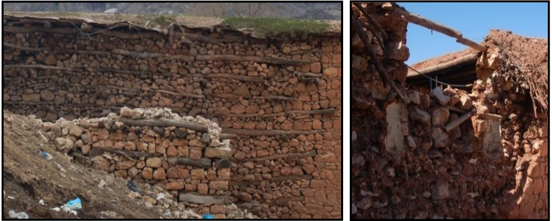
Şekil.3.64 Duvar örgüsünde ahşap hatıl kullanımı (Diyarbakır-Silvan, 2012)
