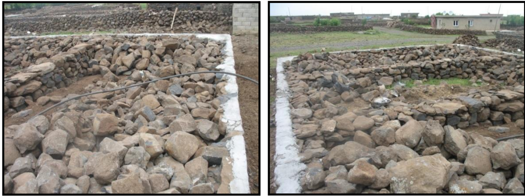
Şekil.3.55.Doğal zemin üzerine temel inşası (Diyarbakır - Merkez, 2012)
