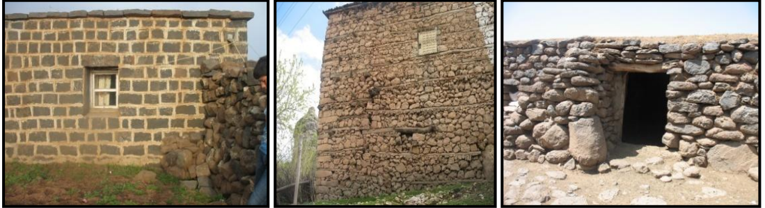
Şekil.3.117 Taş yığma sistem (Diyarbakır, 2012)
