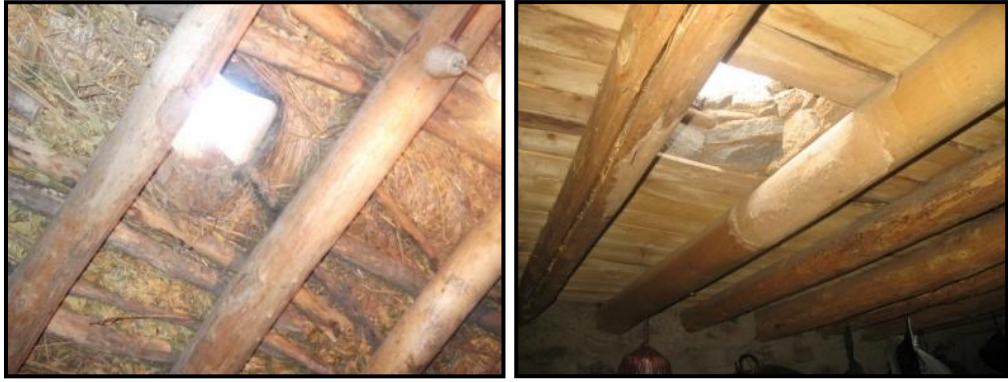
Şekil.3.84 Üst döşemeden havalandırma sağlayan boşluklar (Diyarbakır, 2012)
