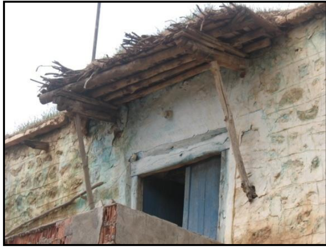
Şekil.3.51 Saçak elemanı olarak ahşabın kullanım türü (Diyarbakır-Silvan, 2012)
