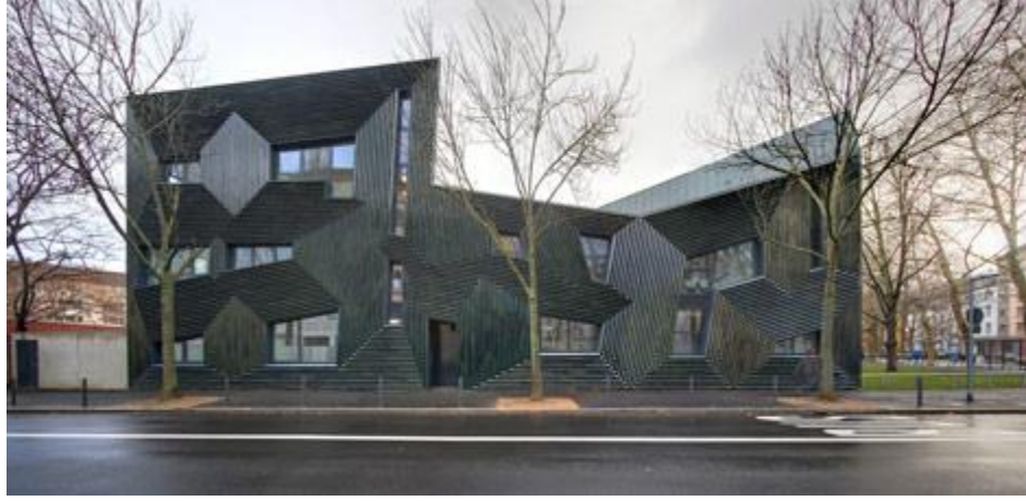
Resim 51. Sinagogun cephe görüntüsü
