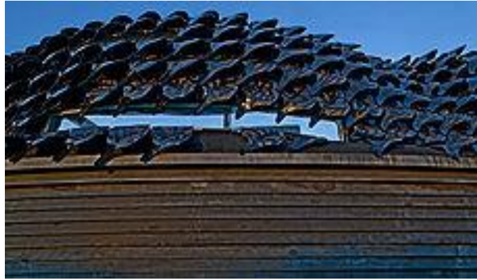
Resim 36. Konutun Corian kaplı cephe görünüşü ve seramik kaplamasının farklı bir açıdan görünüşü
