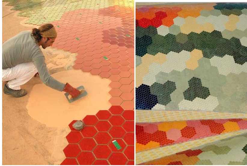
Resim 50. Çarşı çatısına yapılan seramik uygulaması
