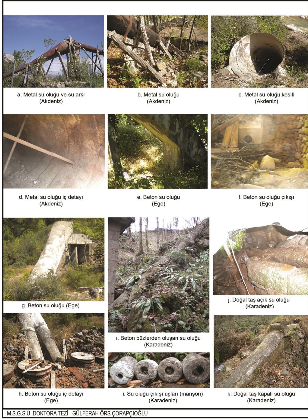
Şekil 3.22 Düşey Milli Yatay Çarklı Değirmen Sistemlerinde Su Oluğu Örnekleri. (Çorapçioğlu,2012).
