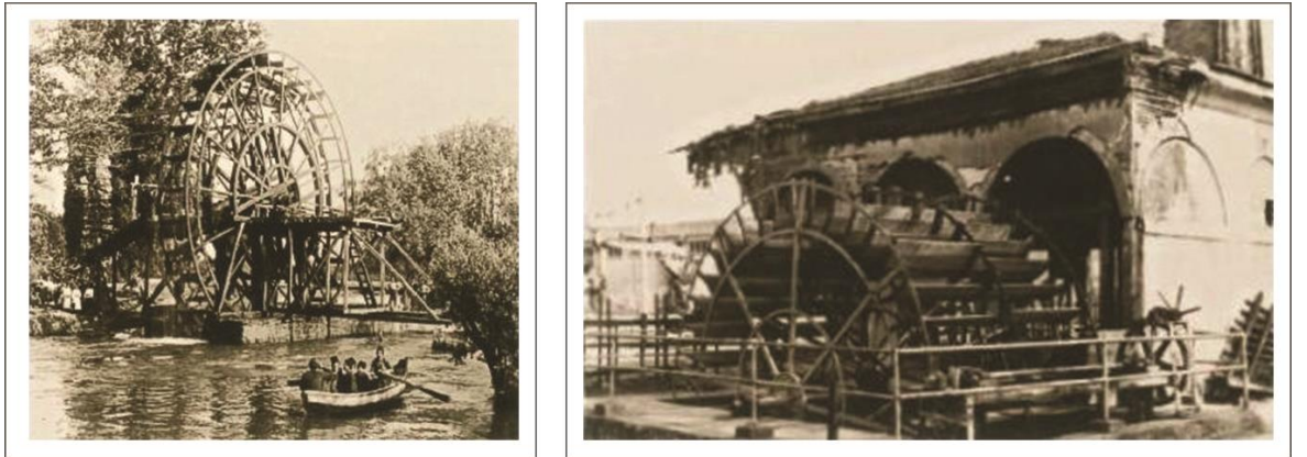
Şekil 2.27 Adapazarı Çark deresi, a)1892 yılına ait noria çarkı. b) 1912 yılına ait yatay çark sistemi (Bir ve diğ.2012,39,40).
