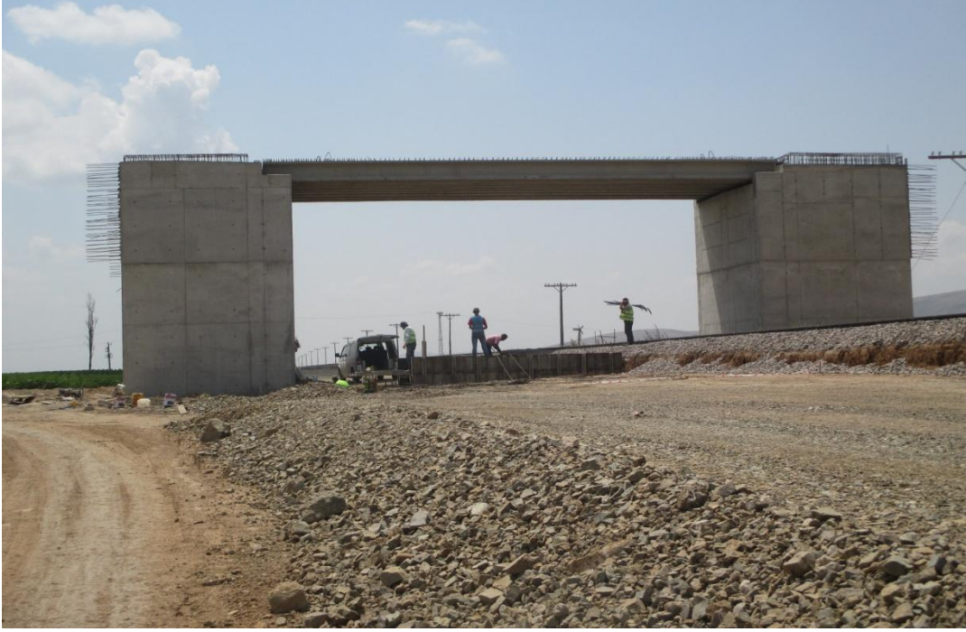
Şekil 3.25. Konya-Karaman hızlı tren hattı inşaat çalışmaları- km 69+368
