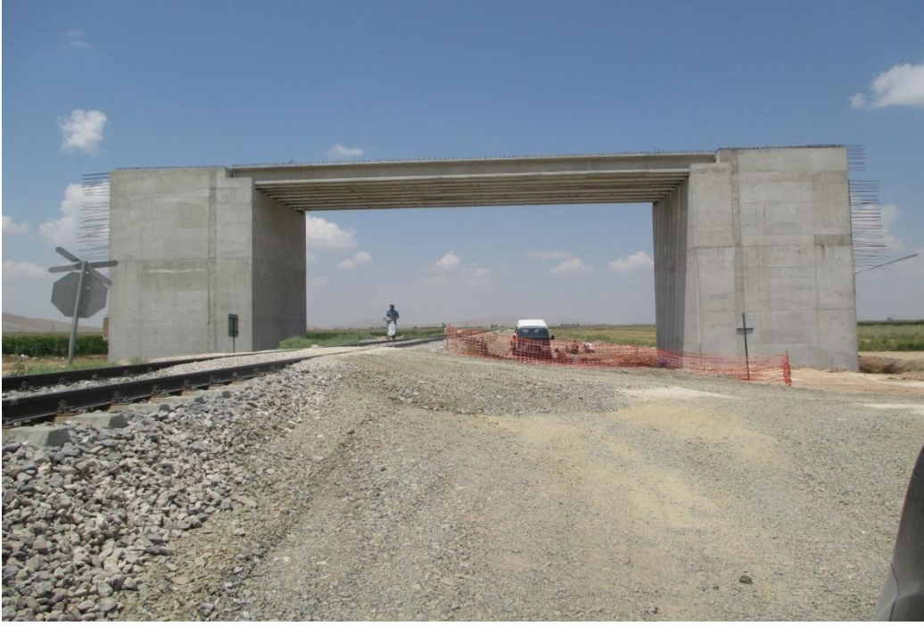
Şekil 3.27. Konya-Karaman hızlı tren hattı inşaat çalışmaları- km 87+317
