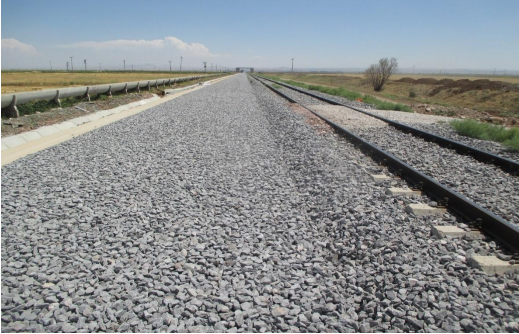
Şekil 3.28. Konya-Karaman hızlı tren hattı inşaat çalışmaları- km 92+000
