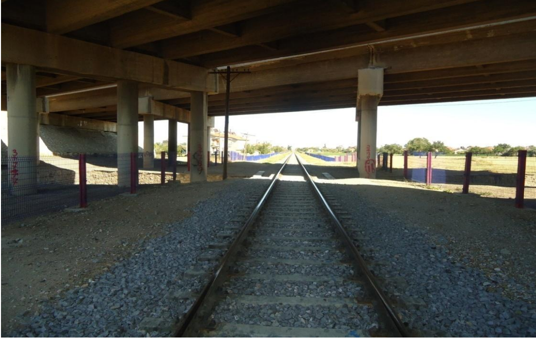
Şekil 4.31. Yıkılacak ve tekrar yapılacak olan çevre yolu köprüsü ayakları
