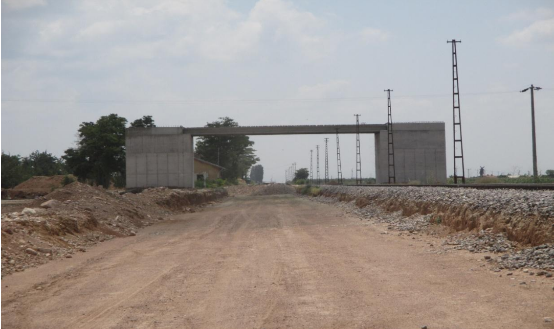
Şekil 3.26. Konya-Karaman hızlı tren hattı inşaat çalışmaları- km 79+240
