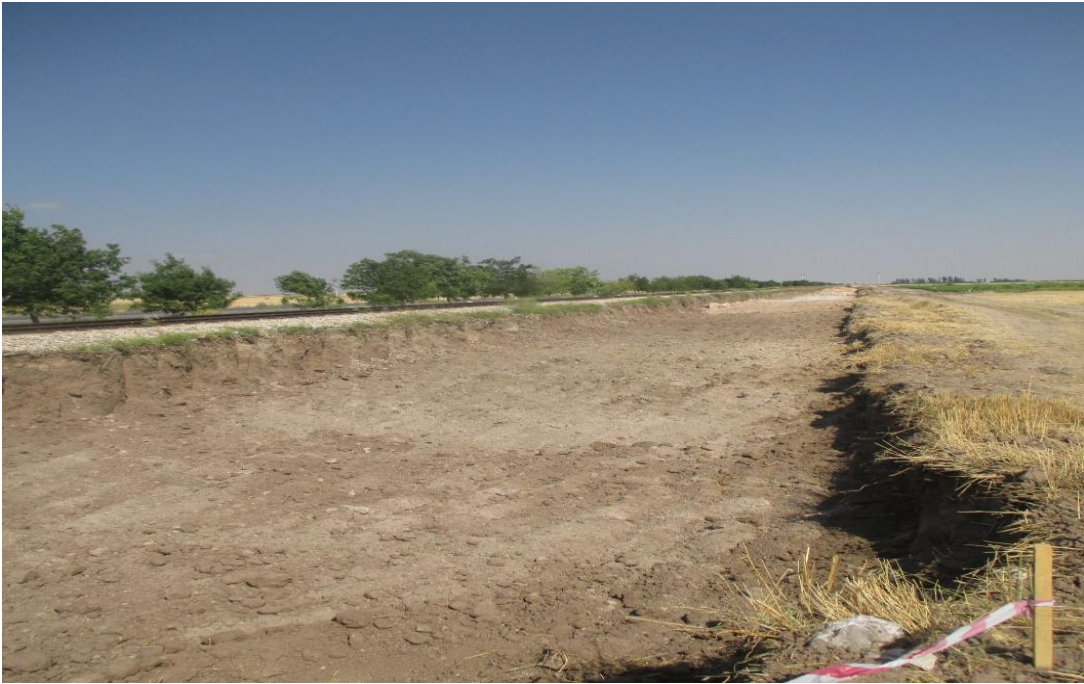
Şekil 3.22. Konya-Karaman hızlı tren hattı inşaat çalışmaları- km 34+000
