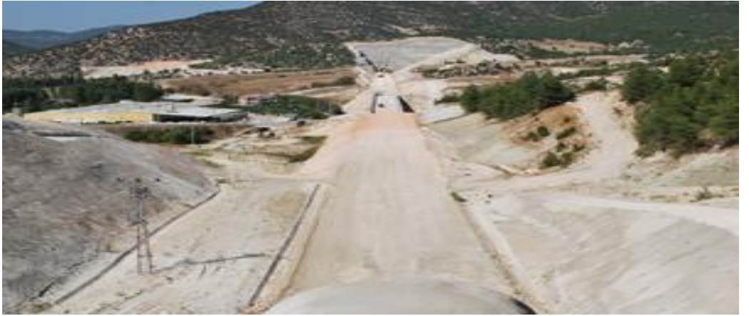
Şekil 2.10. Ankara-İstanbul yüksek hızlı tren hattı inşaat çalışmaları-2
