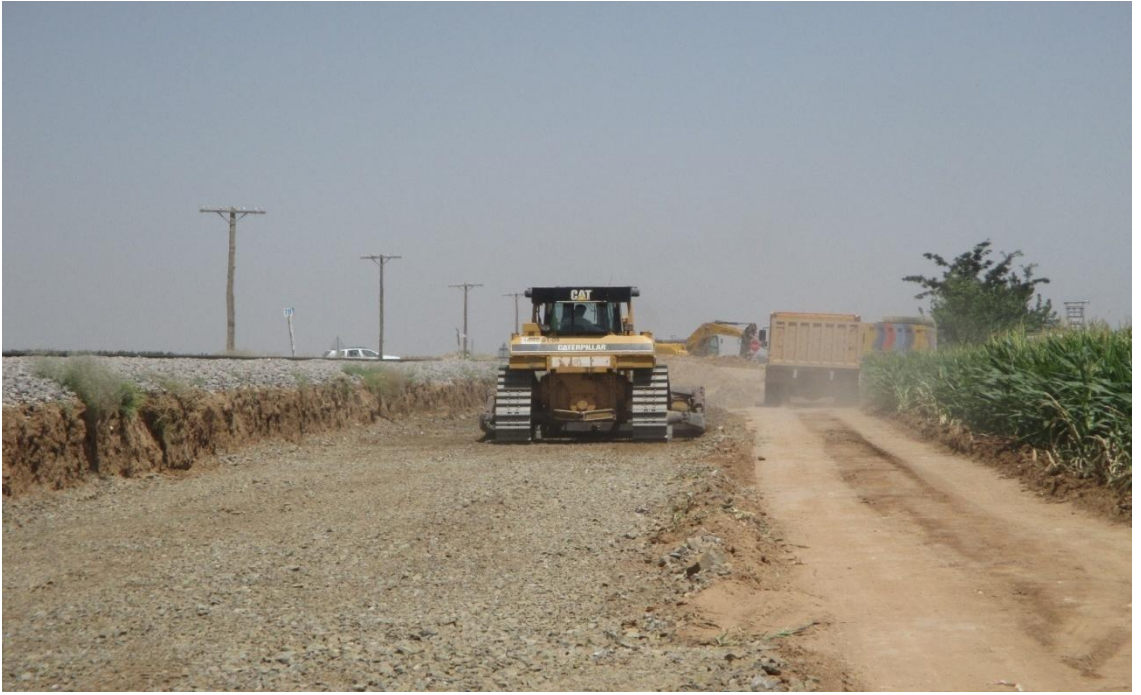
Şekil 3.24. Konya-Karaman hızlı tren hattı inşaat çalışmaları- km 69+300
