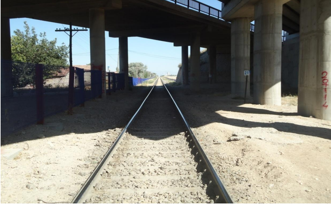
Şekil 3.33. Km 20+110 üst geçit köprüsü ayakları
