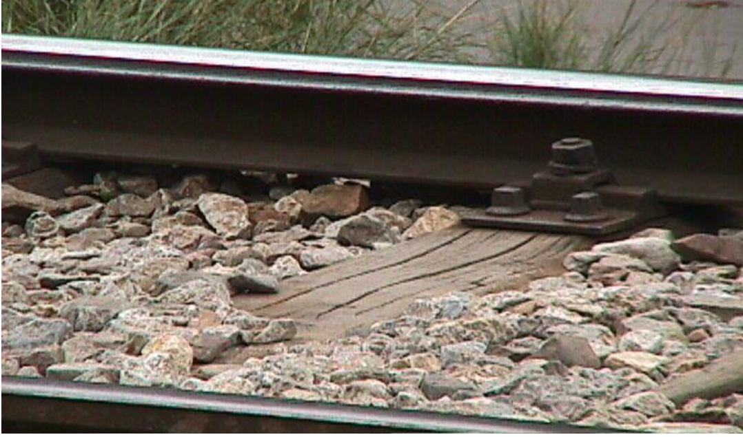
Şekil 3.16. K tipi travers ray bağlantısı
