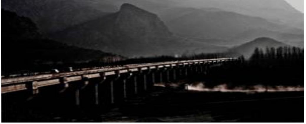
Şekil 2.12. Ankara-İstanbul yüksek hızlı tren hattı inşaat çalışmaları-4
