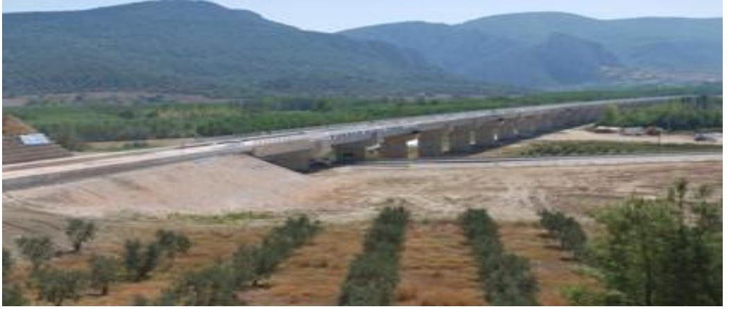
Şekil 2.9. Ankara-İstanbul yüksek hızlı tren hattı inşaat çalışmaları-1
