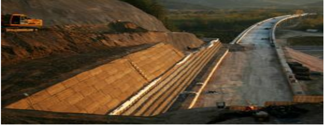
Şekil 2.14. Ankara-İstanbul yüksek hızlı tren hattı inşaat çalışmaları-6
