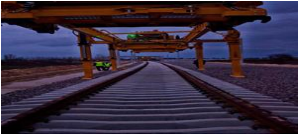
Şekil 2.13. Ankara-İstanbul yüksek hızlı tren hattı inşaat çalışmaları-5
