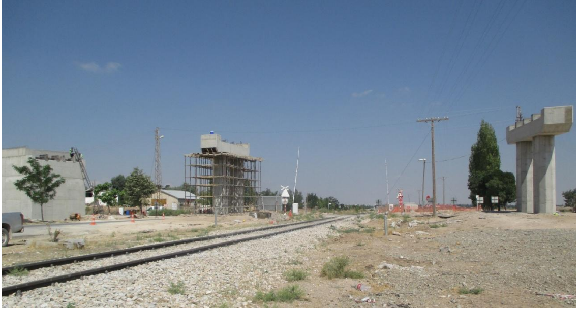
Şekil 3.23. Konya-Karaman hızlı tren hattı inşaat çalışmaları- km 47+795
