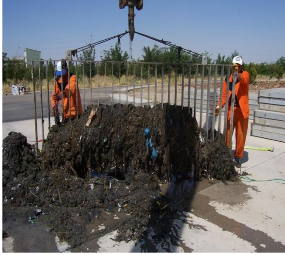
Şekil 4.6. İnce ızgarada yumaklaşma sorunu
