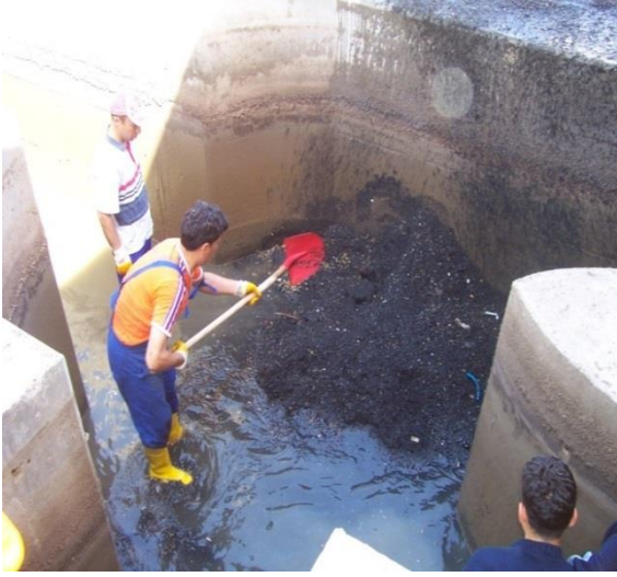
Şekil 4.5. Izgara kanallarında kum çakıl birikmesi
