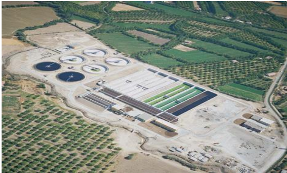
Şekil 4.10. Malatya atıksu arıtma tesisi
