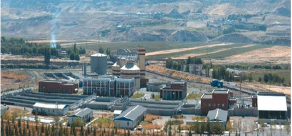
Şekil 4.1. Diyarbakır Atıksu Arıtma Tesisi
