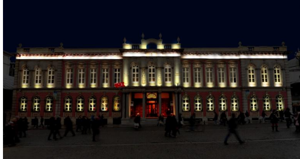
Şekil 7.97 Mevcut aydınlatma tasarımı
