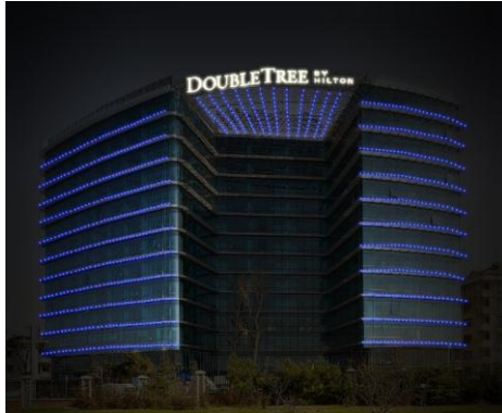
Şekil 7.27 Mevcut aydınlatma tasarımı
