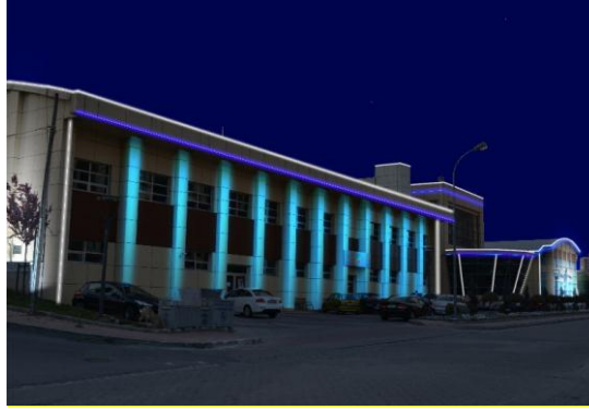
Şekil 7.41 Mevcut aydınlatma tasarımı
