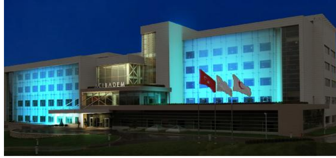
Şekil 7.67 Mevcut aydınlatma tasarımı
