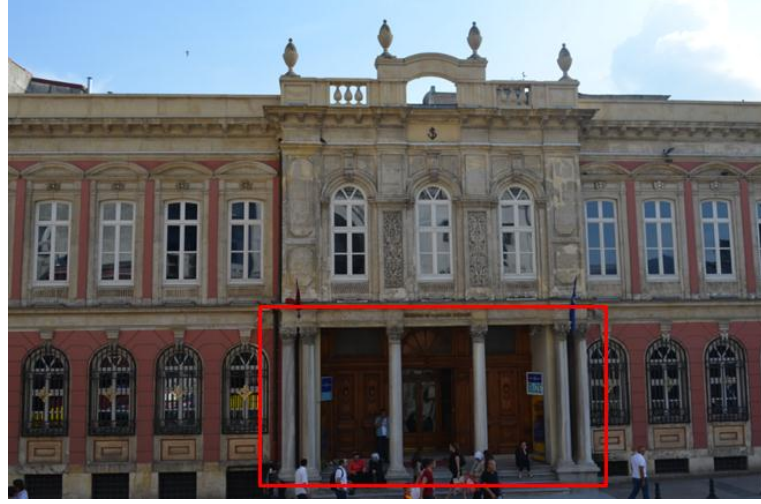
Şekil 6.59 Yapı yüzündeki kolonlu giriş bölümü
