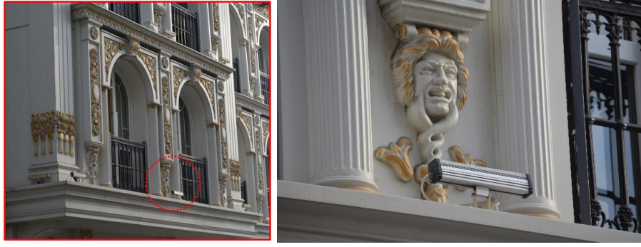
Şekil 6.8 Albatros Hotel üst kat kolon aydınlatmasında aygıt konumu
