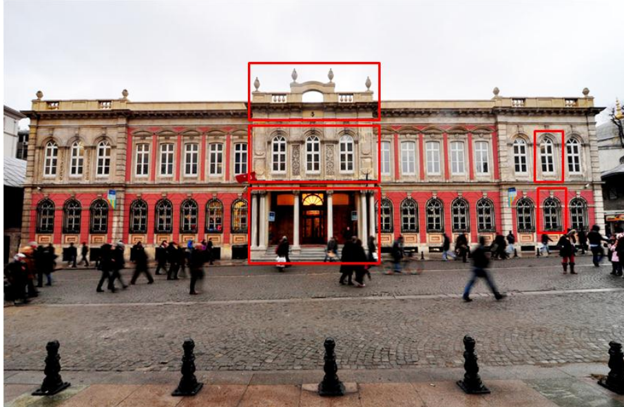
Şekil 6.55 Yapının incelenen çeşitli bölümleri
