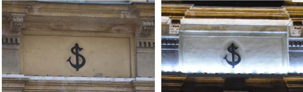
Şekil 6.67 Çatı silmesinde kullanılan aydınlatma aygıtlarının konumu
