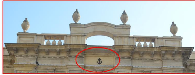
Şekil 6.65 Çatı silmesi ve taç kısmı yakın görünümü
