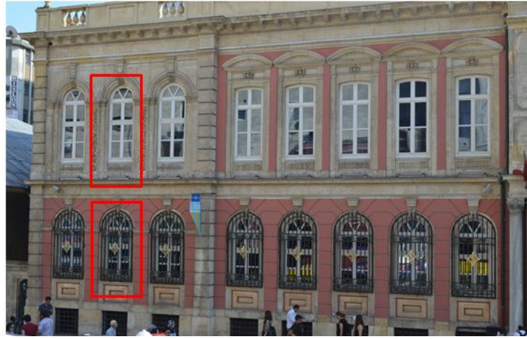
Şekil 6.56 Işıklılık ölçmesi yapılan pencerelerin yapı yüzündeki konumu
