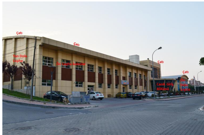
Şekil 6.21 Bahçeşehir Spor Kompleksi'nin çeşitli bölümleri
