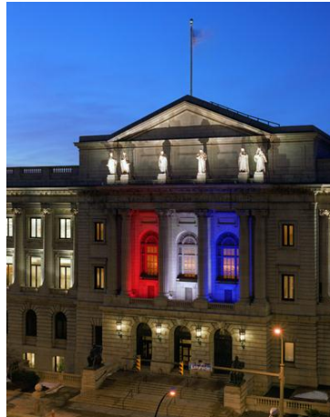
Şekil 5.41 Cuyahoga County Court House'un vurgu aydınlatması detayı [5]
