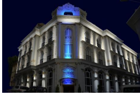
Şekil 7.14 Mevcut aydınlatma tasarımı
