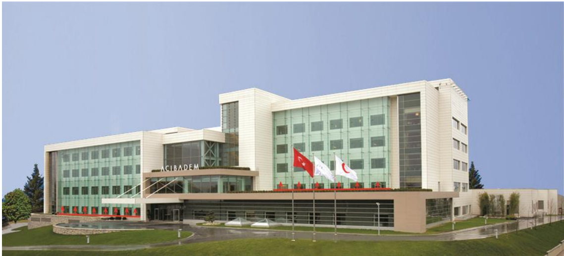
Şekil 6.40 Acıbadem Hastanesi’nin yapı yüzü aydınlatma düzeni
