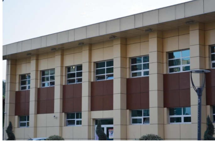
Şekil 6.24 Yapı ön cephesindeki kolonlar
