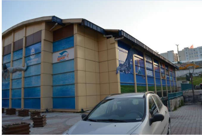
Şekil 6.30 Sağ yan dolu cephe gündüz görünümü
