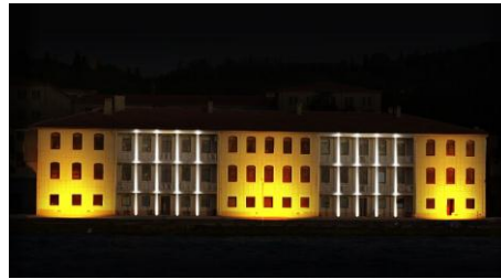
Şekil 7.81 Mevcut aydınlatma tasarımı
