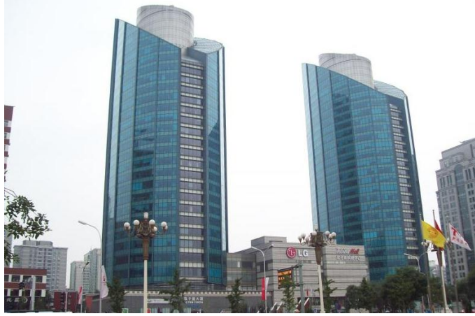
Şekil 5.63 LG Towers'ın gündüz görünümü [36]
