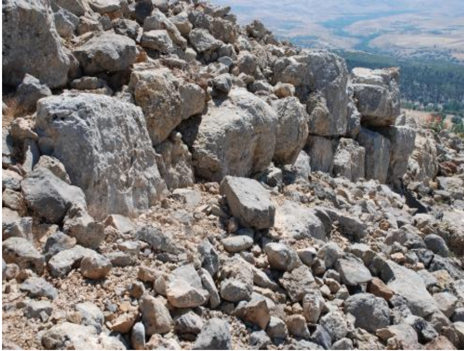
Res.98 Sağır kalesi batı sur yapısı
