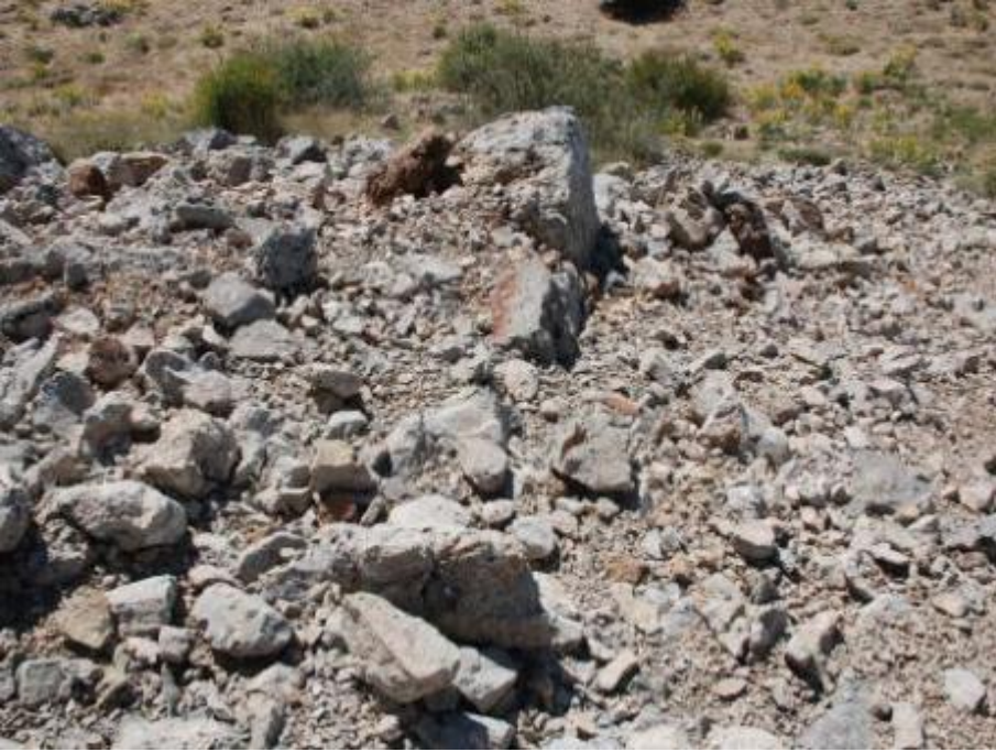
Res.92 Sağır kalesi Batı sur Burç sistemi
