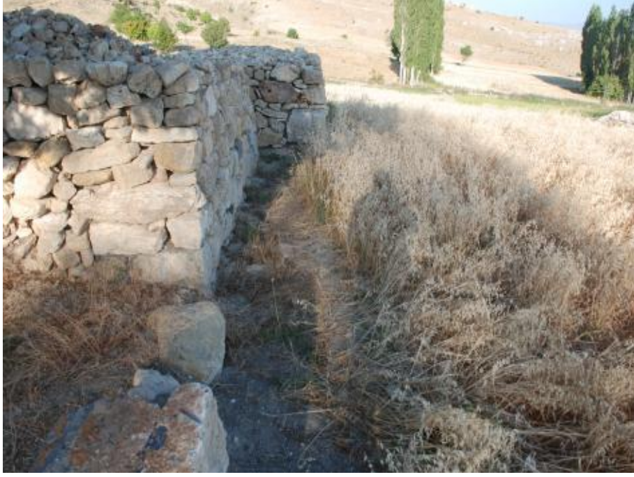
Res.153 Sağır Kilisesi güney duvar temel blokları
