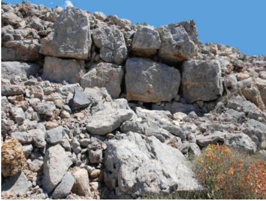
Res.97 Sağır kalesi batı sur yapısı
