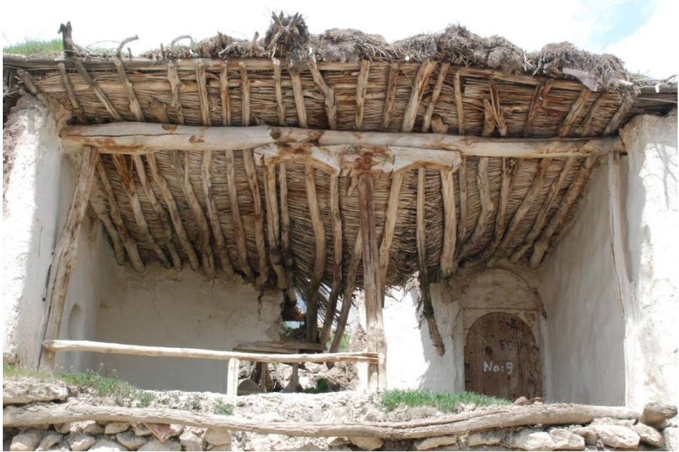
Res.17Sağır köyü evlerinin ahşap dikmeleri ve birleşme noktaları
