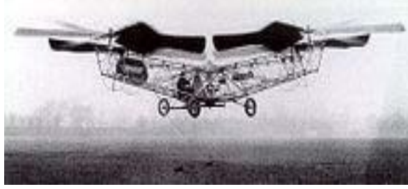
Şekil 2.1. Bilinen ilk quadrotor (Taylor, 1977)
