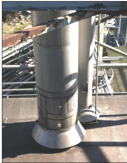
Şekil 3.11 : 17 saatlik karakterizasyon için örnekleme yapılan fermantasyon prosesi bacası.
