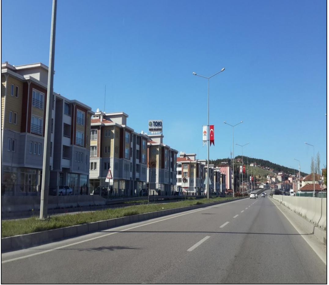
Şekil 28: Şehirlerarası karayolu kenarına (E-80) inşa edilen TOKİ konutlarının görünümü.
