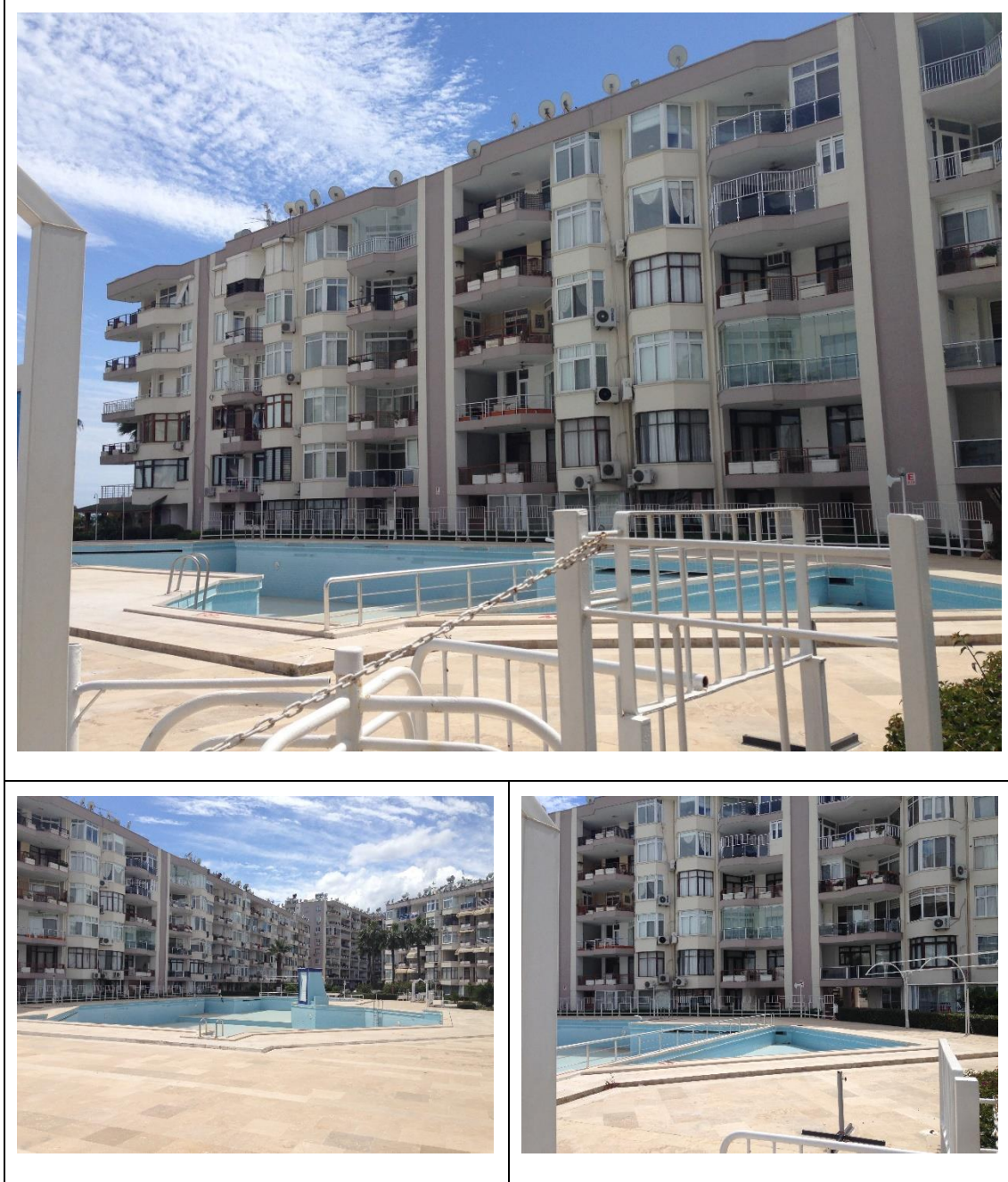
Şekil 4.29. Babil Sitesinde Bulunan Havuzlar
