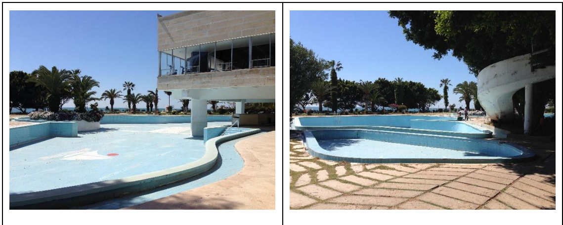
Şekil 4.3. Soli 1'de Bulunan Havuzlar
