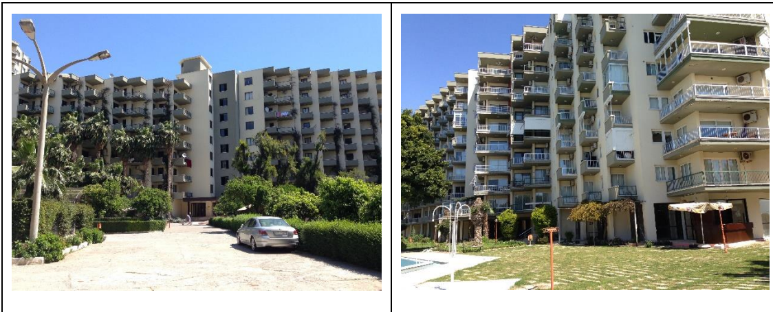
Şekil 4.13. Soli 3'te Bulunan 7 ve 8 Katlı Yapılar
