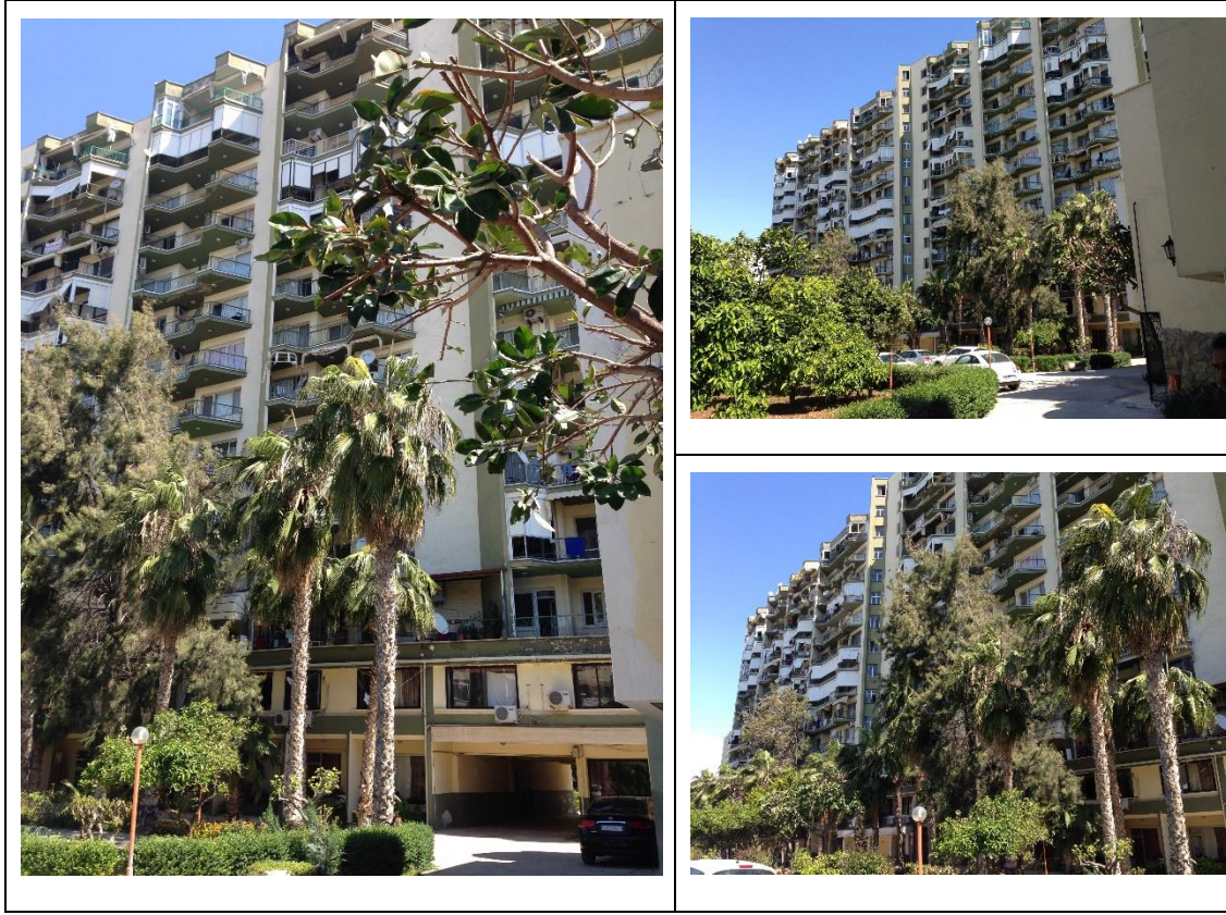
Şekil 4.9. Soli 2’de Bulunan 12 Katlı Yapı
