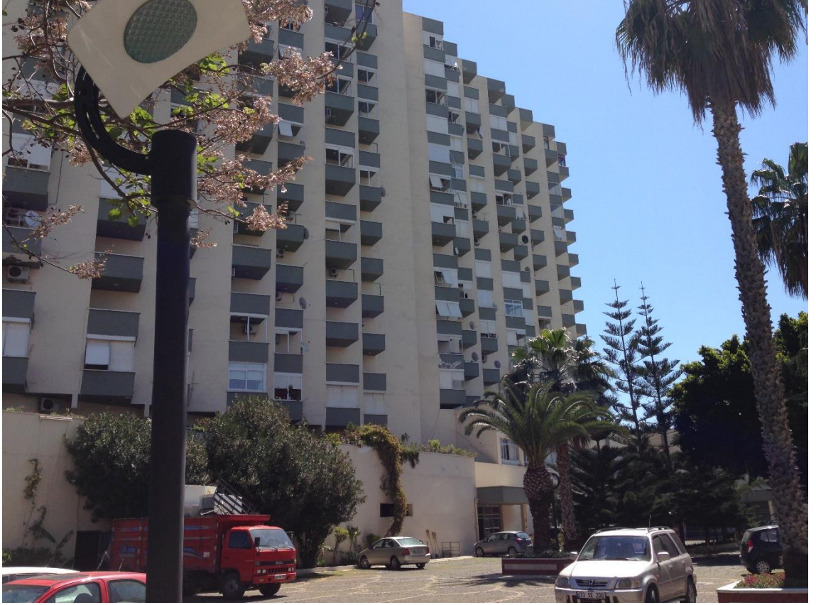
Şekil 4.5. Soli 1’de Bulunan 13 Katlı Yapı
