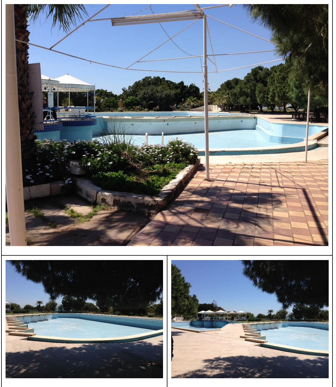
Şekil 4.8. Soli 2’de Bulunan Havuzlar
