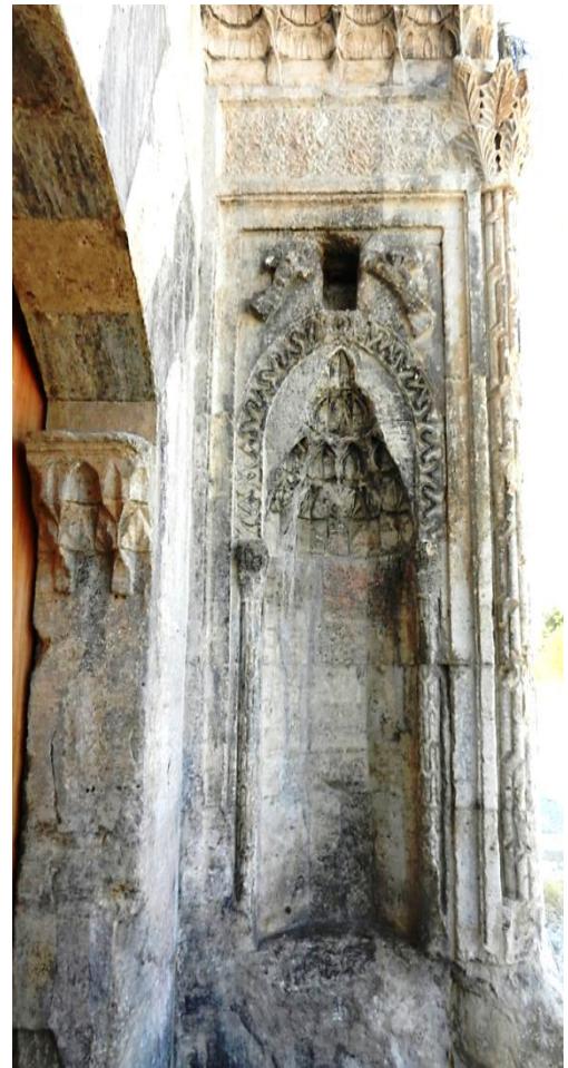
Fotoğraf. 37: Susuz Han, taç kapı, güney yan niş (Shim, 2013)
