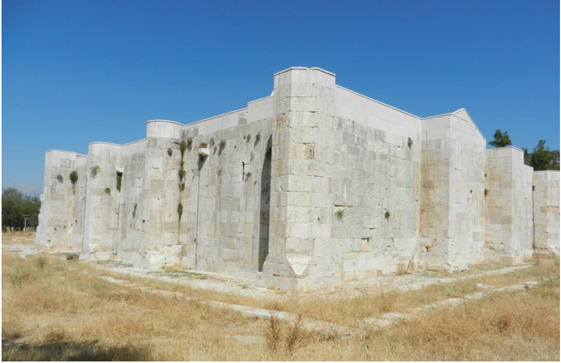
Fotoğraf. 20: Susuz Han, güney ve doğu cephe (Shim, 2013)
