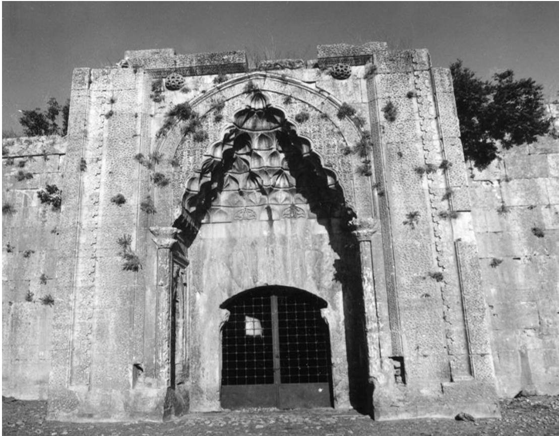
Fotoğraf. 3: Susuz Han, ön cephe / batı cephe (Eba, 1907)
