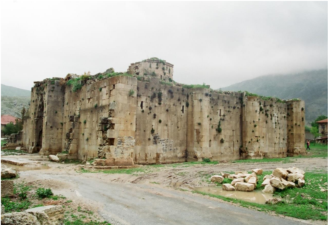
Fotoğraf.8: Susuz Han, onarımdan öncesi batı cephe ve güney cepheler (Vakıflar Genel Müdürlüğü Sanat Eserleri ve Yapı İşleri Dairesi Başkanlığı Arşivi, 1991)
