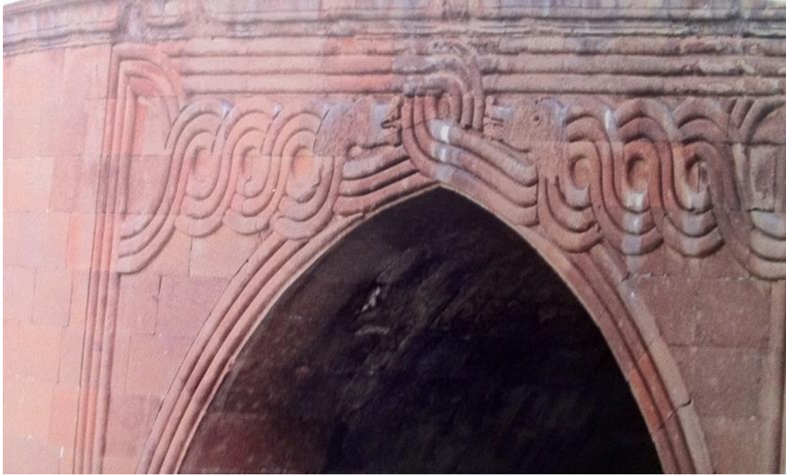
Fotoğraf. 58: Karatay Han, giriş eyvanının avluya bakan cephesindeki ejderin genel görünümü (Denktaş, 2007)
