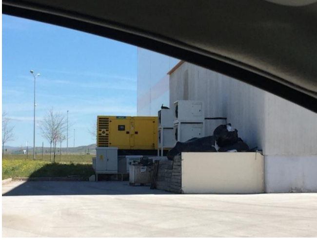
Resim 5.7. Ankara Lojistik Üssü'ndeki soğuk hava deposu (06.05.2015 tarihinde çekilmiştir.)
