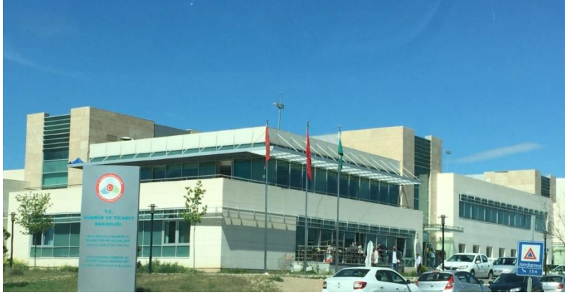
Resim 5.1. Ankara Lojistik Üssü T.C. Gümrük ve Ticaret Bakanlığı Orta Anadolu Gümrük ve Ticaret Bölge Müdürlüğü (06.05.2015 tarihinde çekilmiştir.)
