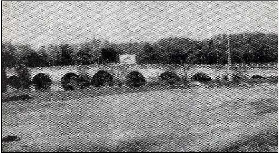
RES M 33: EHÂBEDDÎN PAŞA – SARAÇHANE KÖPRÜSÜNDEN BİR GÖRÜNÜM (1972) 132
