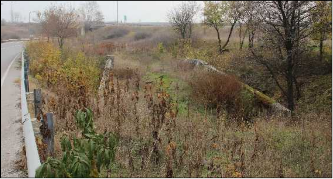
RES M 97: KAZAN KÖPRÜSÜNDEN BİR GÖRÜNÜM 215
