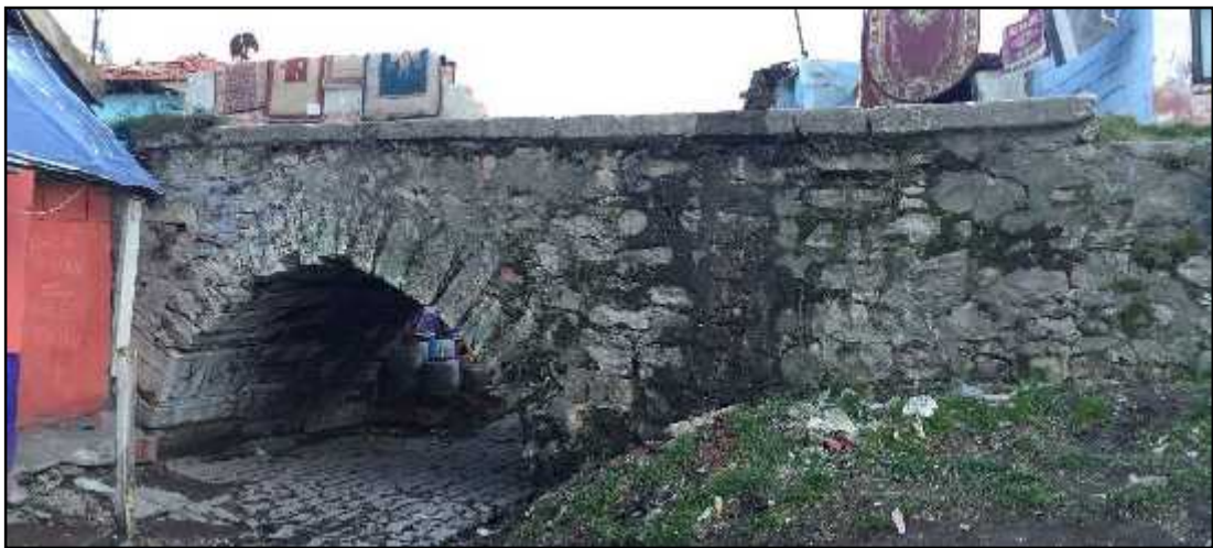
RES M 93: TA KÖPRÜDEN BİR GÖRÜNÜM (2014) 210
