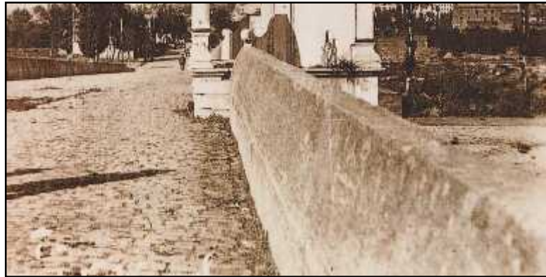
RES M 10: SULTAN MECDİ – MERÇİ KÖPRÜSÜ KORKULUKLARI (1930) 98
