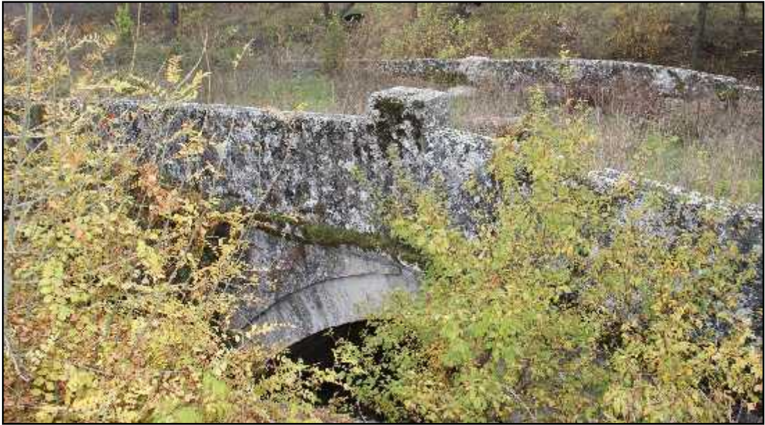
RES M 98: KAZAN KÖPRÜSÜNDEN BİR GÖRÜNÜM 216
