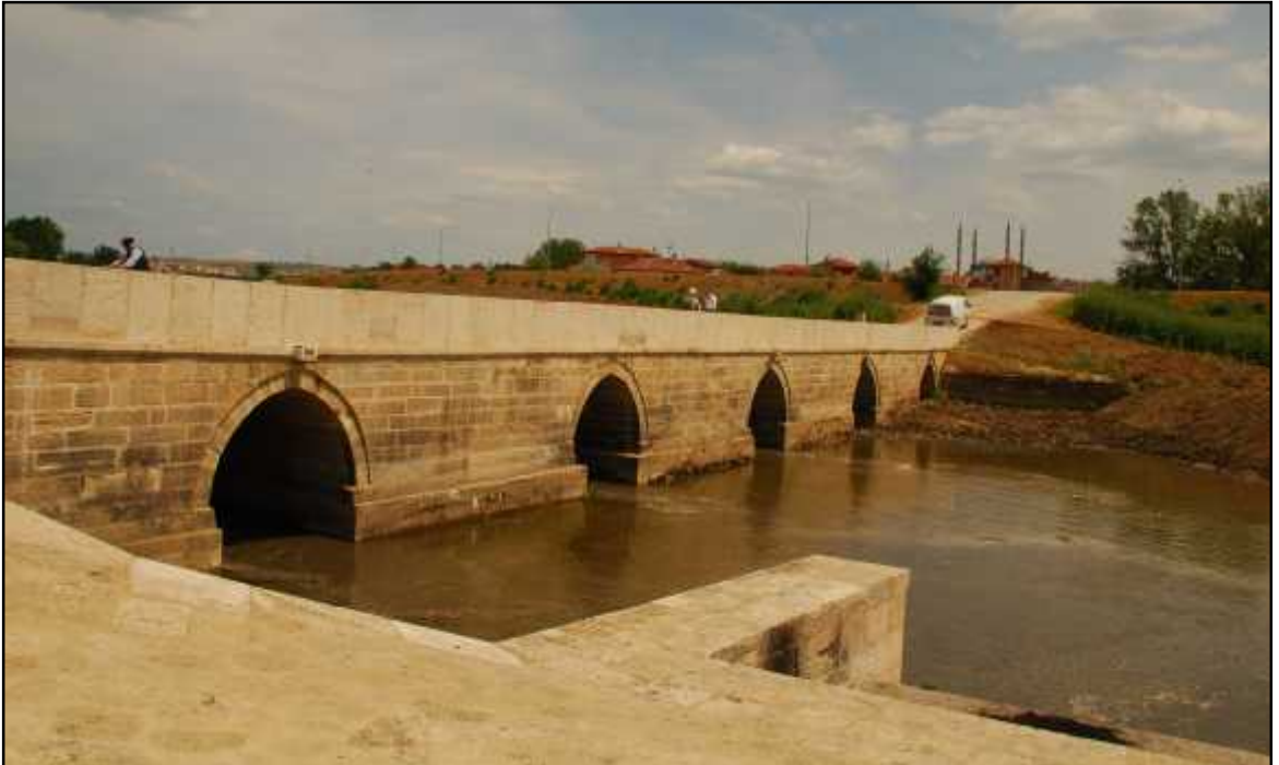
RES M 60: YALNIZGÖZ – TEKGÖZ KÖPRÜSÜNDEN BİR GÖRÜNÜM (2011) 166
