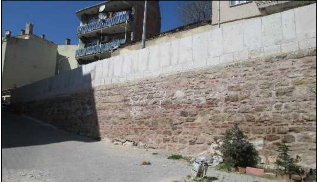
RES M 103: KANATLI KÖPRÜDEN BİR GÖRÜNÜM 222
