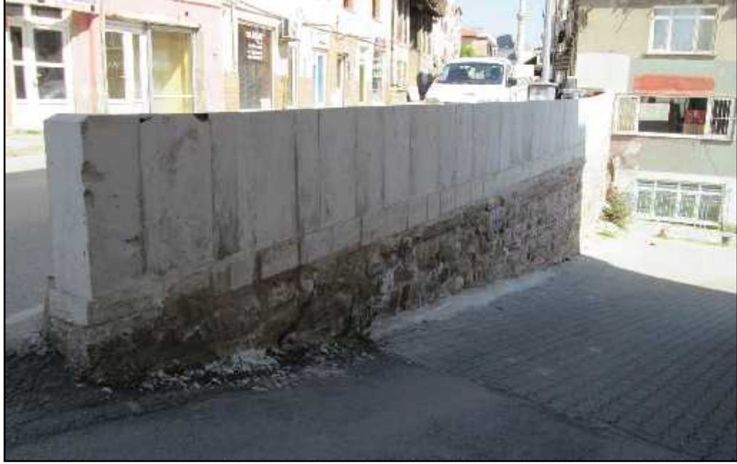
RES M 102: KANATLI KÖPRÜDEN BİR GÖRÜNÜM 221
