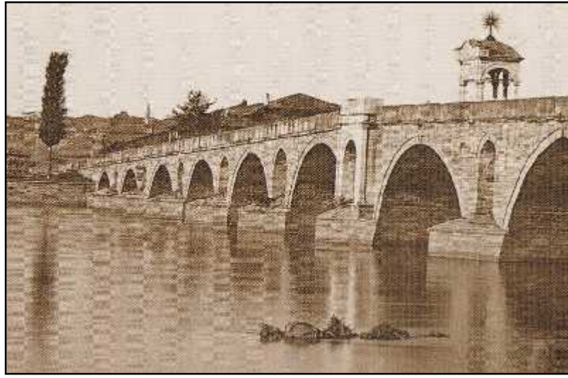
RESİM 6: SULTAN MECDİ – MERÇİ KÖPRÜSÜ ÜZERİNDEKİ BALKON (1890) 91
