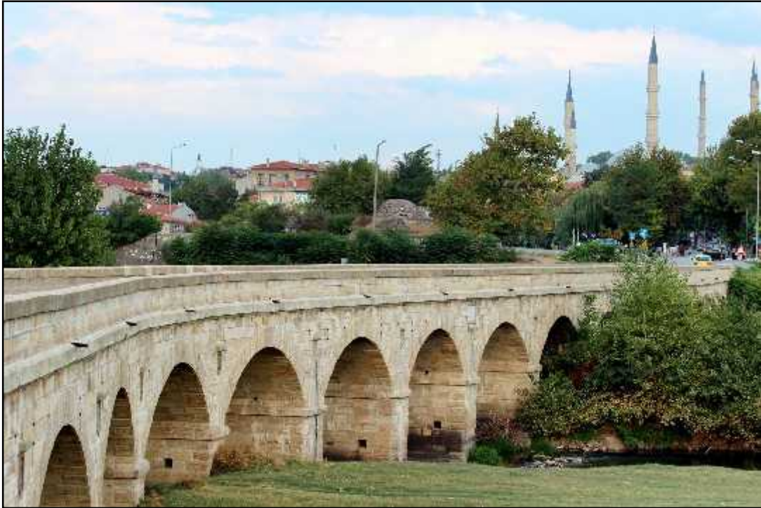
RES M 17: GAZ M HAL – HAM D YE KÖPRÜSÜNÜN GÜNÜMÜZDEK DURUMU (2012) 109
