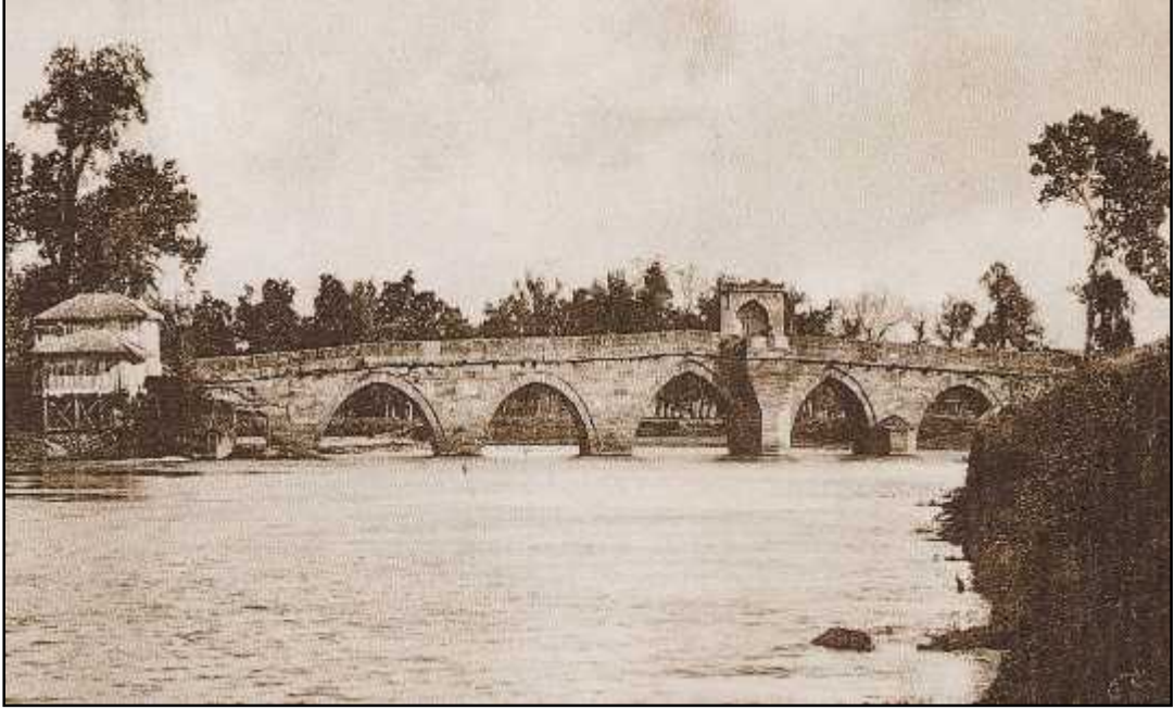
RES M 28: EHÂBEDDÎN PAŞA – SARAÇHANE KÖPRÜSÜNDEN BİR GÖRÜNÜM 127
