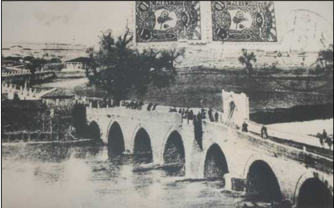
RES M 29: EHÂBEDDÎN PAŞA – SARAÇHANE KÖPRÜSÜNDEN BİR GÖRÜNÜM (1907) 128
