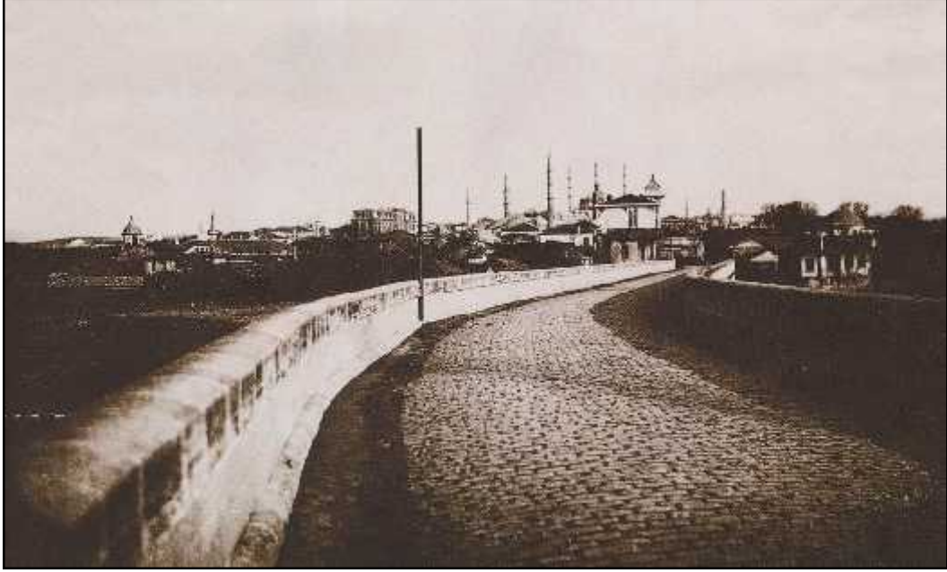
RES M 16: GAZ M HAL – HAM D YE KÖPRÜSÜ (1920) 108
