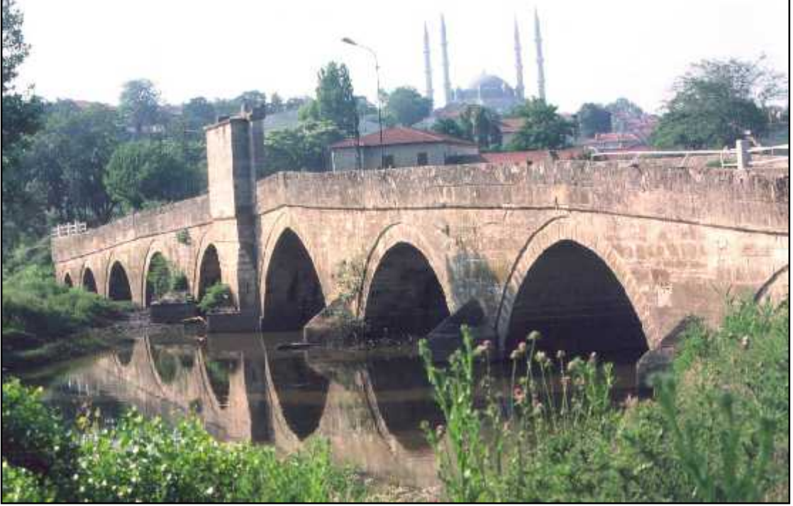
RES M 32: EHÂBEDDÎN PAŞA – SARAÇHANE KÖPRÜSÜNDEN BİR GÖRÜNÜM (2000) 131
