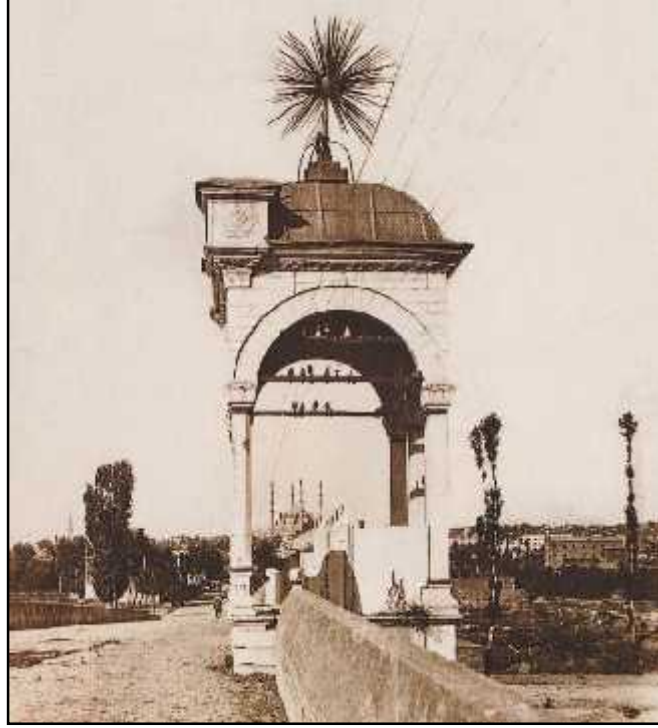
RES M 4: SULTAN MECİD – MERİÇ KÖPRÜSÜ TARİHİ KÖŞKÜ (1930) 88
