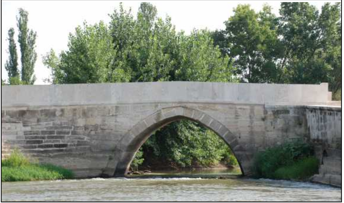
RES M 59: YALNIZGÖZ – TEKGÖZ KÖPRÜSÜNDEN BİR GÖRÜNÜM (2009) 165
