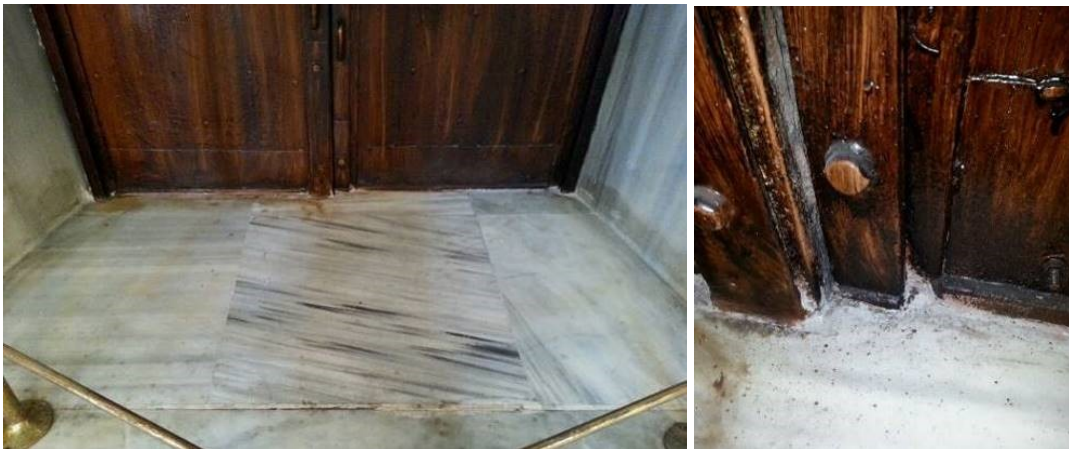
Şekil 4.256 : Kilisenin kuzeybatısında mermer döşeme kaplaması ile gömülen demir kapı.
