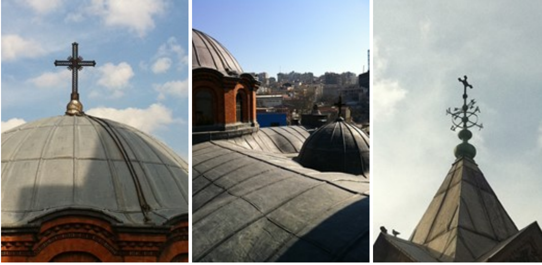
Şekil 4.143 : Kurşun kaplı kubbe, tonoz ve çan kulesi çatısı.
