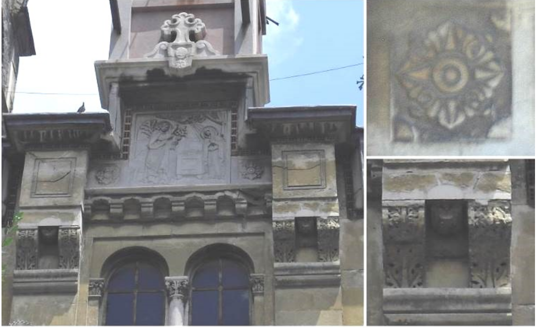
Şekil 4.88 : Üzerinde kabartma çiçek motifleri bulunan kare biçiminde mermer levhalar ve bitkisel motif içeren taş konsollar.
