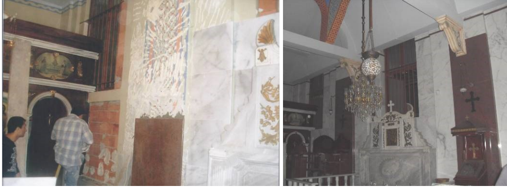
Şekil 4.221 : Ayazma iç mekânında duvarların Marmara mermeri ve granit kaplanması sırasında (2007) ve sonrasında çekilen fotoğraflar (2014).
