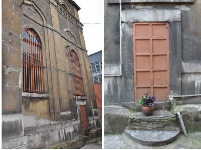
Şekil 4.104 : Güneydoğu Cephesi, doğu yönünde yer alan giriş kapısı.
