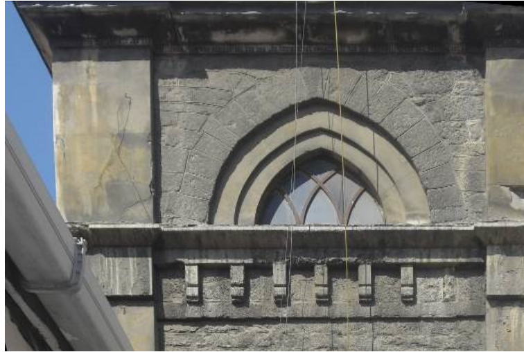
Şekil 4.94 : +10.52 kotundaki silmenin üzerinde yer alan sivri kemerli pencere.
