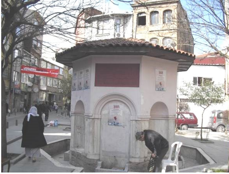
Şekil 3.61 : Restorasyon sonrasında Mihrişah Valide Sultan Çeşmesi, 2011 (E.Aşık).
