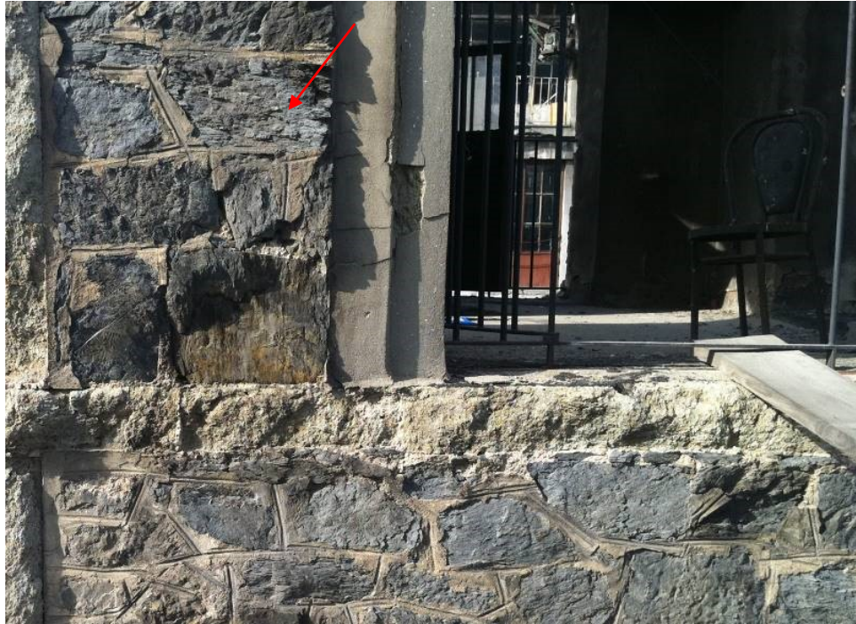
Şekil 4.152 : Moloz taş duvar örgüsünde kullanılan kuvars vake (grovak).
