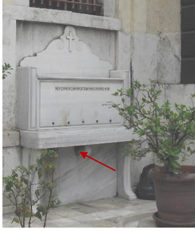
Şekil 4.269 : Eklenen çeşmenin su gideri ile kapanan bodrum kat havalandırma deliği.
