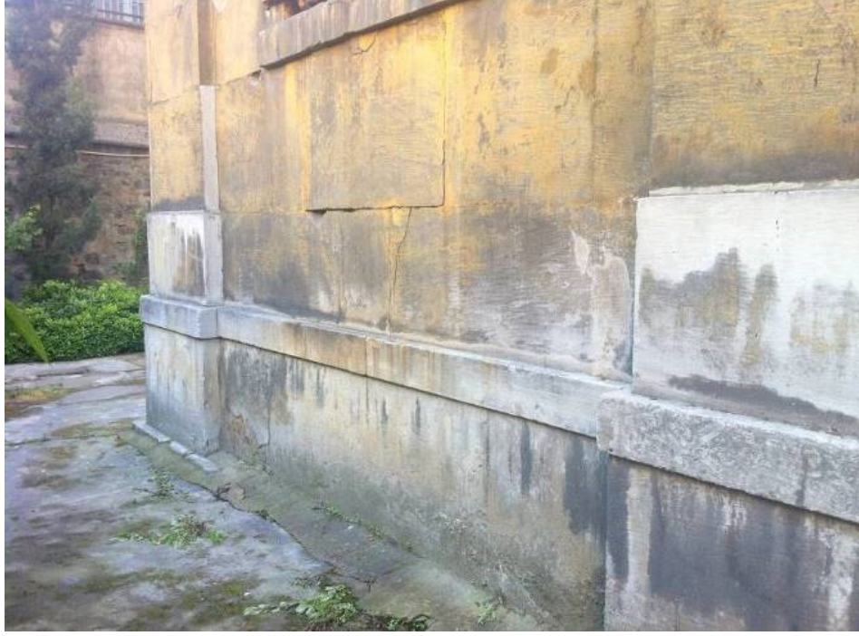
Şekil 4.151 : Cephenin açık bej veya sarı renkli biyomikritik / mikritik / killi biyomikritik veya kumlu biyomikritik kireçtaşı bölümlerinde görülen kirlenme ve kabuk oluşumu.
