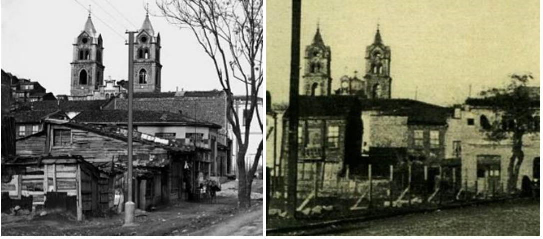
Şekil 4.267 : Achile Samandji (1918-1936 ) ve Kilise arşivi (1953) fotoğraflarında güneybatı cephesi.
