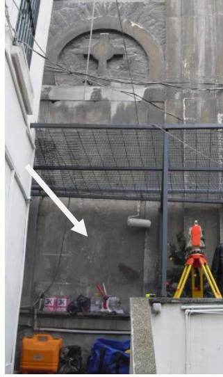
Şekil 4.93 : +1.28 - +4.18 kotları arasında sonradan kapatılmış açıklık ve üzerinde yer alan atnalı kemer.
