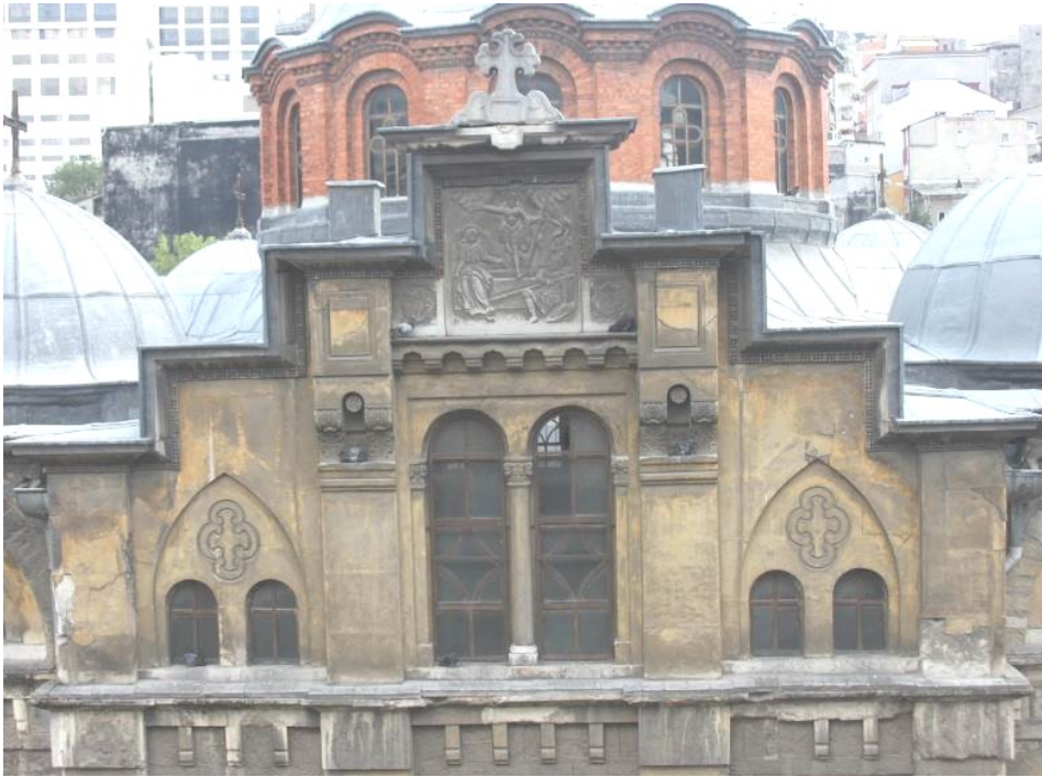
Şekil 4.119 : Kuzeybatı Cephesinin kademeli olarak yükselen orta bölümü.
