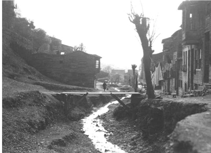
Şekil 3.38 : Dolapdere'ye akan Bulbül Deresi ve üzerindeki ahşap köprü, 1950 (Stamapoulos, 2007, s.320).
