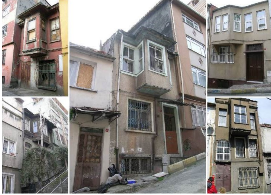
Şekil 3.108 : Çalışma alanındaki “korunmaya değer” olarak nitelendirilen cumbalı yapılardan örnekler.
