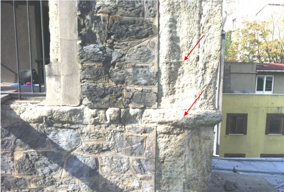
Şekil 4.153 : Çan kulesi köşe pilastırlarında kullanılmış olan arkozik kumtaşı.
