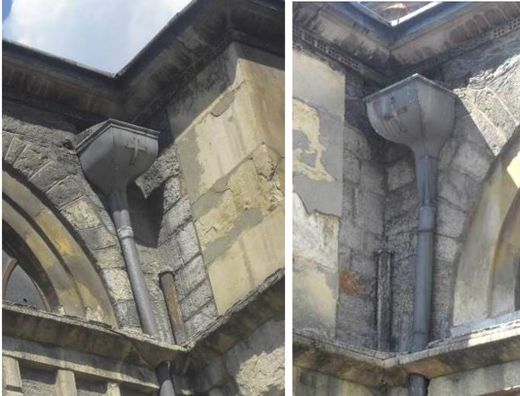
Şekil 4.233 : Özgün ve sonradan eklenen çinko yağmur iniş boruları.
