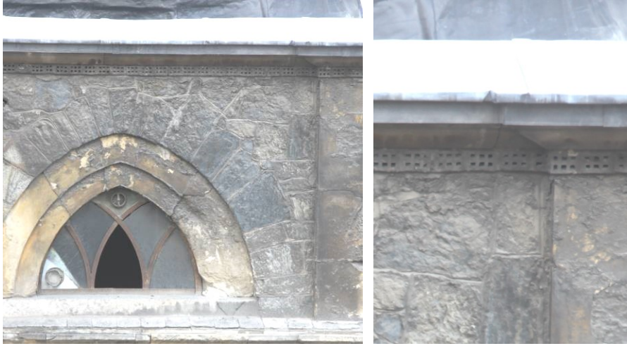
Şekil 4.123 : Kuzeybatı Cephesi, batı ucundan saçak detayı.
