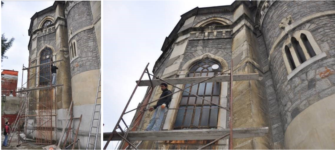
Şekil 4.237 : Apsis pencerelerinde demir parmaklıkların yenilenmesi, 2011.
