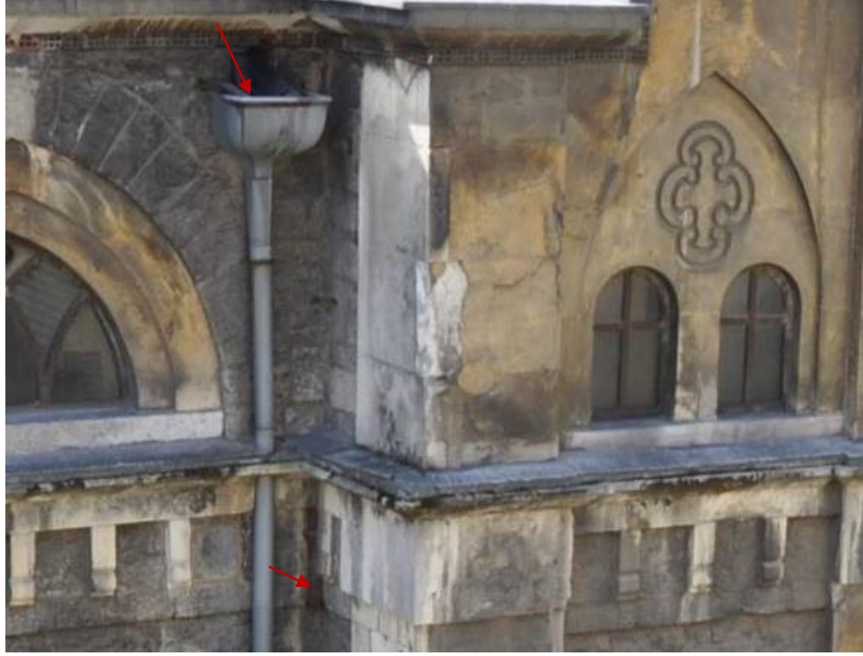
Şekil 4.277 : Özgün çörten ve yağmur iniş borusu.
