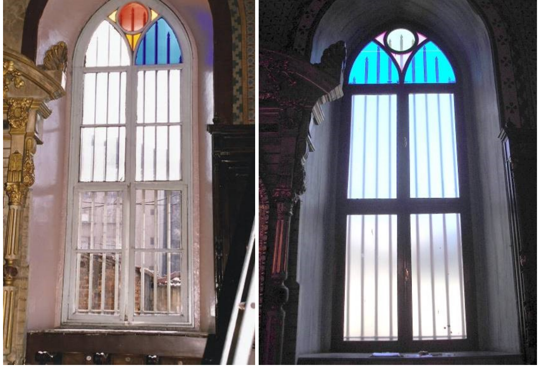
Şekil 4.271 : Yenileme öncesi (2000) ve sonrası naos penceresi (2011).
