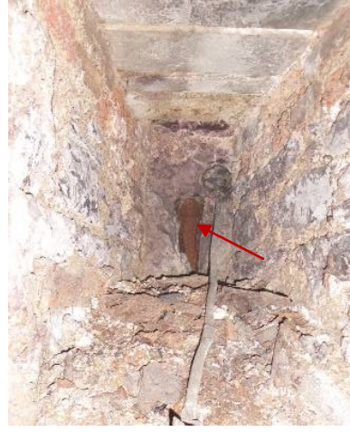
Şekil 4.269 : Eklenen çeşmenin su gideri ile kapanan bodrum kat havalandırma deliği.
