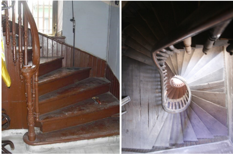
Şekil 4.46 : Galeri katına çıkan ahşap merdiven.
