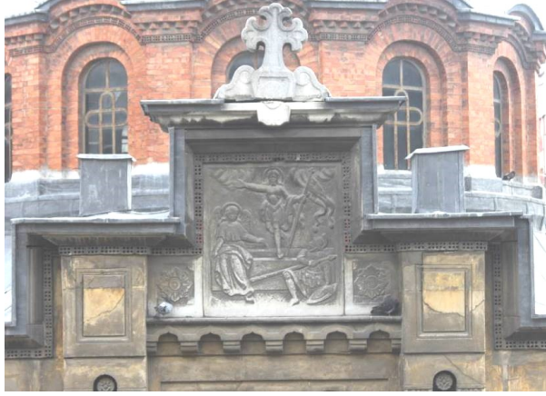
Şekil 4.120 : Kuzeybatı Cephesinin orta bölümünde yer alan “Diriliş İkonası”.
