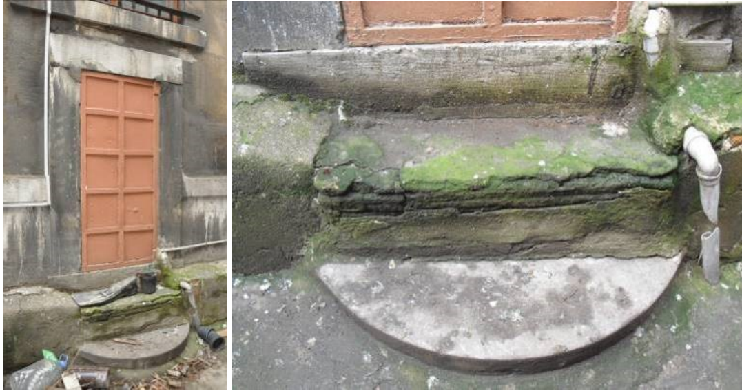
Şekil 4.230 : Güneydoğu Cephe, doğu yönünde bodruma giriş kapısı.
