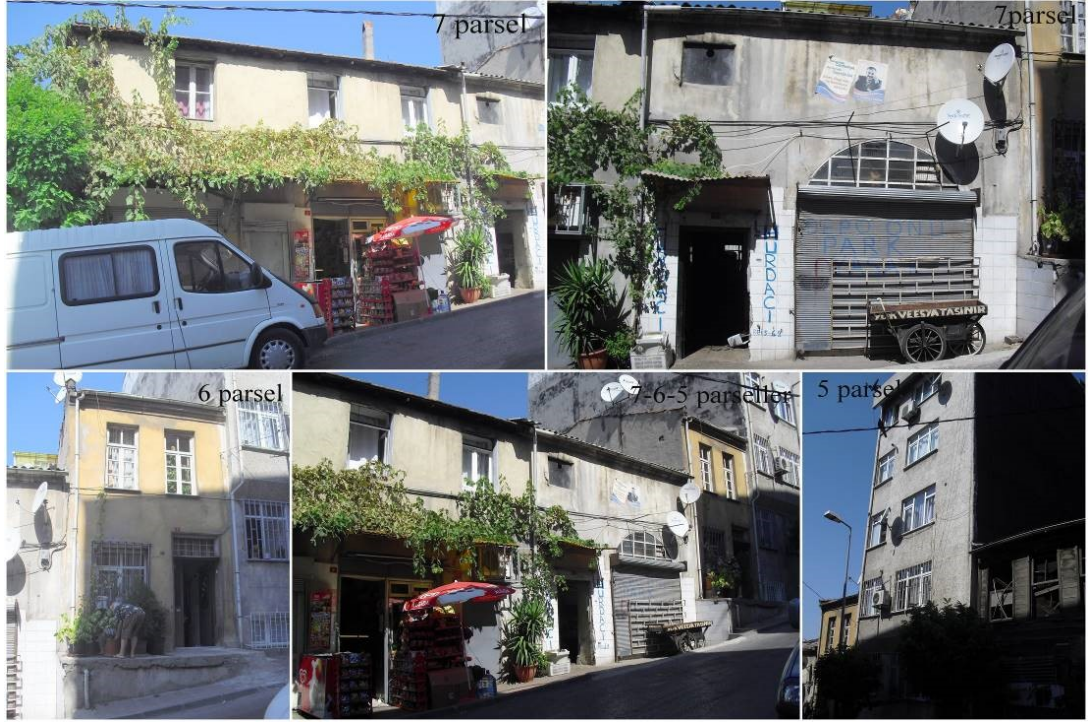
Şekil 3.105 : Çalışma alanında tescili kaldırılan 1332 adada 5-6-7 parsellerde yer alan yapılar.
