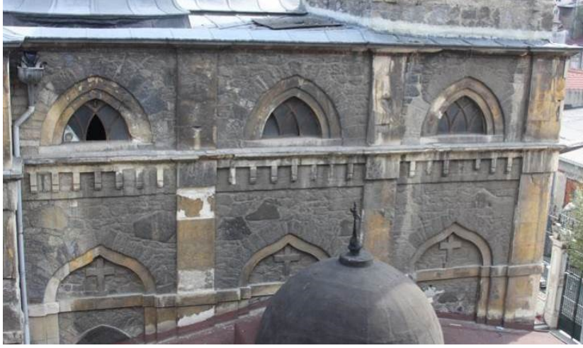
Şekil 4.122 : Kuzeybatı Cephesi, batı ucu.
