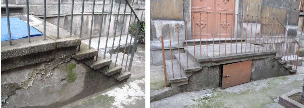
Şekil 4.273 : Güneydoğu cephesindeki dökme mozaik basamaklar ve merdiven sahanlığı.
