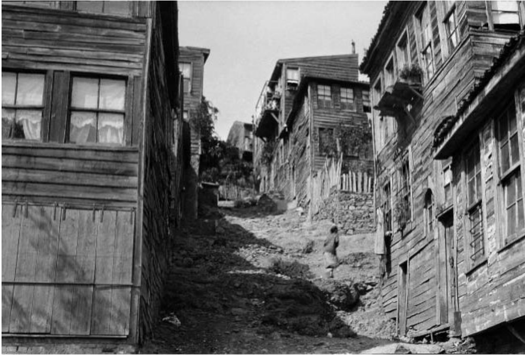
Şekil 3.110 : Tatavla’da 1929 yangını öncesinde tipik bir sokak görünümü (Achille Samandji).
