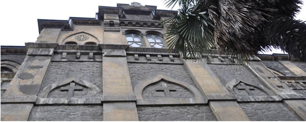
Şekil 4.100 : Güneydoğu Cephe, silmenin (+7.44) üzerindeki flamboyant kemerler.
