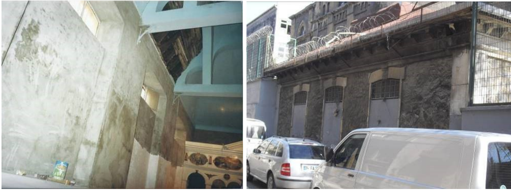
Şekil 4.223 : Ayazmanın güneybatı duvarındaki pencerelerin kapatılması sırasında (2007) ve sonrasında çekilen fotoğraflar (2014).
