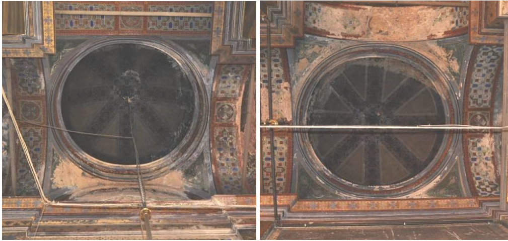
Şekil 4.132 : Çapraz tonozlar arasında kalan köşelerde yer alan küçük kubbeler.
