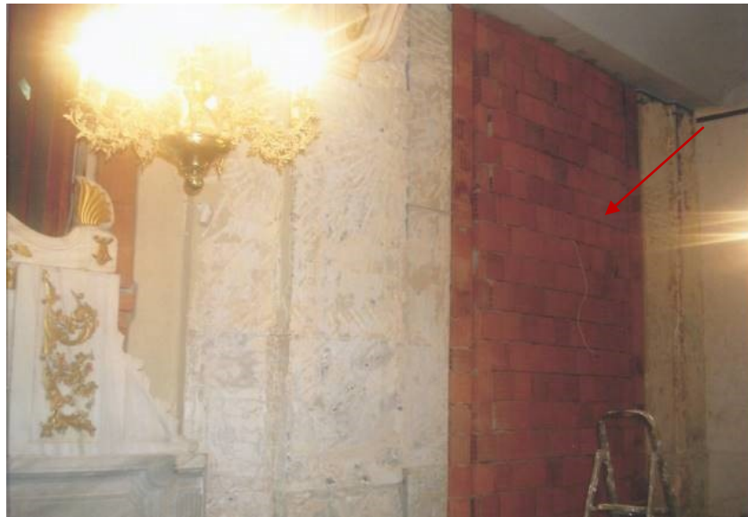
Şekil 4.254 : Kuzeydoğu cephesinde sonradan kapatılmış kapı açıklığı, 2007 (Evangelistria Kilisesi Arşivi).
