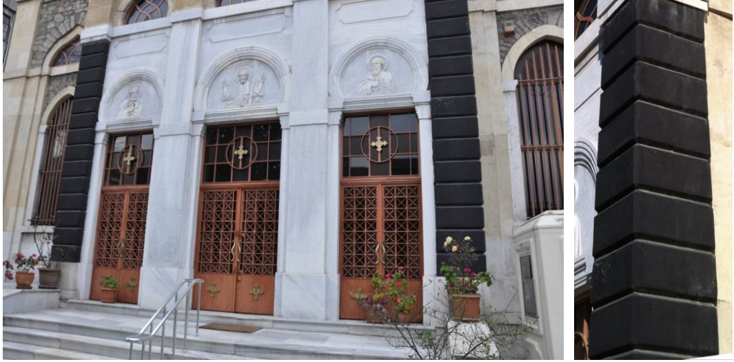
Şekil 4.84 : Evangelistria Kilisesi, nartekse giriş ve köşe pilastırından detay.
