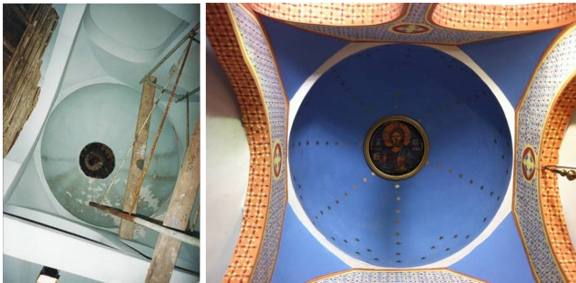
Şekil 4.220 : Ayazma kubbesinin onarım aşamaları (2006 - 2007).
