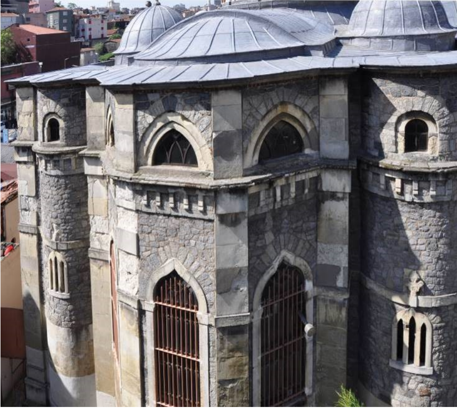
Şekil 4.107 : Kuzeydoğu Cephesi genel görünüm.
