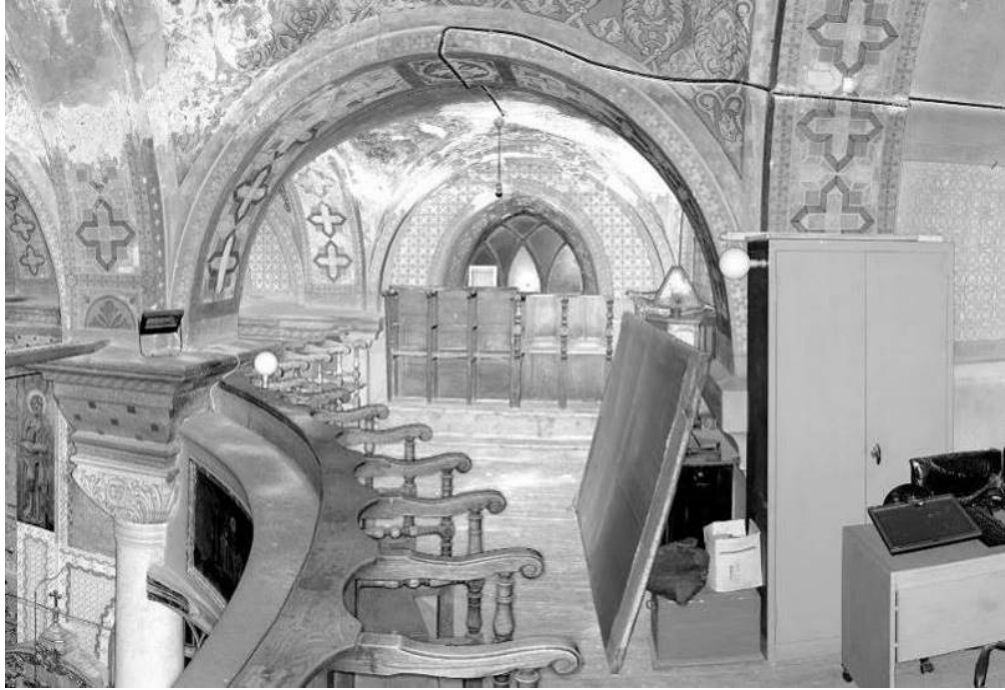
Şekil 4.70 : 2. Galeri, güneydoğu yönündeki pencere.
