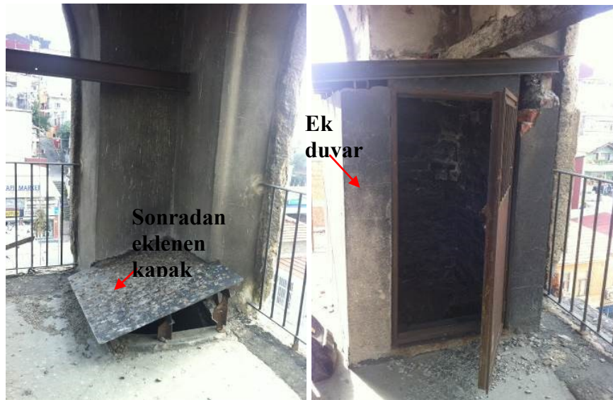
Şekil 4.51 : Doğu ve batı çan kulelerinin çatı seviyesine çıkış bölümleri.
