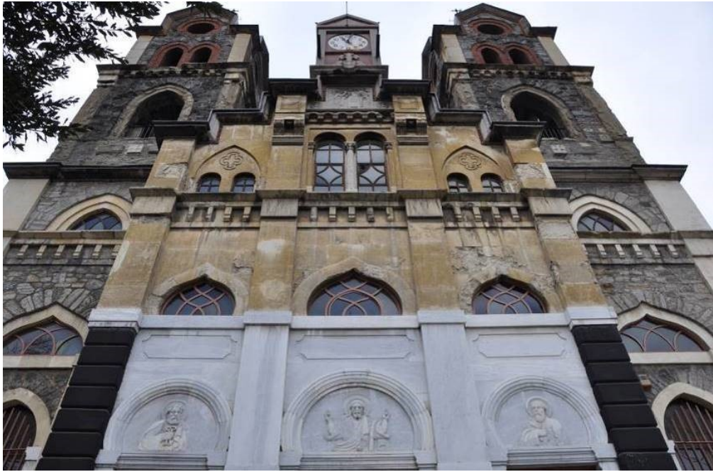
Şekil 4.85 : Güneybatı Cephesi orta bölümdeki üç flamboyant kemerli pencere.
