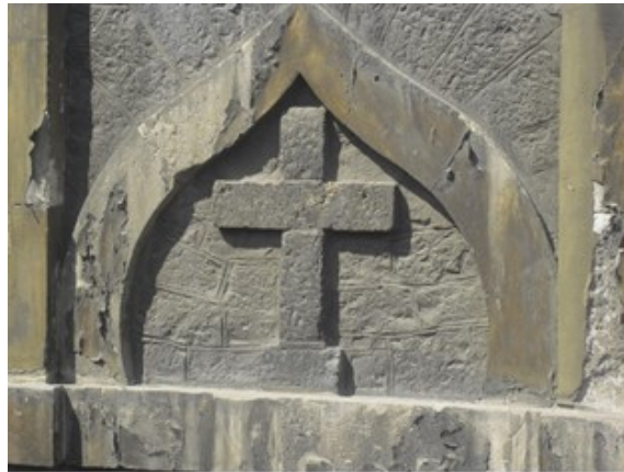
Şekil 4.101 : Flamboyant kemer ve aynasında taş kaide üzerine oturan haç.
