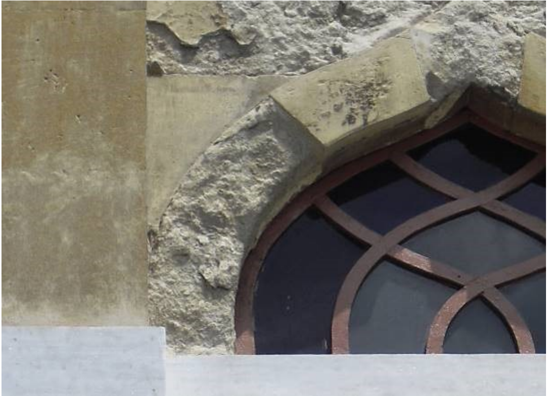
Şekil 4.209 : Biyomikritik kireçtaşı kemer taşında görülen yüzey kaybı.
