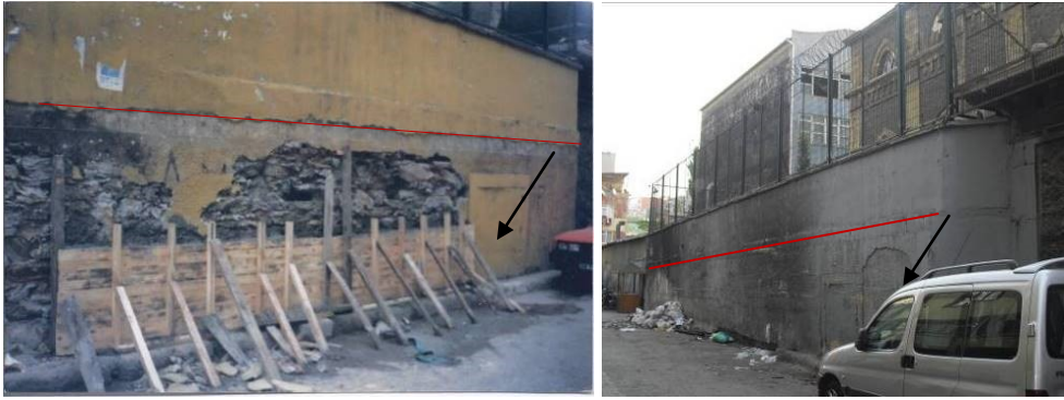
Şekil 4.219 : Yükseltilen güneybatı avlu duvarı ve üzerindeki kapatılmış kapı.
