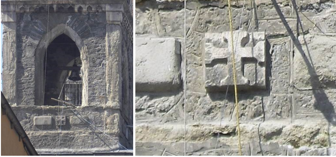
Şekil 4.96 : Güney kule Güneydoğu Cephesi'nde haç kabartmalı blok.
