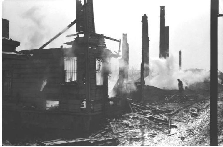
Şekil 3.83 : Tatavla yangınından görünüm, 1929 (Achille Samandji).
