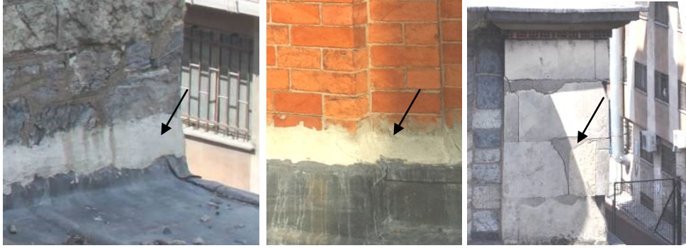
Şekil 4.214 : imento baęlayıcılı sıva uygulanan yzeyler.
