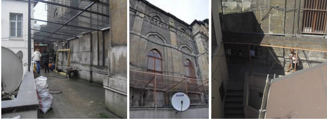
Şekil 4.232 : Kilisenin güneydoğu cephesi önüne eklenen tel kafes koruyucu çatı.
