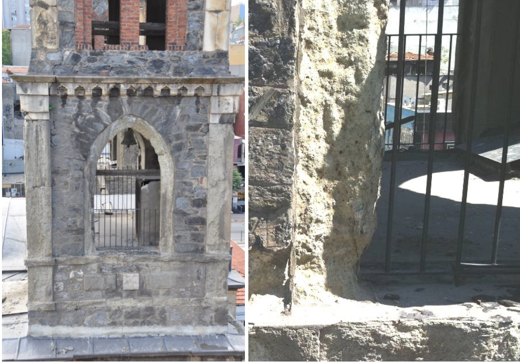
Şekil 4.203 : Riyodasitik tf (od taşı) svelerde yzey kaybı.
