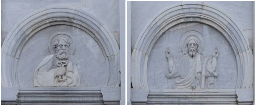
Şekil 4.227 : Mermer kemer aynalarında görülen şekersi aşınma.
