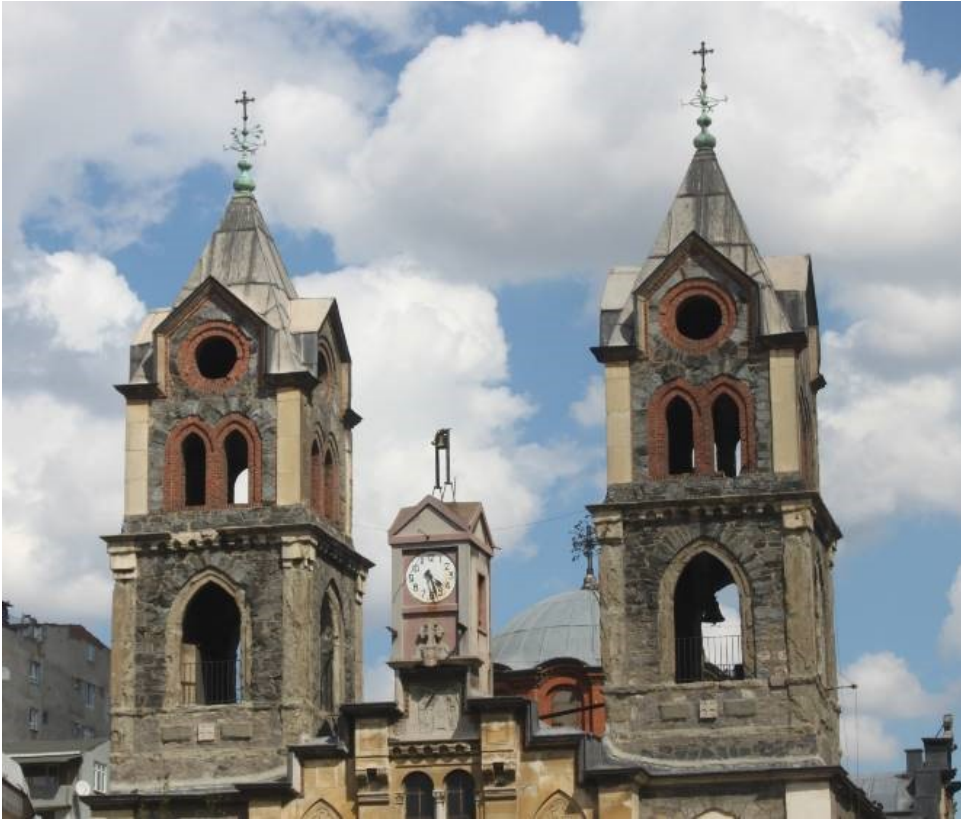
Şekil 4.90 : Güneybatı Cephesi çatı üzerinde yükselen çan kuleleri.
