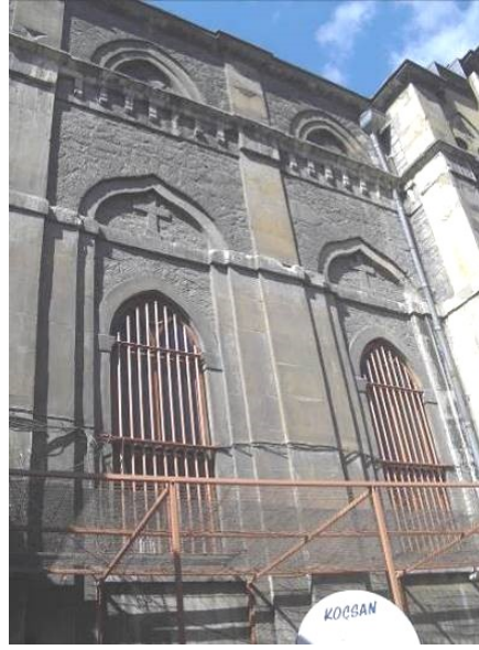
Şekil 4.98 : Güneydoğu Cephe, güney yönü.
