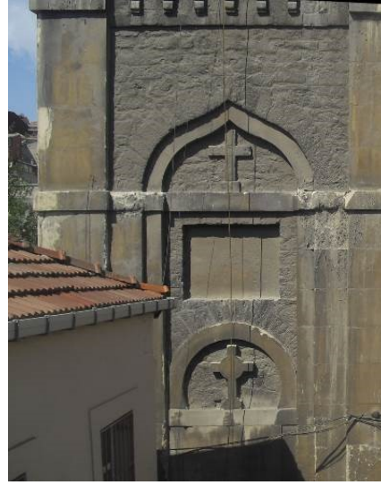
Şekil 4.93 : +1.28 - +4.18 kotları arasında sonradan kapatılmış açıklık ve üzerinde yer alan atnalı kemer.
