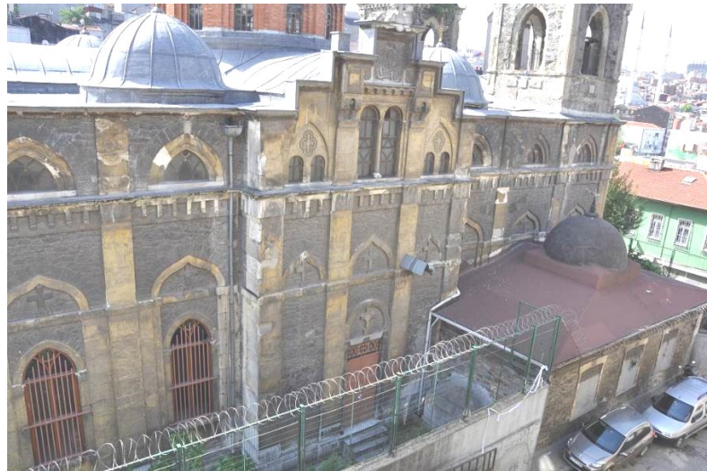
Şekil 4.117 : Kuzeybatı Cephesi'nde dışa taşan orta bölüm (3).
