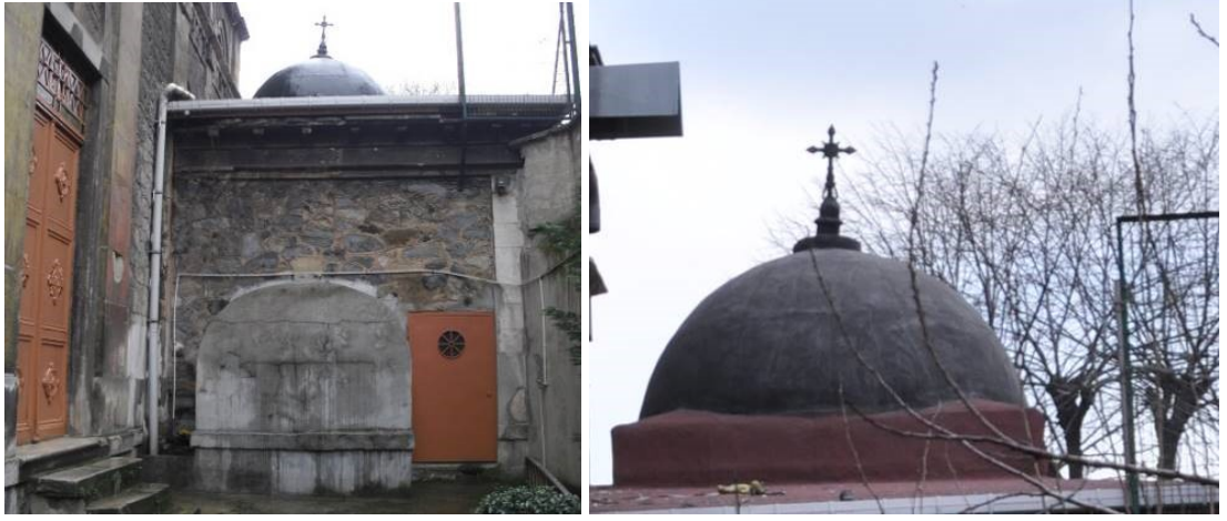
Şekil 4.238 : Ayazmanın Kuzeydoğu Cephesi.
