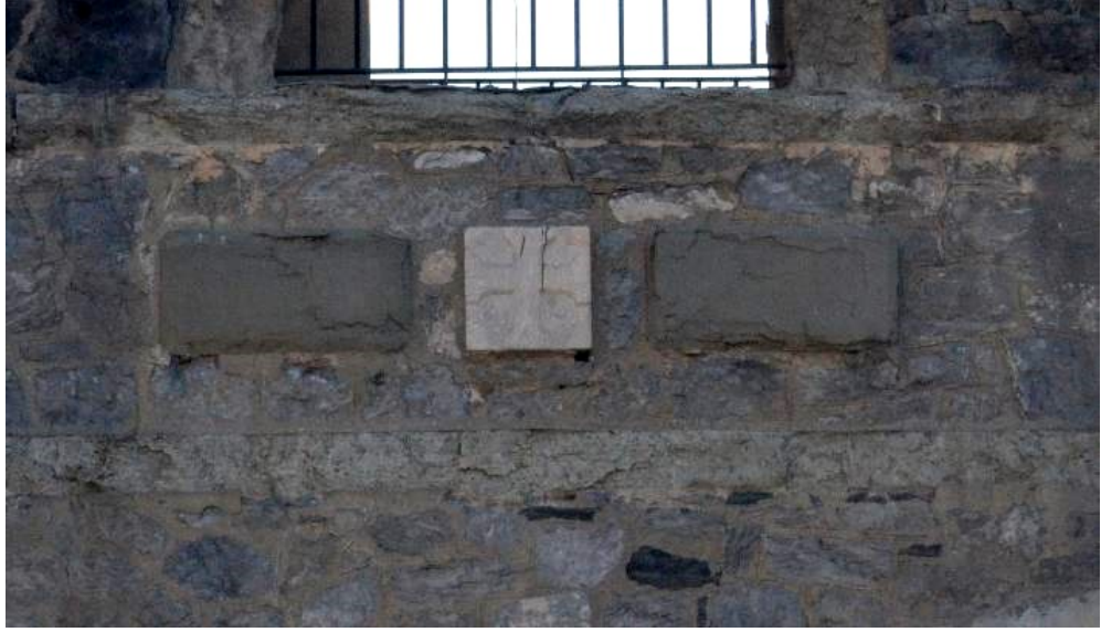
Şekil 4.91 : Güneybatı Cephesi çan kulesi haç motifi detayı.
