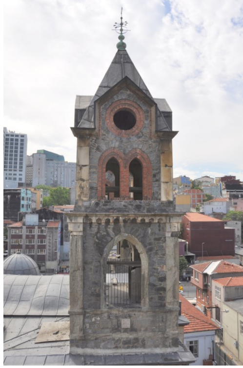
Şekil 4.124 : Kuzeybatı Cephe, kule bölümü.
