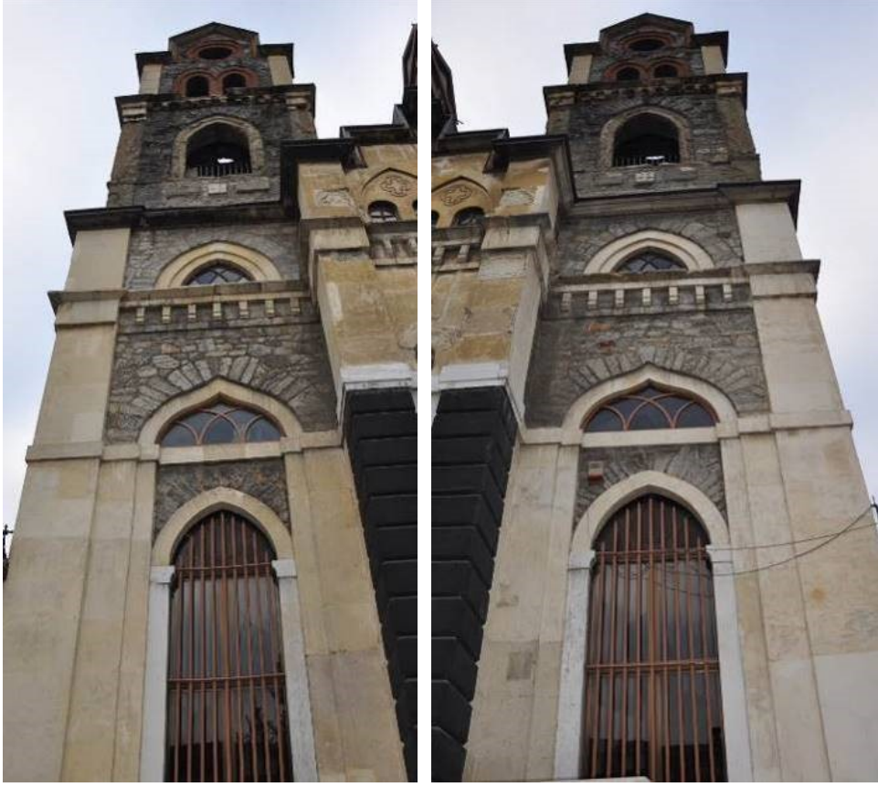
Şekil 4.89 : Güneybatı Cephenin iki yanında yer alan çan kuleleri.
