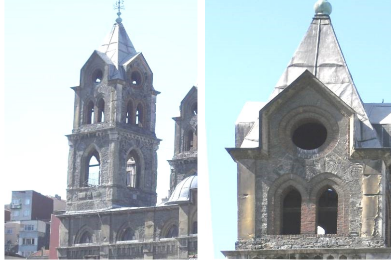
Şekil 4.97 : Güneydoğu Cephesi, çan kuleleri ve piramidal çatıları.
