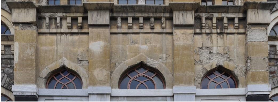
Şekil 4.228 : +7.44 - +10.52 kotundaki silmeler arasındaki orta bölüm.
