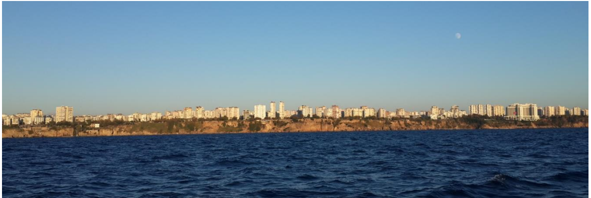
Resim 3.10. Lara Falezler Bölgesi'ndeki yüksek katlı yapılaşmanın denizden görünümü, kişisel arşiv, 2015
