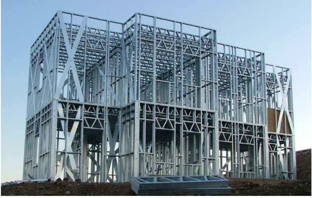
Şekil 1.2 Çelik çaprazlı çerçeve sistem yapı
