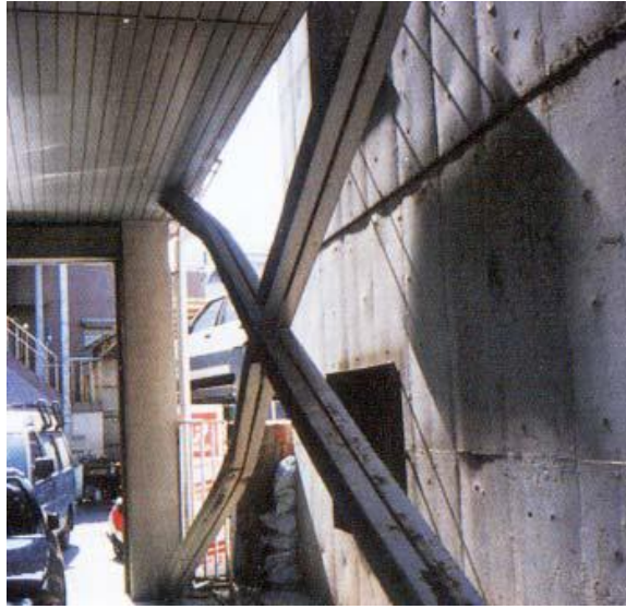
a.Düzlem dışı burkulma ve aprazlarda kırılma [19]
