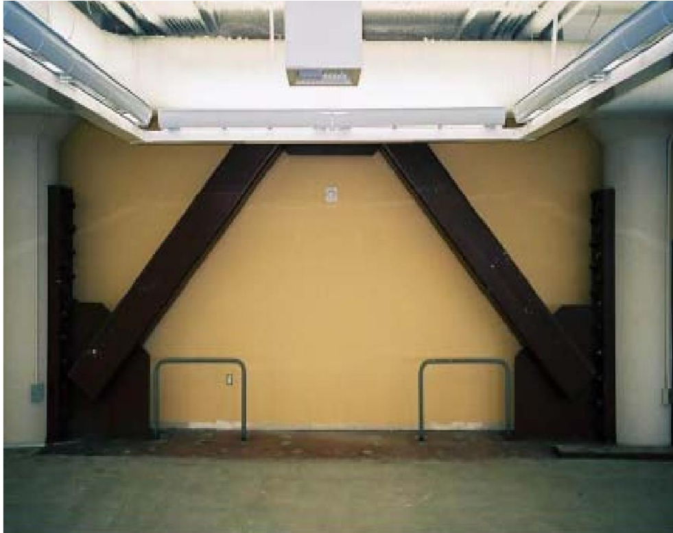
Şekil 1.1 Geleneksel çelik çapraz uygulaması
