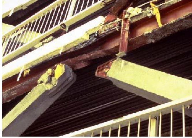
b.Birleşimde kırılma [21]
