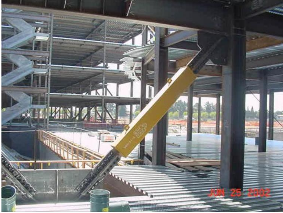
Şekil 2.1 Burkulması önlenmiş çapraz (BÖÇ)
