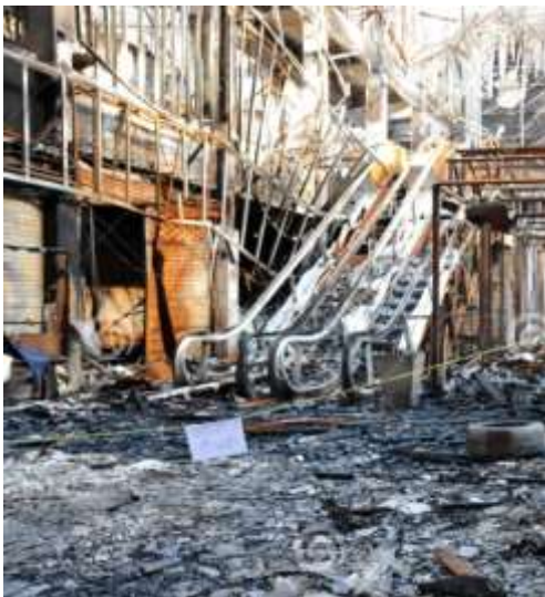
Resim 2.9. Çelik strüktürde yangının etkisi [47]
