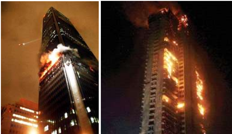
Resim 2.7. Yüksek binalarda yangın [36,37]
