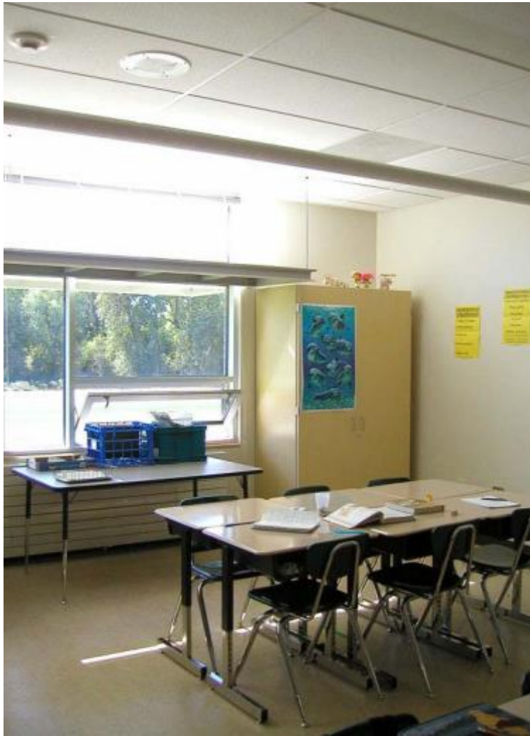
Resim 3.5. Işık rafının mekân içinden görünümü [32]
