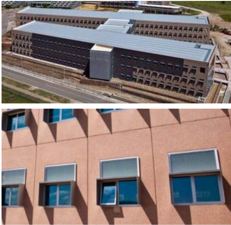
Resim 3.6. Yapının genel görünümü(üstte) ve güney cephesinde gölge elemanları ve panjurlarla beraber kullanılan ışık rafları(alta)
