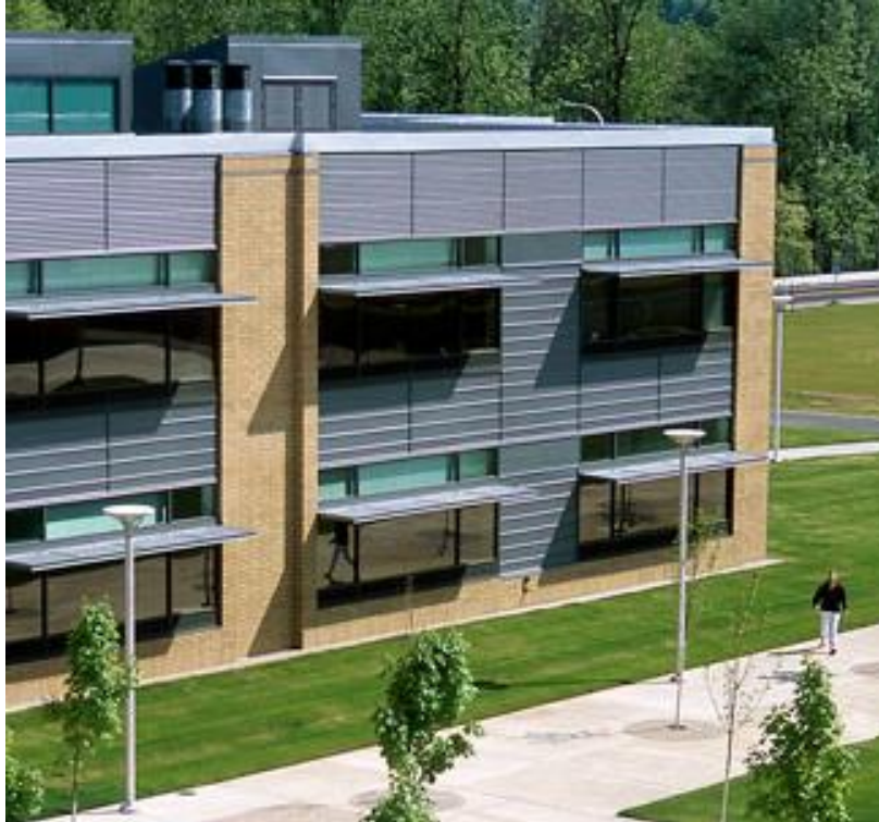
Resim 3.2. Işık raflarının dış cephede görünümü [29]
