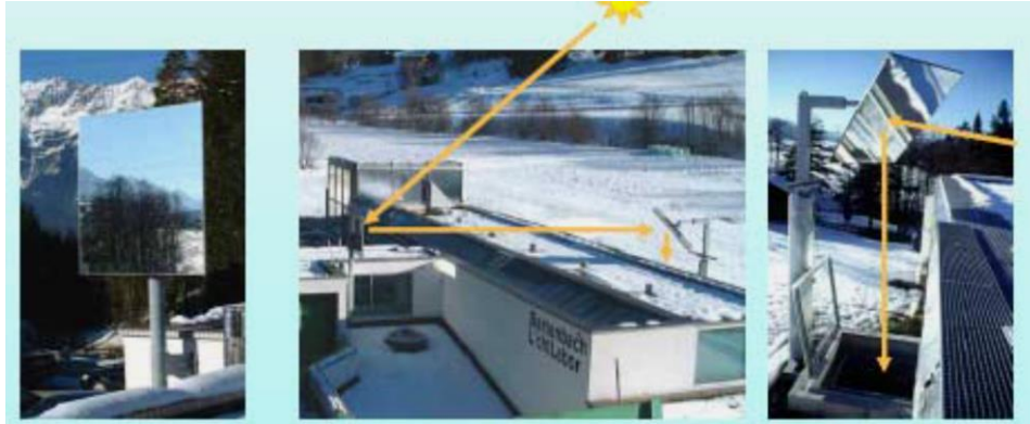
Şekil 2.6. Işık kılavuzları çalışma prensibi
