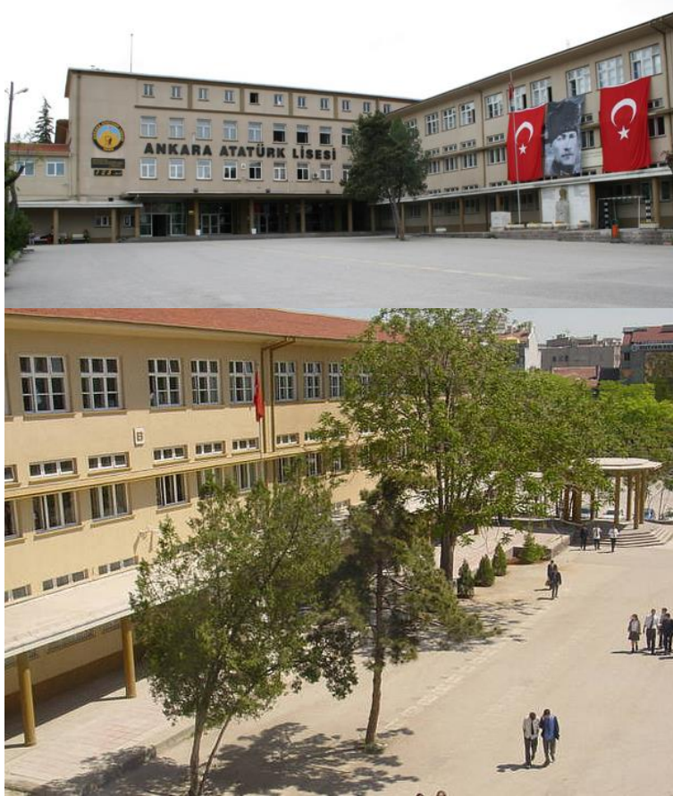
Resim 3.10. Binanın genel görünümü ve B Bloкта ışık raflarının kullanımı
