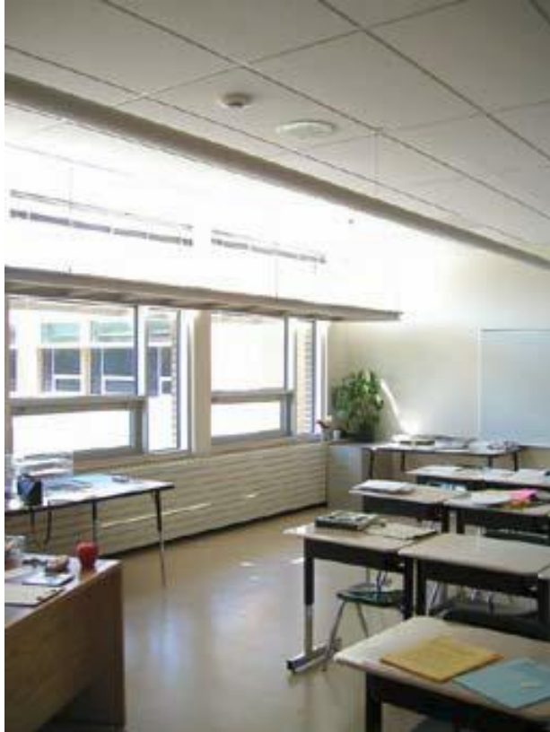
Resim 3.1. Laboratuarda ışık rafı uygulaması, Ash Creek Intermediate School [20]
