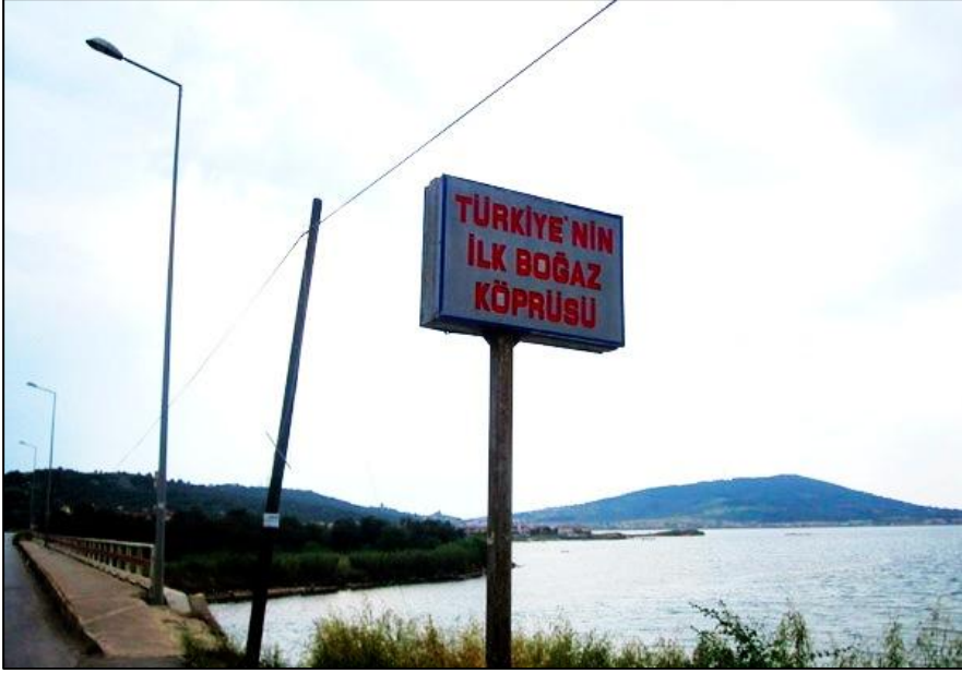
Şekil 4.25: Ülkemizdeki ilk boğaz köprüsü
