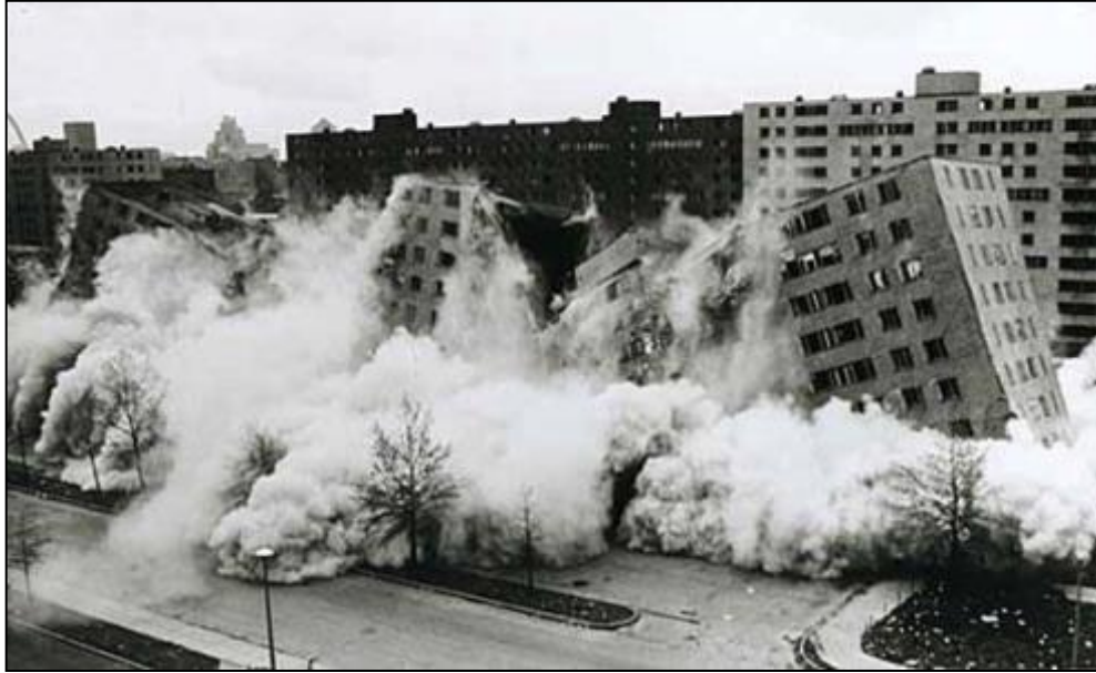
Şekil 3.4 Pruitt-Igoe toplu konutlarının dinamitle yıkılması [101]
