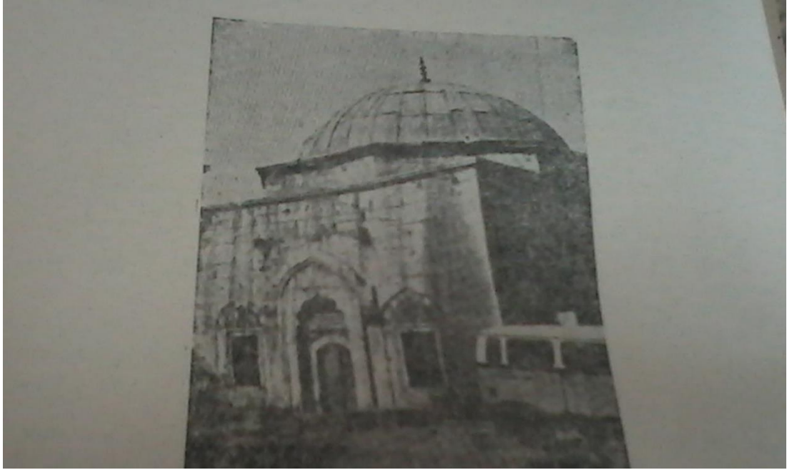
Ek-4 Haliliye Medresesi'nin Yıkılmadan Önceki Son Fotoğrafı
