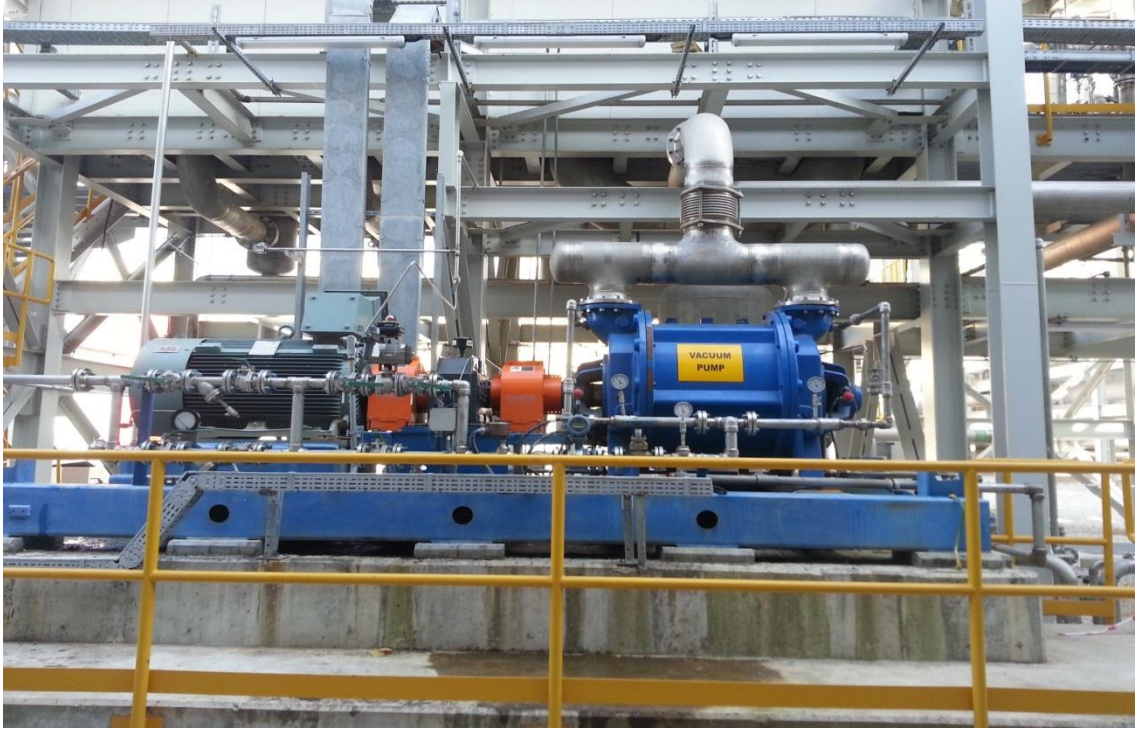
Şekil 6.7 Gaz alma sistemi sıvı halkalı vakum pompası
