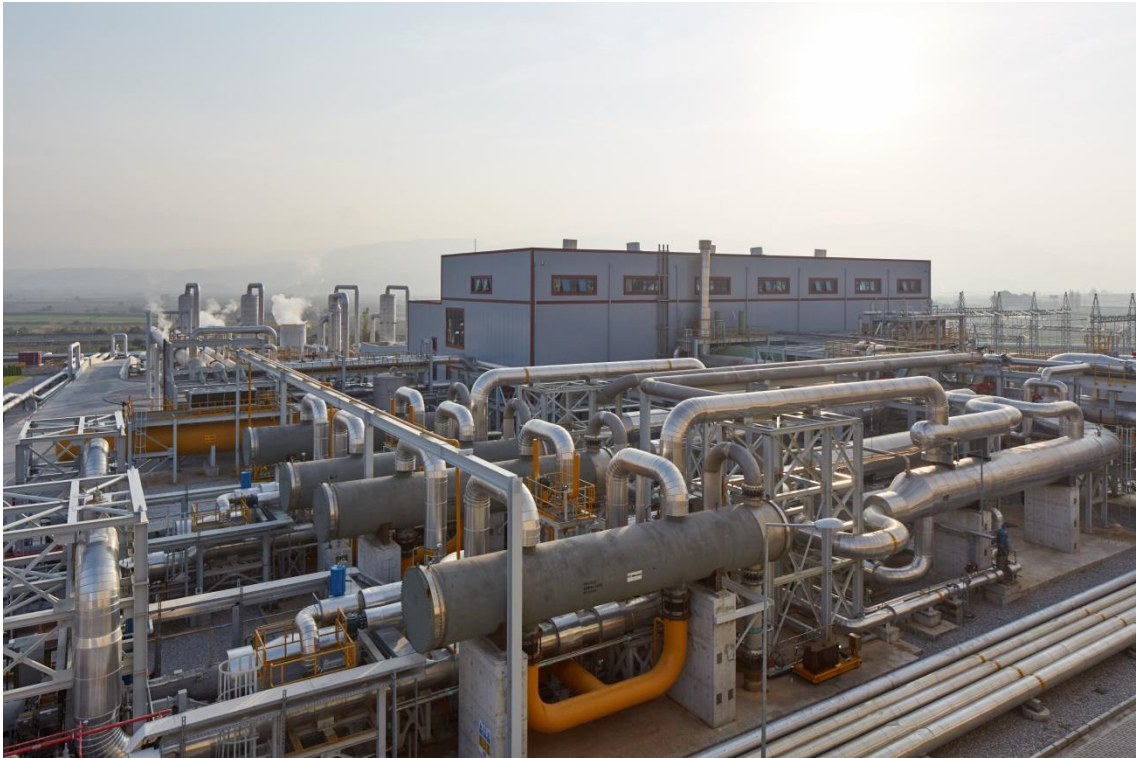
Şekil 6.3 Kızıldere-II JES binary çevrim üniteleri
