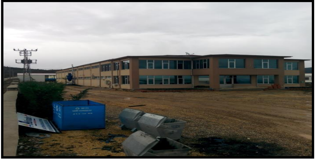
Şekil 4.1: Kastamonu Organize Sanayi Bölgesi katı atık toplama konteynırları.
