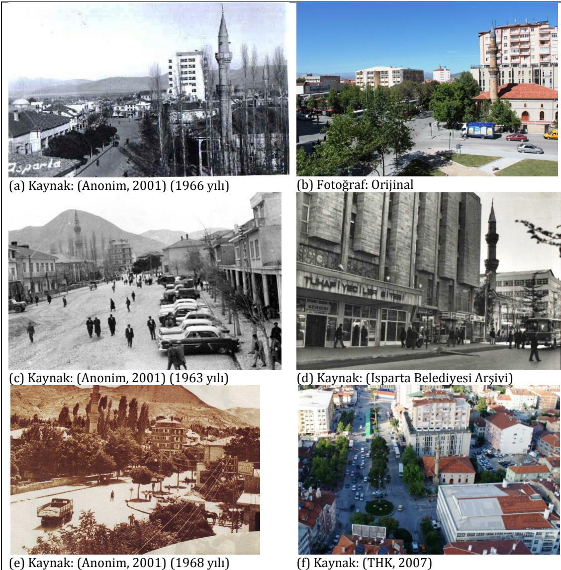
Şekil 5.7. Kavaklı Camii ve çevresine ait görünümeler
