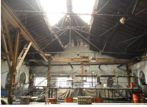
Şekil 5. 250 İç mekân, 4 ve 5 nolu hattın bulunduğu bölüm, büyük yay şeklindeki yapı ve çatısı
