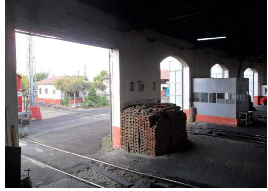
Şekil 5. 314 İç mekân, 1 – 4 nolu hattın bulunduğu bölüm, arka cephedeki lokomotif giriş – çıkış kapıları
