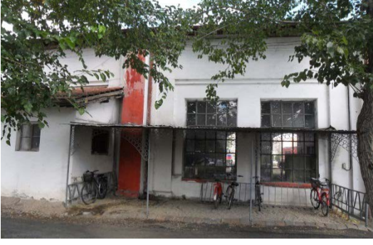
Şekil 5. 295 Arka cephe, 8 ve 9 nolu hattın bulunduğu bölüm, 9 nolu hattın bulunduğu bölümde orijinal pencereler, sonradan imal edilmiş gölgelik ve 8 nolu hattın arka cephesindeki ek
