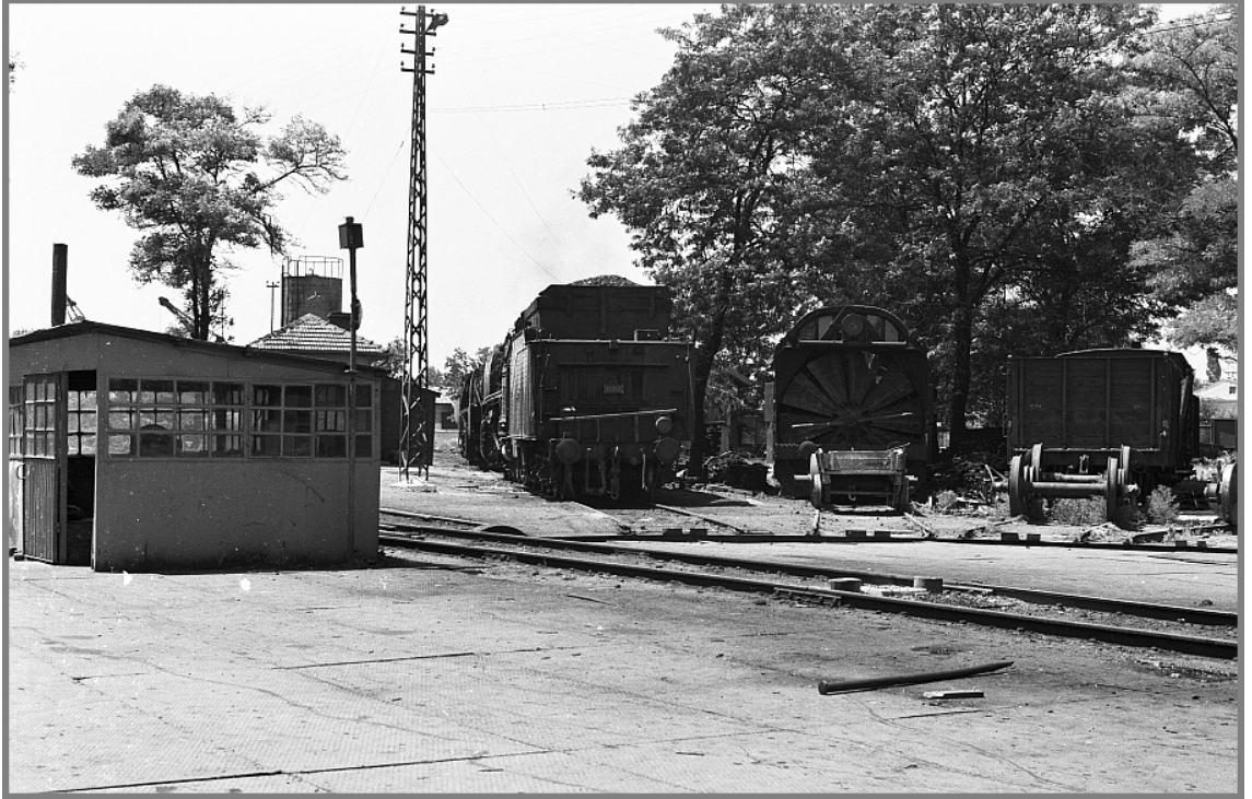
Şekil 5. 121 Konya İstasyonu'ndaki dairesel planlı lokomotif deposu dönerköprüsü ve dönerköprü üzerindeki kontrol odası [135].
