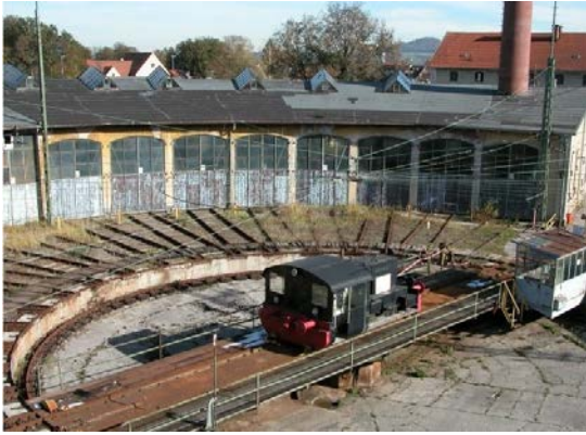
Şekil 4. 37 Freilassing dairesel planlı lokomotif deposu. Restorasyon öncesi dış cephe [86].
