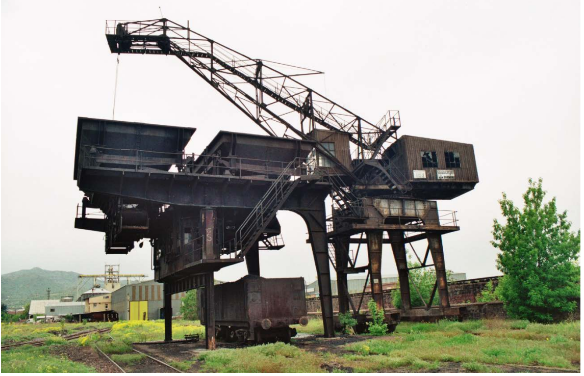
Şekil 5. 275 Kayseri İstasyonu'ndaki dairesel planlı lokomotif deposu arka bölümünde yer alan, bugün mevcut olmayan kömür rıhtımları ve yükleme tesisatı [160].
