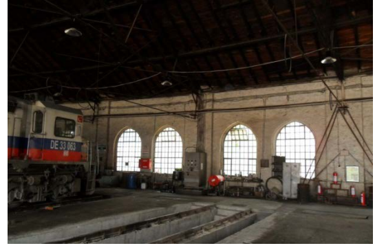
Şekil 5. 247 İç mekân, 2 - 13 nolu hattın bulunduğu bölümler, arka cephe duvarlar ve pencereler, lokomotif bakım çukurları, ana mekânın çatısı
