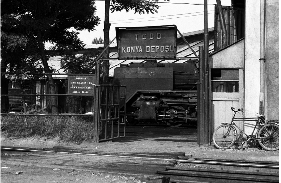
Şekil 5. 119 Konya İstasyonu'ndaki dairesel planlı lokomotif deposu lokomotif giriş – çıkış kapılarının bulunduğu ön cephe [135].
