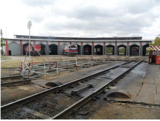
Şekil 5. 277 Ön cephe, 1 - 12 nolu hattın bulunduğu bölüm, lokomotif giriş - çıkış kapıları, ana mekânın çatısı ve çatı aydınlığı, dönerköprü
