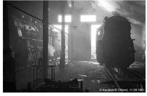
Şekil 3. 8 Hatları dönerköprülerle bağlanan dikdörtgen depolara örnek: Samsun Lokomotif Depo [54].
