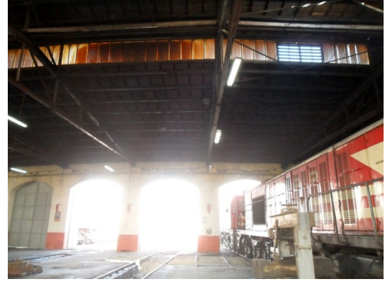
Şekil 5. 308 İç mekân, 8 – 11 nolu hattın bulunduğu bölüm, lokomotif giriş – çıkış kapıları, lokomotif bakım çukurları, çatı ve çatı aydınlığı
