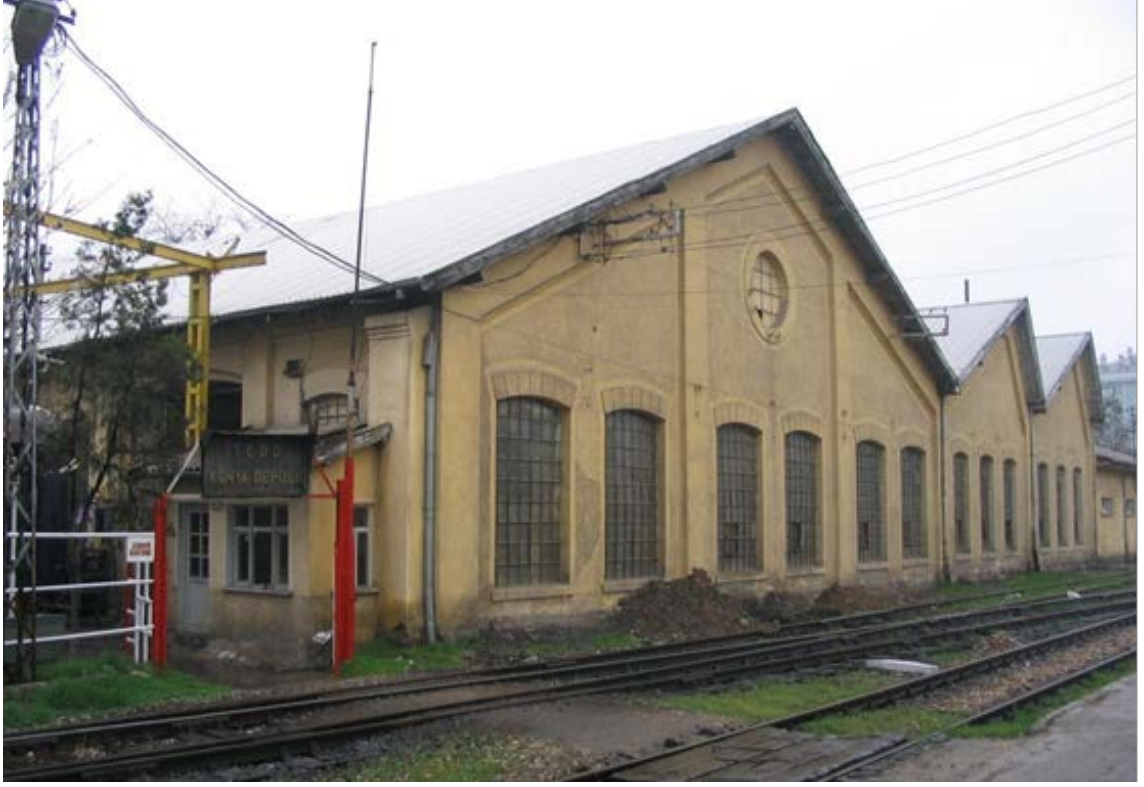
Şekil 5. 138 Konya İstasyonu'ndaki dairesel planlı lokomotif deposu yan cephesi [142].
