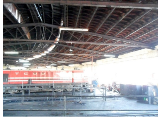
Şekil 5. 304 İç mekân, 2 - 12 nolu hattın bulunduğu bölüm, arka cephedeki orijinal pencereler, lokomotif bakım çukurları, çatı ve çatı aydınlığı
