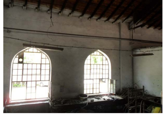
Şekil 5. 259 İç mekân, 14, 15 nolu hattın bulunduğu bölüm, arka duvar üzerindeki pencereler
