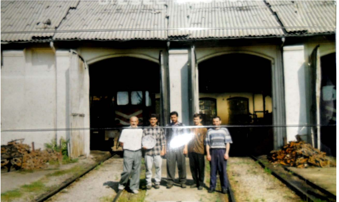
Şekil 5. 135 Konya İstasyonu'ndaki dairesel planlı lokomotif deposu ön cephesi [141].
