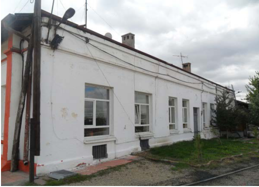
Şekil 5. 285 Yan cephe, ofis bölümü, PVC olarak imal edilmiş yeni pencereler
