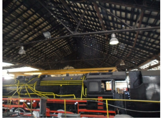
Şekil 5. 177 İç mekân, 2-10 nolu hatların bulunduğu ana mekân, çatı konstrüksiyonu
