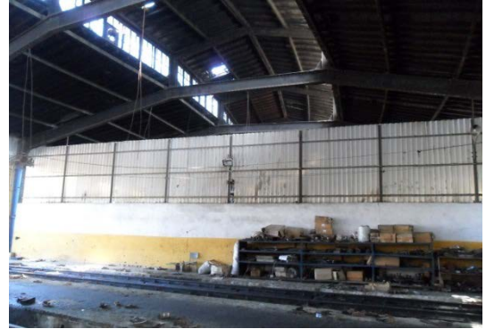
Şekil 5. 52 İç mekân, 3 nolu hattın bulunduğu bölüm, lokomotif bakım çukuru, bölücü duvar, çatı ve çatı aydınlığı
