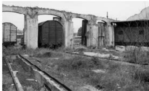
Resim 6.7. Çerkezköy Lokomotif Deposu İç Kısmı (Mayıs 2007)
