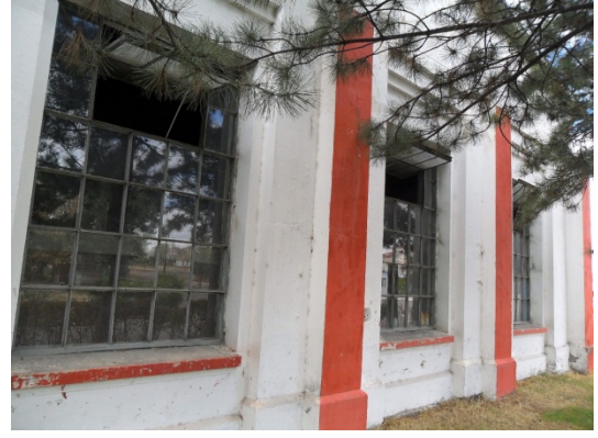
Şekil 5. 302 Yan cephe, yan cephedeki orijinal pencereler, taşıyıcı kolonlar
