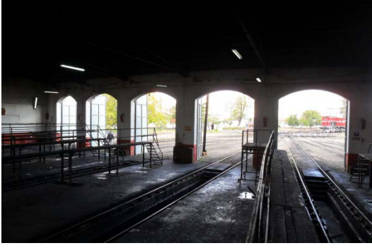
Şekil 5. 313 İç mekân, 1 - 5 nolu hattın bulunduğu bölüm, lokomotif giriş – çıkış kapıları, lokomotif bakım çukurları
