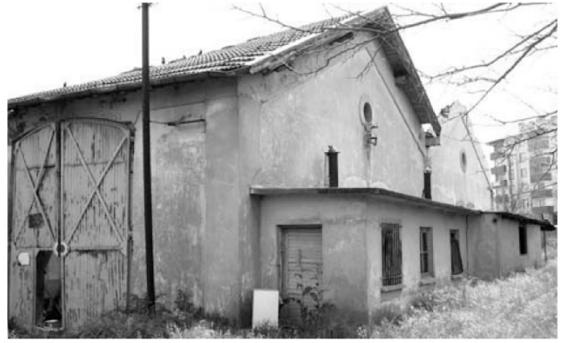
Resim 6.1. Çerkezköy Lokomotif Deposu Giriş ve Sağ Yan Cephesi (Mayıs 2007)
