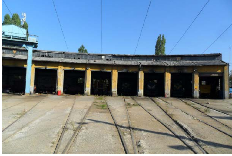
Şekil 5. 13 Ön cephe, 1, 2, 3, 4, 5, 6, 7, 8 nolu hatların bulunduğu bölüm, kapı açıklıkları, çatı ve çatı aydınlığı
