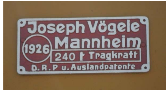
Şekil 5. 73 Dönerköprü üzerindeki kumanda odasının giriş kapısı üzerinde bulunan dönerköprünün imalatçı firmasını ve yapım yılını gösteren plaket
