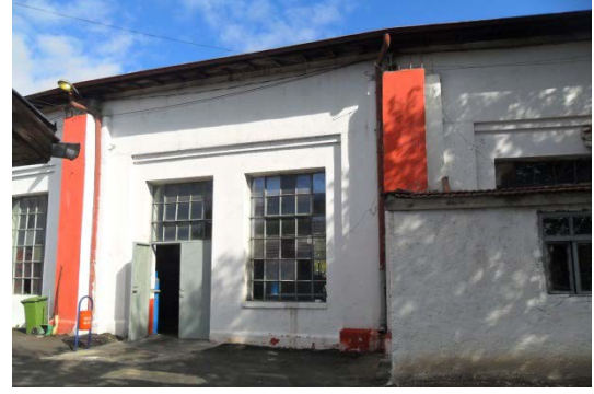
Şekil 5. 296 Arka cephe, 7 ve 8 nolu hattın bulunduğu bölüm, 7 nolu hattın bulunduğu bölümde orijinal pencerelerin birinin yerine sonradan imal edilmiş kapı, 8 nolu hattın bulunduğu bölüm ve arka cephesindeki ek
