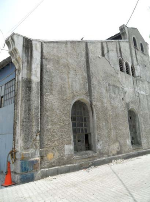
Şekil 5. 231 Yan cephe, 15 nolu hattın bulunduğu bölüm
