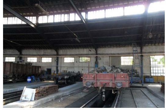
Şekil 5. 48 İç mekân, 5, 6, 7, 8 nolu hatların bulunduğu bölüm, lokomotif bakım çukurları, arka duvar, orijinal pencereler, çatı ve çatı aydınlığı
