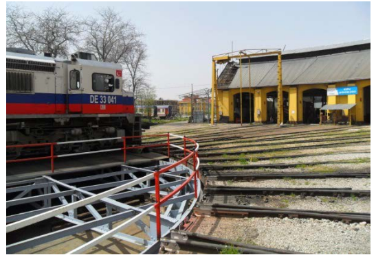
Şekil 5. 149 Lokomotif Giriş Cephesi, 1, 2, 3, 4, 5, 6, 7, 8, 9, 10, 11, 12, 13, 14 nolu hattın bulunduğu bölümler
