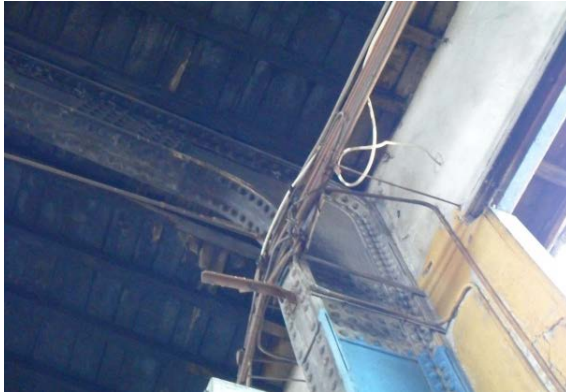
Şekil 5. 15 İç mekân, çelik kolon ve kiriş sistemi ile dış duvar, çatı birleşimi
