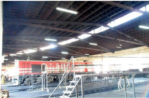
Şekil 5. 305 İç mekân, 2 - 12 nolu hattın bulunduğu bölüm, arka cephedeki orijinal pencereler, lokomotif bakım çukurları, çatı ve çatı aydınlığı
