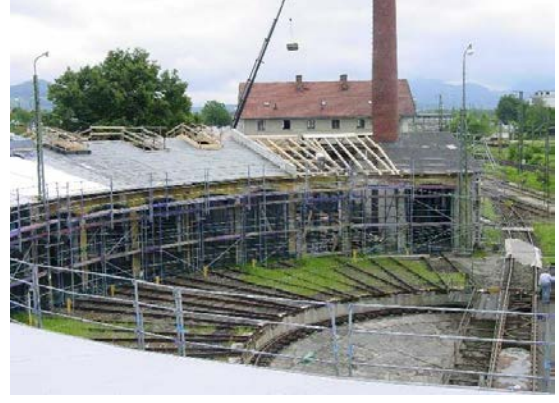
Şekil 4. 40 Freilassing dairesel planlı lokomotif deposu. Restorasyon süreci [86].
