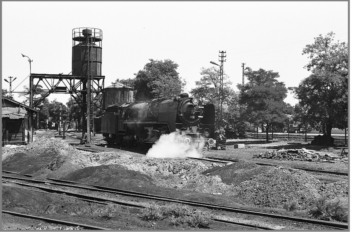
Şekil 5. 123 Konya İstasyonu'ndaki dairesel planlı lokomotif deposu kum deposu [135].
