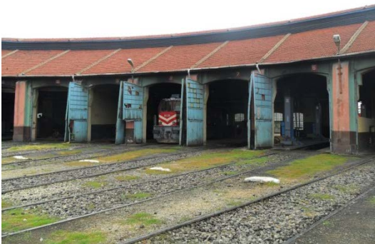
Şekil 5. 66 Lokomotif Giriş Cephesi, 6, 7, 8, 9, 10 nolu hatların kapıları ve çatı aydınlığı
