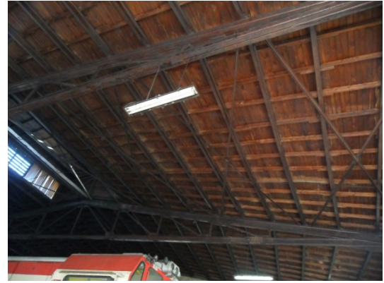
Şekil 5. 310 İç mekân, çatı iskeleti ve kaplaması detayı
