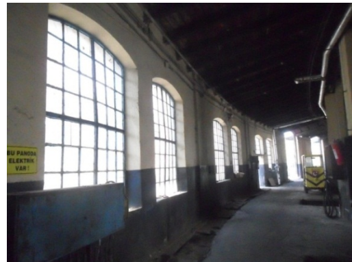
Şekil 5. 95 İç mekân, 5, 6, 7, 8 ve 9 nolu hattın bulunduğu bölüm, taşıyıcı kolonlar ile arka cephe duvarları arasında kalan mekân, arka cephedeki pencereler
