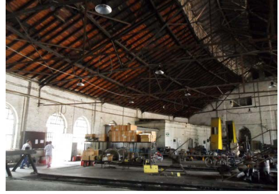
Şekil 5. 245 İç mekân, 12, 13 nolu hattın bulunduğu bölüm, arka cephe duvarları, ana mekânın çatısı
