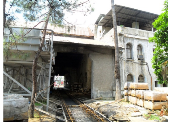
Şekil 5. 215 Arka cephe, 1, 2 nolu hattın bulunduğu bölüm
