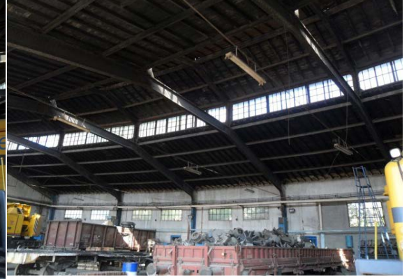
Şekil 5. 38 İç mekân, 6, 7, 8, 9 nolu hatların bulunduğu bölüm, duvarlarının iç yüzeyleri ve çatıda devam eden metal iskelet, yan ve arka duvar, çatı aydınlığı
