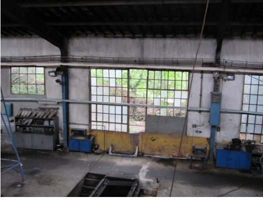
Şekil 5. 47 İç mekân, 5, 6, 7, 8 nolu hatların bulunduğu bölüm, arka duvar, orijinal pencereler, çatı ve çatı aydınlığı
