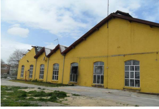
Şekil 5. 162 14 nolu hattın bulunduğu bölümün yan cephesi, orjinal pencerelerin yerine takılan PVC'den imal edilmiş yeni pencereler, ana mekânın çatısı ve devamında üç adet kırma çatı
