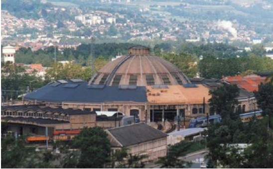
Şekil 4. 50 Chambéry Dairesel Planlı Lokomotif Deposu, çatı onarımı [89].
