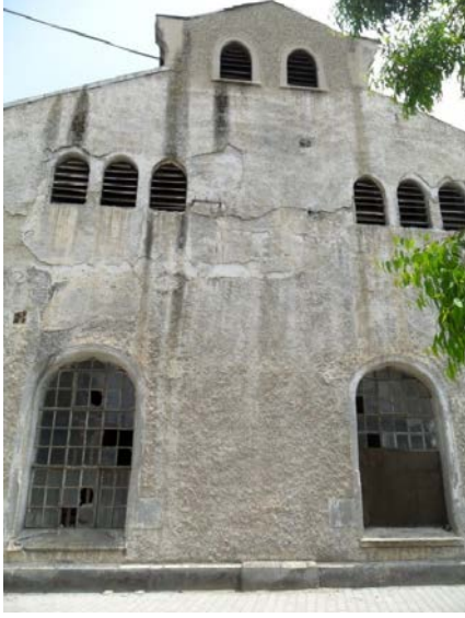
Şekil 5. 233 Yan cephe, 15 nolu hattın bulunduğu bölüm, pencere detayı
