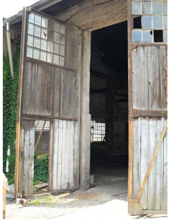
Şekil 5. 220 Arka cephe, 5 nolu hattın bulunduğu bölüm, orijinal kapı
