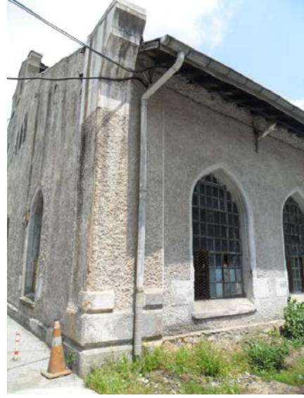
Şekil 5. 234 Yan ve arka cephe, 15 nolu hattın bulunduğu bölüm, pencere detayı
