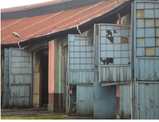
Şekil 5. 68 Lokomotif Giriş Cephesi, 8, 9, 10, 11, nolu hatların bulunduğu bölümlerin kapı detayları
