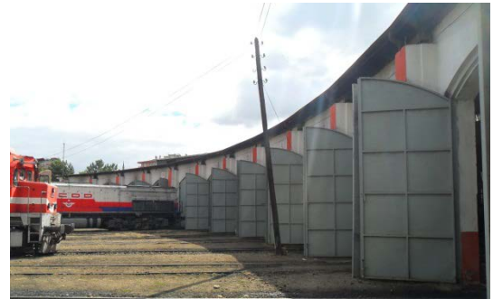
Şekil 5. 282 Ön cephe, 1 - 12 nolu hattın bulunduğu bölüm, lokomotif giriş - çıkış kapıları, taşıyıcı kolonlar
