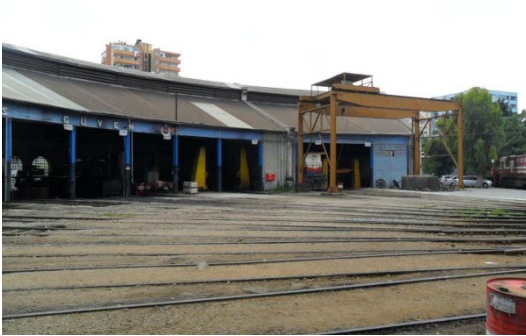
Şekil 5. 227 Ön cephe, 14, 15 nolu hattın bulunduğu bölümler, lokomotif giriş-çıkış kapıları, ana mekânın çatısı ve çatı aydınlığı
