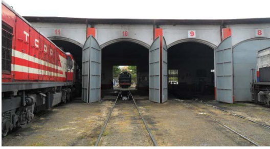
Şekil 5. 279 Ön cephe, 8 - 11 nolu hattın bulunduğu bölüm, lokomotif giriş - çıkış kapıları, taşıyıcı kolonlar
