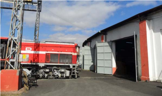
Şekil 5. 299 Arka cephe, 2, 3, 4 nolu hattın bulunduğu bölüm, lokomotif giriş – çıkış kapıları
