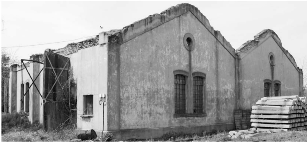
Resim 6.3. Çerkezköy Lokomotif Deposu Arka ve Sol Yan Cephesi (Mayıs 2007)
