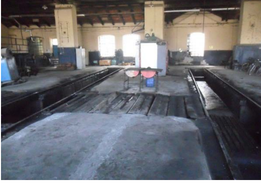
Şekil 5. 102 İç mekân, 11, 12, nolu nolu hattın bulunduğu bölüm, lokomotif bakım çukurları
