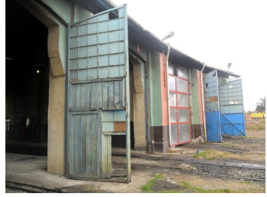
Şekil 5. 69 Lokomotif Giriş Cephesi, 1, 2, 3, 4, nolu hatların bulunduğu bölümlerin kapı detayları, değişen 2 nolu bölümün kapısı
