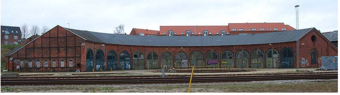
Şekil 4. 106 Viborg Dairesel Planlı Lokomotif Deposu, 2011 [113].
