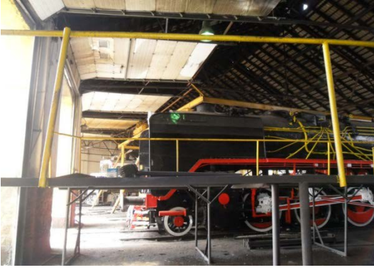
Şekil 5. 176 İç mekân, 2-10 nolu hatların bulunduğu ana mekân, çatı konstrüksiyonu, yeni kapılar
