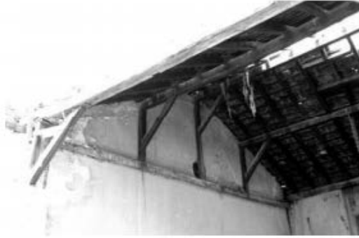
Resim 6.5. Çerkezköy Lokomotif Deposu Çatısı (Mayıs 2007)
