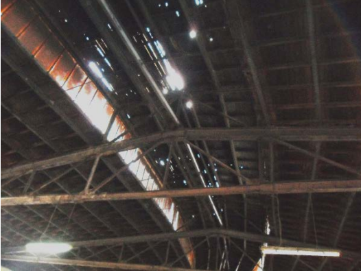
Şekil 5. 307 İç mekân, çatı ve çatı aydınlığı detaylar
