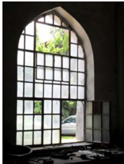
Şekil 5. 260 İç mekân, 14, 15 nolu hattın bulunduğu bölüm, arka duvar üzerindeki pencereler
