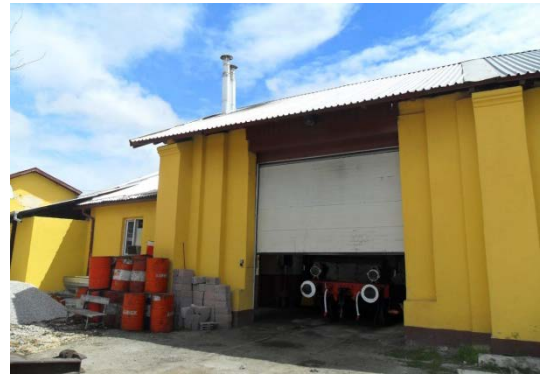
Şekil 5. 167 Arka cephe, 5 nolu yol, yeni kapılar, ana mekânın çatısı
