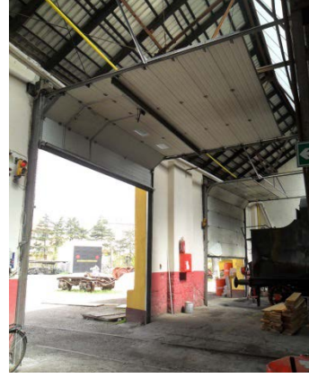
Şekil 5. 181 İç mekân, 5, 6 nolu hatların bulunduğu bölümün arka cephedeki yeni kapıları
