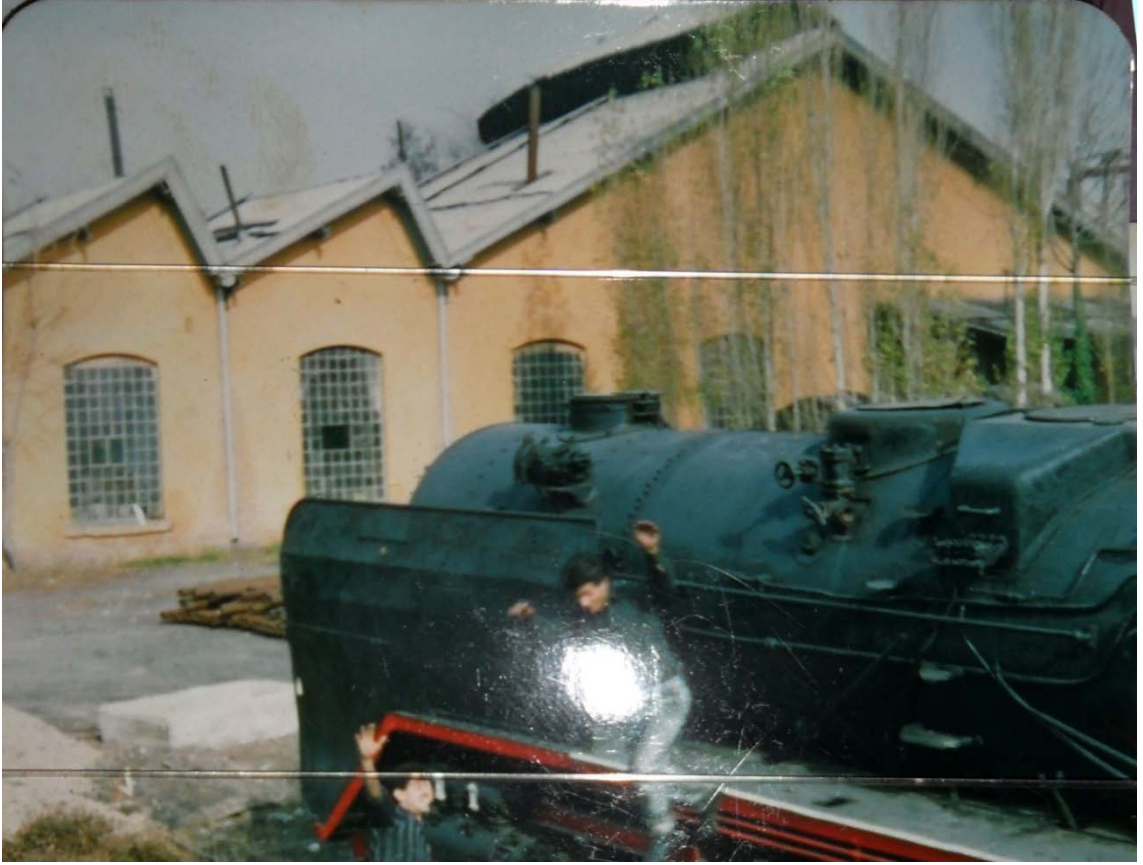
Şekil 5. 140 Konya İstasyonu'ndaki dairesel planlı lokomotif deposu yan cephesi [141].
