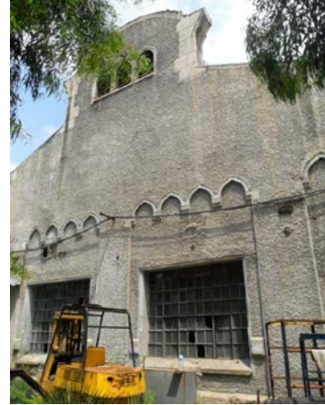
Şekil 5. 241 Arka cephe, 6 nolu hattın bulunduğu bölüm, dış kısımdaki büyük yay şeklindeki yapıyı yan cephesi
