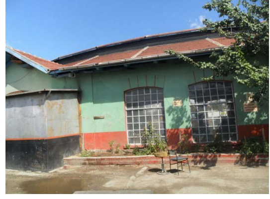
Şekil 5. 85 Arka Cephe, 12 nolu hattın bulunduğu bölüm
