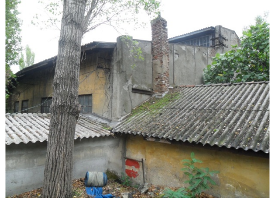
Şekil 5. 28 Arka cephe ve yan cephe, bu bölümdeki ek binalar
