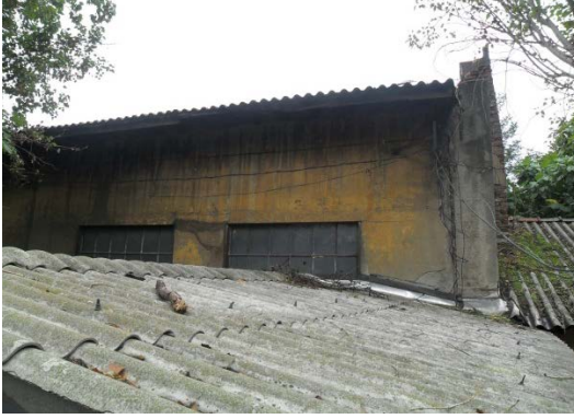
Şekil 5. 27 Arka cephe ve yan cephe, bu bölümdeki ek binalar
