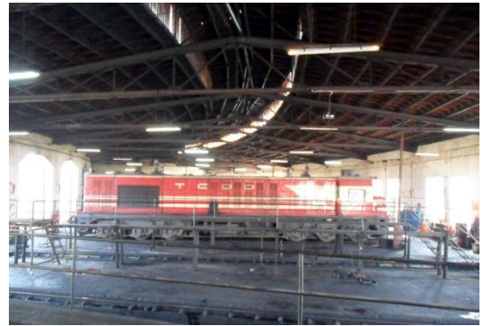
Şekil 5. 306 İç mekân, 2 - 12 nolu hattın bulunduğu bölüm, lokomotif giriş – çıkış kapıları, lokomotif bakım çukurları, çatı ve çatı aydınlığı
