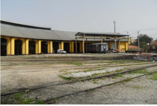
Şekil 5. 146 Lokomotif giriş cephesi, 1, 2, 3, 4, 5, 6, 7, 8, 9, 10 nolu hattın bulunduğu bölümler
