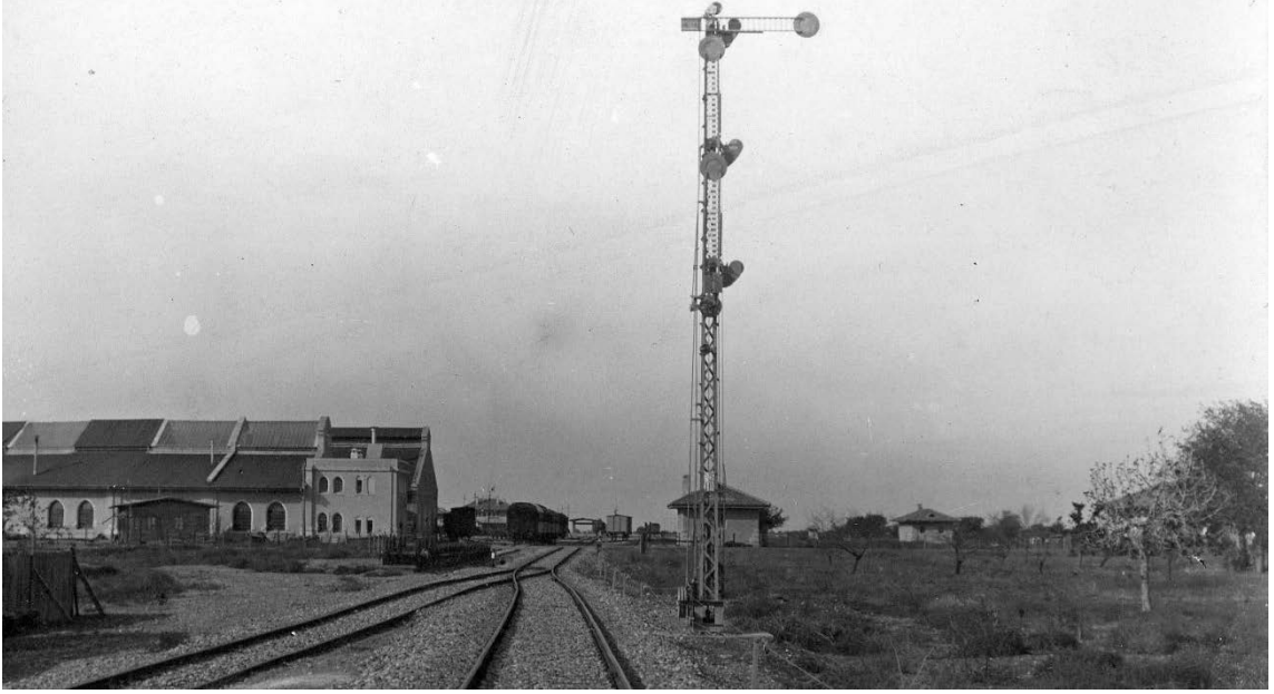
Şekil 5. 200 Adana İstasyonu'ndaki dairesel planlı lokomotif deposu arka cephesi [148].
