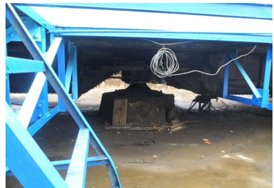
Şekil 5. 36 Krupp marka dönerköprü, beton çukur duvarı merkezindeki destek ünitesi, taşıyıcı kirişler
