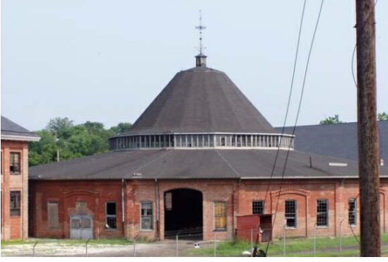
Şekil 4. 68 Martinsburg Dairesel Planlı Lokomotif Deposu. Restorasyon öncesi [93].
