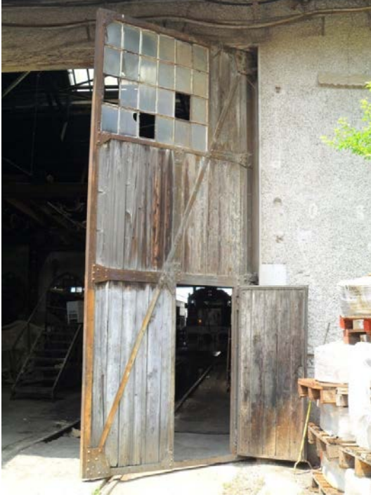
Şekil 5. 219 Arka cephe, 5 nolu hattın bulunduğu bölüm, orijinal kapı
