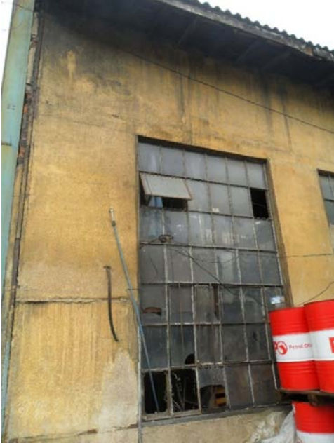
Şekil 5. 21 Yan cephe, dikdörtgen formlu metal iskelet ve cam ile imal edilmiş orjinal pencereler
