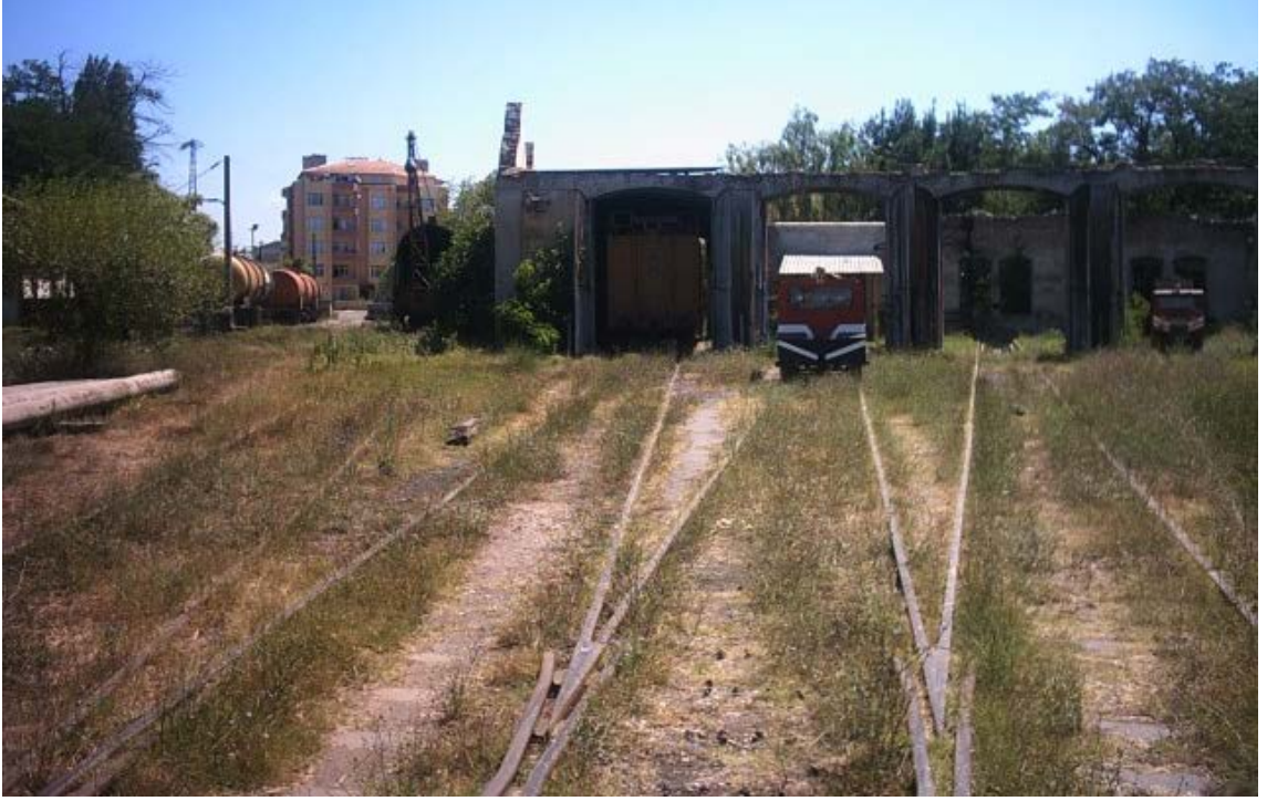
Şekil 5. 336 Çerkezköy Dairesel Planlı Lokomotif Deposu ön cephe [164].
