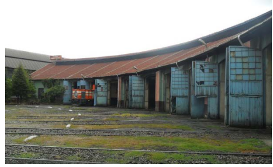
Şekil 5. 63 Lokomotif Giriş Cephesi, depoya lokomotif giriş - çıkışının yapıldığı kapılar, çatı aydınlığı ve çatı kaplama malzemesi
