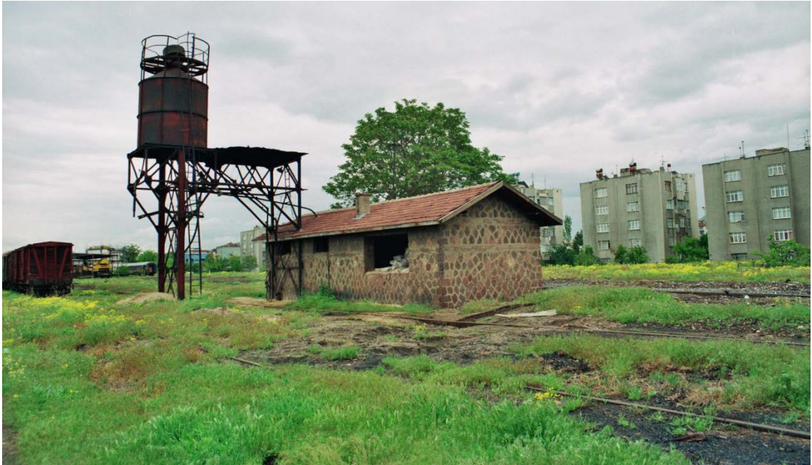
Şekil 5. 274 Kayseri İstasyonu'ndaki dairesel planlı lokomotif deposu arka bölümünde yer alan, bugün mevcut olmayan kum yükleme tesisi [160].
