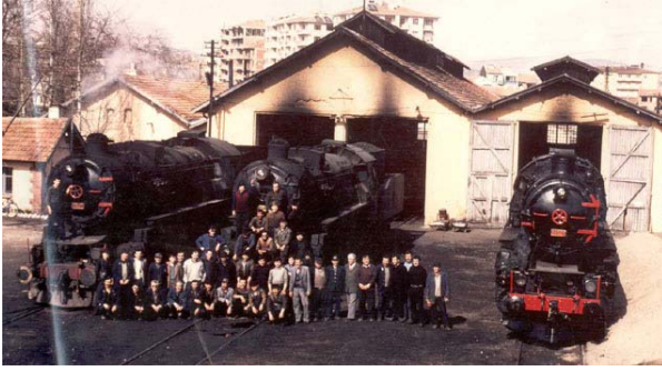
Şekil 3. 5 Hatları dönerköprülerle bağlanan dikdörtgen depolara örnek: Uşak Lokomotif Depo [53].
