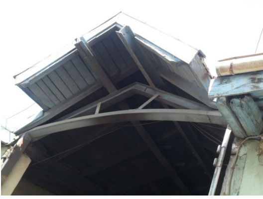
Şekil 5. 90 Arka cephe, 5 nolu hattın bulunduğu bölümün üzerindeki kırma çatı
