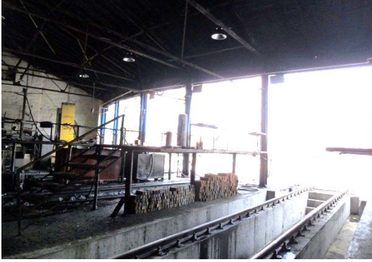
Şekil 5. 246 İç mekân, 2 - 13 nolu hattın bulunduğu bölümler, lokomotif giriş - çıkış kapısı
