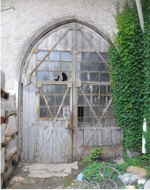
Şekil 5. 221 Arka cephe, 6 nolu hattın bulunduğu bölümün devamındaki ofis binasının orijinal kapısı
