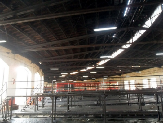
Şekil 5. 303 İç mekân, 3 - 12 nolu hattın bulunduğu bölüm, lokomotif giriş – çıkış kapıları, arka cephedeki orijinal pencereler, çatı ve çatı aydınlığı
