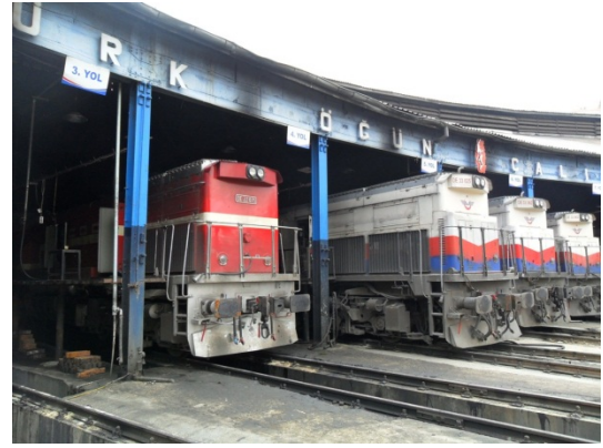
Şekil 5. 226 Ön cephe, 4 - 8 nolu hattın bulunduğu bölümler, lokomotif giriş kapıları
