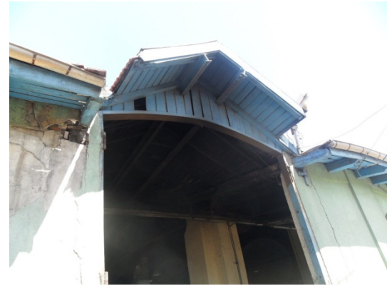
Şekil 5. 89 Arka cephe, 6 nolu hattın bulunduğu bölümün üzerindeki kırma çatı detayı
