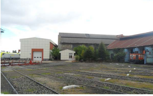
Şekil 5. 62 Lokomotif Giriş Cephesi, döner köprü, yeni yapılan simülasyon binası, ve daha önceki tarihlerde depoya bitişik olarak inşa edilmiş Tülomsaş atölyesi
