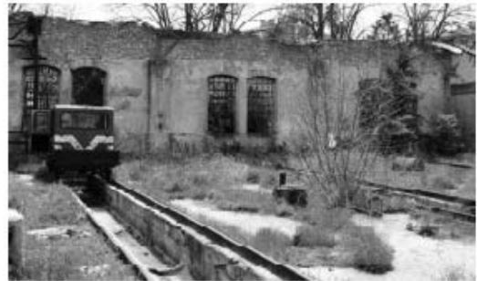
Resim 6.8. Çerkezköy Lokomotif Deposu İç Kısmı (Mayıs 2007)
