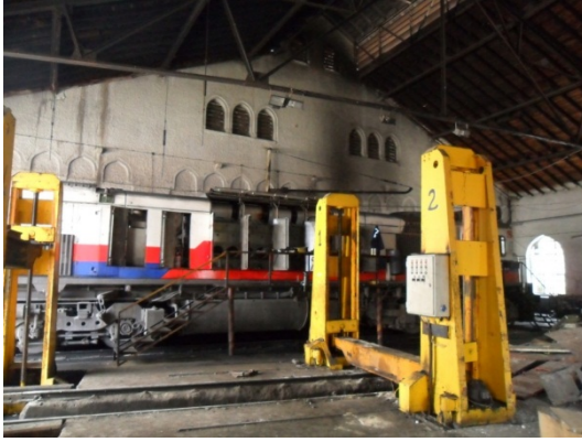
Şekil 5. 258 İç mekân, 14, 15 nolu hattın bulunduğu bölüm, lokomotif bakım çukurları, ana mekânın çatısı
