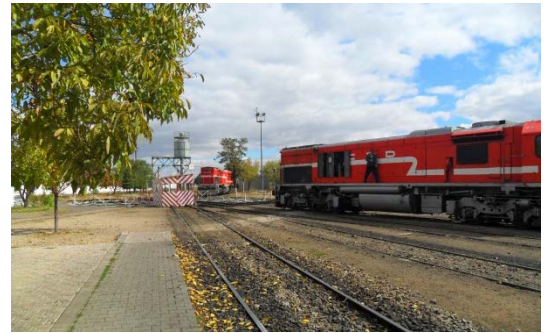
Şekil 5. 288 Dönerköprü, kum deposu (eskiden atölyenin arka alanında yer alırken yeri değiştirilerek döner köprü yakınlarında konumlandırılmış)
