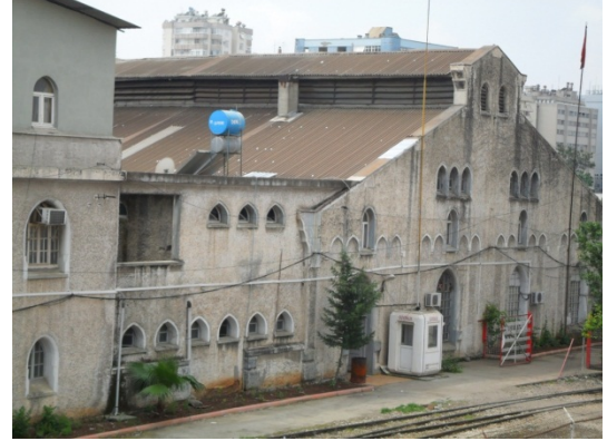
Şekil 5. 217 Yan cephe, 1 nolu hattın bulunduğu bölümün sonundaki ofis veya lojman bölümü ve bu bölümün üzerine sonradan inşa edilmiş çatı katı
