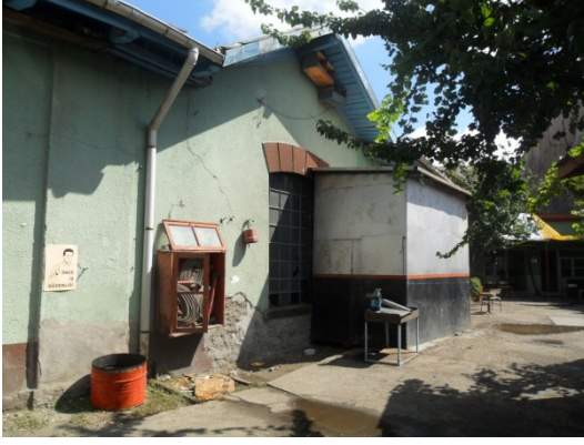
Şekil 5. 84 Arka Cephe, 11 nolu hattın bulunduğu bölüm
