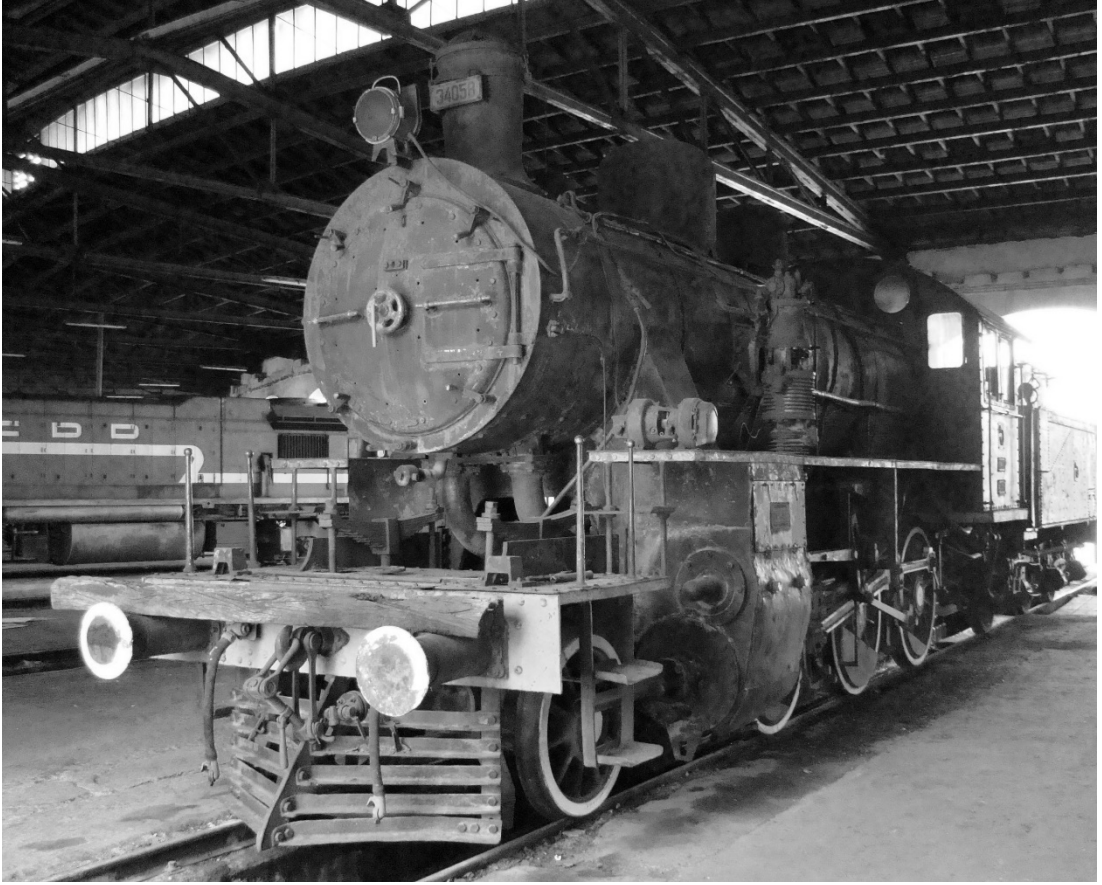
Şekil 5. 271 Kayseri İstasyonu'ndaki dairesel planlı lokomotif deposu iç mekân, depo içerisindeki buharlı lokomotif [160].
