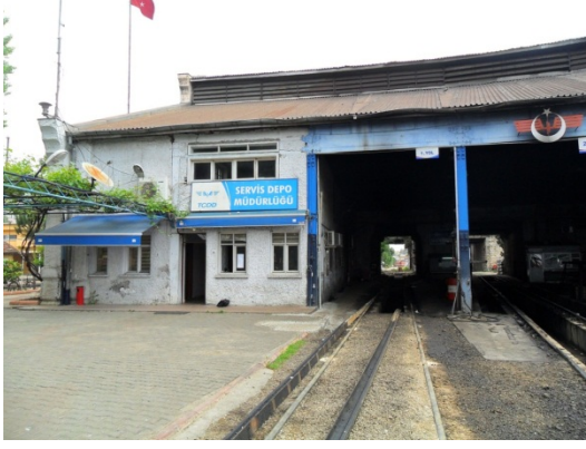
Şekil 5. 223 Ön cephe, 1 ve 2 nolu hattın bulunduğu bölüm
