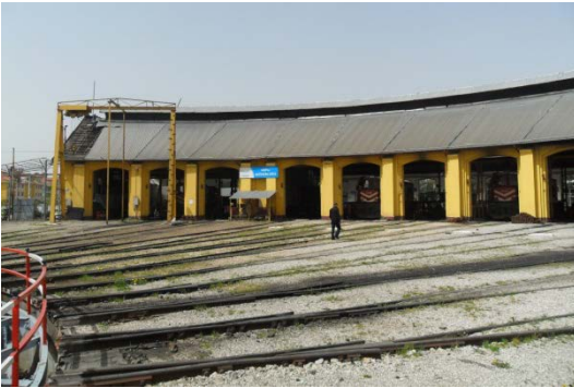
Şekil 5. 148 Lokomotif Giriş Cephesi, döner köprü, 7, 8, 9, 10, 11, 12, 13, 14 nolu hattın bulunduğu bölümler
