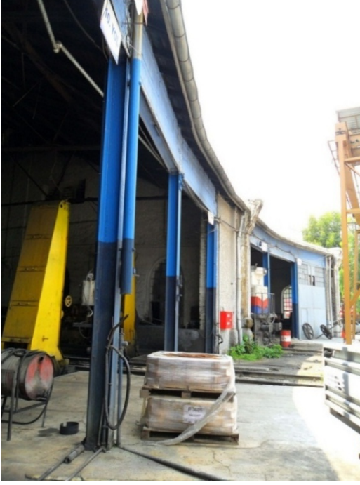
Şekil 5. 229 Ön cephe, 11 – 15 nolu hattın bulunduğu bölümler, lokomotif giriş-çıkış kapıları
