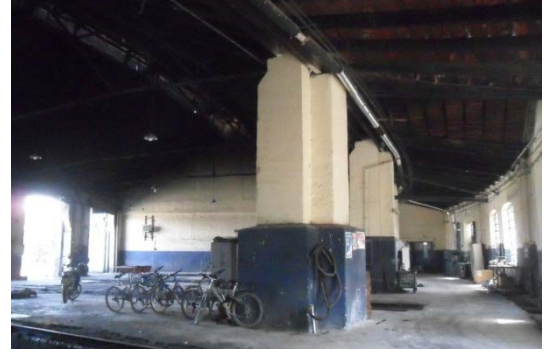
Şekil 5. 97 İç mekân, 8 ve 9 nolu hattın bulunduğu bölüm, lokomotif giriş-çıkış kapıları ile taşıyıcı kolonlar arasında kalan mekân, lokomotif bakım çukurları
