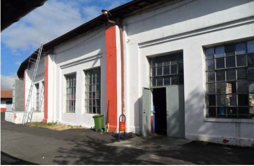
Şekil 5. 297 Arka cephe, 5, 6, 7 nolu hattın bulunduğu bölüm, 7 nolu hattın bulunduğu bölümde orijinal pencerelerin birinin yerine sonradan imal edilmiş kapı
