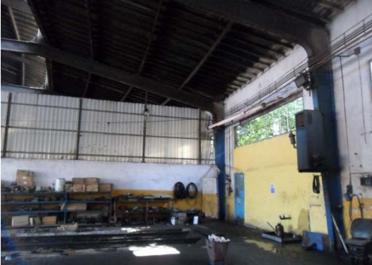
Şekil 5. 51 İç mekân, 3 nolu hattın bulunduğu bölüm, arka duvar ve formu değiştirilmiş pencere, bölücü duvar,
