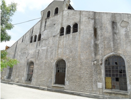
Şekil 5. 235 Yan cephe, 15 nolu hattın bulunduğu bölüm, pencere detayı
