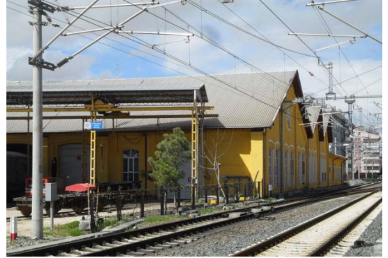
Şekil 5. 147 Eskişehir, Ankara yönünden gelen hızlı tren hattı ve lokomotif deposu yan cephesi
