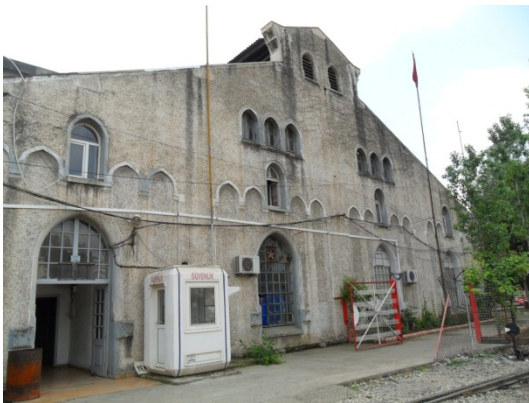
Şekil 5. 218 Yan cephe, 1 nolu hattın bulunduğu bölüm
