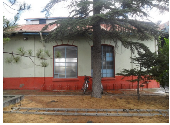
Şekil 5. 79 Arka Cephe, 2 nolu hattın bulunduğu bölüm
