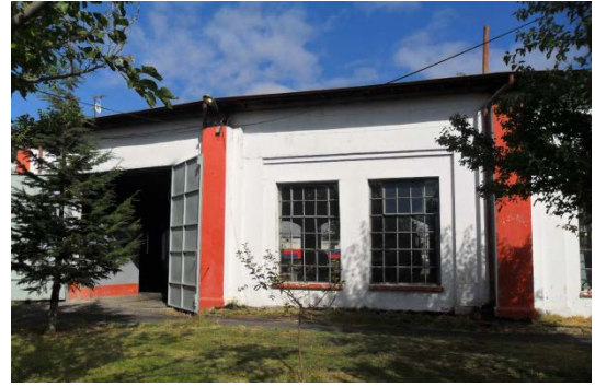
Şekil 5. 292 Arka cephe, 10 ve 11 nolu hattın bulunduğu bölüm, orijinal pencereler ve sonradan açılmış kapı
