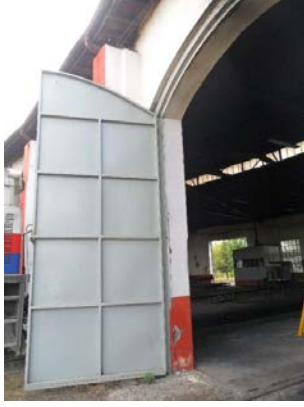
Şekil 5. 289 Ön cephe, 10 nolu hattın bulunduğu bölüm, lokomotif giriş – çıkış kapılarının sabitlenmesi
