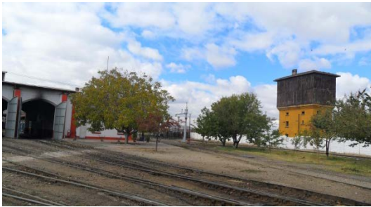
Şekil 5.287 Ön cephe, 1 nolu hattın bulunduğu bölüm, ofis bölümü, lokomotif giriş – çıkış kapıları, taşıyıcı kolonlar ve buharlı lokomotifler döneminde kullanılan su deposu
