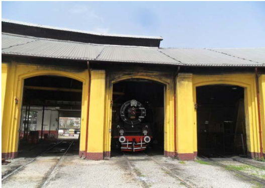
Şekil 5. 154 Lokomotif Giriş Cephesi, 5, 6, 7 nolu hattın bulunduğu bölümler
