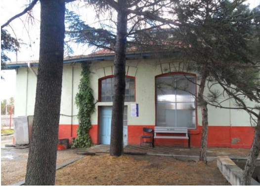
Şekil 5. 78 Arka Cephe, 1 nolu hattın bulunduğu bölüm
