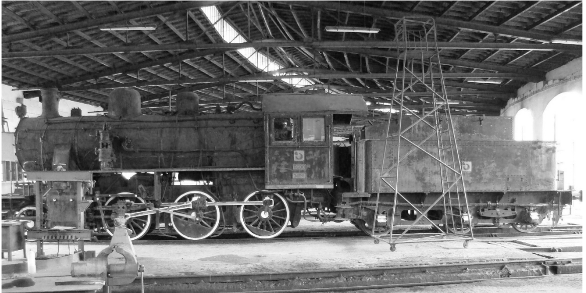
Şekil 5. 272 Kayseri İstasyonu'ndaki dairesel planlı lokomotif deposu iç mekân, depo içerisindeki buharlı lokomotif [160].
