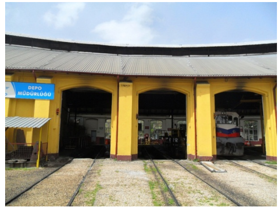
Şekil 5. 153 Lokomotif Giriş Cephesi, 9, 10, 11, 12 nolu hattın bulunduğu bölümler
