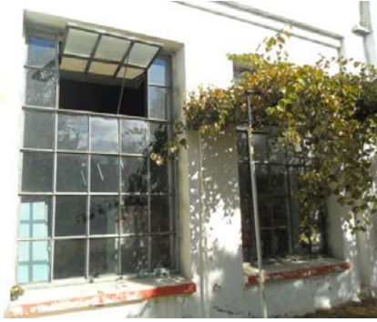
Şekil 5. 291 Arka cephe, 12 nolu hattın bulunduğu bölüm, orijinal pencerelerin kelebek sistemi açılma - kapanma detayı
