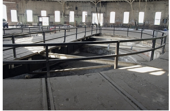
Şekil 4. 71 Martinsburg Dairesel Planlı Lokomotif Deposu. Restorasyon öncesi dönerköprü [93].
