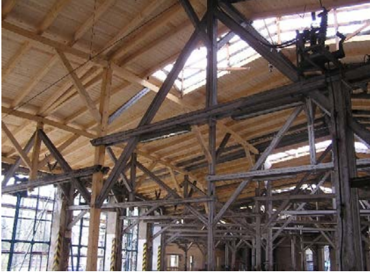
Şekil 4. 39 Freilassing dairesel planlı lokomotif deposu. Restorasyon süreci [86].
