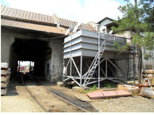
Şekil 5. 214 Arka cephe, 1, 2, 3 nolu hattın bulunduğu bölüm, 3 nolu hattın arka cephesindeki kapı boşluğu
