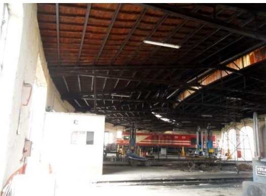
Şekil 5. 311 İç mekân, 1 - 9 nolu hattın bulunduğu bölüm, lokomotif giriş – çıkış kapıları, arka cephe, çatı ve çatı aydınlığı
