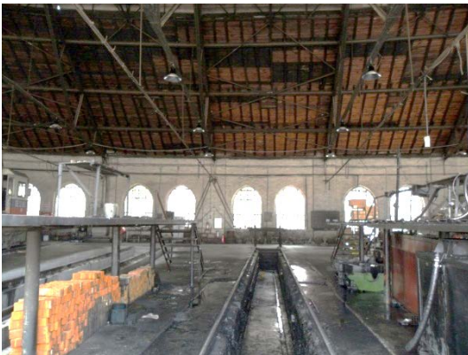
Şekil 5. 248 İç mekân, 2 - 13 nolu hatlar, arka cephe, lokomotif bakım çukurları, ana mekânın çatısı
