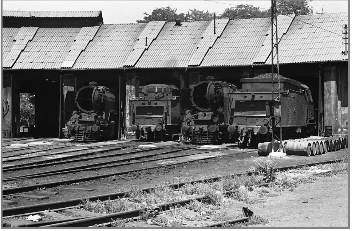
Şekil 5. 120 Konya İstasyonu'ndaki dairesel planlı lokomotif deposu lokomotif giriş – çıkış kapılarının bulunduğu ön cephe [135].
