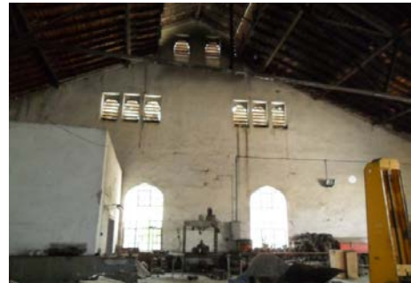
Şekil 5. 261 İç mekân, 14, 15 nolu hattın bulunduğu bölüm, yan duvar üzerindeki pencereler
