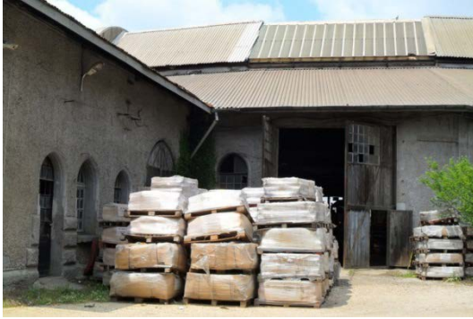
Şekil 5. 210 Arka cephe, 6 ve 5 nolu hattın bulunduğu bölüm, 6 nolu hattın devamındaki ofis binası, 5 nolu hattın arka cephesindeki orijinal kapısı
