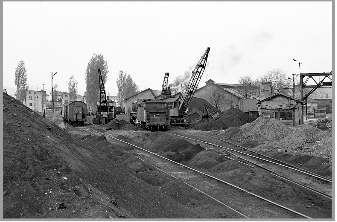
Şekil 5. 122 Konya İstasyonu'ndaki dairesel planlı lokomotif deposu kum deposu [135].
