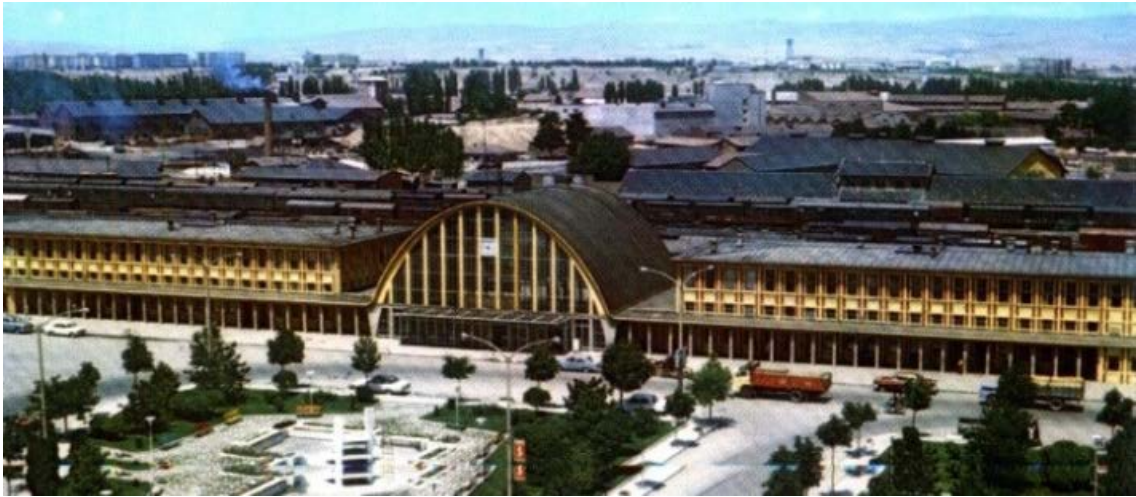
Şekil 5. 341 Eskişehir Garı Giriş Cephesi [169].
