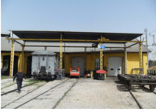
Şekil 5. 150 Lokomotif Giriş Cephesi, 1, 2, 3, 4, 5 nolu hattın bulunduğu bölümler
