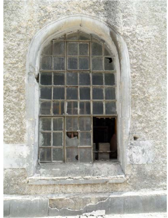
Şekil 5. 232 Yan cephe, 15 nolu hattın bulunduğu bölüm, pencere detayı
