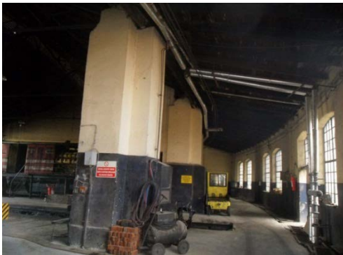
Şekil 5. 94 İç mekân, 7, 8 ve 9 nolu hattın bulunduğu bölüm, taşıyıcı kolonlar ile arka cephe duvarları arasında kalan mekân, tek yöne eğimli kırma çatı, arka cephedeki pencereler
