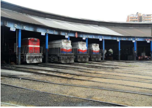
Şekil 5. 225 Ön cephe, 4 - 11 nolu hattın bulunduğu bölümler, lokomotif giriş kapıları
