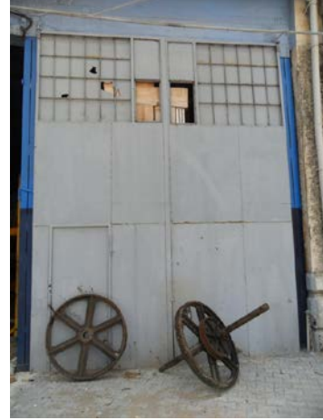
Şekil 5. 257 Ön cephe, 14, 15 nolu hattın bulunduğu bölümün giriş kapısı
