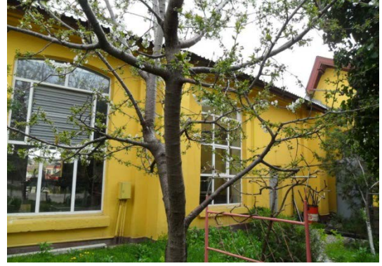
Şekil 5. 165 11 nolu hattın bulunduğu bölümün arka cephesi, PVC'den imal edilmiş yeni pencereler
