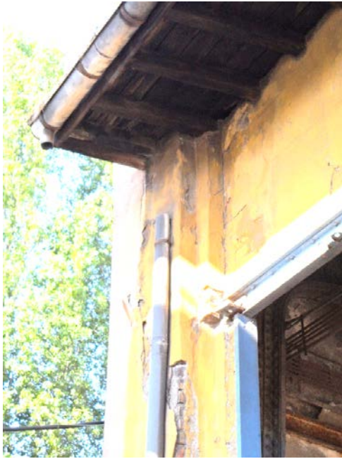
Şekil 5. 19 Ön cephe ile yan cephe birleşme noktası, kapı açıklığı üst ölüm, saçak detayı
