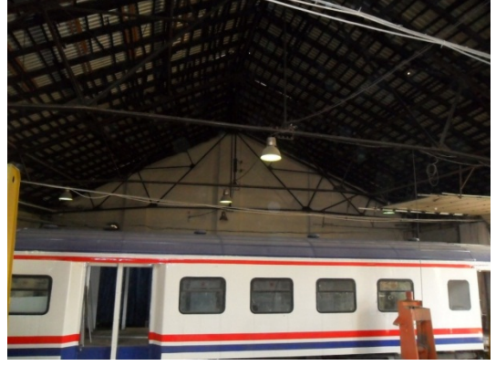
Şekil 5. 175 İç mekân, 2-10 nolu hatların bulunduğu ana mekân, çatı konstrüksiyonu
