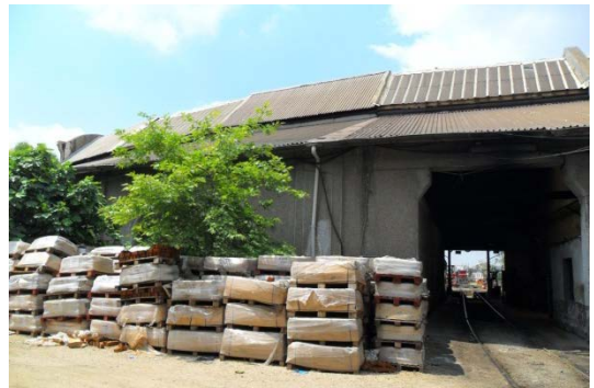
Şekil 5. 213 Arka cephe, 3, 4 nolu hattın bulunduğu bölüm
