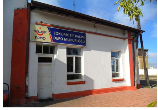
Şekil 5. 284 Ön cephe, ofis bölümü, giriş kapısı ve PVC olarak imal edilmiş yeni pencereler
