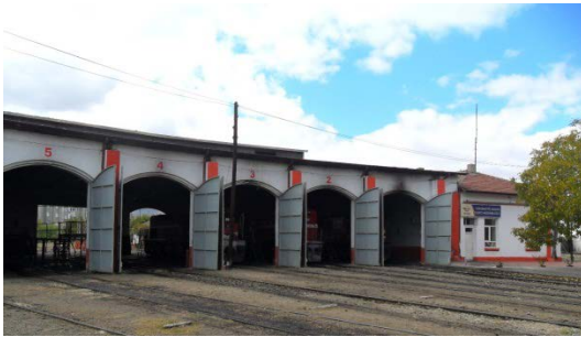
Şekil 5. 281 Ön cephe, 1 - 5 nolu hattın bulunduğu bölüm, ofis bölümü, lokomotif giriş - çıkış kapıları
