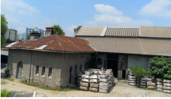
Şekil 5. 208 Arka cephe, 6 ve 5 nolu hattın bulunduğu bölüm, ofis binası, 5 nolu hattın arka cephesindeki orijinal kapısı, ana mekânın ve ofis binasının çatısı
