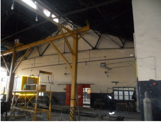
Şekil 5. 92 İç mekân, 1 ve 2 nolu hattın bulunduğu bölüm, çatı makasları ve çatı aydınlığı, diğer bölümler ile aradaki duvar
