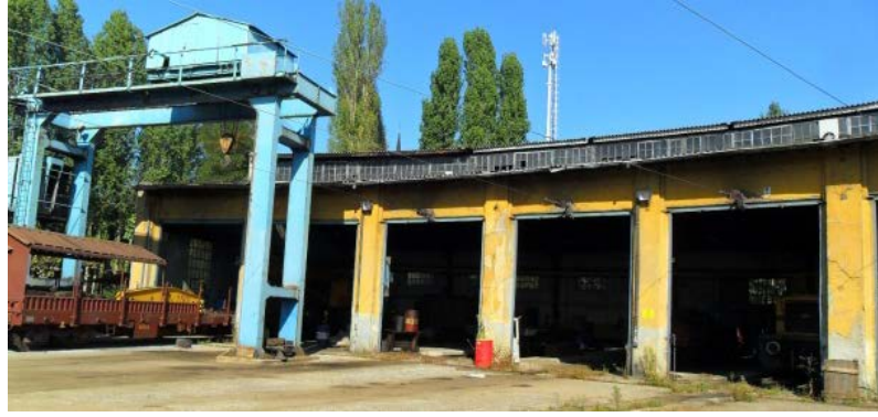
Şekil 5. 14 Ön cephe, 5, 6, 7, 8, 9 nolu hatların bulunduğu bölümler, kapı açıklıkları, çatı ve çatı aydınlığı
