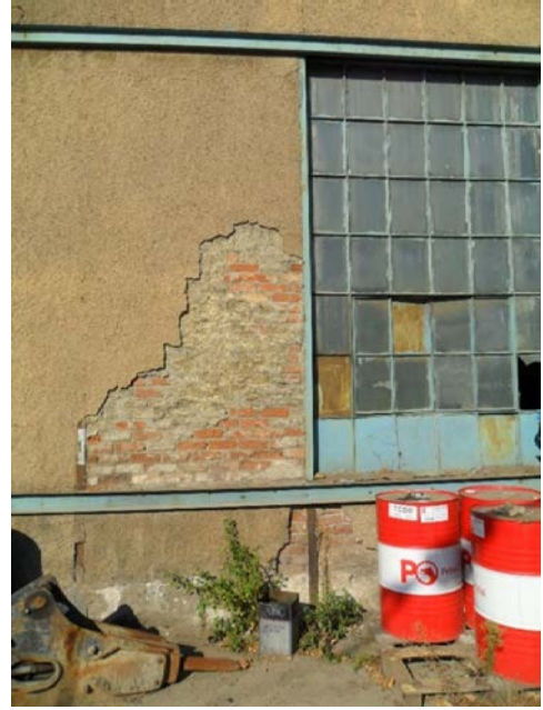
Şekil 5. 24 Yan cephe, dikdörtgen formlu metal iskelet ve cam ile imal edilmiş orjinal pencereler, bina dış duvarlarında kullanılan metal hatıl ve tuğla duvar örgüsü detayı
