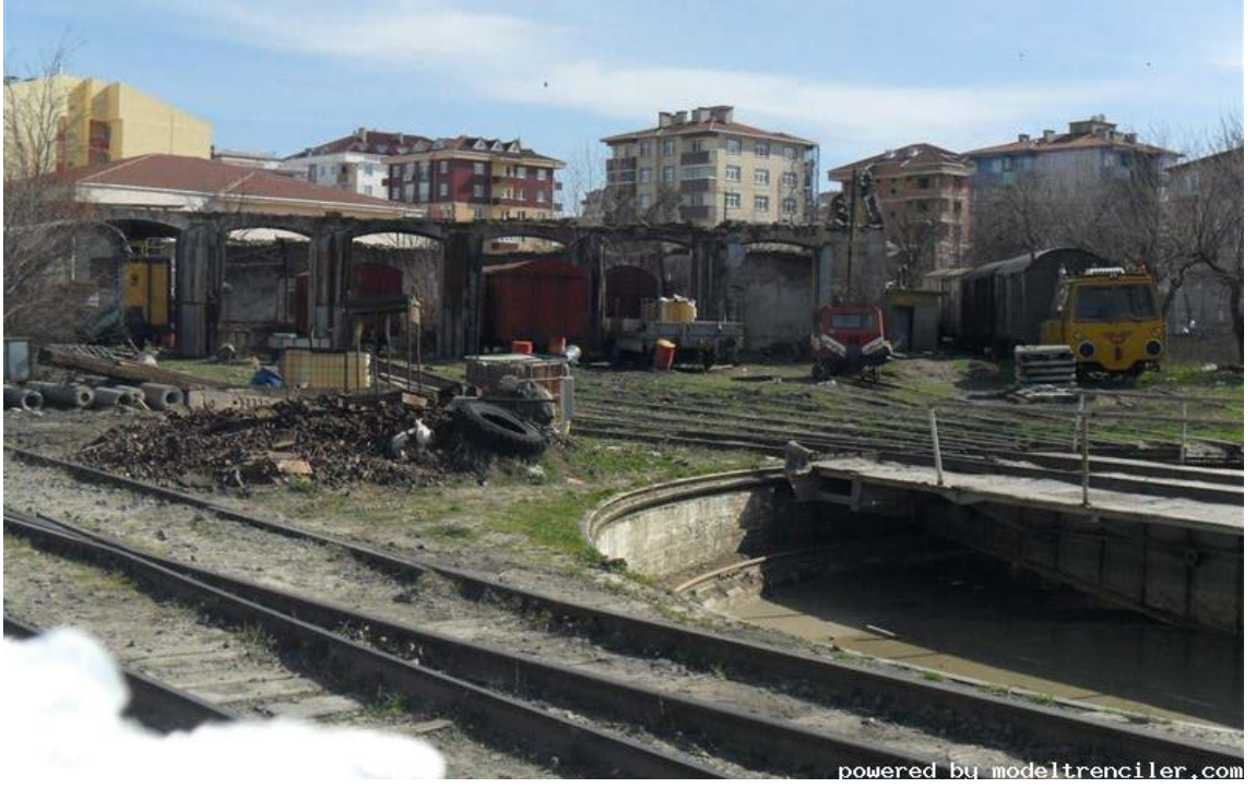
Şekil 5. 334 Çerkezköy Dairesel Planlı Lokomotif Deposu ön cephe ve dönerköprü [163].
