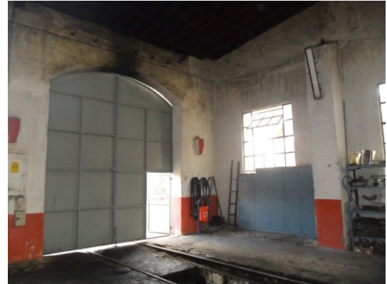
Şekil 5. 318 İç mekân, 12 nolu hattın bulunduğu bölüm, lokomotif giriş – çıkış kapısı, yan cephedeki orijinal pencere
