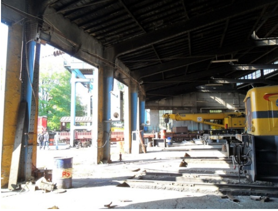
Şekil 5. 37 İç mekân, 5, 6, 7, 8, 9 nolu hatların bulunduğu bölüm, kapı açıklıkları, metal iskelet
