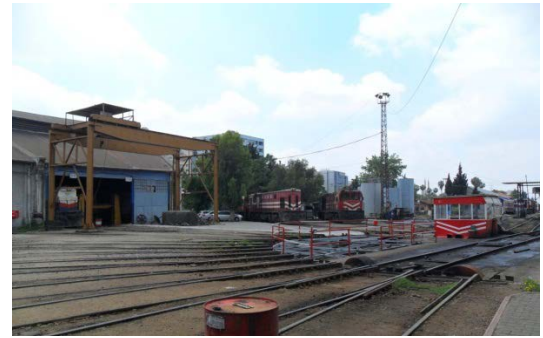
Şekil 5. 228 Ön cephe, 14, 15 nolu hattın bulunduğu bölümler, lokomotif giriş-çıkış kapıları, ana mekânın çatısı ve çatı aydınlığı, dönerköprü
