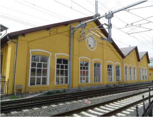
Şekil 5. 172 Eskişehir, Ankara yönünden gelen hızlı tren hattı ve dairesel planlı lokomotif deposu yan cephesi
