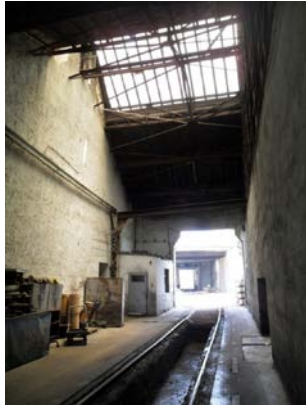
Şekil 5. 254 İç mekân, 3 nolu hattın bulunduğu bölüm, arka cephedeki kapı, bu bölümün çatısı
