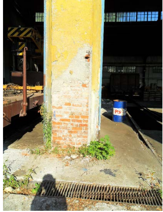
Şekil 5. 18 Ön cephe, kapı açıklıkları ve aralarındaki taşıyıcı kolonlar alt ölüm, tuğla örgü detayı
