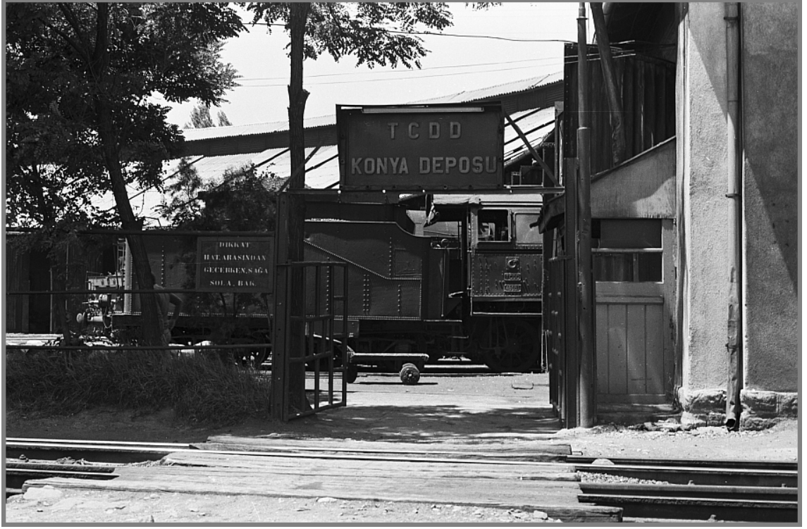
Şekil 5. 118 Konya İstasyonu'ndaki dairesel planlı lokomotif deposu lokomotif giriş – çıkış kapılarının bulunduğu ön cephe [135].
