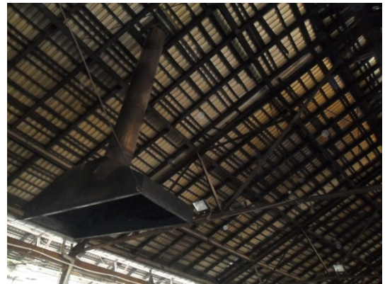
Şekil 5. 185 İç mekân, ana mekânın çatısı ve buharlı lokomotif dönemine ait baca
