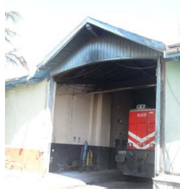
Şekil 5. 91 Arka cephe, 3 nolu hattın bulunduğu bölümün üzerindeki kırma çatı
