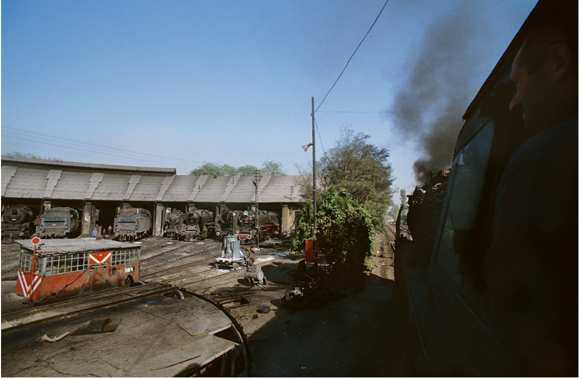
Şekil 5. 132 Konya İstasyonu'ndaki dairesel planlı lokomotif deposu ön cephesi, dönerköprüsü ve dönerköprü üzerindeki kontrol odası [139].
