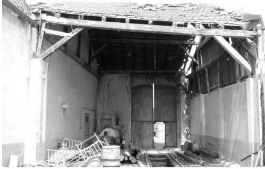
Resim 6.4. Çerkezköy Lokomotif Deposu İç Kısmı (Mayıs 2007)
