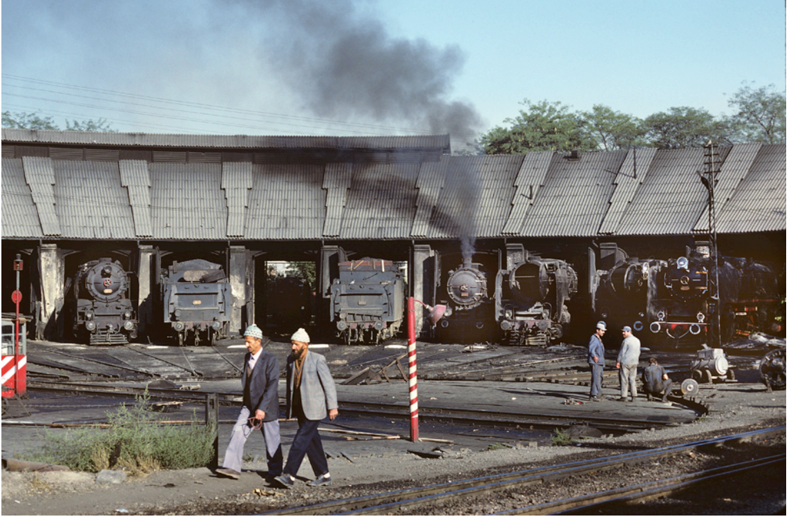
Şekil 5. 130 Konya İstasyonu'ndaki dairesel planlı lokomotif deposu ön cephesi, dönerköprüsü [139].
