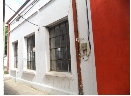
Şekil 5. 286 Arka cephe, ofis bölümü, demir iskelet ile imal edilmiş eski pencereler
