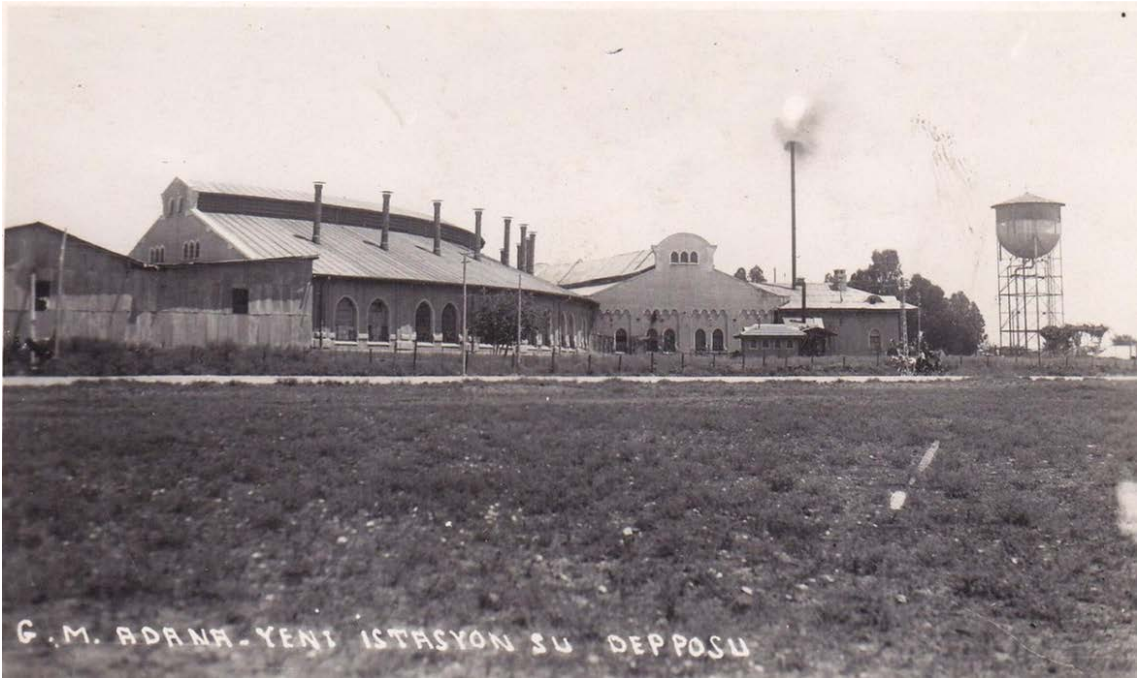
Şekil 5. 201 Adana İstasyonu'ndaki dairesel planlı lokomotif deposu arka cephesi ve bugün mevcut olmayan su deposu (1920) [149].
