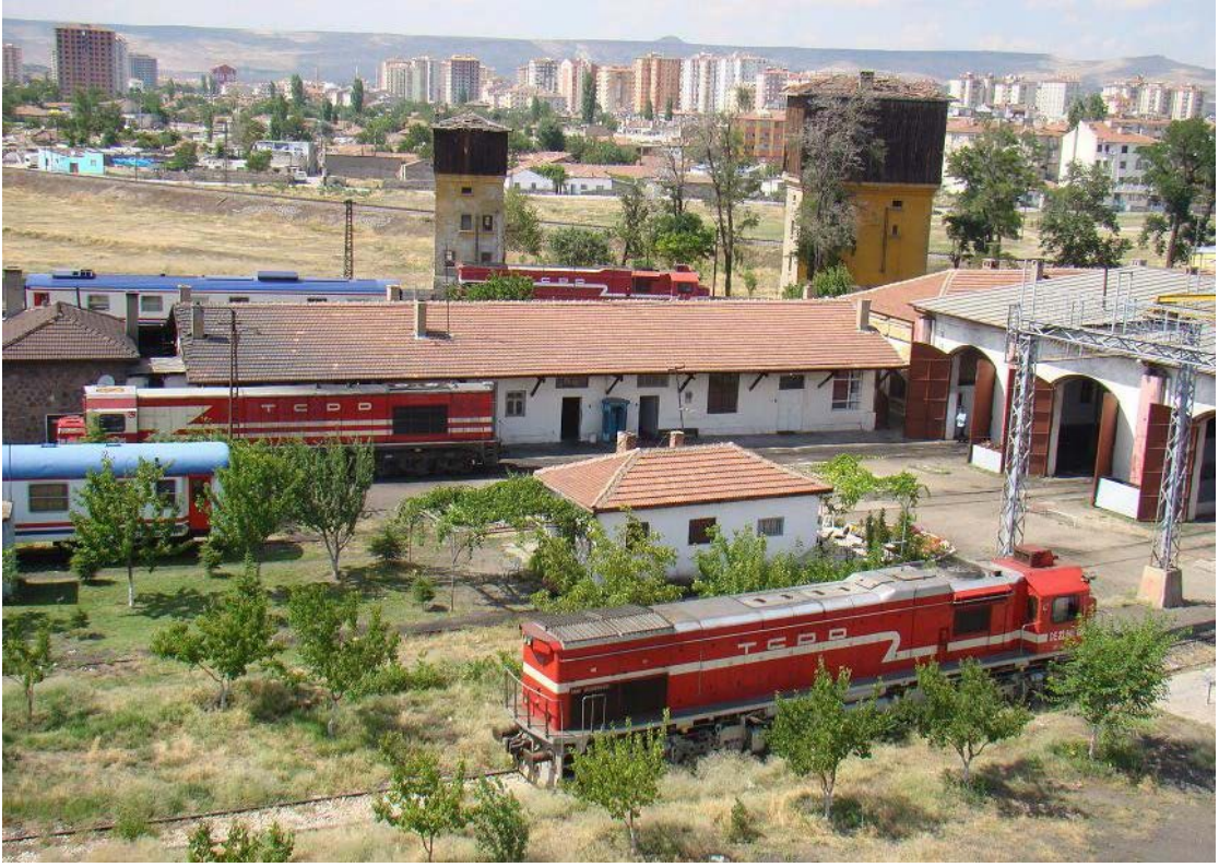
Şekil 5. 273 Kayseri İstasyonu'ndaki dairesel planlı lokomotif deposu dış mekân, 1, 2, 3 nolu bölümün arka cephesi, atölye ve su depoları ile birlikte
