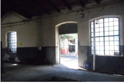
Şekil 5. 96 İç mekân, 7 nolu hattın bulunduğu bölüm, bu bölümdeki arka cephedeki pencereler ve pencereden bozularak dönüştürülen kapı
