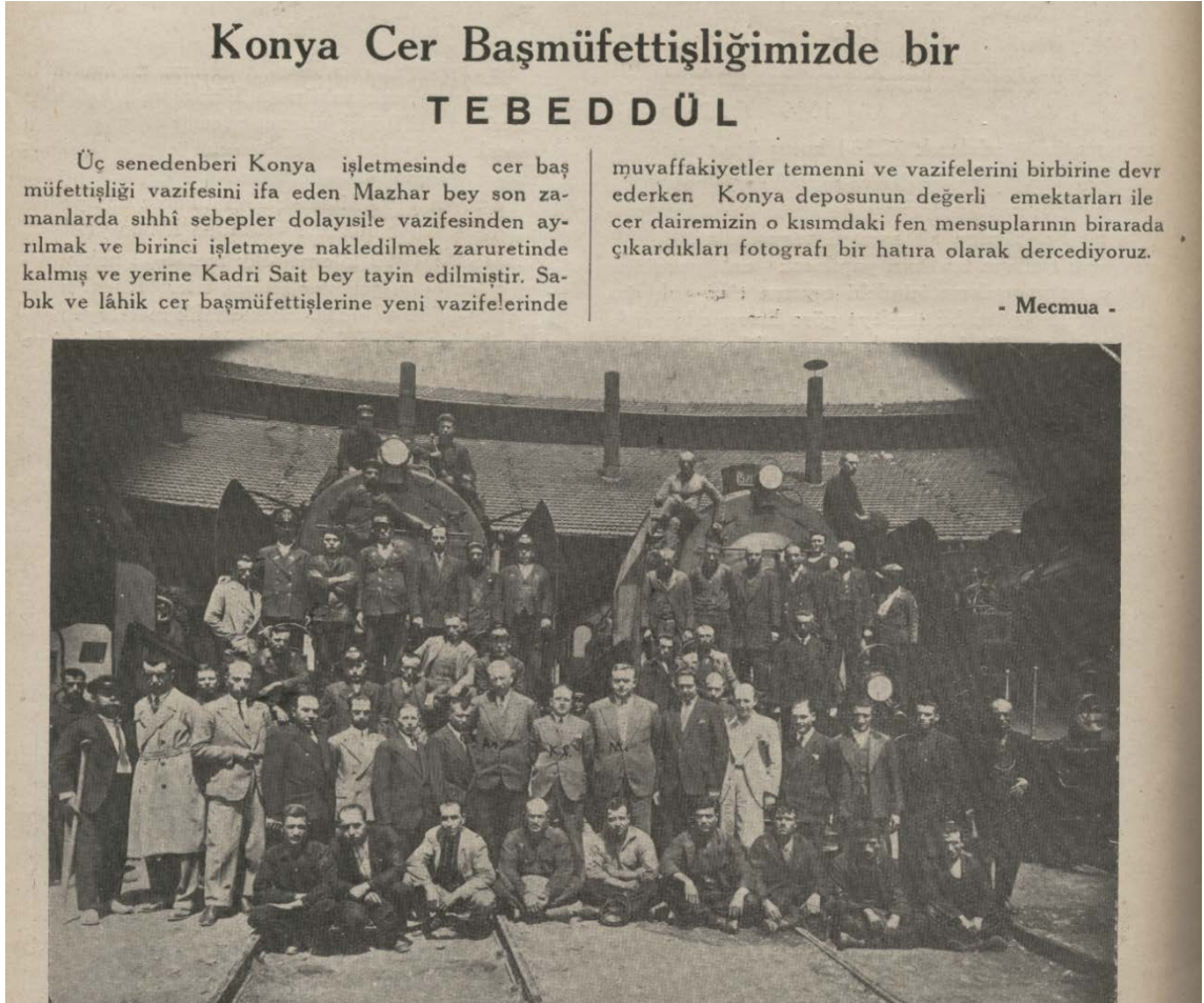
Şekil 5. 125 Konya İstasyonu'ndaki dairesel planlı lokomotif deposu [137].
