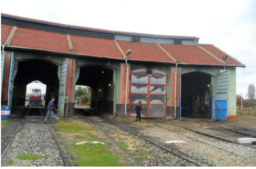
Şekil 5. 64 Lokomotif Giriş Cephesi, 1, 2, 3, 4, nolu hatların kapıları ve çatı aydınlığı
