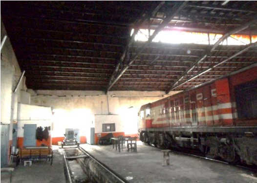
Şekil 5. 317 İç mekân, 11, 12 nolu hattın bulunduğu bölüm, arka cephedeki orijinal pencereler
