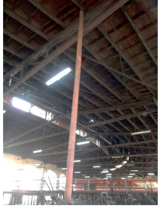
Şekil 5. 320 İç mekân, 2 - 12 nolu hattın bulunduğu bölüm, lokomotif giriş – çıkış kapıları, baca, çatı ve çatı aydınlığı
