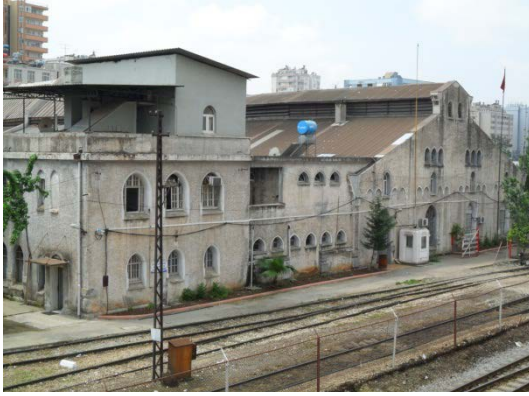
Şekil 5. 216 Yan cephe, 1 nolu hattın bulunduğu bölümün sonundaki ofis veya lojman bölümü ve bu bölümün üzerine sonradan inşa edilmiş çatı katı
