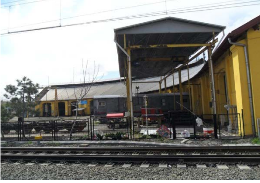
Şekil 5. 170 Eskişehir, Ankara yönünden gelen hızlı tren hattı ve dairesel planlı lokomotif deposu ön cephesi
