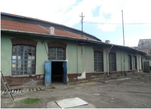
Şekil 5. 82 Arka Cephe, 7, 8, 9 nolu hattın bulunduğu bölüm
