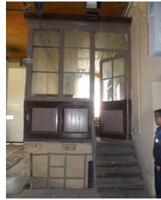
Şekil 5. 191 İç mekân, atölye binası içerisinde ofis olarak kullanılan bölüm
