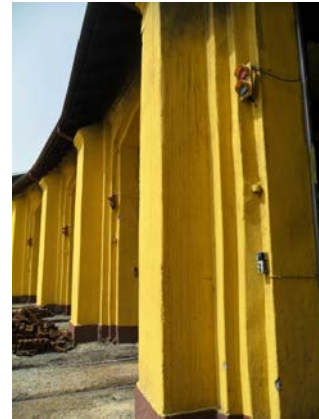
Şekil 5. 155 Giriş Cephesi, lokomotif giriş – çıkışının yapıldığı kapılar, orijinal kapı kanadı bulunmamaktadır.
