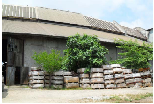
Şekil 5. 211 Arka cephe, 4 nolu hattın bulunduğu bölüm, 4 nolu hattının arka cephesindeki pencereler, ana mekânın çatısı
