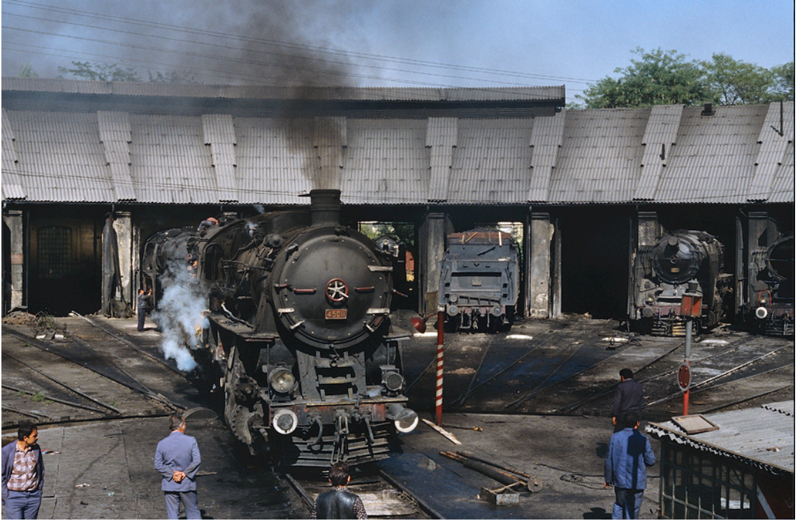
Şekil 5. 131 Konya İstasyonu'ndaki dairesel planlı lokomotif deposu ön cephesi, dönerköprüsü ve dönerköprü üzerindeki kontrol odası [139].
