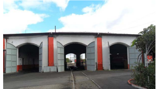
Şekil 5. 300 Arka cephe, 1, 2, 3, nolu hattın bulunduğu bölüm, , lokomotif giriş – çıkış kapıları
