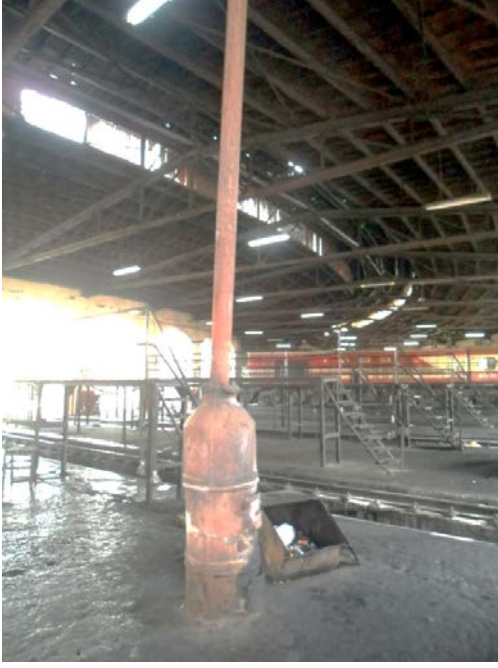
Şekil 5. 319 İç mekân, 2 - 12 nolu hattın bulunduğu bölüm, lokomotif giriş – çıkış kapıları, lokomotif bakım çukurları, soba ve baca, çatı ve çatı aydınlığı
