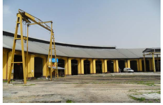
Şekil 5. 145 Lokomotif giriş cephesi, 3, 4, 5, 6, 7, 8, 9, 10, 11, 12, 13 nolu hattın bulunduğu bölümler
