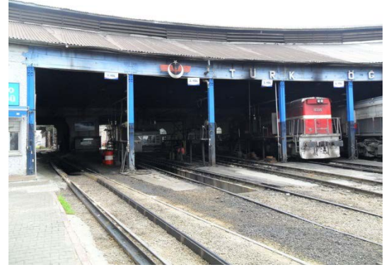
Şekil 5.224 Ön cephe, 1 ve 2, 3, 4, 5 nolu hattın bulunduğu bölüm
