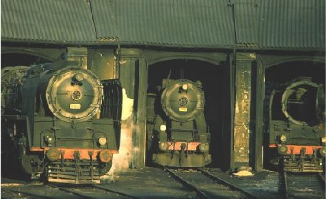
Şekil 5. 133 Konya İstasyonu'ndaki dairesel planlı lokomotif deposu ön cephesi [140].
