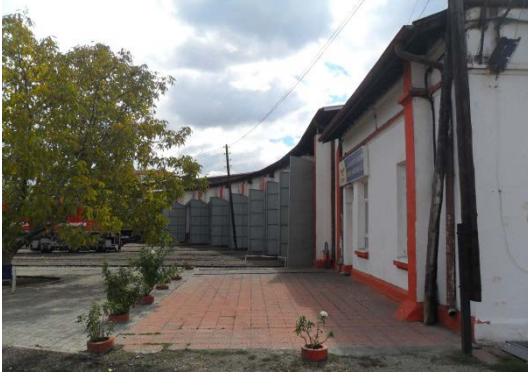
Şekil 5. 283 Ön cephe, 1 – 6 nolu hattın bulunduğu bölüm, ofis bölümü, lokomotif giriş – çıkış kapıları, taşıyıcı kolonlar
