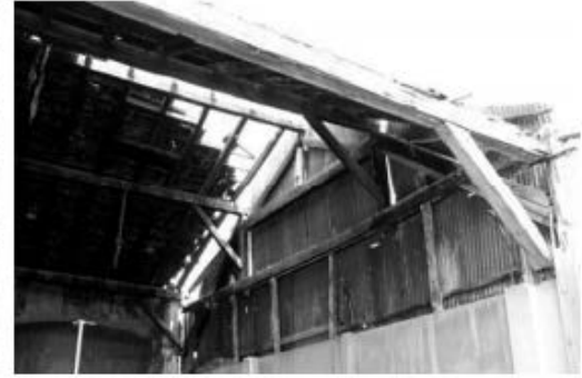
Resim 6.6. Çerkezköy Lokomotif Deposu Ahşap Asma Çatı Makası (Mayıs 2007)
