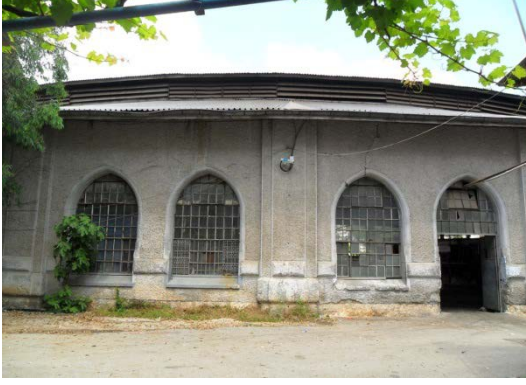
Şekil 5. 238 Adana Dairesel Planlı Lokomotif Deposu arka cephesi
