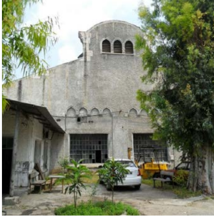
Şekil 5. 240 Arka cephe, 6 nolu hattın bulunduğu bölüm, dış kısımdaki büyük yay şeklindeki yapıyı yan cephesi
