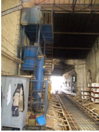
Şekil 5. 256 İç mekân, 2 nolu hattın bulunduğu bölüm, büyük yay şeklindeki yapı, arka cephedeki kapısı ve çatısı
