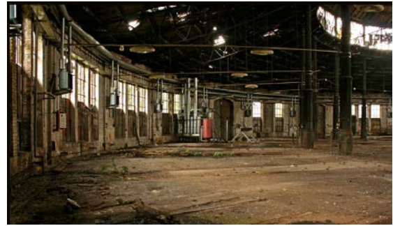
Şekil 4. 84 Düsseldorf Dairesel Planlı Lokomotif Deposu. Restorasyon öncesi [103].
