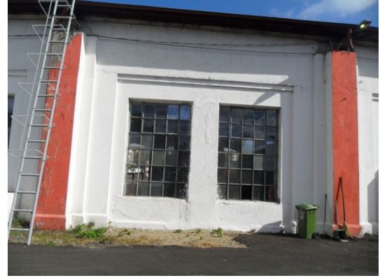
Şekil 5. 298 Arka cephe, 6 nolu hattın bulunduğu bölüm, orijinal pencereler
