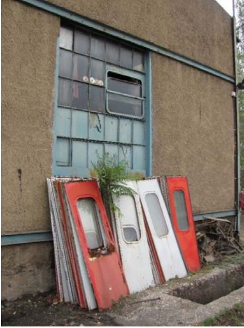
Şekil 5. 23 Yan cephe, dikdörtgen formlu metal iskelet ve cam ile imal edilmiş orjinal pencereler, bina dış duvarlarında kullanılan metal hatıl ve tuğla duvar örgüsü detayı
