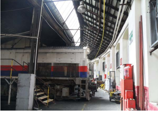
Şekil 5. 180 İç mekân, 5-10 nolu hatların bulunduğu bölümlerdeki ikincil mekânın üzerini örten, iki yöne eğimli kırma çatı ve aydınlık bölümü
