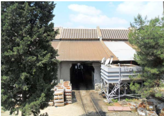
Şekil 5. 212 Arka cephe, 3 nolu hattın bulunduğu bölüm, ana mekânın çatısı
