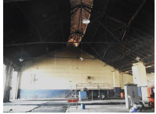
Şekil 5. 99 İç mekân, 8 ve 9 nolu hattın bulunduğu bölüm, bu mekânın üzerini örten çift yönde kırma çatı
