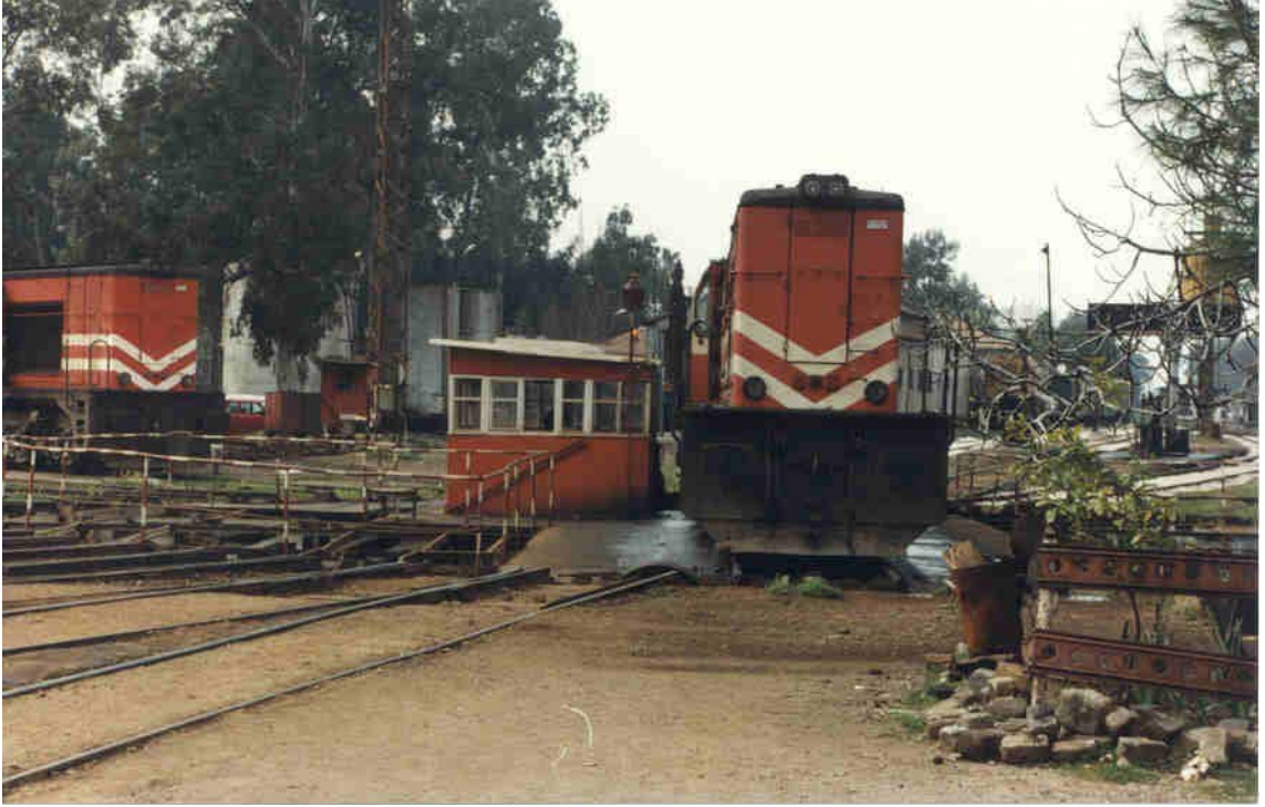
Şekil 5. 204 Adana İstasyonu'ndaki dairesel planlı lokomotif deposu dönerköprüsü [152].
