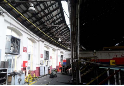
Şekil 5. 182 İç mekân, 5-10 nolu hatların bulunduğu bölümlerdeki ikincil mekânın üzerini örten, iki yöne eğimli kırma çatı ve aydınlık bölümü
