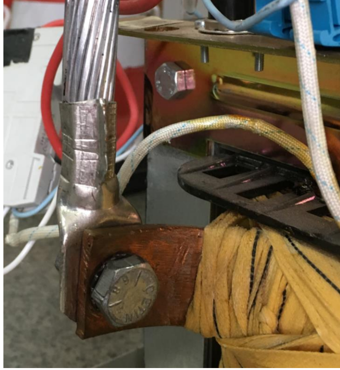
Şekil 2.10 Kablo pabuçlarının transformatör barasına dik şekilde bağlanması
