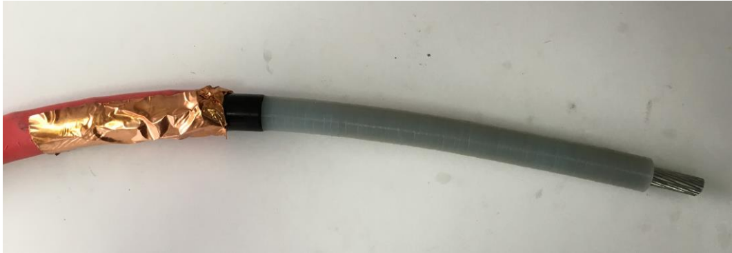
Şekil 2.4 Ölçümde kullanılan kablo numunesinin test için hazırlanmış durumu
