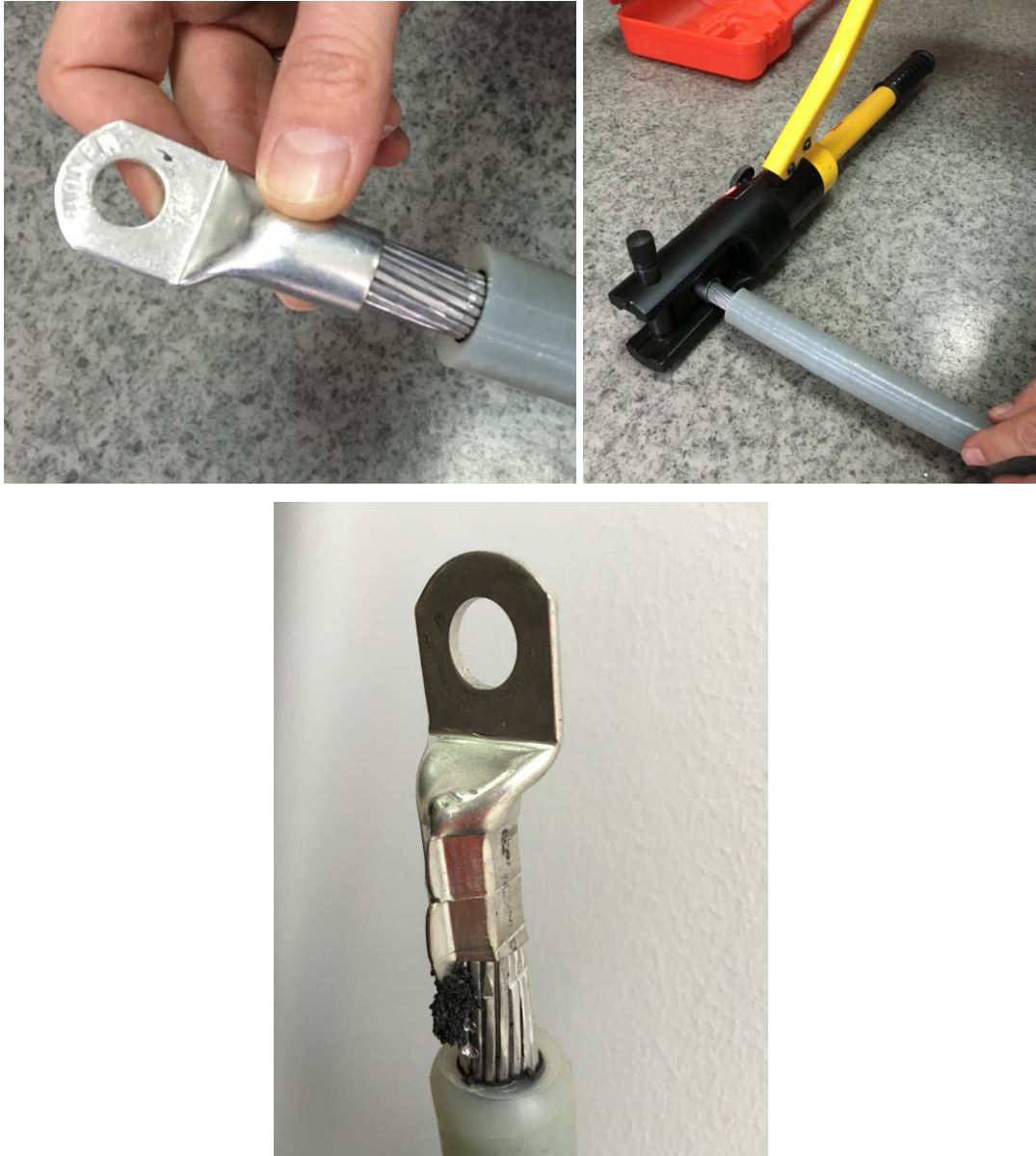
Şekil 2.6 Kablo numunesine pabuç montajının yapılması
