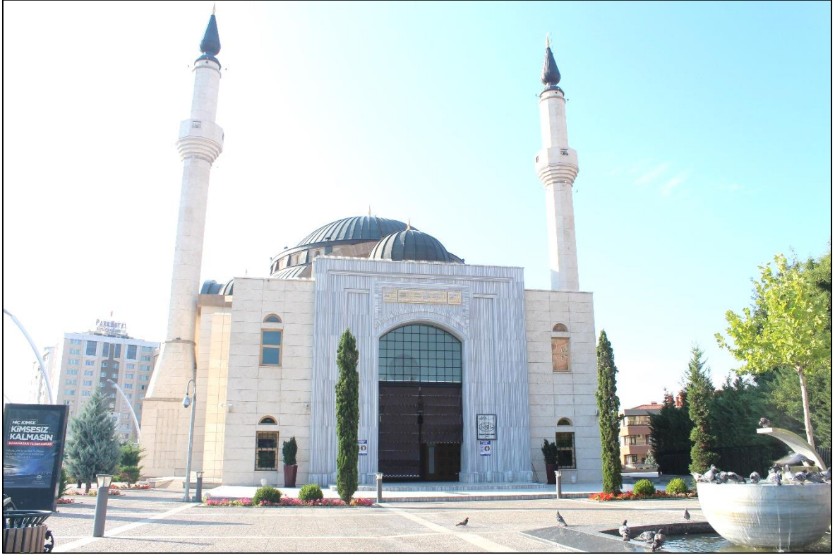
Resim 4.2. Hasan Tanık Camii ön cephe görüntüsü [18]
